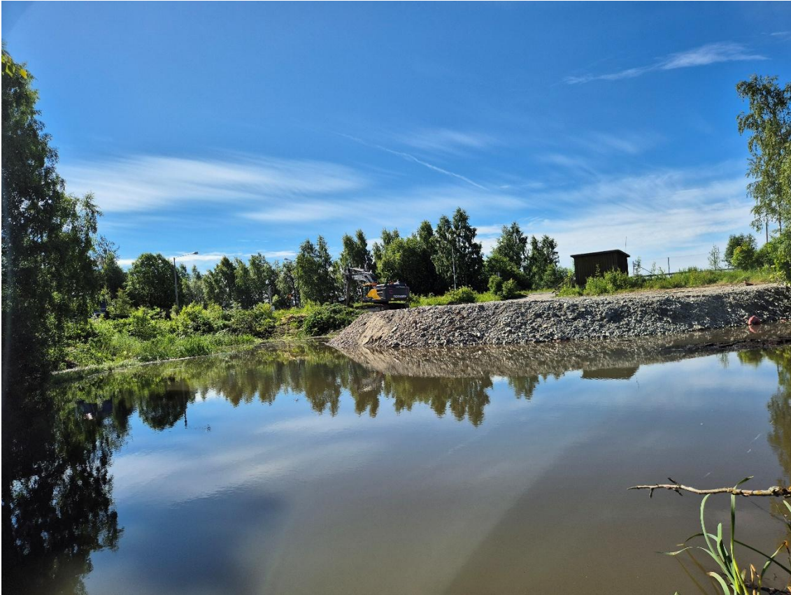
Kuva 4. Maa-altaan eteläosa ja rakennettu maapato. Kuva otettu 2.7.2026.
