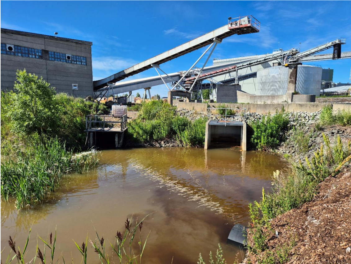
Kuva 2. Väliallas, käynnissä lipeän syöttö. Putken suuaukosta virtaa vesi saapasaltaasta välialtaaseen. Kuva otettu 2.7.2026.
