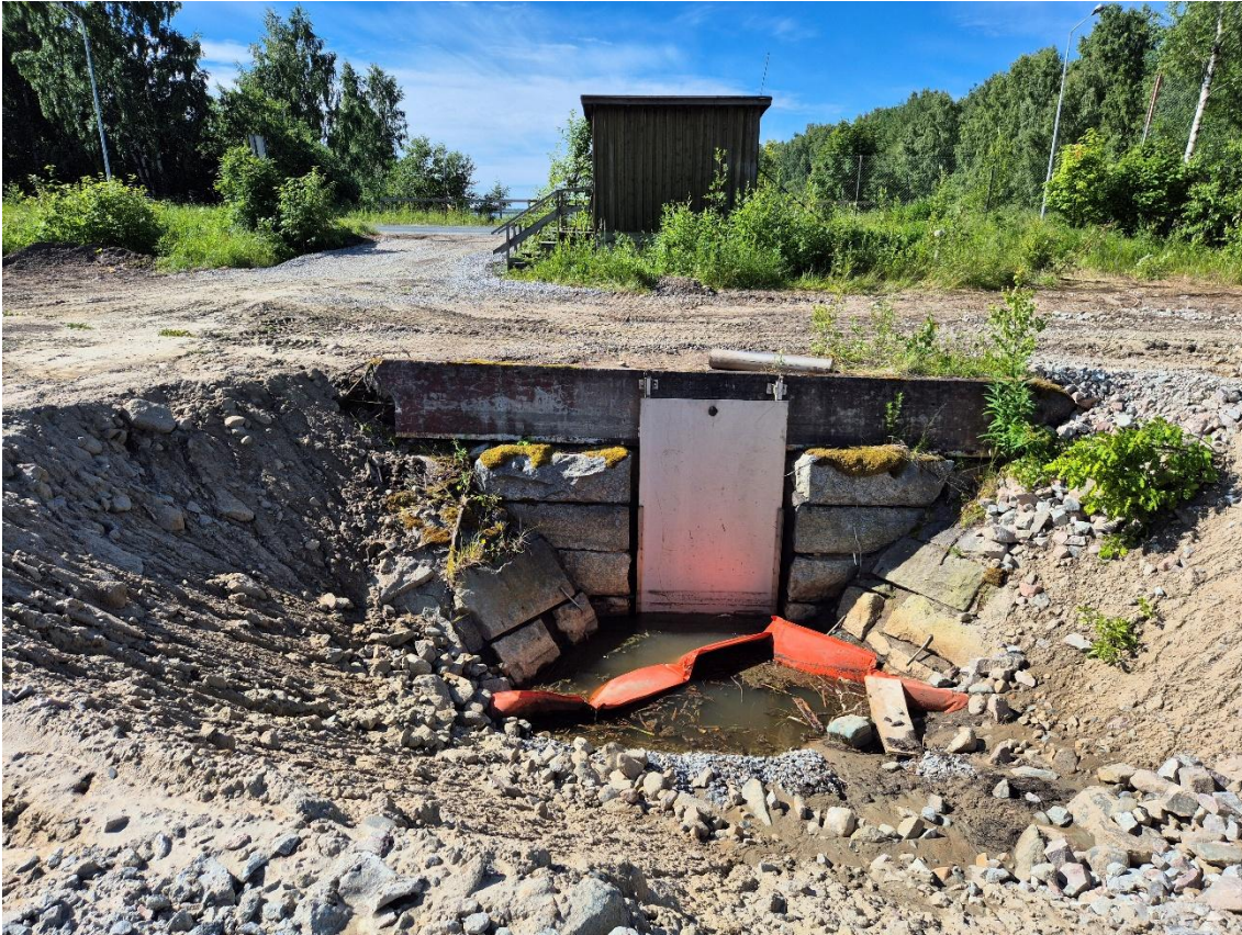
Kuva 5. Purkukohtaan rakennettu maapato sekä asennettu padottava metallilevy. Kuva otettu 2.7.2026.
