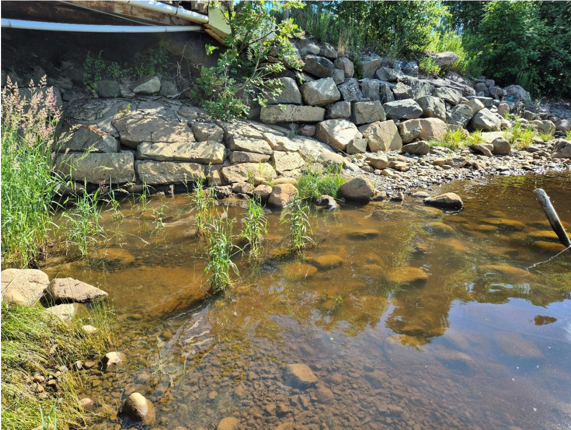
Kuva 6. Vesien purkukohta mereen kuvattuna meren puolelta. Kuva otettu 2.7.2026.
