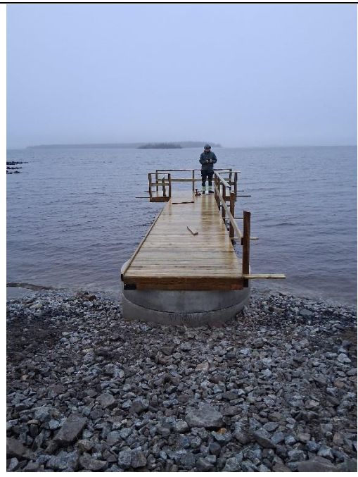
Laiturille rakennettiin kaiteet
