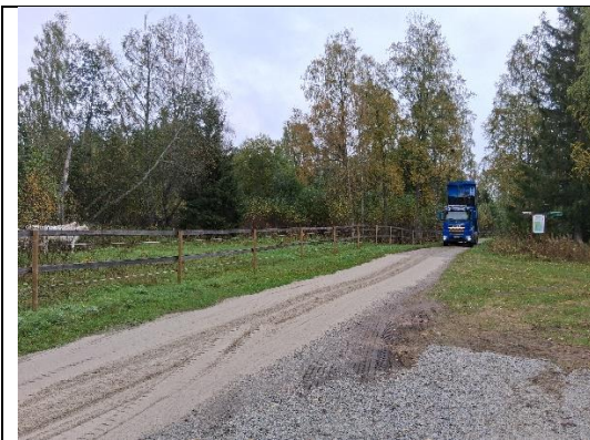
Kivituhka levitettiin kaseteilla. Lapin lehmät uteliaina.
