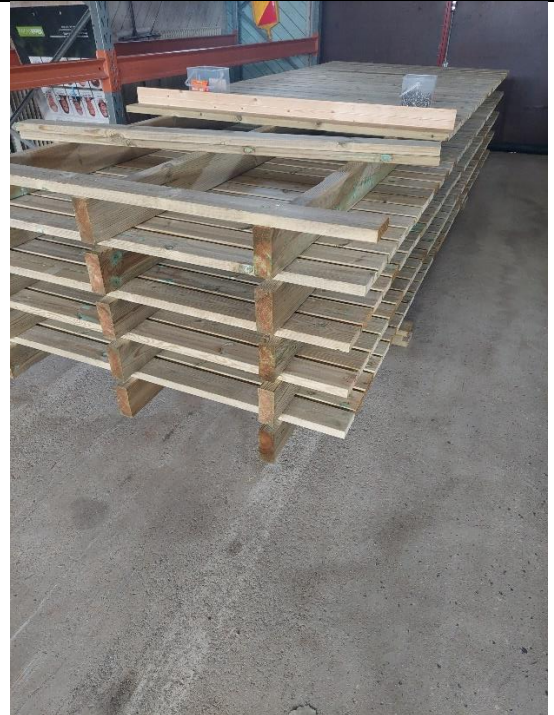
Pitkospuuelementit valmistettiin varikon hallilla. Kolme juoksua ja poikittaislaudoitus kantena.
