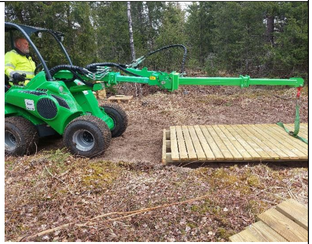
Elementtien siirto paikoilleen tapahtui yhden henkilön toimesta Avanti pienpyöräkuormaajalla
