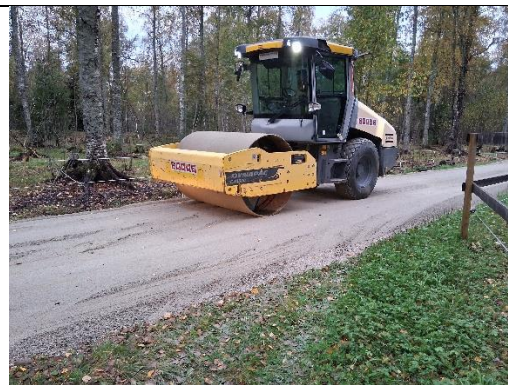
Kivituka valssattiin tiiviiksi ja tasaiseksi.
