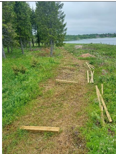
Parrut ja juoksut levitettiin maastoon. Hankalin osuus rakennettiin paikanpäällä
