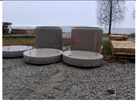
Laiturin perusuksina toimii kolme 5 tonnin kaivonrenkaita kansineen. Renkaat täytettiin kivimurskalla.
