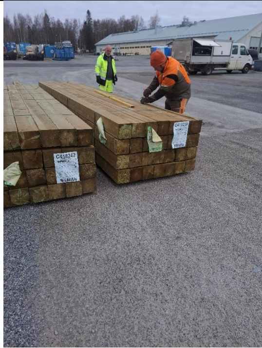
148x148 pitkospuiden niskoiksi tulleet parrut pilkottiin 150 cm pätkiin.
