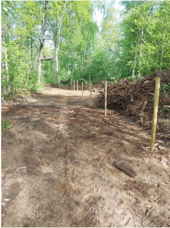
Esteet poistettiin lohkojen välistä
