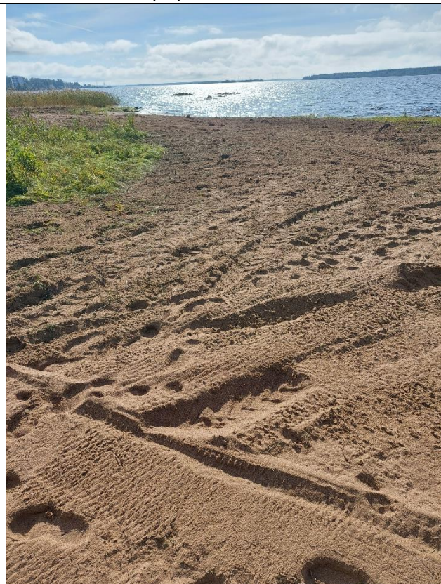
Jyrsinän jälkeen uutta mineraalimaata
