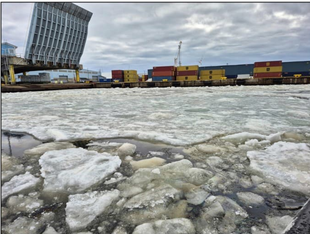
Kuva 24. Tutkimuspiste SF11 kolmannella tarkkailukerralla (27.3.2026), kuvaussuunta kohti itää. Veden pinnalla havaittiin öljykalvoa.
