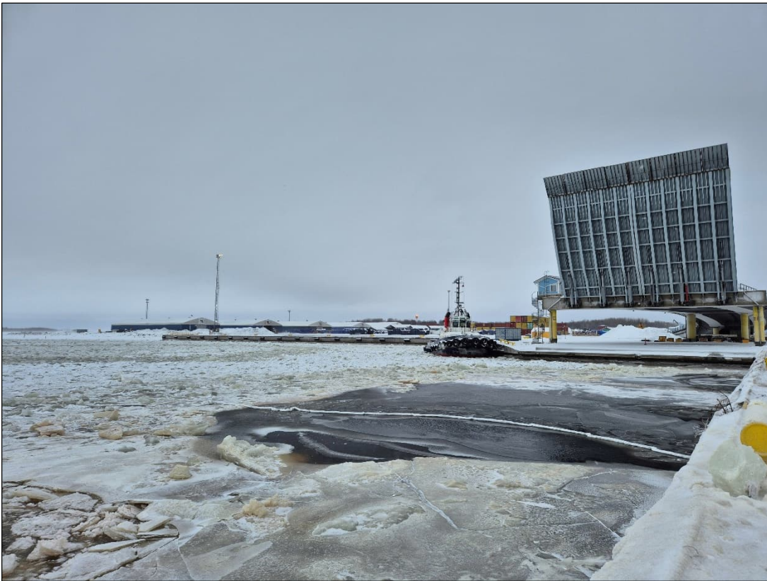
Kuva 7. Tutkimuspisteet SF1-SF3 ensimmäisellä tarkkailukerralla (18.2.2026), kuvaussuunta kohti koillista. Veden pinnalla havaittiin öljykalvo ja jää oli osittain värjäätynyt öljypäästön seurauksena. Alueella havaittiin polttoaineen hajua.
