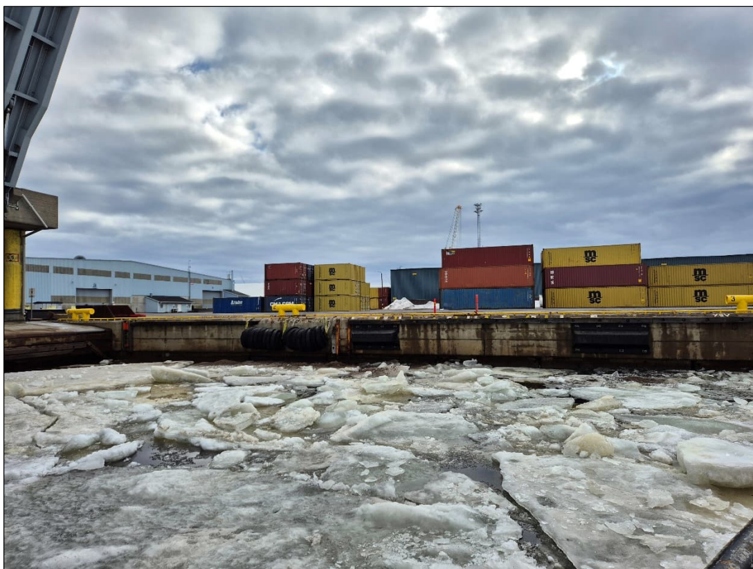
Kuva 25. Tutkimuspiste SF13 kolmannella tarkkailukerralla (27.3.2026), kuvaus-suunta kohti itää. Veden pinnalla havaittiin öljykalvoa.
