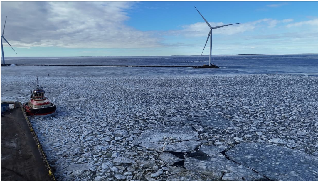
Kuva 20. Öljyvahinkoalue kolmannella tarkkailukerralla (27.3.2026), kuvaussuunta kohti länttä. Laituri 3 oli otettu takaisin satamakäyttöön ja väylää pidetty auki murtamalla jäätä.
