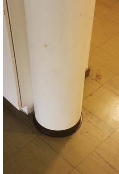
Tasoitettu ja maalattu betonipilari kerhuhuoneen ja sivukäytävän välissä.
