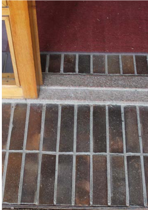
Tasalimimtetty tiillaatta kirkkosalin aulassa
