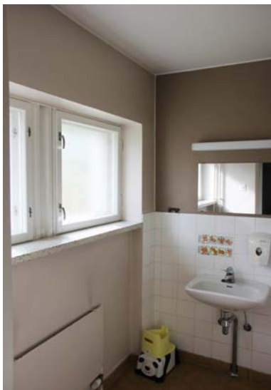
Kellarin tuulikaappi on säilynyt varsin alkuperäisenä. Putkia ja johtoja on lisätty pinta-asennuksina.
