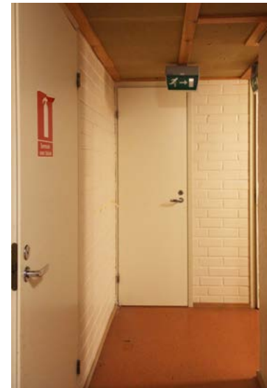
Kellarin laajennusosan 1980-luvun laakaovia.
