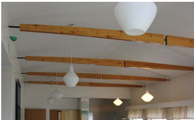
Ensimmäisen kerroksen aulassa on avoin sisäharja. Rakenne on jäykistetty teräksisillä vetotangoilla, joissa on puuverhoilu.
