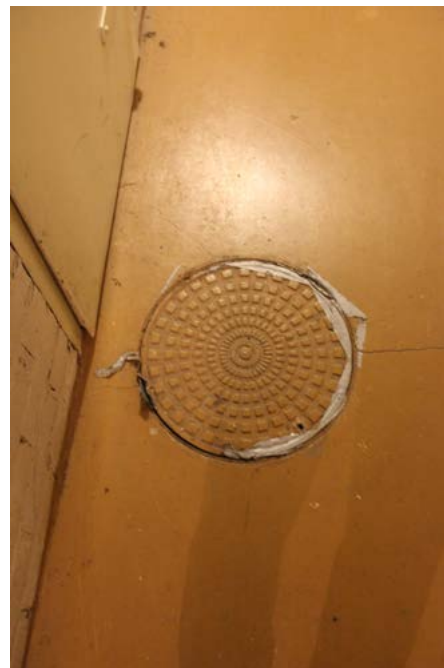
Kellarin lattian alla kulkee putkikanaali.
