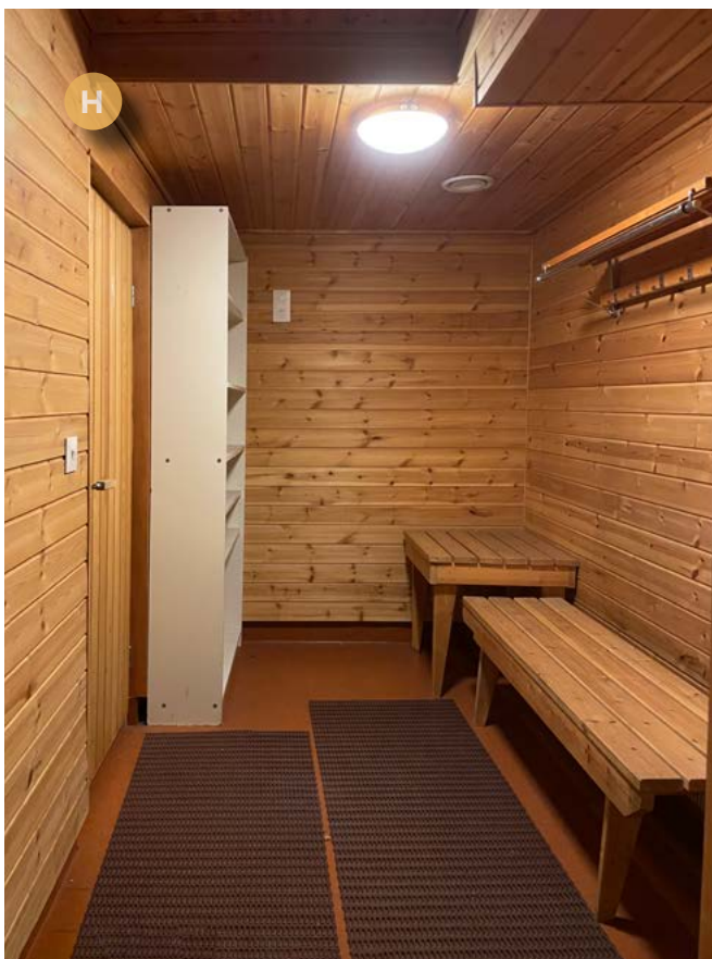
Saunan pukuhuone. Vasemmalla on pesuhuoneeseen johtava ovi. Tila on kauttaaltaan paneloitu ja lattiassa on muovimatto.
