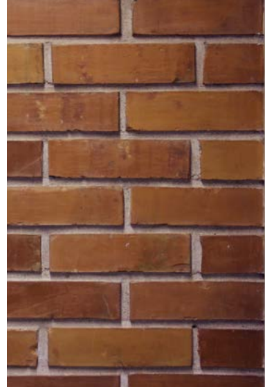
Kellarikerroksen kerhuhuoneen puhtaaksi muurattu punatiilliseinä.
