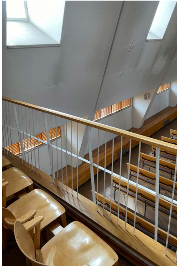
Lehterin etureunassa on kohteeseen suunniteltu metallipinnakaide. Käsijohde on tammea.
