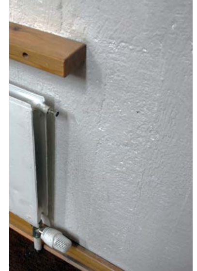
Kirkkosalin lehterin maalattu betoni-seinä.
