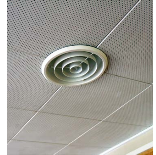
Kirkkosalin eteisaulan alas laskettu Soundex-akustiikkakatto on tehty perforoidusta puukuitulevystä.
