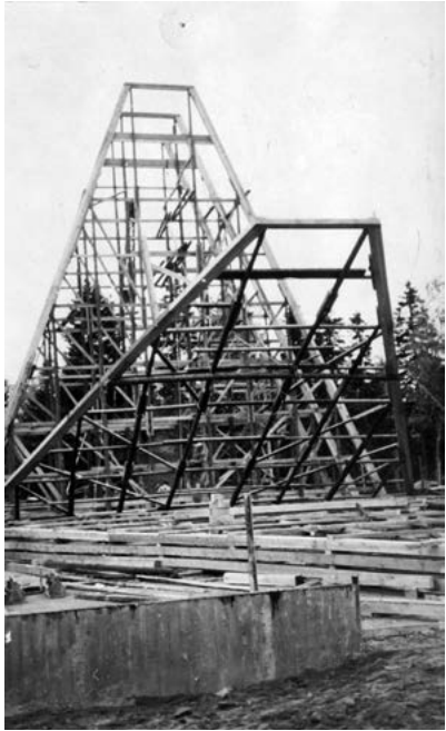
Kirkkosalin valumuotin suurta puukehää nostetaan paikoilleen. Kuvan etualalla on sakastin betoniperustus. KUVA: Valde Remeksen perikunta
