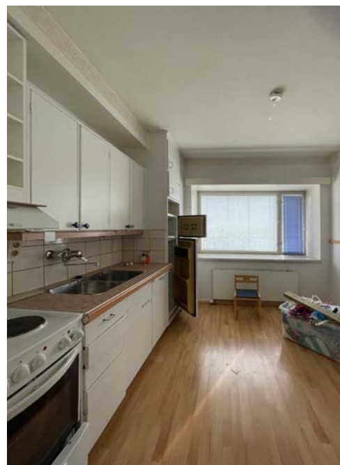
Alkuperäisiä keittiökalusteita on ajan saatossa muunneltu. Lattiaan on asennettu sauvaparketti.
