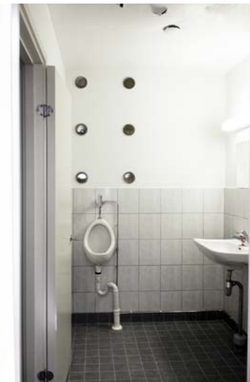
OIKEALLA: Pyöreistä kolmen tuuman saviputkista ja lasista muodostettu valoaukko.
