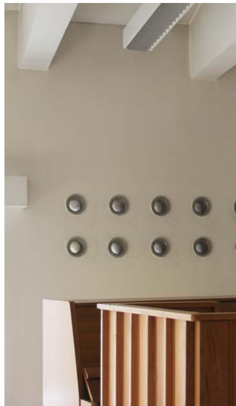
Seurakuntasalin korokkeen takana on pyöreiden saviputki-ikkunoiden rivistöt.
