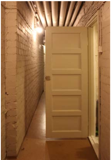
Kellarin tekniikka- ja varastokäytävällä on 1950-luvun puisia pelioivia.
