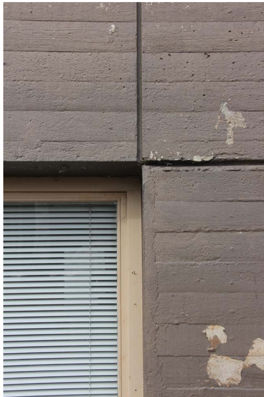
OIKEALLA: Betonisokkelissa on lautamuotin synnyttämä kuvio sekä elementti- jakoa jäljittelevä uritus.
