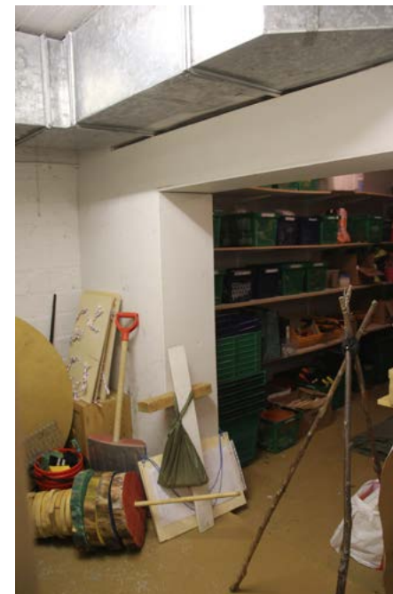
Varastotilaan on ripustettu laajennusosaan johtava ilmanvaihtokanava.
