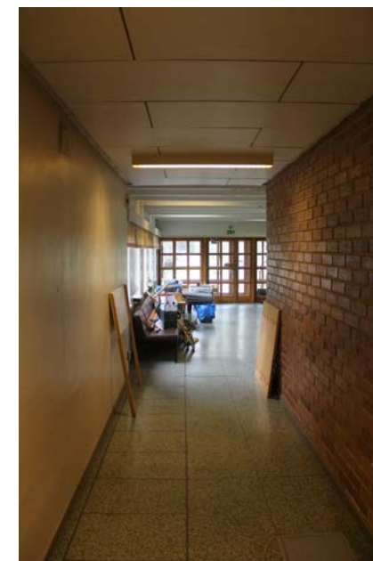
Näkymä sivukäytävän päästä kohti pääovea. Tiiliseinän takana on kerhohuone. Käytävän alakaton levytys on 1980-luvun kerrostumaa.
