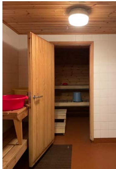
Saunan ja pesuhuoneen välinen pystypaneloitu puuovi.
