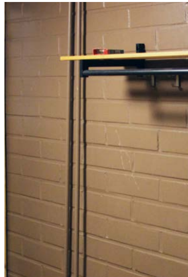
Kellarin laajennusosan käytävän maalattu kalkkihiikkakiviseinä.
