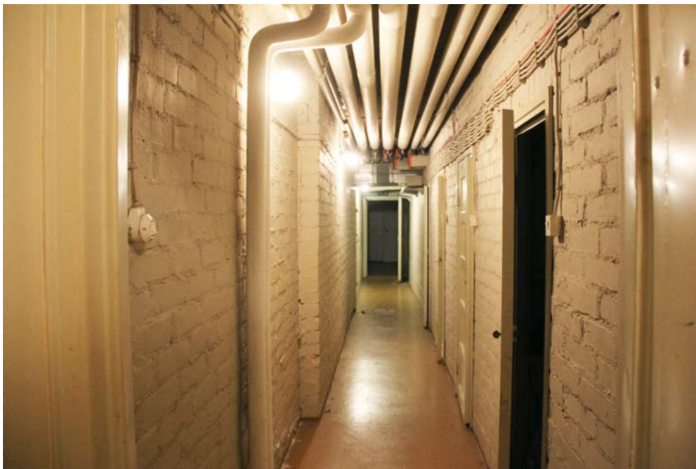
Kellarikäytävän tiiliseinissä on kalkkisively. Lattia on maalattua betonia. Alakattoon on ripustettu lämpö- ja käyttövesiputkistoja.
