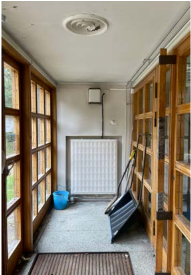
Kellarikerroksen tuulikaapin lasitetut tammiovet.
