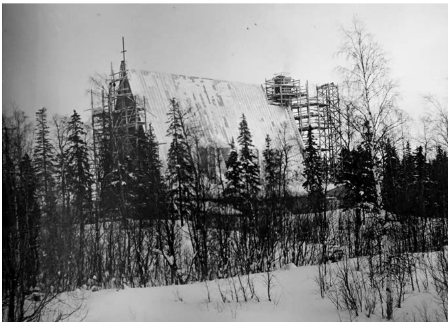
Veitsiluodon seurakuntakeskuksen rakennustyömaa talvella 1957, jolloin vesikatto on valmis. Kuva on otettu Haminalahden suunnasta eli luoteesta. KUVA: Kemin seurakunnan arkisto
