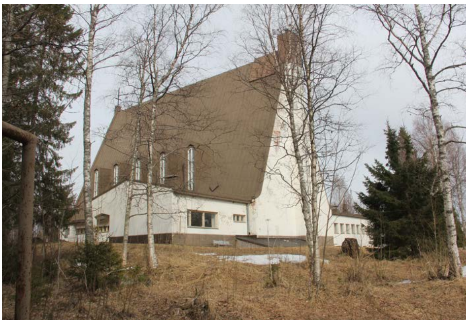
Seurakuntatalon takajulkisivu lounaaseen. Etualalla on länsisiipeen sijoittuva sakasti.
