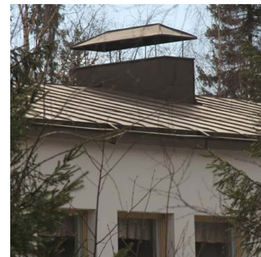
Seurakuntasalin katto on loiva satulakatto, jonka vesikourut ulottuvat julkisivulinjan ulkopuolelle.
