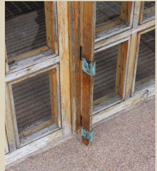
OIKEALLA: Kirkkosalin oven pitkässä tammivedin on kiinnitetty oveen pronssiholkeilla.
