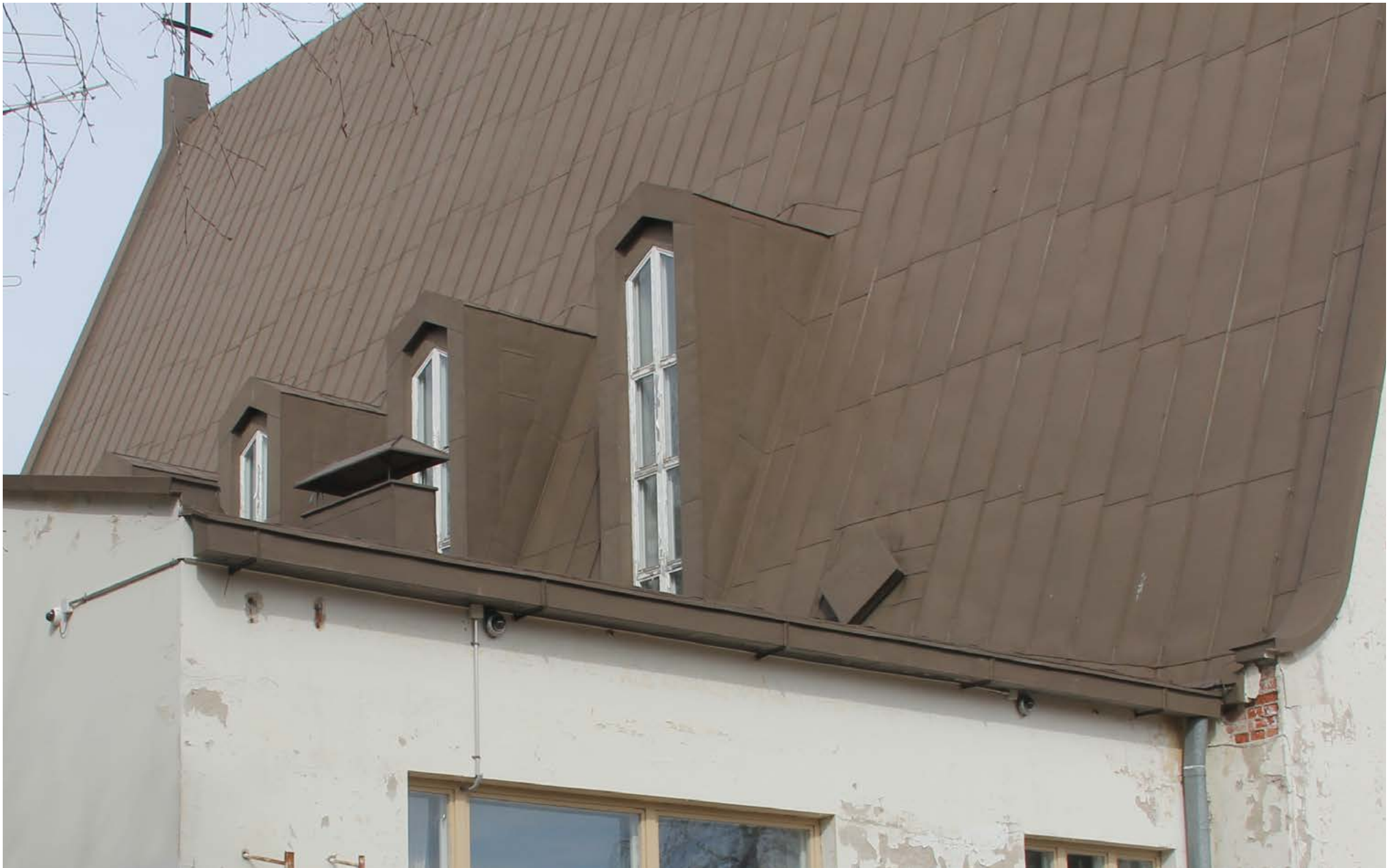
Etualalla on sakastin loiva räystäätön satulakatto. Taustalla on kirkkosalin vesikaton läntinen lape. Rappausvauriot osoittavat vesikaton ongelmakohtat.
