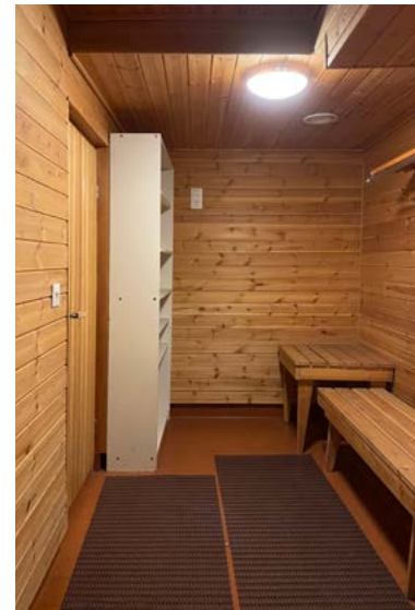
Sauna-osaston pukuhuoneen vaakasuuntainen mäntypanelointi.
