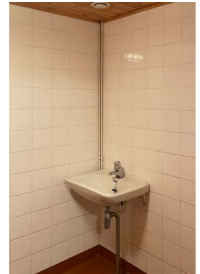
Saunan pesuhuoneen valkoinen seinälaatoitus.
