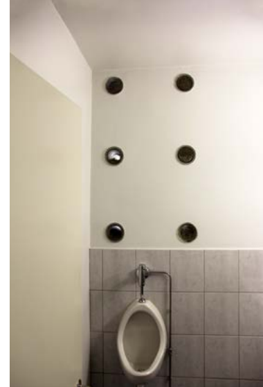
Kirkkosalin WC-tilojen seinien alaosaan on lisätty harmaa laatoitus.
