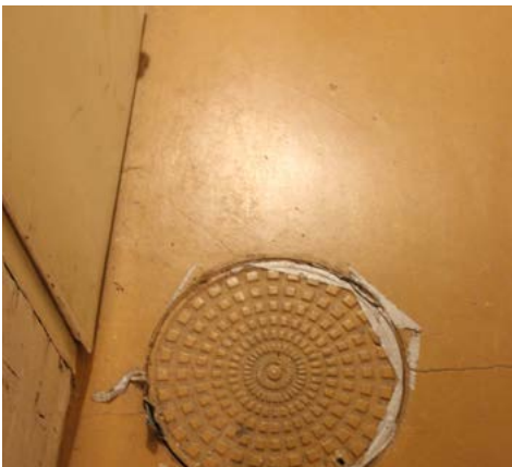
Kellarikäytävän maalattu betonilattia.
