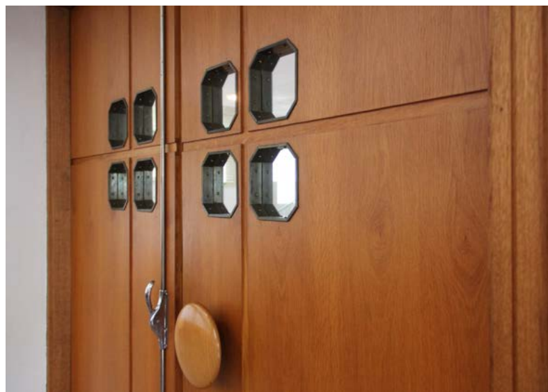
Aulan ja kirkkosalin välisten ovien lasiaukot on kehystetty mustalla metallilistalla. Oveissa on tamminen lautasvedin ja kromattu pitkäsalpa.
