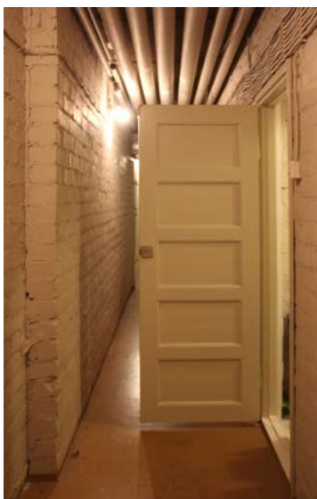
Kellarikäytävän tiiliseinissä on kalkkisively. Lattia on maalattua betonia. Alakattoon on ripustettu lämpö- ja käyttövesiputkistoja.
