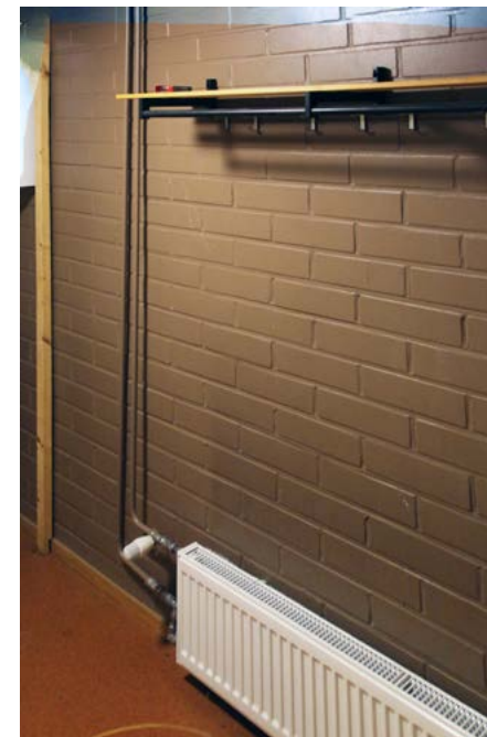
Laajennusosan käytävässä on ruskeaksi maalatut tiiliseinät. Käytävä toimii sisäänkäyntiin liittyvänä vaate-eteisenä.
