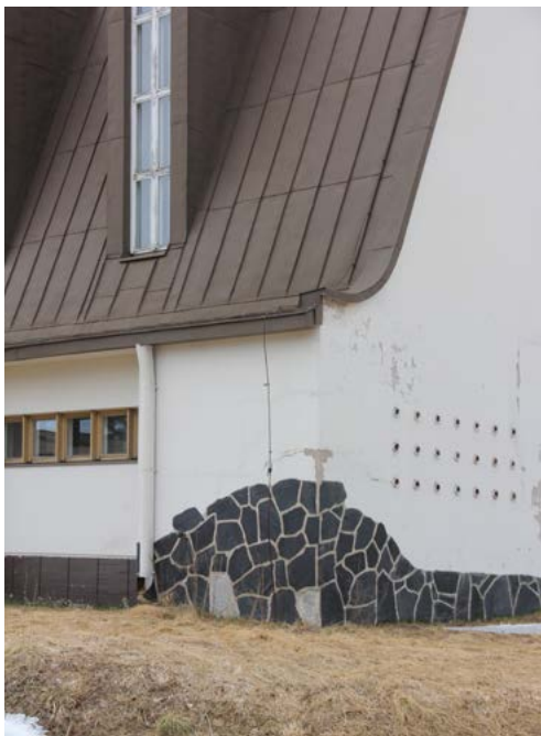
Kirkkosalin katon räystääs päättyy kaarevaa nostoon.
