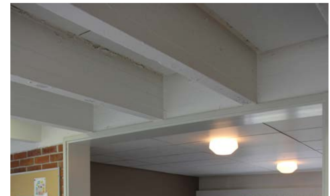
Kellarikerroksen aulassa ylälaattaa kannattava betonipalkisto on näkyvillä. Palkkien väleissä on akustiikkalevyt.
