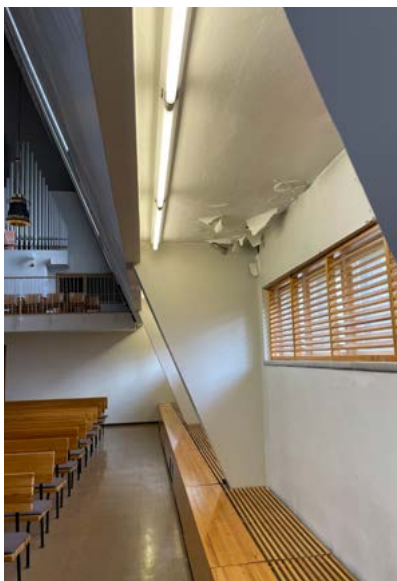
Sivulaipioihin on sijoitettu seinän alaosaan valaisevat jonovalaisimet.
