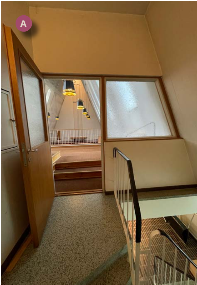
Portaan ylätasanne on erotettu lehteristä lasitetulla väliovella. Oven rinnalla on vino sisäikkuna.
