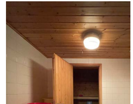
Saunaosaston paneloitu alakatto.
