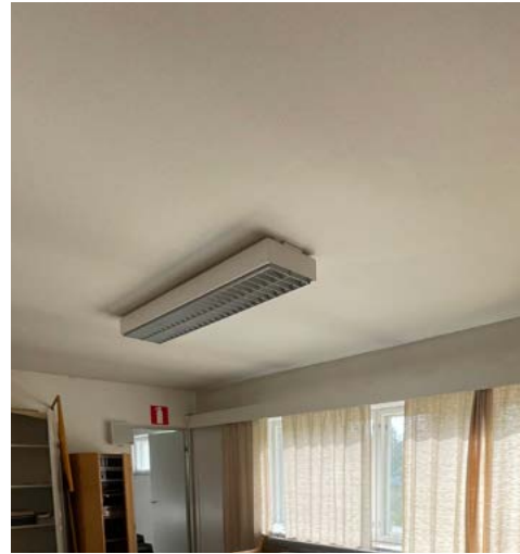
Sakastin tasoitettu ja maalattu alakatto. Tilassa on yläpalkkilaatta.
