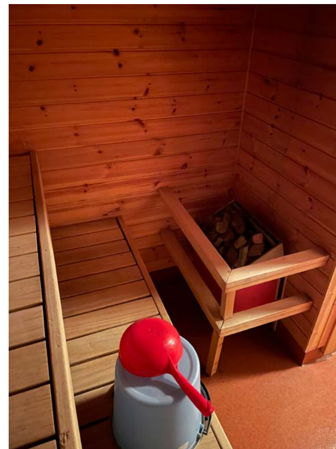
Saunassa on tehdasvalmisteiset lauteet ja sähkökivas. Kivas on suojattu puukaiteella.
