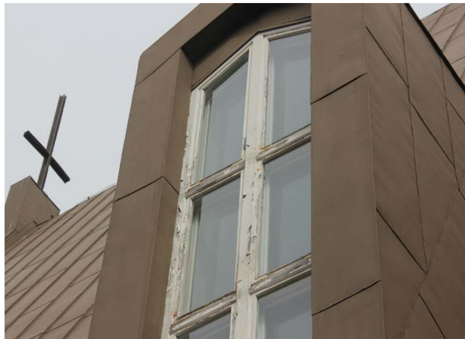
Ikkunalyhdyt on pellitetty vesikattomateriaalilla. Puurunkoiset ikkunat ovat hienoisessa syvennyksessä.
