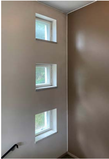
Porrashuoneen tasoitetut seinät on maalattu puolikiiltävällä öljymaalilla.
