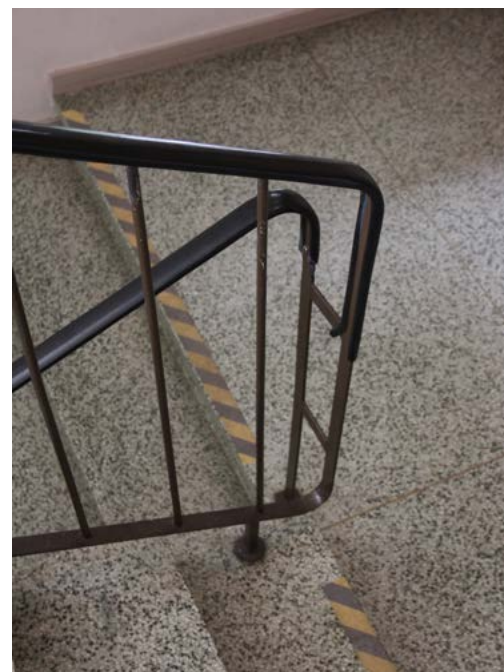
Mosaiikkibetonipintaista porrasta reunustaa teräksinen pinnakaide, jonka käsijohde on muovia.
