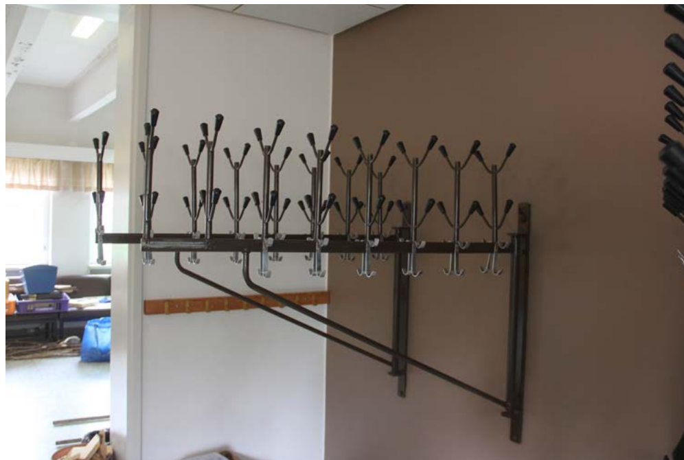
Kääntyvät seinänaulakot ovat Veikko Larkaksen toimiston kohteeseen suunnittelemat. Naulakossa on erikseen hattu- ja vaateripustimet.
