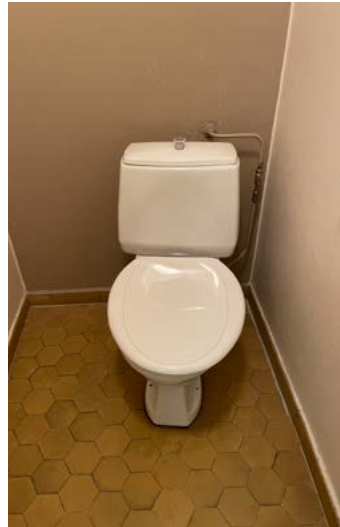
WC-istuimet on uusittu 1980-luvulla.
