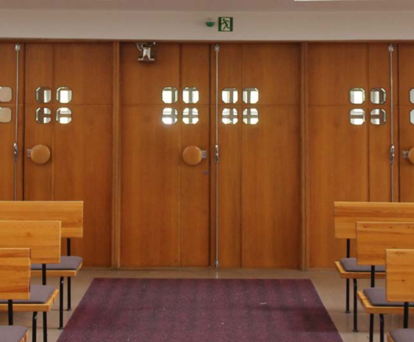
Aulan ja kirkkosalin ikkunalliset väliovet ovat kohteeseen suunniteltuja ja valmistettuja tammiviiluvia.
