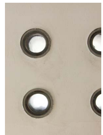
OIKEALLA: Pyöreistä kolmen tuuman saviputkista ja lasista muodostettu valoaukko.
