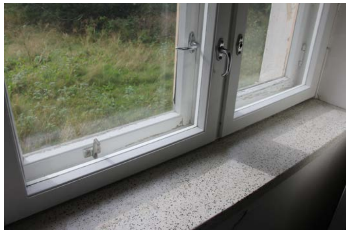
Kokoushuoneen kaksilasiset ikkunat ovat alkuperäiset. Ikkunapenkki on mosaiikkibetonia.
