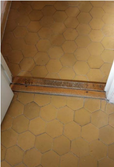
Pukkilan kuusikulmainen lattialaatta WC:ssä
