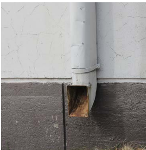
Sadevesisyöksyt ovat alkuperäisiä ja reilusti mitoitettuja. Vesi päättyy useimmiten pihalle.
