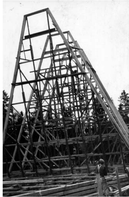
Neljä ensimmäistä maassa rakennettua puukehää on pystytetty. Etualalla on kirkkosalin perustuksen muottirakenteita. KUVA: Valde Remeksen perikunta
