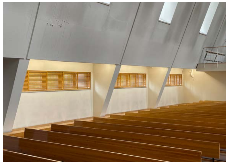
Sivulaipioihin on sijoitettu seinän alaosaan valaisevat jonovalaisimet.
