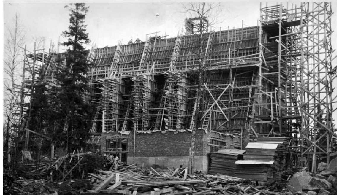
Kirkkosalin länsilapteen sisäpuolinen muotti on valmis ja kirkkosalin eteläpääty on muurattu. Etualalla on räystäskorkeuteen muurattu sakastisiipi. Sakastin seinustalle on pinottu määrämittaan leikkautta puutavaraa. KUVA: Valde Remeksen perikunta
