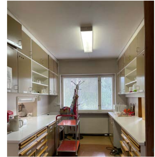
Keittiön tasoitettu ja maalattu alakatto. Tilassa on yläpalkkilaatta.
