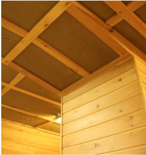
Kellarin kerhuhuoneen alakatto on tehty puukuitulevyistä ja mäntyrimoista.
