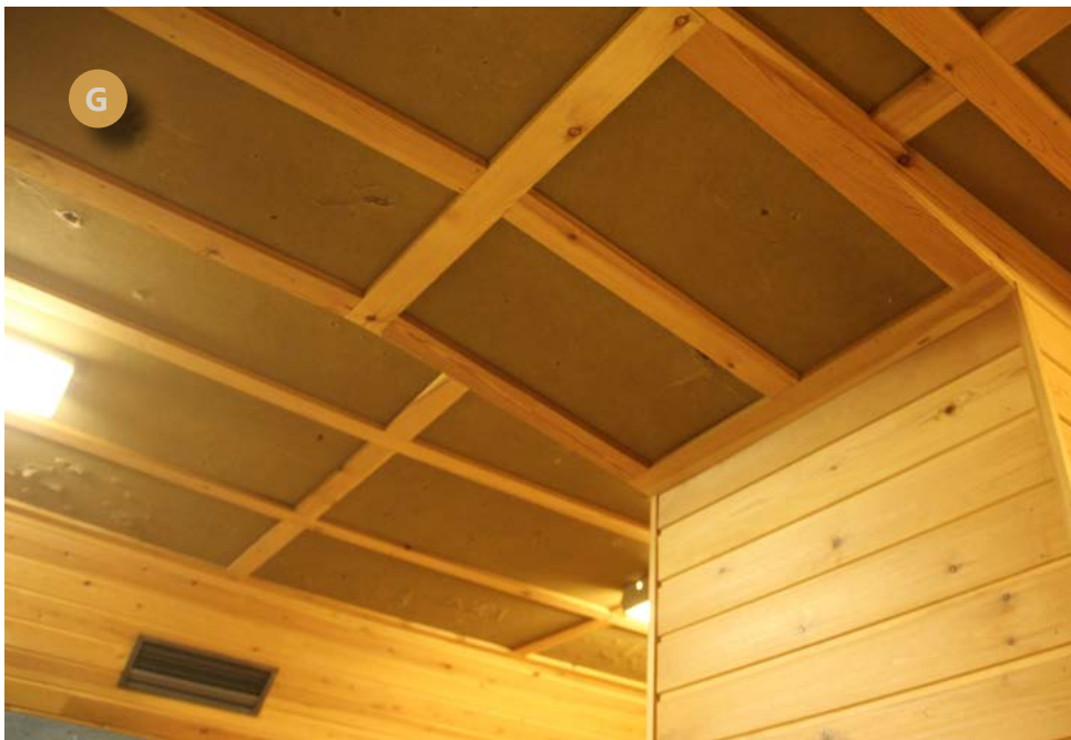
Kerhuhuoneen alakatto on tehty ruskeasta puukuitulevystä, jonka saumat on peitetty mäntyrimoilla. Seinät on paneloitu kuultokäsittellyllä mäntypaneelilla.
