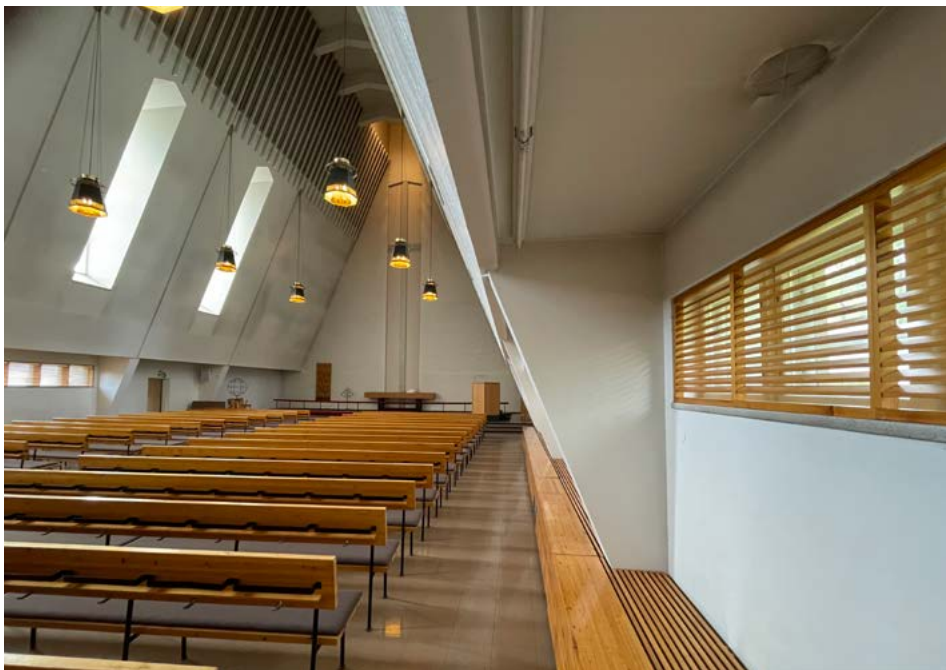
Matalat seinäsyvennykset korostavat kirkkosalin tilallista dynamiikkaa. Nauhaikkunoiden puurilät ja lämpöpattereiden verhoiluksi tehdyt puupenkit ovat vuoden 1983 lisäyksiä.
