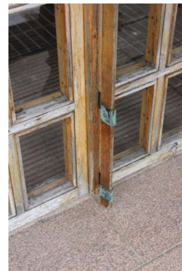
Ulkotaso on punaista graniittia. Ulko-ovi on kynnyksetön. Kupariset kiinnikkeet ovat patinoituneet.
