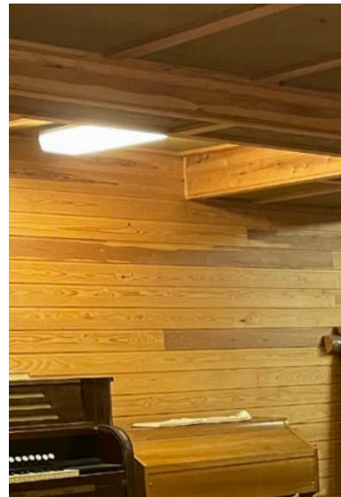
Kellarin laajennusosan kerhuhuoneen vaakaneloitu seinä.
