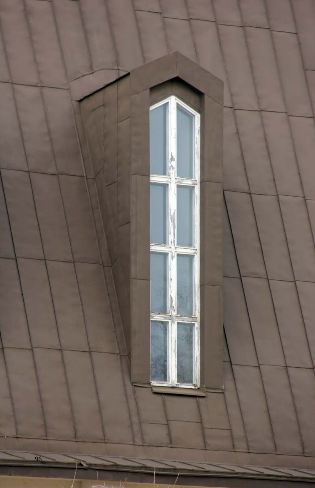
OIKEALLA: Kirk- kosalin yläikkuna antaa epäsuoraa luonnonvaloa sy- vennyksen seinien kautta. Voimak- kaasti viistetty ikku- napenkki on tehty mosaiikkibetonista.
