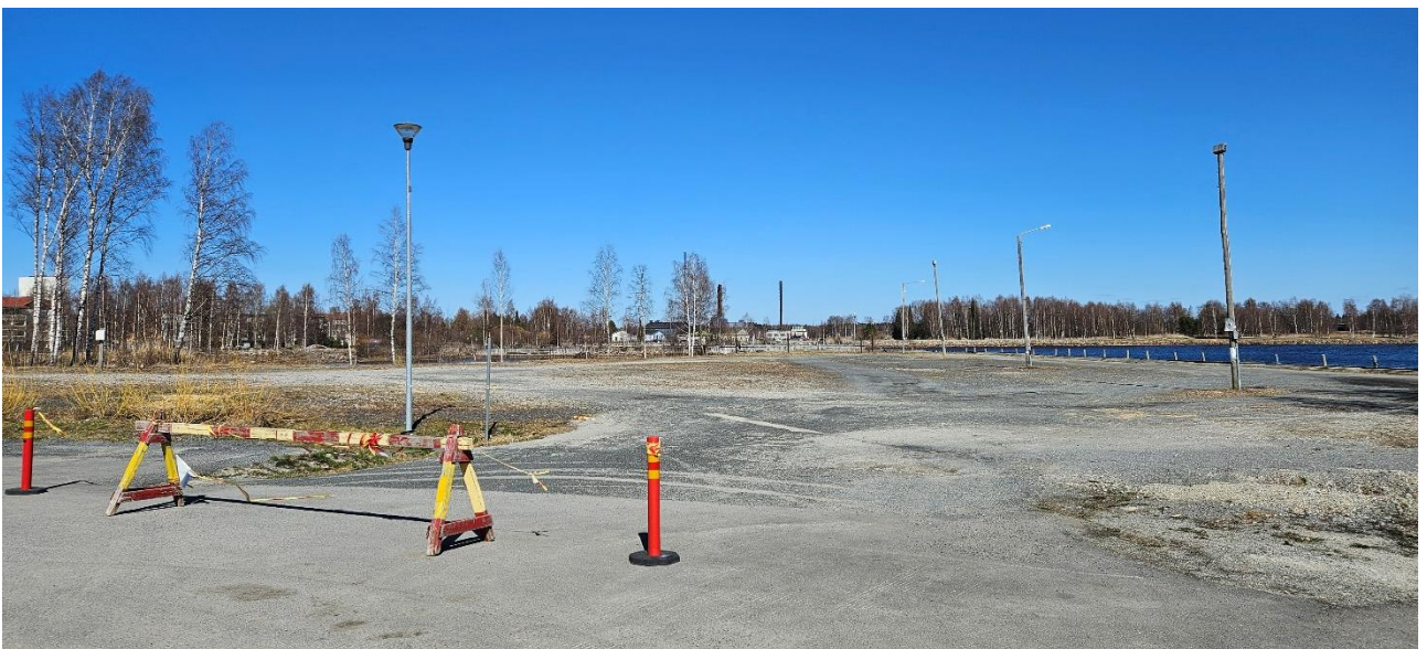
3. SUUNNITTELUALUE ON OSITTAIN HYVINKIN JÄSENTYMÄTÖNTÄ. Kuvassa lumilinnan päärakennuksen edustalla sijaitseva alue, joka on vielä pari vuotta sitten toiminut veneiden säilytyspaikkana. (5/2025)
