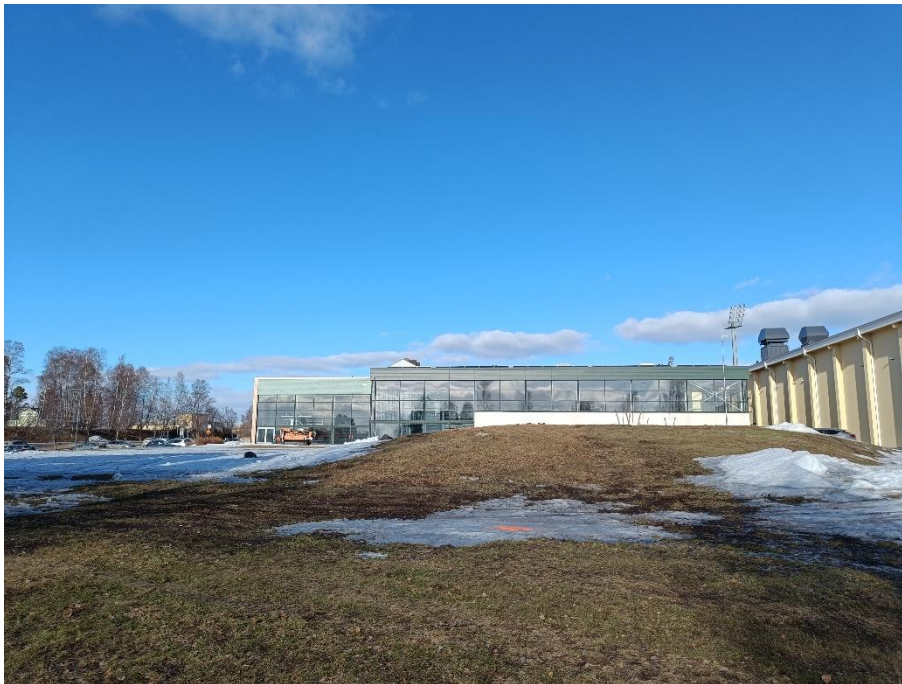
Kuva 3. Yleiskuva kohteesta. Kuvaussuunta koilliseen.
