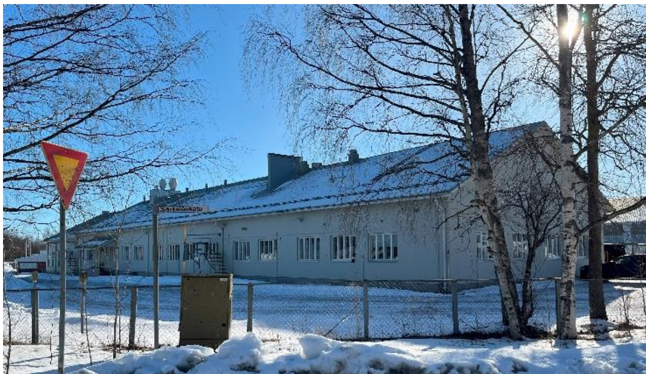
9. Korjaamorakennus (nro 1) Särkelänsäädun ja Kalkkinokantien risteyksestä eli pohjoisesta päin kuvattuna.
