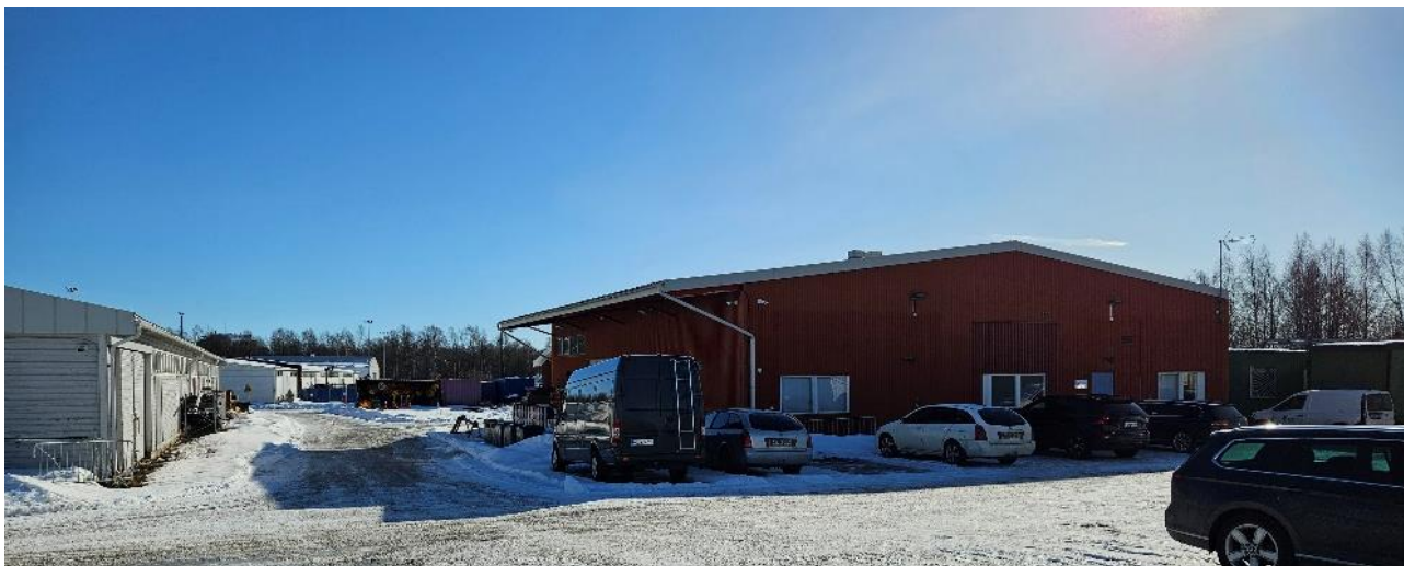
14. Kaupungin varikon entinen kiinteistöhuollon ja korjauksen toimitilarakennus (nro 5).
