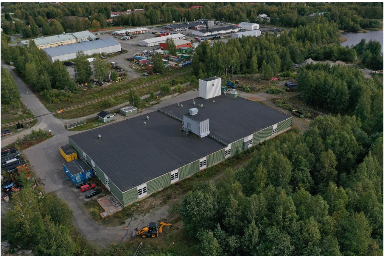
27. Nykyinen jätevedenpuhdistamo, joka sijoittuu kaava-alueen länsipuolelle. Kaava-alue kuvassa jätevedenpuhdistamon takana.
