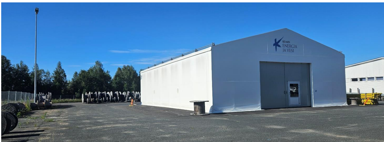
18. Kemin Energia ja Vesi Oy:n varastohalli (nro 9).
