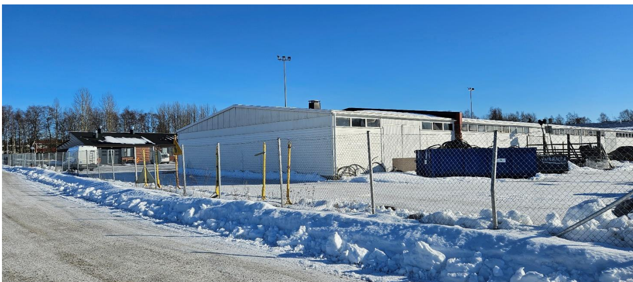
16. Kemin Energia ja Vesi Oy:n varastorakennus (nro 7).
