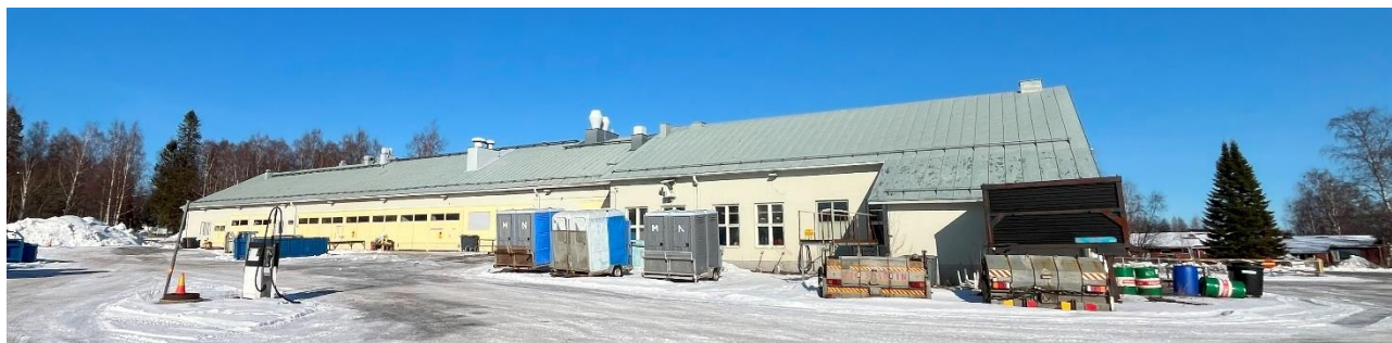
8. Kaupungin varikon korjaamorakennus (nro 1) etelästä päin kuvattuna.
