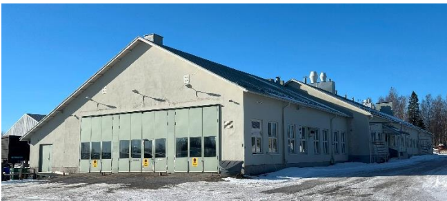
21. Korjaamorakennus (nro 1) idästä päin kuvattuna.
