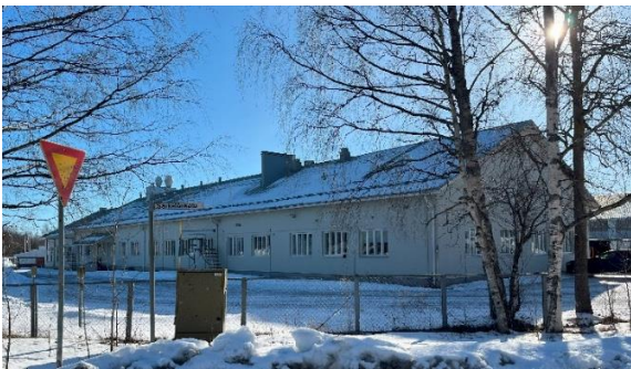
20. Korjaamorakennus (nro 1) Särkelänsäädun ja Kalkkinokantien risteyksestä eli pohjoisesta päin kuvattuna.
