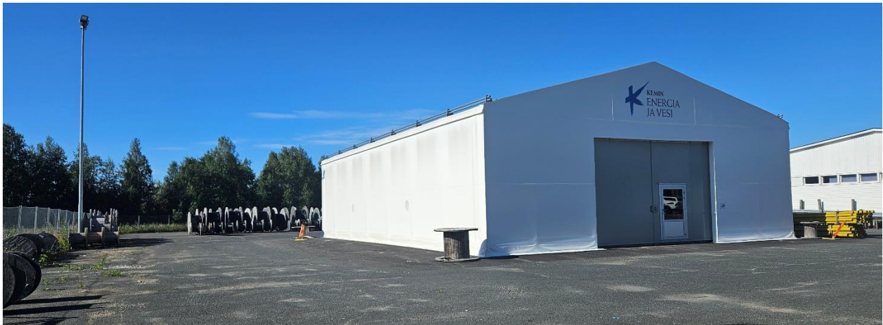
30. Kemin Energia ja Vesi Oy:n pressuhalli, joka toimii kylmänä varastotilana.
