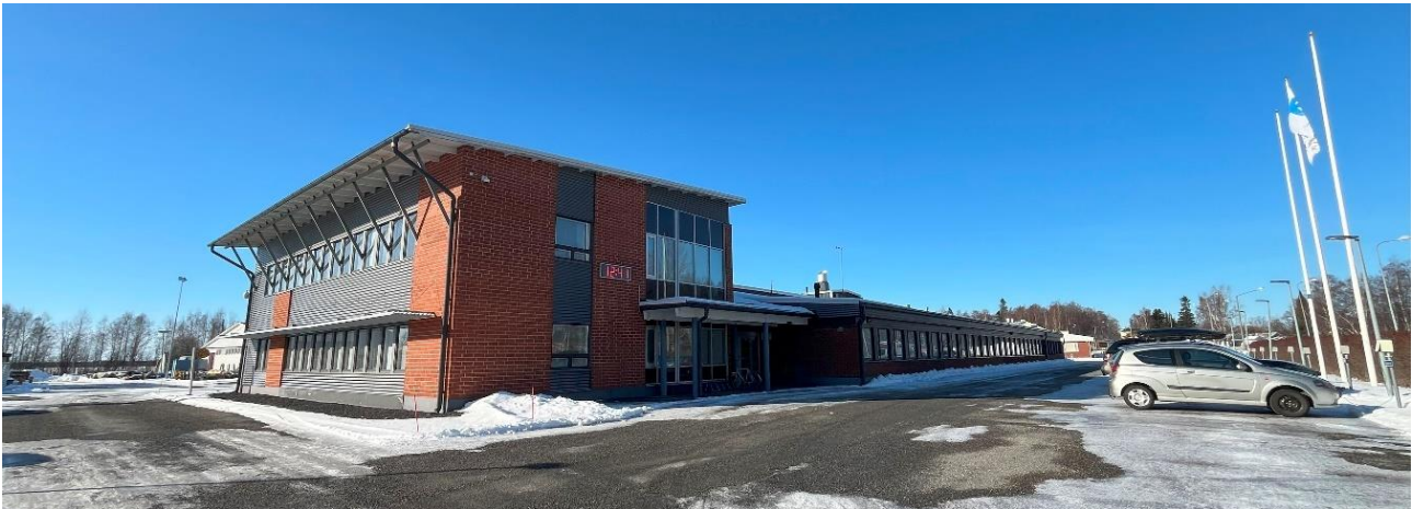
27. Kemin Energia ja Vesi Oy:n toimitilarakennus , johon sijoittuu toimisto-, sosiaali- ja verstaattiloja. Kaavamuutoksella ei ole vaikutusta rakennuksen käyttöön.
