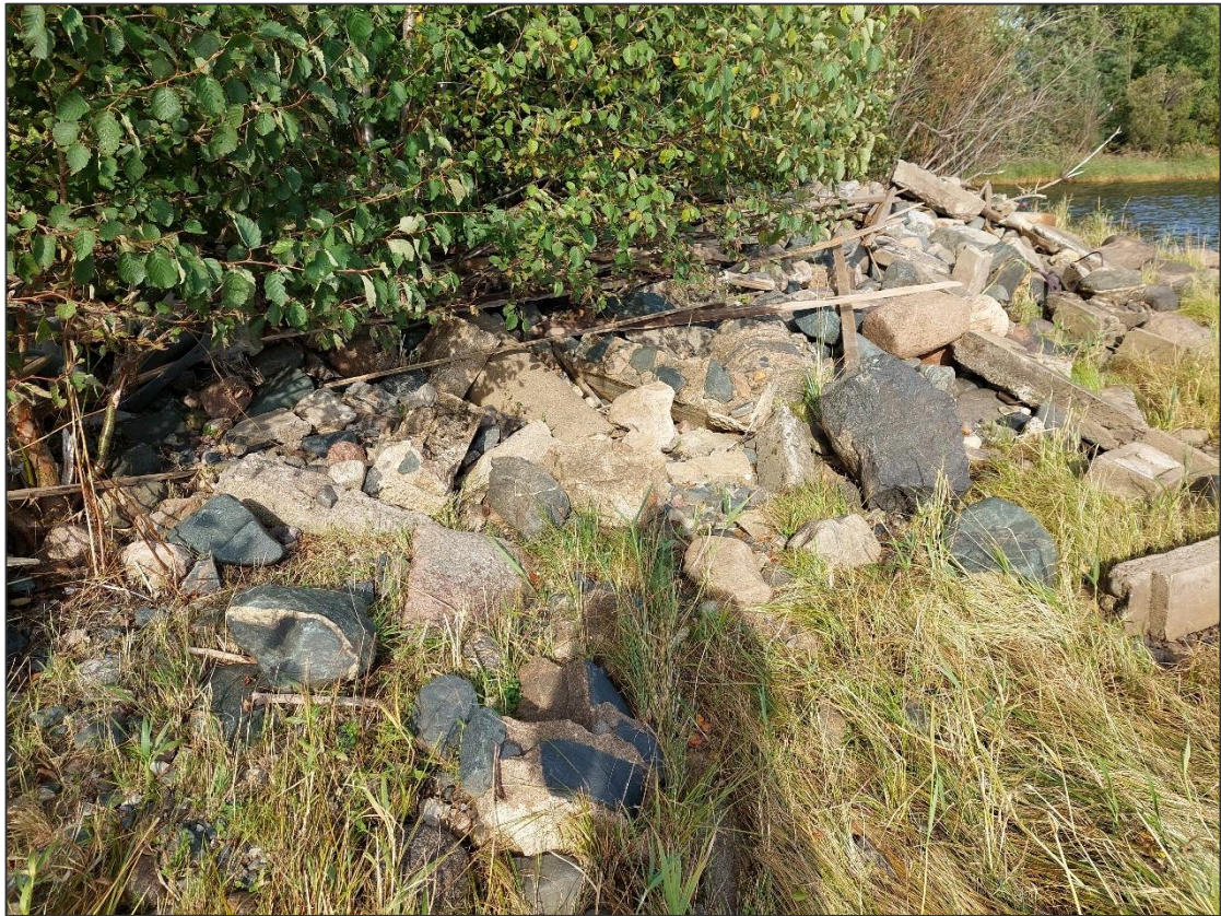
Kuva 5. Täyttöalueen ranta-alueella havaittiin maanpinnalla kivien seassa betonia. Alueen eteläosa, kuvaussuunta itään. (4.9.2024)
