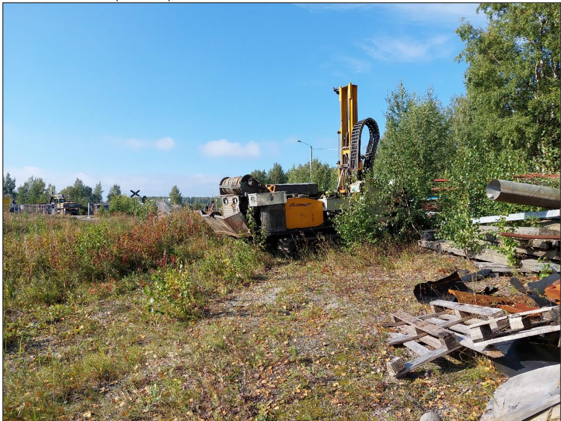
Kuva 6. Keskusvaraston kiinteistön tutkimuspisteen KK20 kairausta. Kuvaussuunta luoteeseen. (5.9.2024)
