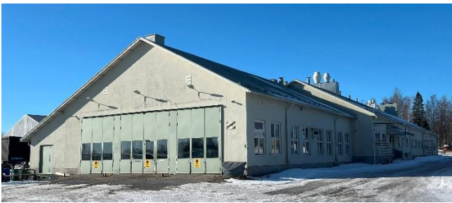
12. Korjaamorakennus (nro 1) idästä päin kuvattuna.
