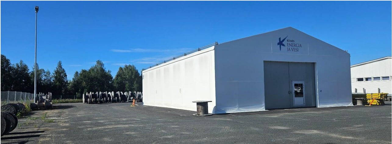
21. Kemin Energia ja Vesi Oy:n pressuhalli, joka toimii kylmänä varastotilana.
