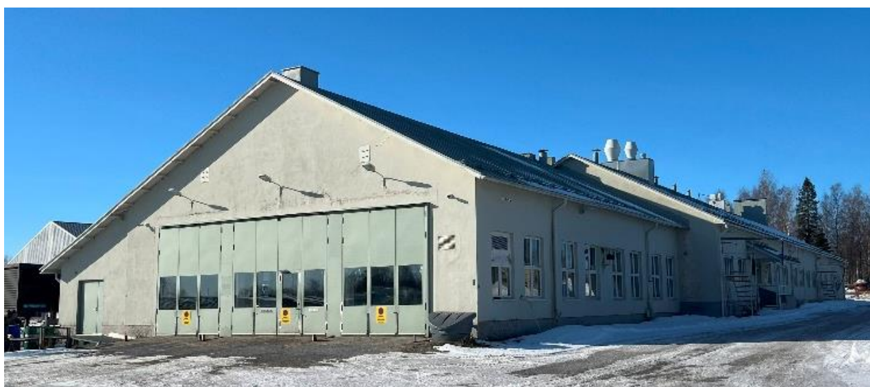
7. Korjaamorakennus (nro 1) idästä päin kuvattuna.
