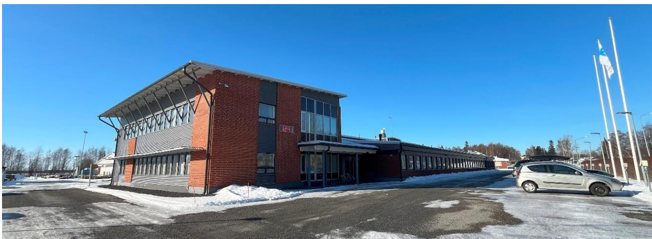
12. Kemin Energia ja Vesi Oy:n toimitilarakennus (nro 6).
