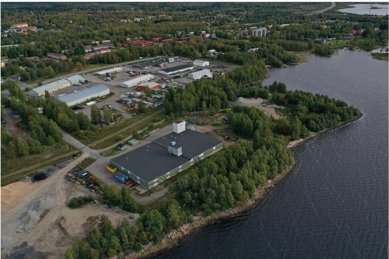
21. Nykyinen jätevedenpuhdistamo (kuvassa etualalla) sijoittuu suunnittelualan länsipuolelle.
