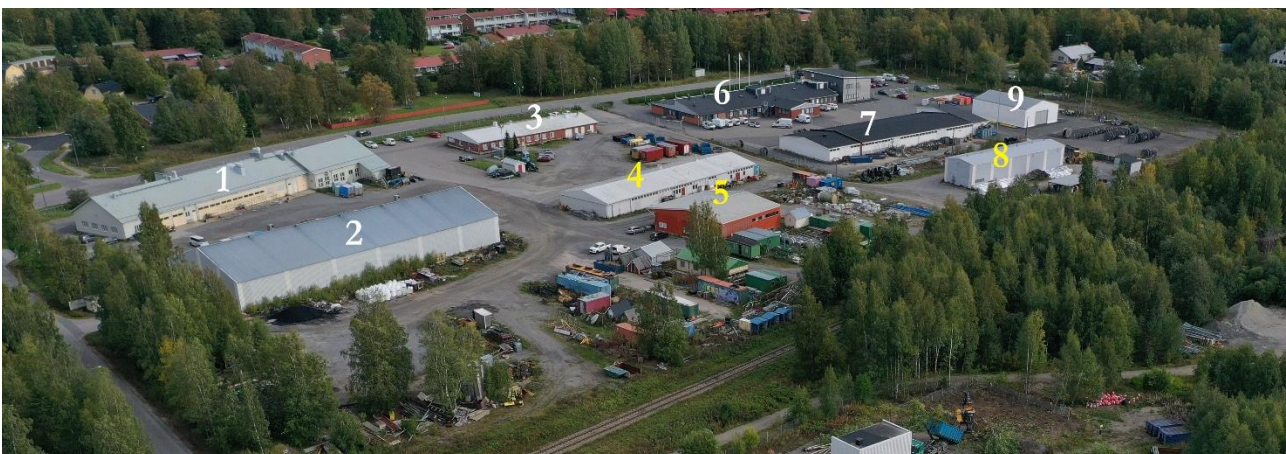
4. Suunnittelualueen rakennukset numeroituina (selitykset alla). Keltaisella merkitty uuden jätevedenpuhdistamon alta purettavat rakennukset.
