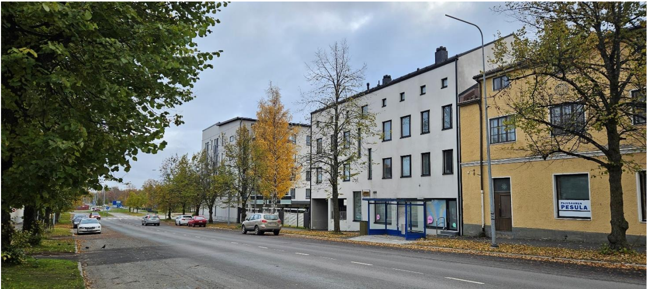
18. Suunnittelualan välittömässä läheisyydessä sijaitsevat kerrostalot (Valtakatu).
