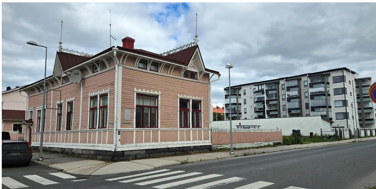
4. Näkymä Etelärantakadulta, etualalla Kaakisen rakennus.
