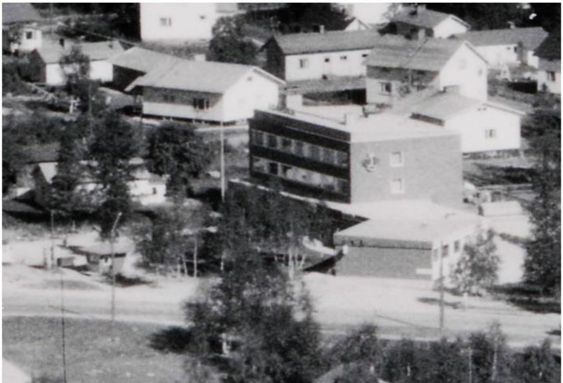
Toivolan rakennus lounaasta
