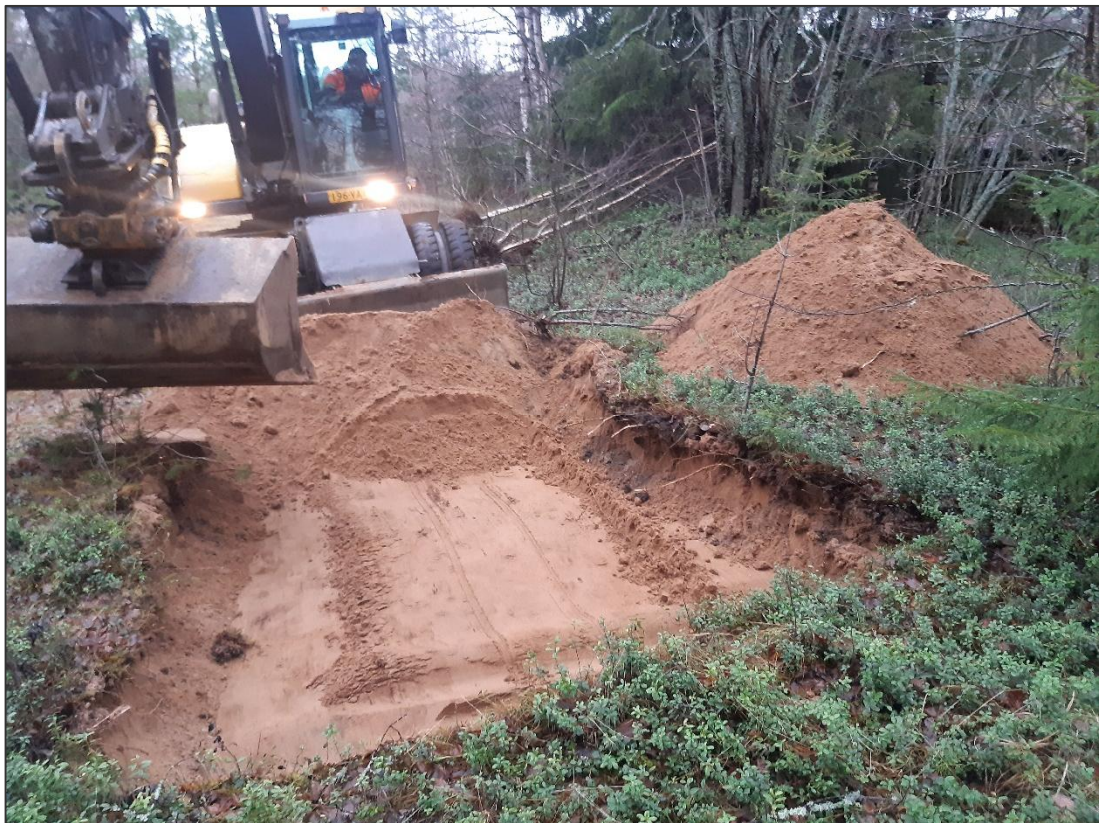
Kuva 4. Koekuopan KK8 kaivua (2.11.2021).
