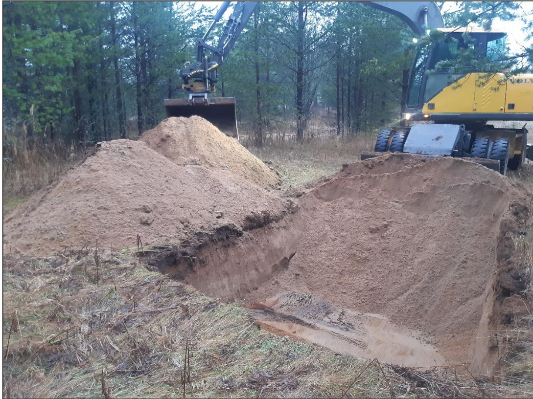
Kuva 3. Koekupan KK2 kaivua (1.11.2021).
