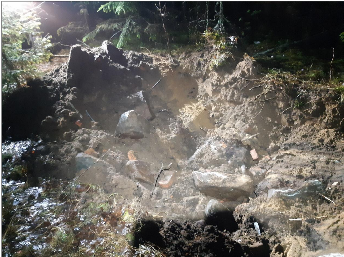
Kuva 4. Koekuopassa KK7 todettiin tiilijätettä maaperän pintakerroksissa (1.11.2021).
