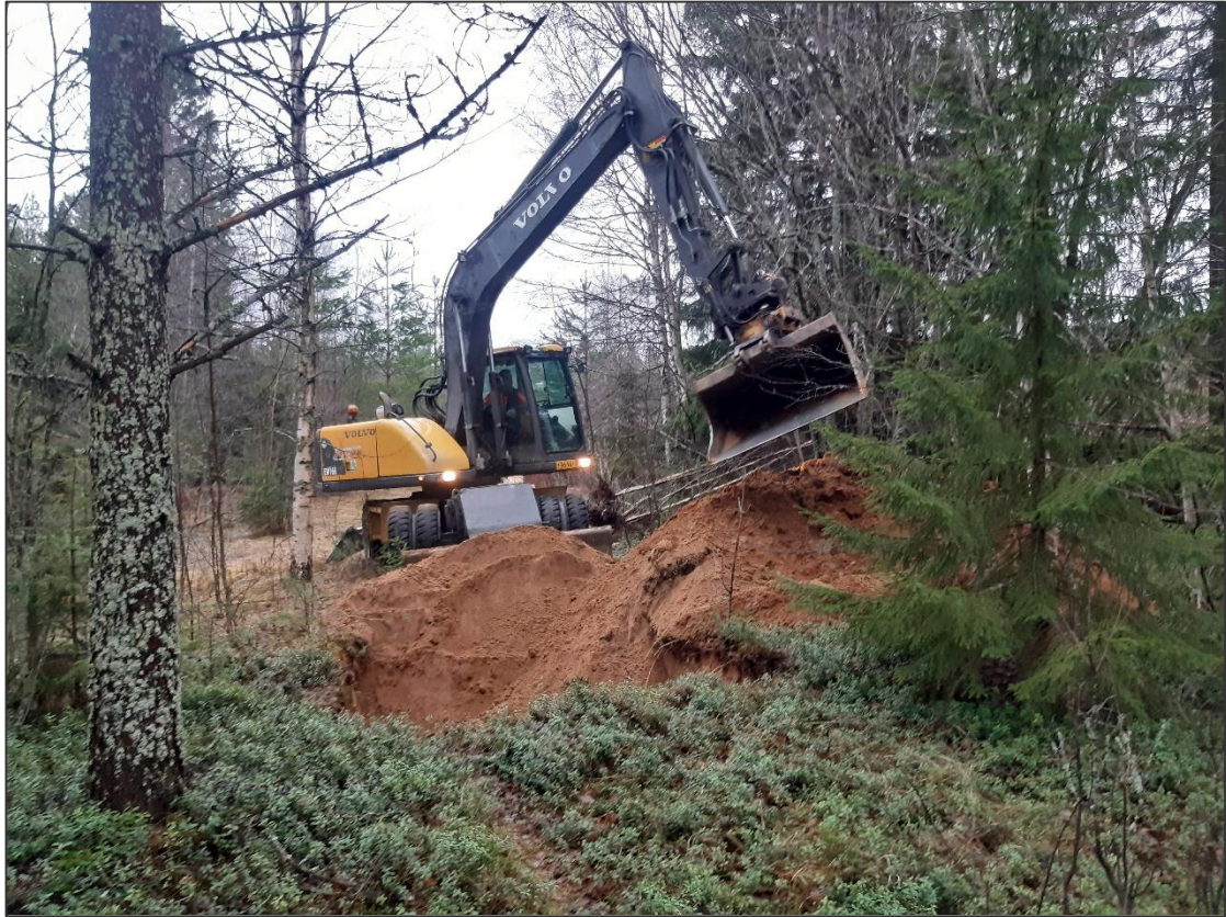
Kuva 1. Koekuopan KK8 kaivua (2.11.2021).
