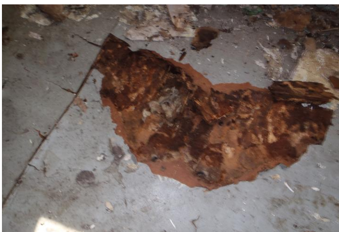
33-34. Pihapään huonetilassa lattia eristeineen päädyssä laho laudoituksen päällä, talon alla alapinnassa kosteusjälki
