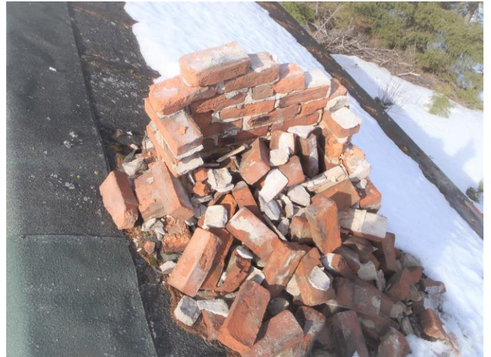
25-26.Vesikaton kattuhuopa heikkokuntoinen takalappeella(pihalappeella korjattu).Yksi piipuista romahtanut
