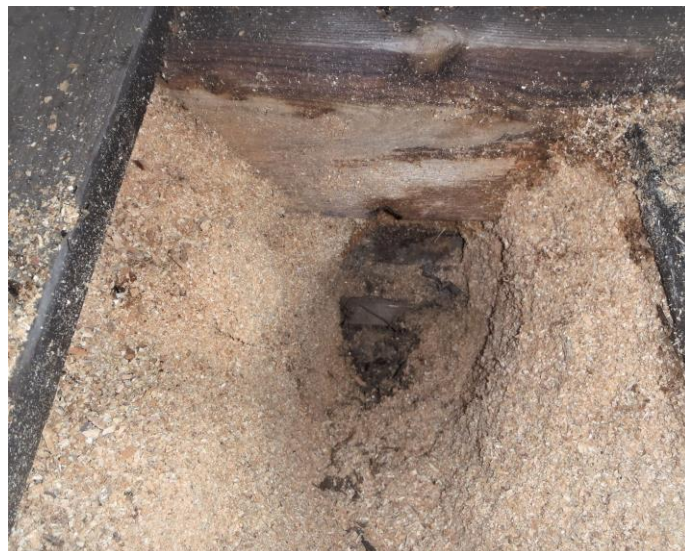
11-12.Ulkoseinäyläosissa/yläpohjassa takasivulla (k/mh-kulmalla ja k:ssä piipun alla ympärillä) merkkiä kosteusvaurioita
