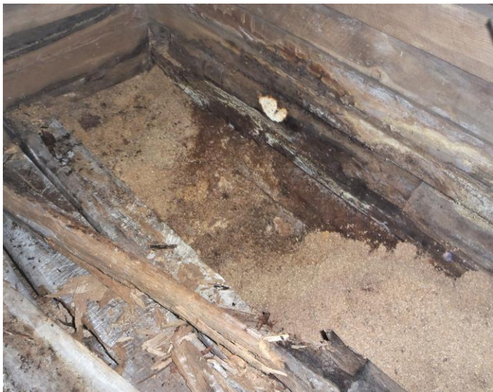
11-12.Ulkoseinäyläosissa/yläpohjassa takasivulla (k/mh-kulmalla ja k:ssä piipun alla ympärillä) merkkiä kosteusvaurioita
