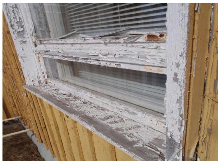
13-14.Julkisivun alapäissä paikoin lahovikaa,maalipinnassa kunnostamista.Ikkunoissa kunnostamista
