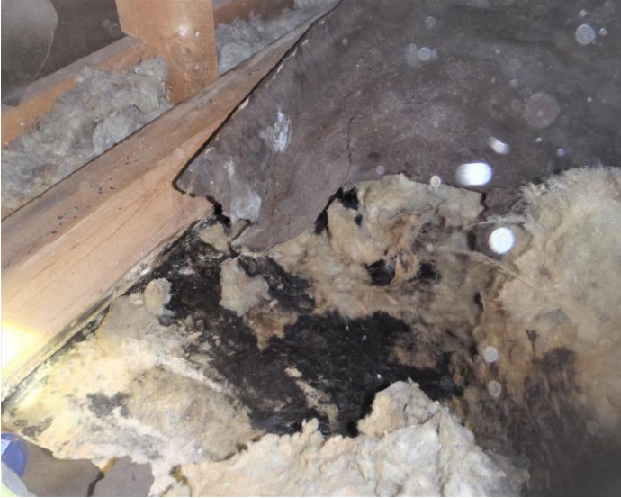
23-24.Laajennusosan(peh-wc ja ljh) yläpohjassa/katoissa märkiä villoja(kattoluukku/katto vuotanut)
