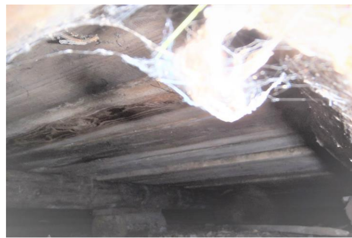
33-34. Pihapään huonetilassa lattia eristeineen päädyssä laho laudoituksen päällä, talon alla alapinnassa kosteusjälki
