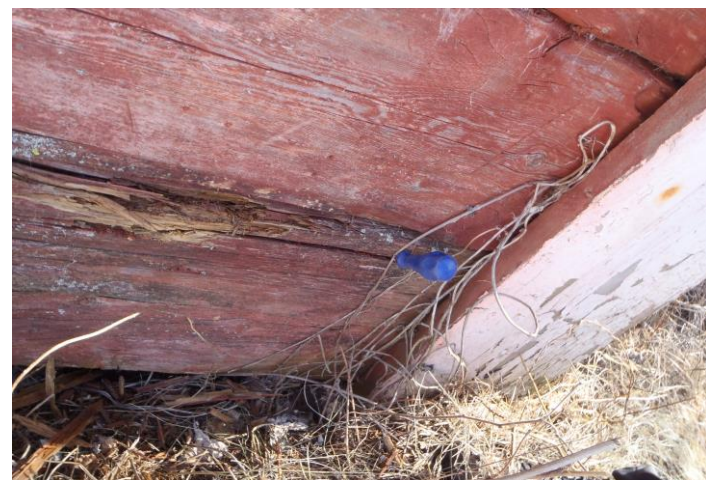
31-32. Talouksrakennuksessa matala kiviperustus, alahorisissa paikoin lahovikaa (sadevesipoistot puuttuu)
