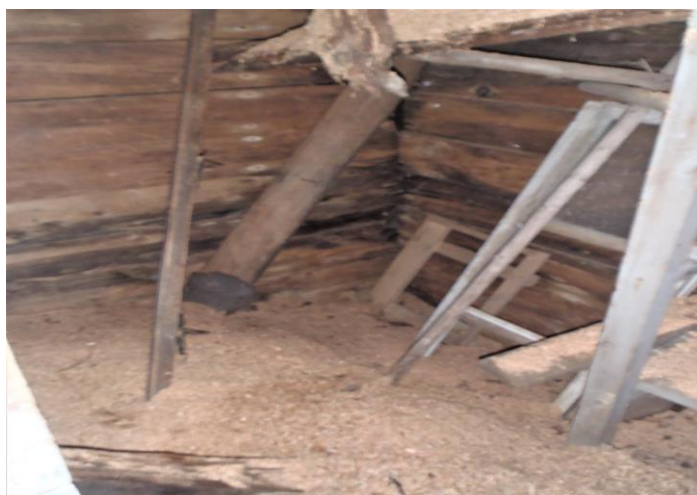
41-42. Talousrakennuksen lisävarastoissa katto vuotaa/vuotanut, välivaraston muhaeristeinen yläpohja romahtanut
