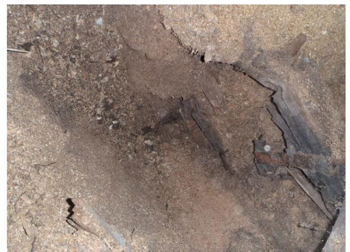
9-10. Ulkoseinäyläosissa/yläpohjassa pihisivulla (ent k/oh-et:n vuotkohdat) vanhoja kosteusvaurioita (kattohuopa uusittu)
