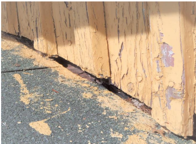
29-30. Kuistin lapeliittymän huopanosto puuttuu, laajennuosan lapeliittymän huopanostossa tiivistämistä (kost. kälkiä alla)
