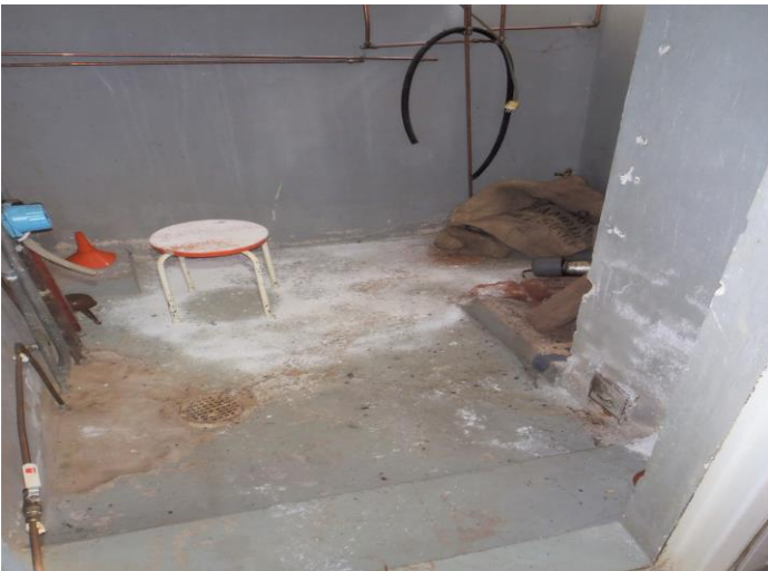
7-8. Lämmönjakohuoneen lattia kostea/kosteusjälkiä. Peh-wc:n lattian betonilaatassa hiushalkeamia
