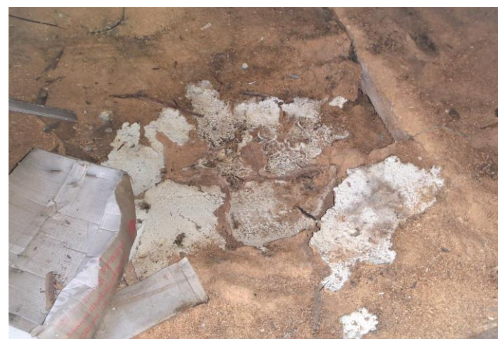
15-16.Yläpohjassa/em ulkoseinäyläosassa kuivuneita(katto korjattu) kosteusvauriokohtia pihasivulla keittiössä ja oh/et seinällä
