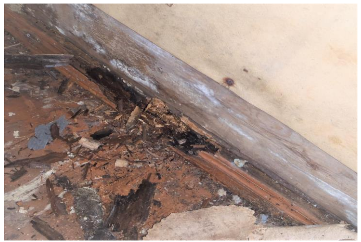
39-40. Talousrakennuksen vesikatto vuotaa/vuotanut kostuttaen pintojen massapaveja, aiheuttaen paikoin laho- ja kosteusvikoja
