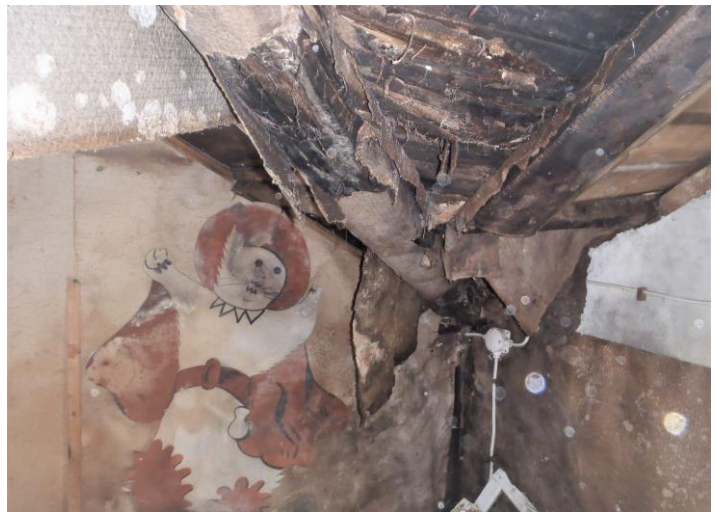
37-38. Vesikatto vuotaa/vuotanut (valo paistaa) pihapään huonetilan parviosalla, puoissa lahovikoja, jiiri romahtamassa
