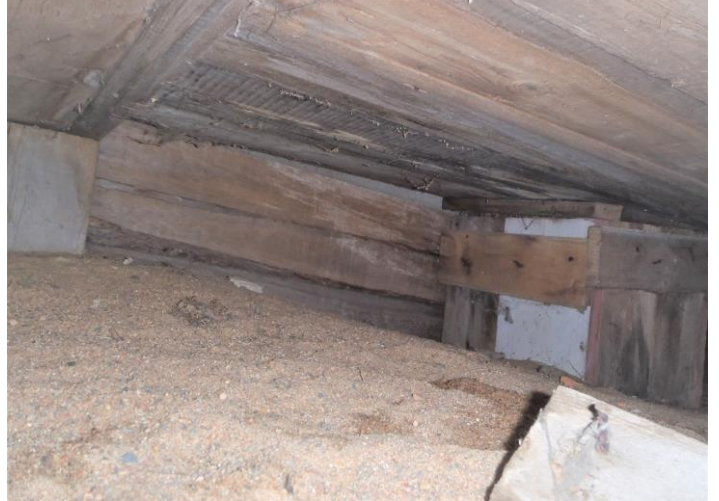
5-6. Pihisivulla keittiöseinällä alapohja pieneltä osin pudonnut, perustuskivi painunut. Piipujuuressa alapohjassa kost.jälkiä/-vikaa
