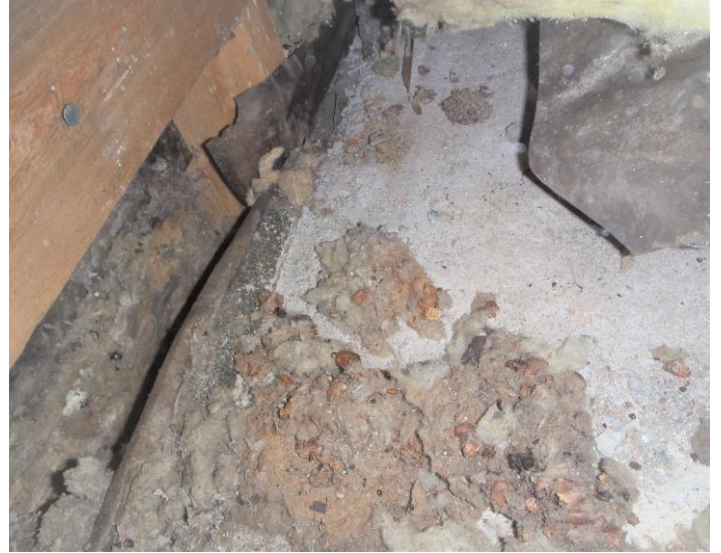
23-24.Laajennusosan(peh-wc ja ljh) yläpohjassa/katoissa märkiä villoja(kattoluukku/katto vuotanut)
