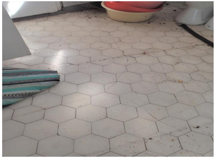
7-8. Lämmönjakohuoneen lattia kostea/kosteusjälkiä. Peh-wc:n lattian betonilaatassa hiushalkeamia
