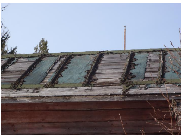
43-44. Talousrakennuksen vesikaton huopakate osin puuttuu, laudoituksessa/räystäässä lahovikoja. Sadevesipoistoja ei ole ollut
