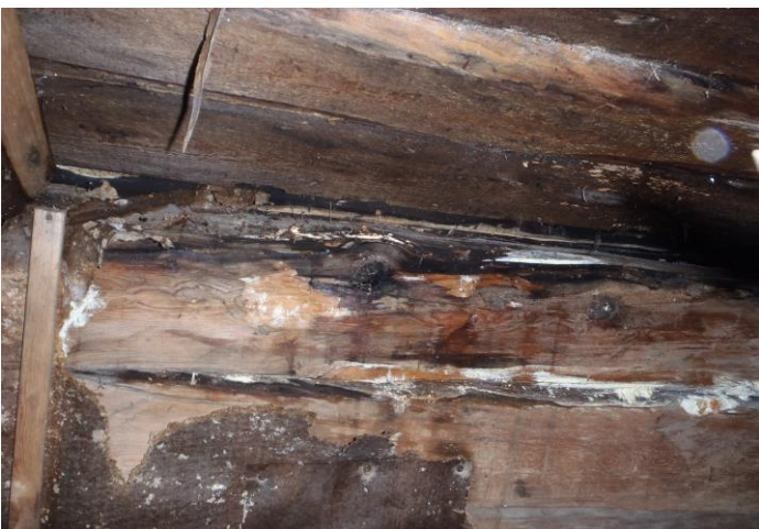
39-40. Talousrakennuksen vesikatto vuotaa/vuotanut kostuttaen pintojen massapaveja, aiheuttaen paikoin laho- ja kosteusvikoja
