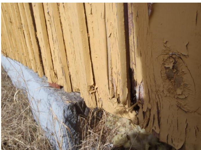
13-14.Julkisivun alapäissä paikoin lahovikaa,maalipinnassa kunnostamista.Ikkunoissa kunnostamista
