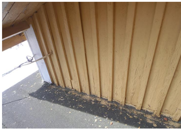
29-30. Kuistin lapeliittymän huopanosto puuttuu, laajennuosan lapeliittymän huopanostossa tiivistämistä (kost. kälkiä alla)
