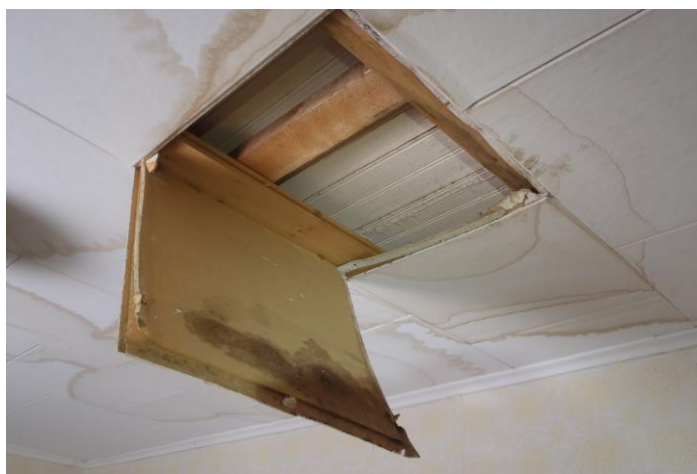
21-22. Vesikattolaudoituksessa ja huonetilojen sisäkatoissa useissa kohdissa vanhoja kosteusjälkiä(kts em yläpohja)
