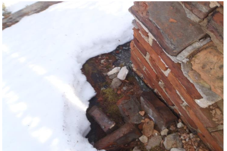
25-26.Vesikaton kattuhuopa heikkokuntoinen takalappeella(pihalappeella korjattu).Yksi piipuista romahtanut
