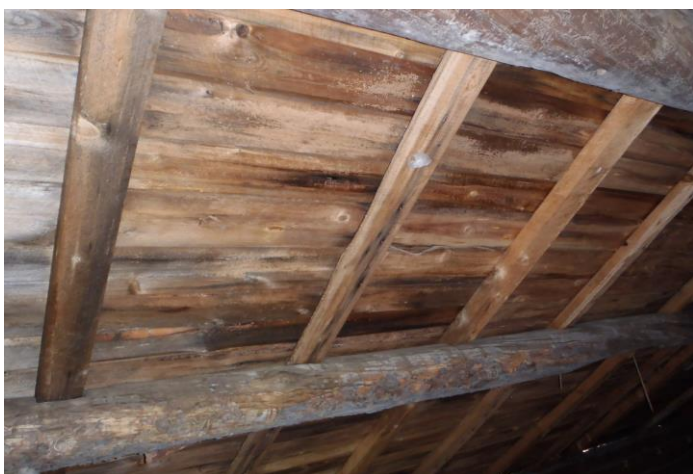
21-22. Vesikattolaudoituksessa ja huonetilojen sisäkatoissa useissa kohdissa vanhoja kosteusjälkiä(kts em yläpohja)
