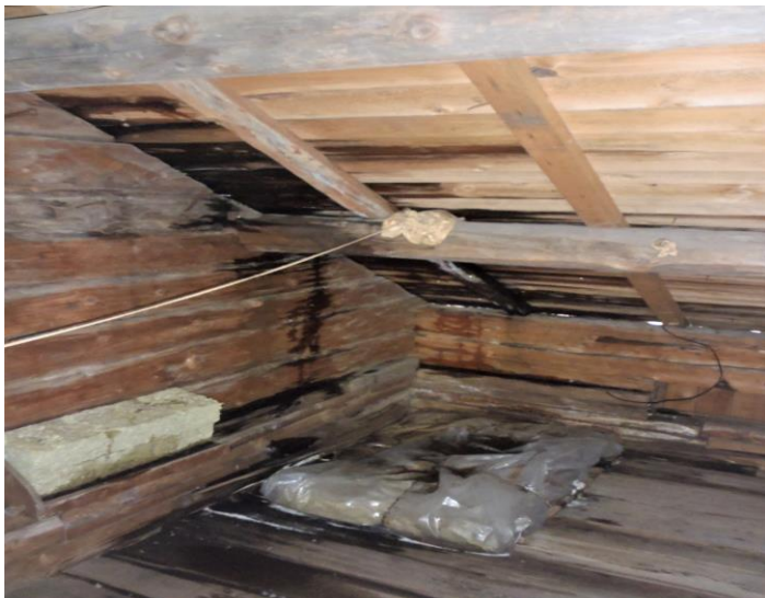
17-18. Takasivulla yläpohjan mh/oh-nurkalla katto vuoti,ko kohdalla laho- ja mikrobivaurioita puu- ja eristeosissa(kts ulkoseinät)
