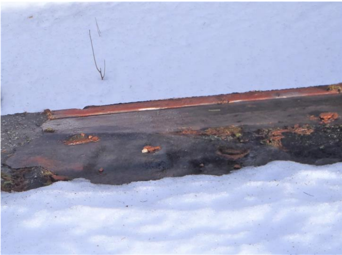
25-26.Vesikaton kattuhuopa heikkokuntoinen takalappeella(pihalappeella korjattu).Yksi piipuista romahtanut
