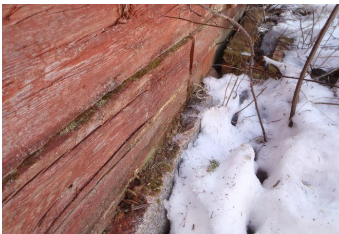
31-32. Talouksrakennuksessa matala kiviperustus, alahorisissa paikoin lahovikaa (sadevesipoistot puuttuu)
