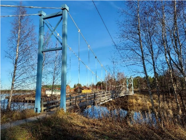
Kuva 8. Kaava-alueelta Sotisaareen johtava kevyenliikenteen silta.
