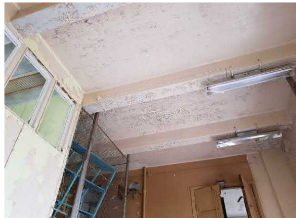
Kattoa kannattavat muodoltaan pelkistetyt betonipalkit.
