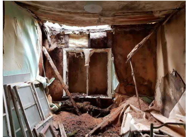
Majoitushuoneet. Seinät ja katot on pinnoitettu kuitulevyillä ja pinkopahveilla ja maalattu, lattioissa on levypinnoitteet. Kattoissa levytysten alla näkyy vanhoja kattopaneeleita. Huoneissa on paikoin pahoja kosteuden aiheuttamia vaurioita.
