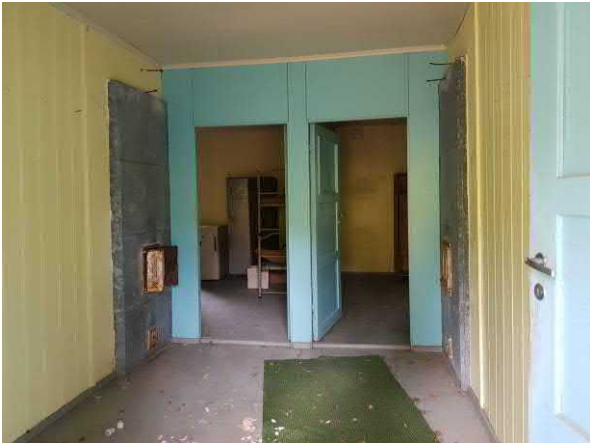
Eteisen molemmin puolin on asuinhuoneita lämmittävät uunit. Uuneja on ollut mahdollista lämmittää eteisen puolelta huoneissa nukkuvia häiritsemättä.
