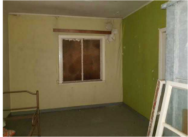
Majoitushuoneet. Seinät ja katot on pinnoitettu kuitulevyillä ja pinkopahveilla ja maalattu, lattioissa on levypinnoitteet. Kattoissa levytysten alla näkyy vanhoja kattopaneeleita. Huoneissa on paikoin pahoja kosteuden aiheuttamia vaurioita.
