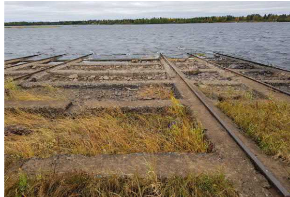
Päätelakan rautakisko- ja betonirakenteita.
