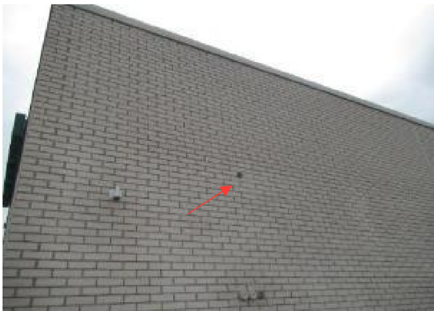
Kuva 17. US5. Ulkoseinän rakenneavaus altaiden puoleisessa päädyssä.
