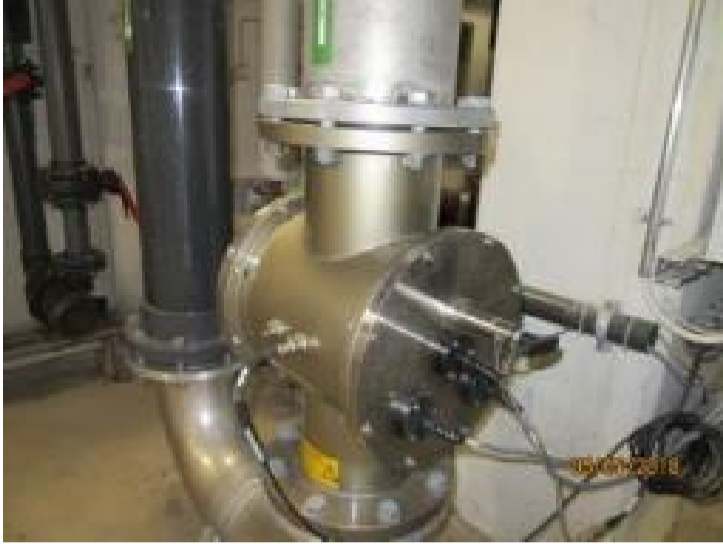
Kuva 260. Lämpimän kierron UV-laite
