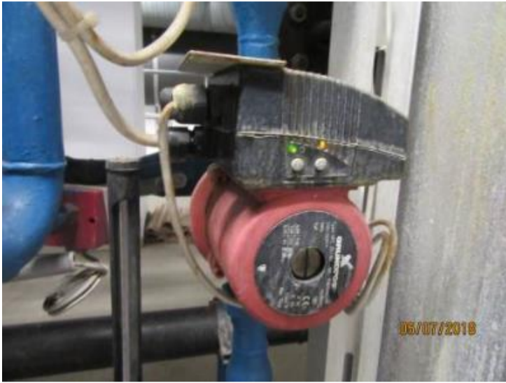
Kuva 181. Lämmitysverkoston kiertovesipumppu
