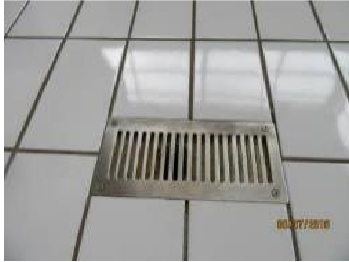
Kuva 263. Allasveden pohjaventtiili
