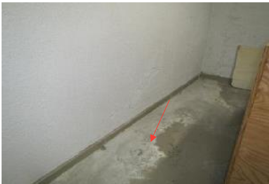
Kuva 35. US13. Rakenneavauskohta ulkoseinän alaosaan kellarissa.
