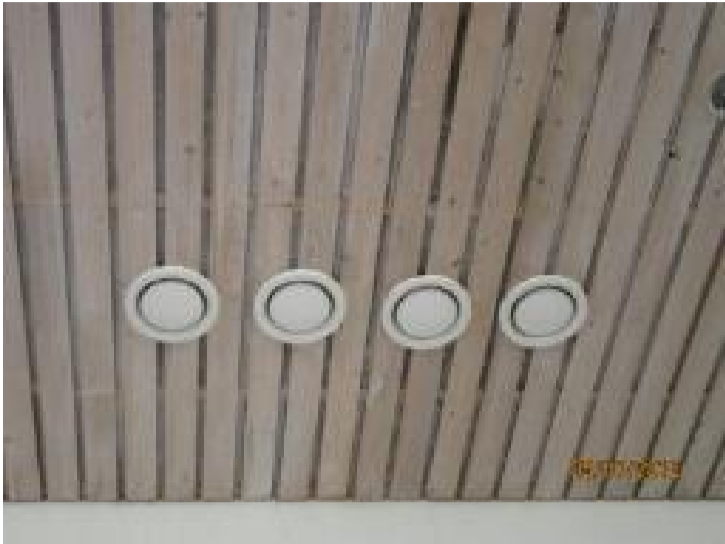
Kuva 231. Poistoilmaventtiili
