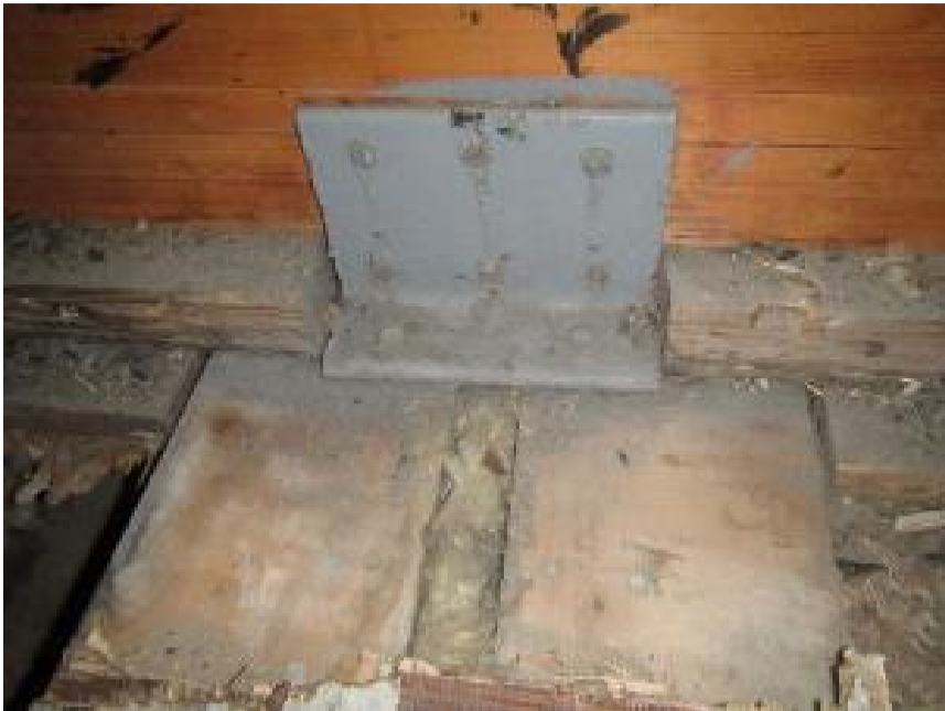
Kuva 67. Yläpohjarakenteen kiinnitys kantavan liimapuupalkin alareunaan .
