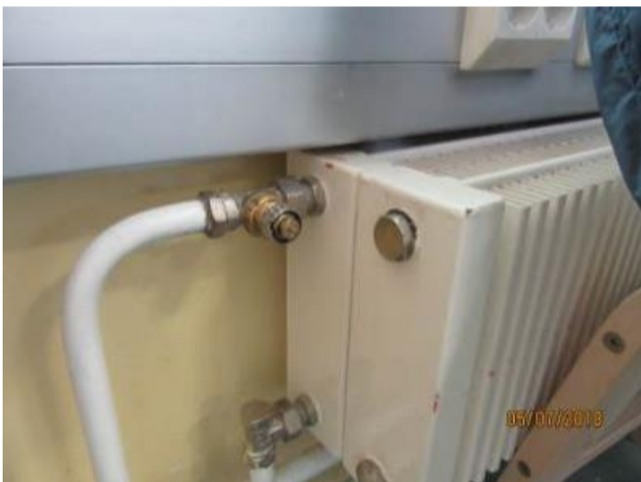
Kuva 187. Patteriventtiili
