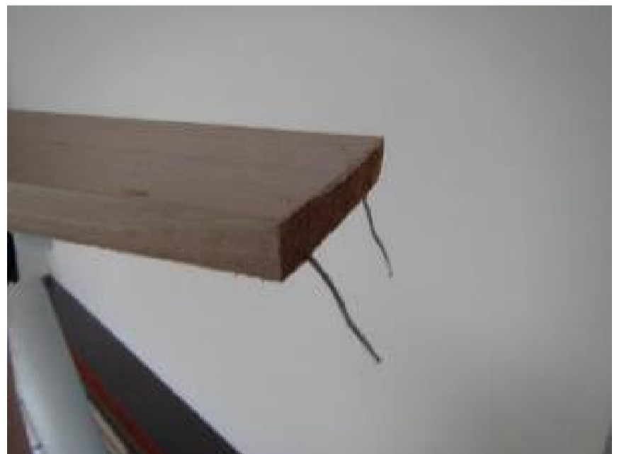
Kuva 88. Harvalaudointi on kiinnitetty koolaukseen teräksisillä viimeistelynauloilla.
