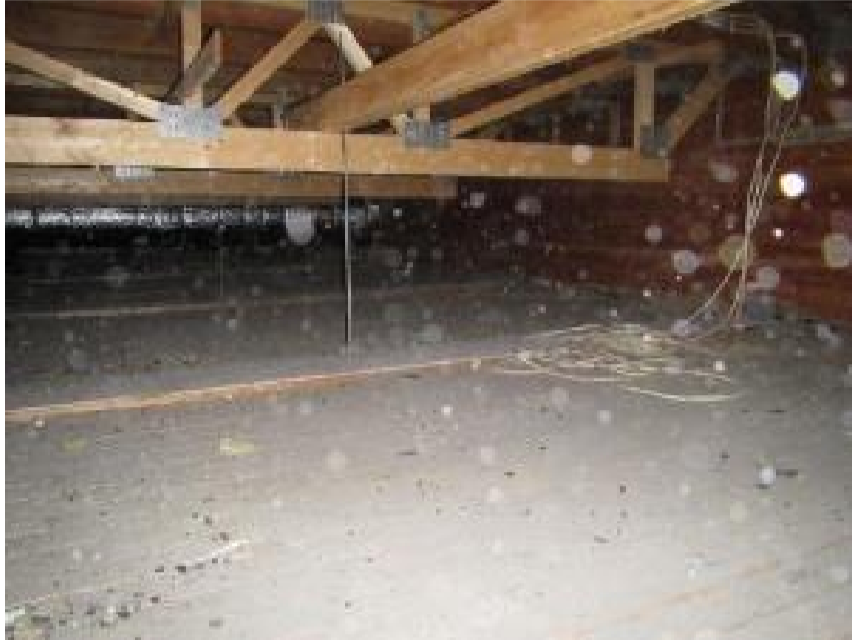
Kuva 49. Yleiskuvaa yläpohjatilasta. Kohdalla yläpohjarakenteen lisäkannatus.
