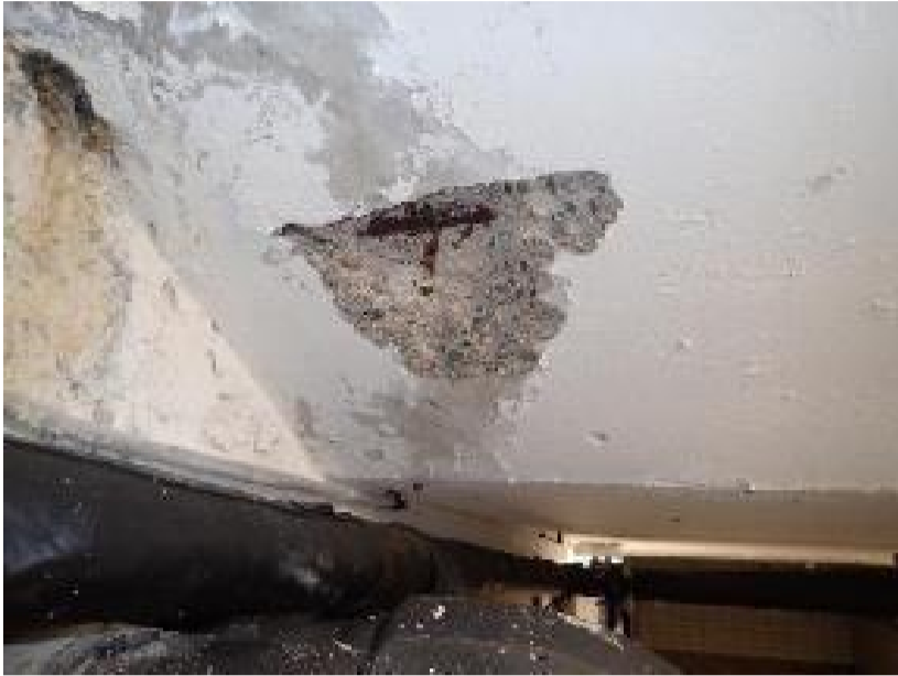
Kuva 116. Opetusaltaan alapuolella on korroosioaurioituneita teräksiä
