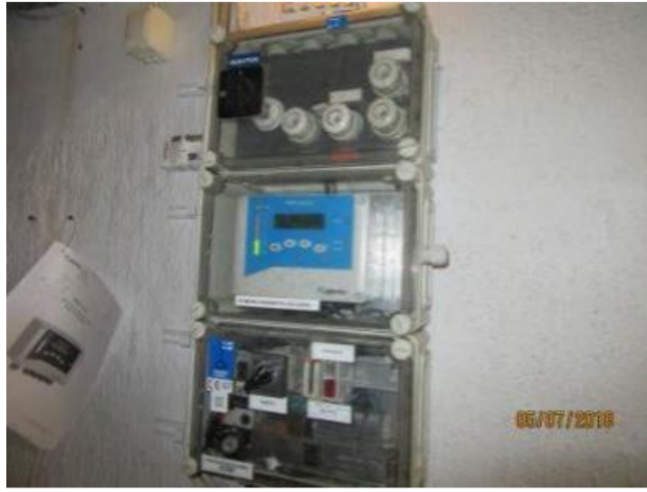
Kuva 208. Jätevesipumppaamon ohjauskeskus
