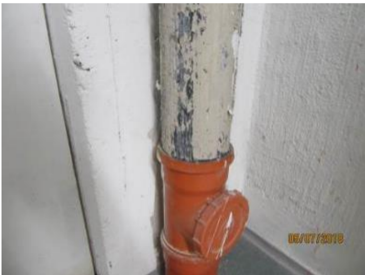
Kuva 203. Alkuperäinen valurautaviemäri liitetty muoviviemäriin
