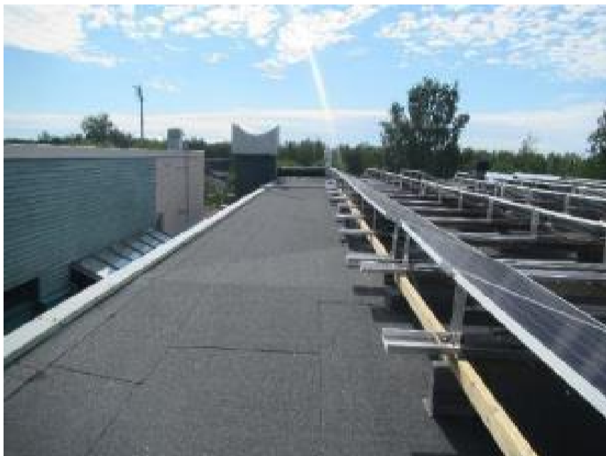
Kuva 79. Kaadot kaivoille ovat riittävät. Vettä ei lammikoidu kattopinnalle.
