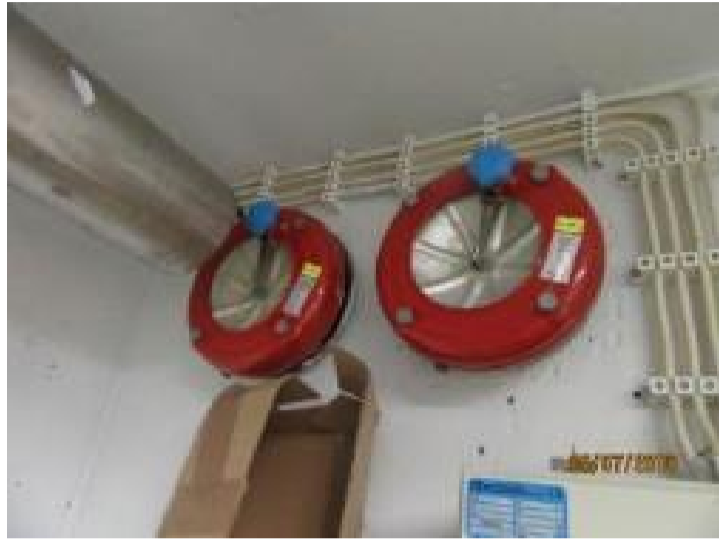
Kuva 238. Ylipaineventtiili
