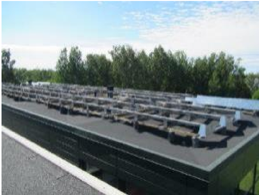
Kuva 77. Yleiskuva vesikatolta. Katolla aurinkopaneelit.
