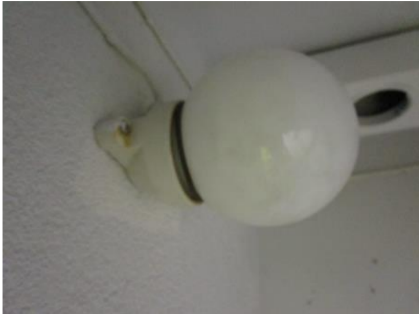
Kuva 158. Hehkulamppuvalaisimia, VSS (alkuperäisiä).
