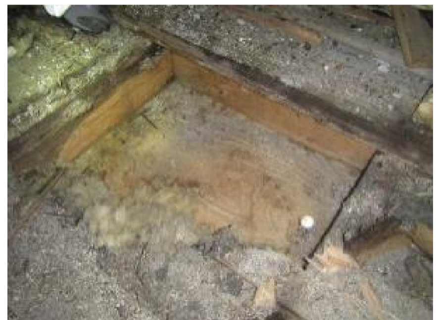
Kuva 60. YP2. Rakenne on ollut märkä kokonaisuudessaan. Tutkimushetkellä kuiva.
