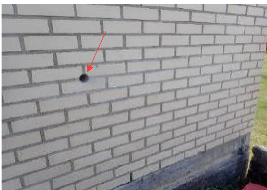
Kuva 31. US11 Rakenneavaus altaan puoleisen päätyseinän alaosaan.
