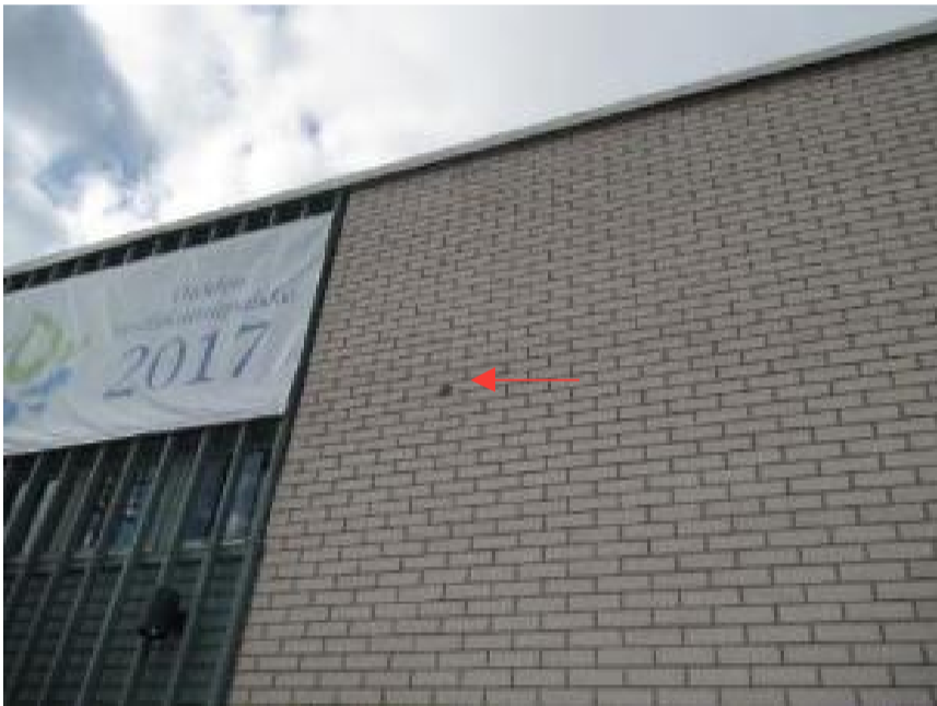
Kuva 11. US2. Ulkoseinän rakenneavaus etusivulla.
