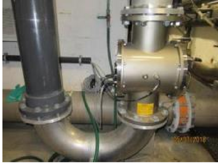
Kuva 261. Kylmän kierron UV-laite
