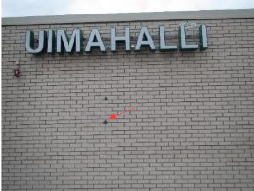
Kuva 15. US4. Ulkoseinän rakenneavaus etusivulla.
