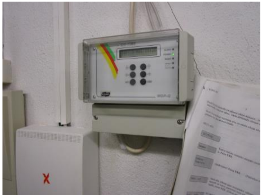
Kuva 169. Näkymää pääkellosta (teletilassa).
