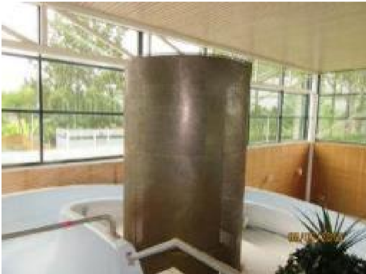
Kuva 233. Uudemman allastilan poistoilmalaite
