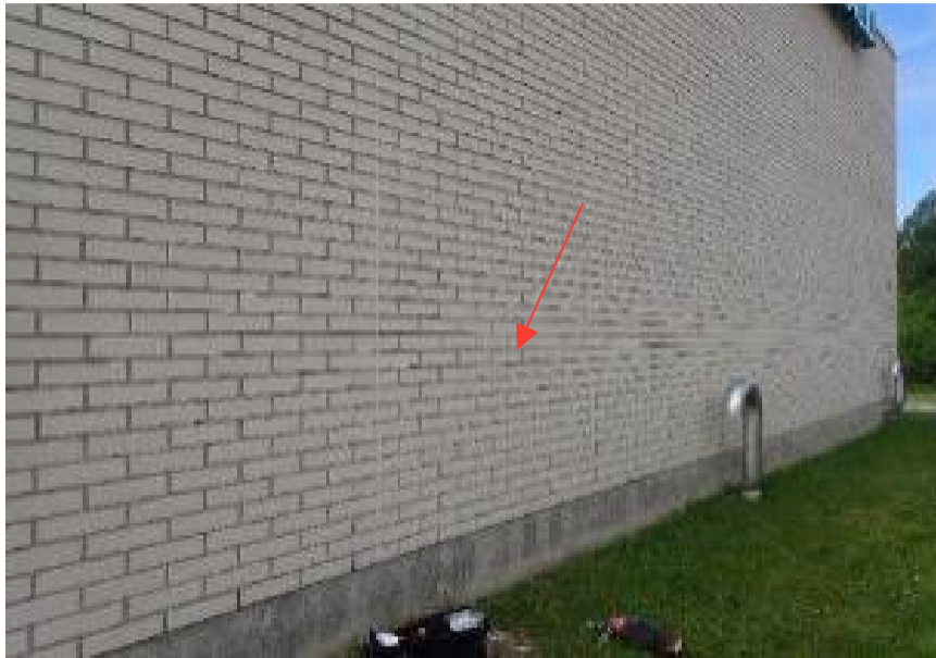
Kuva 27. US9. Rakenneavaus ulkoseinän alaosaan rakennuksen etusivulla.
