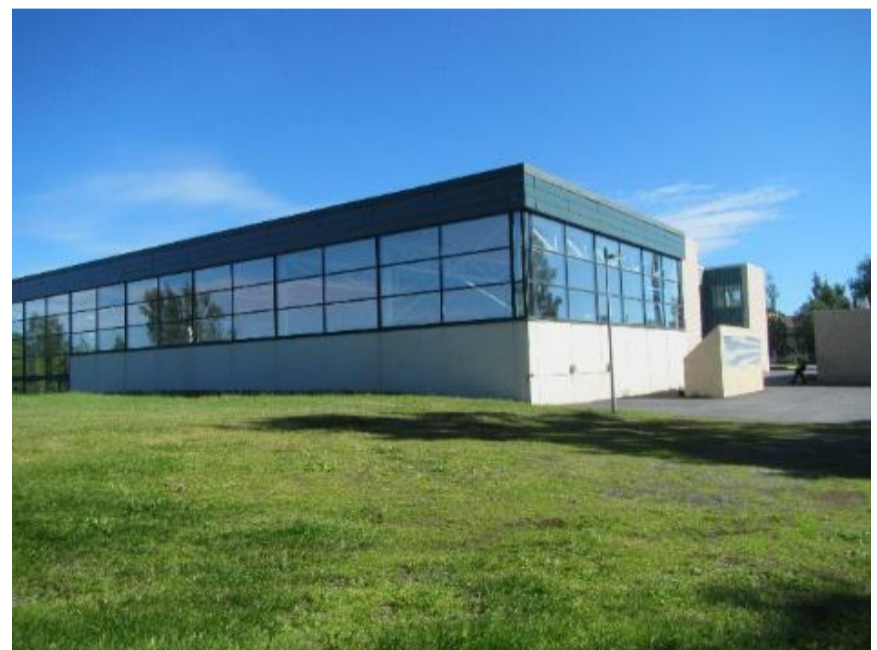
Kuva 4. Kuva laajennuksen takakulmalta. Nurmialue viettää loivasti rakennuksesta poispäin.
