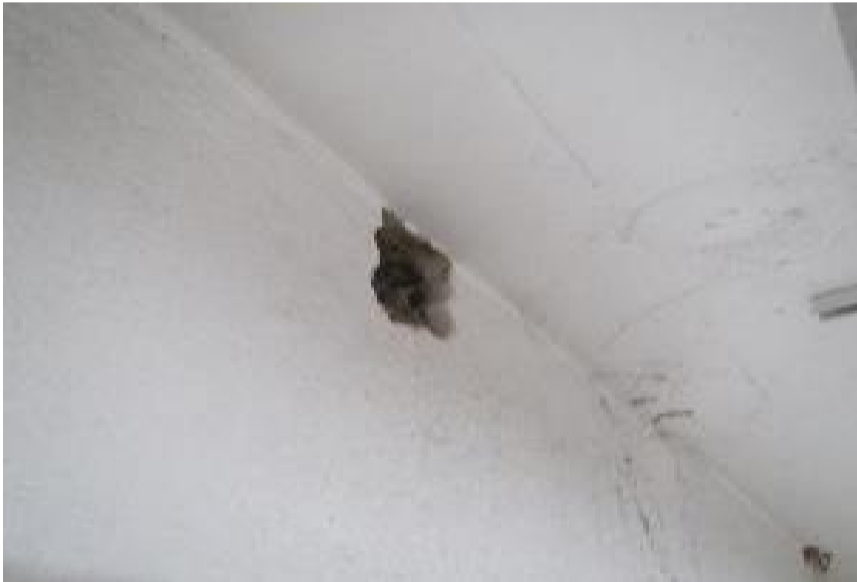
Kuva 41. US16. Rakenneavauskohta kellarin ulkoseinän yläosaan välipohjan liittymässä.
