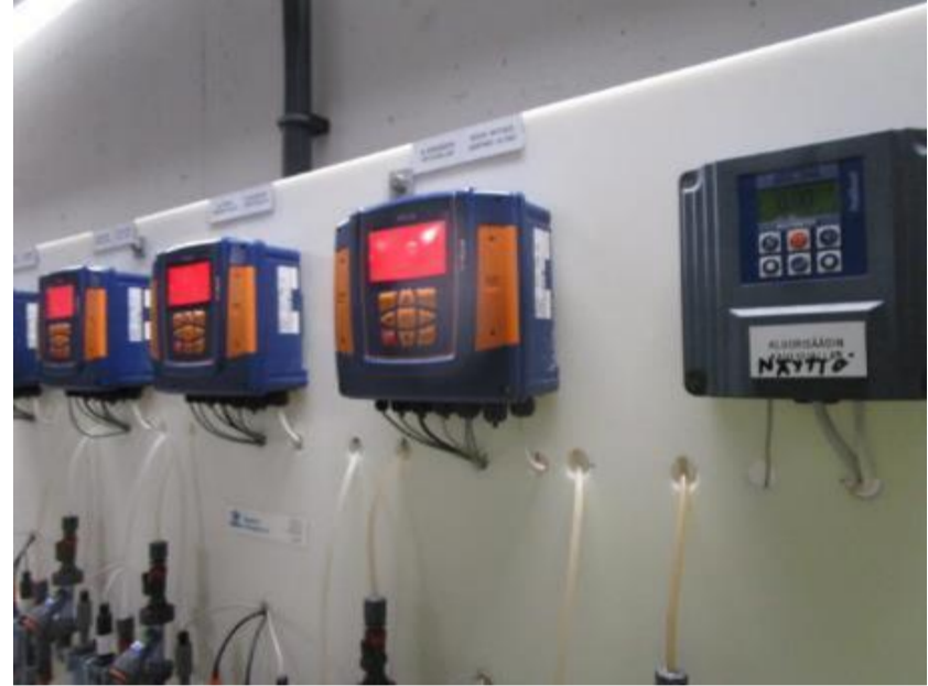
Kuva 177. Allasjärjestelmän ohjainlaitteita.
