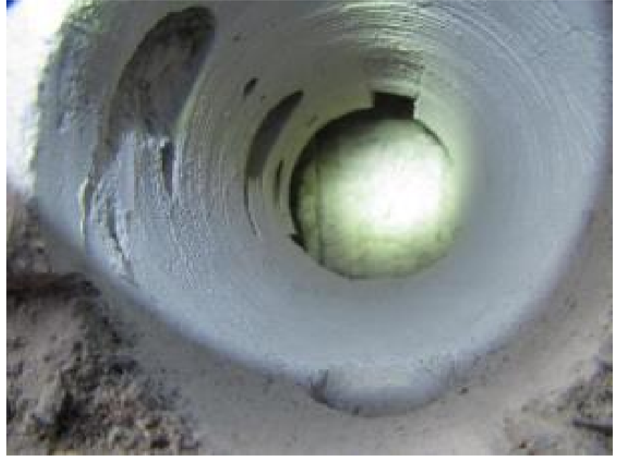
Kuva 10. US1. Kohdalla tiiliverhouksen takana on n. 30 mm tuuletusväli. Näyte M5 kohdalta, ei viitettä vaurioista.
