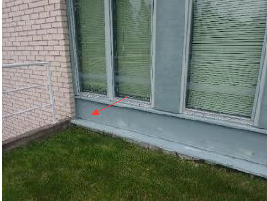
Kuva 21. US7. Rakenneavaus ikkunoiden alapuolelle.
