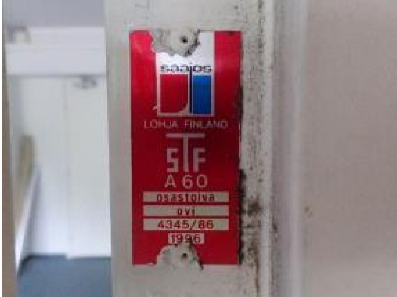
Kuva 93. Palo-ovet on uusittu -97, eristeinä on mineraalivillaa.
