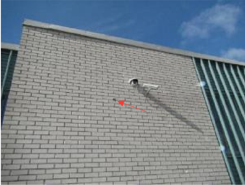
Kuva 9. US1 Ulkoseinän rakenneavaus etusivulla.
