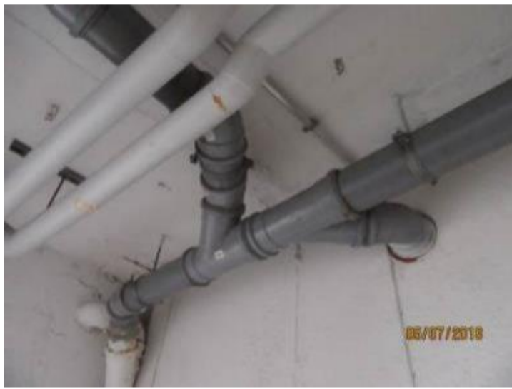
Kuva 204. Muoviviemärit liitetty alkuperäiseen valurautaviemäriin
