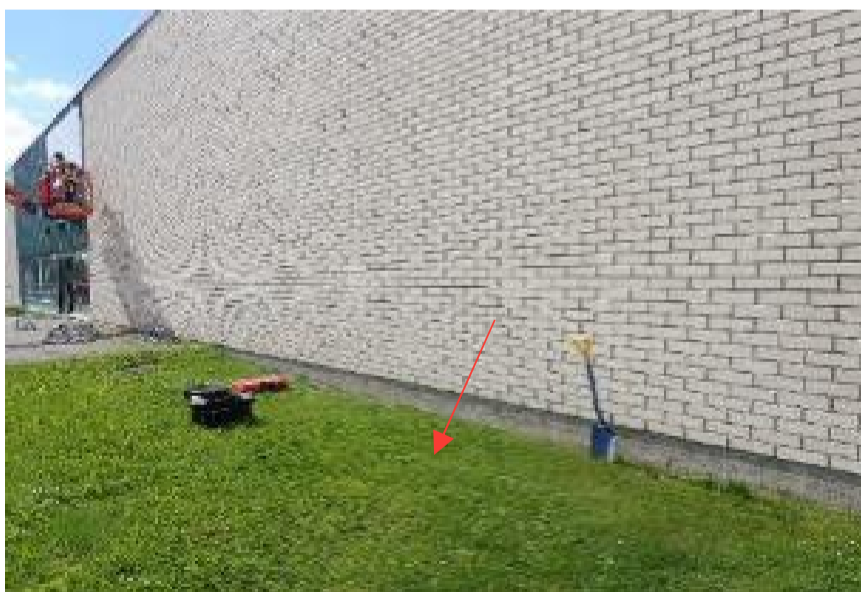
Kuva 25. Koekaivaus rakennuksen vierustalle.
