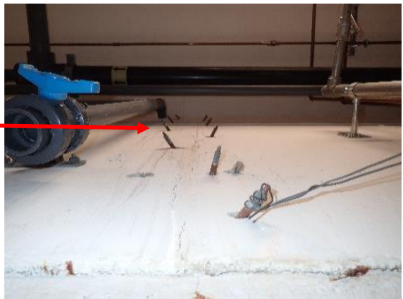
Kuva 141. Toiminta-altaan syvän osan seinämän halkeama on injektoitu
