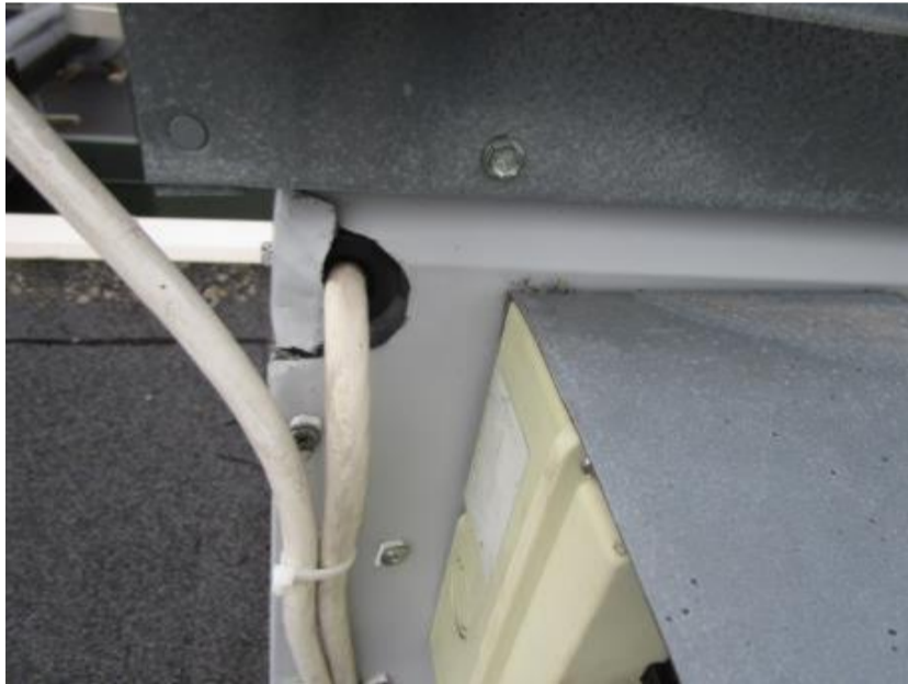
Kuva 152. Katolla läpivienti tiivistysten parantaminen. Kuva 153. Kellarissa on hyllyn päällä tavaraa
