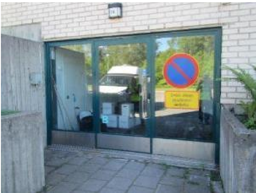
Kuva 47. Yleiskuva ensimmäisen kerroksen ulko-ovesta. Ovissa ei havaittu merkittäviä puutteita.
