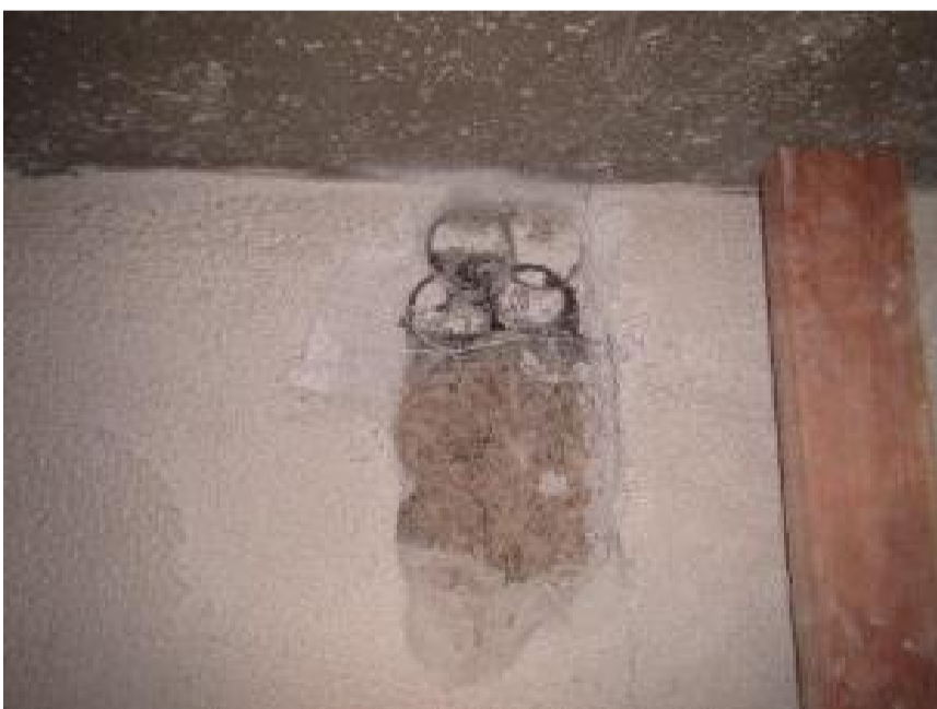
Kuva 43. US17. Rakenneavauskohta ensimmäisen kerroksen ulkoseinän yläosaan välipohjan liittymässä.
