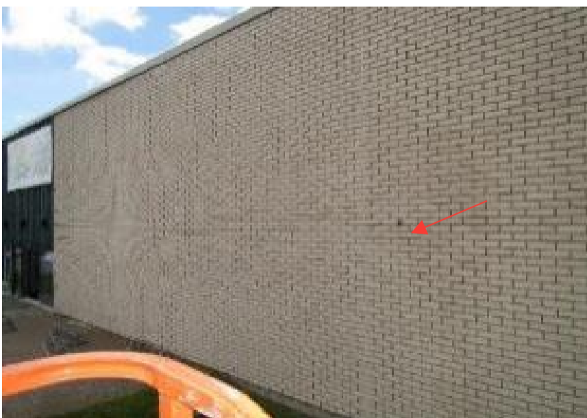
Kuva 13. US3. Ulkoseinän rakenneavaus etusivulla.
