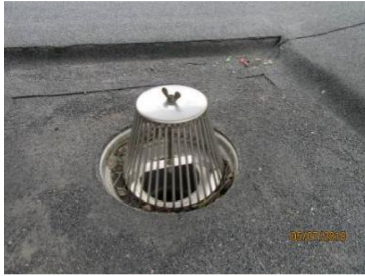
Kuva 210. Kattokaivo
