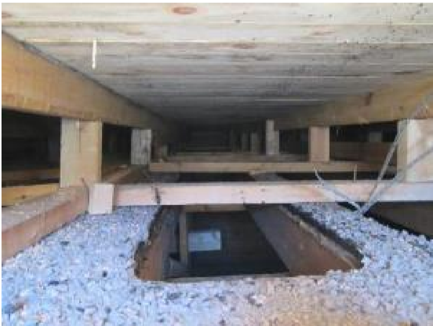
Kuva 51. Vanhaa vesikattoa on avattu tuuletuksen tehostamiseksi. Nykyinen vesikatto on tehty vanhan päälle. Vanhan kermin päällä singelikerros.
