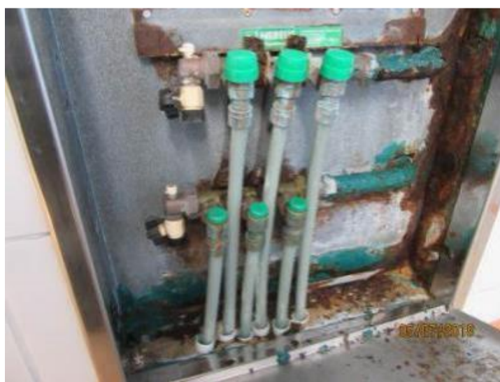
Kuva 190. Lattialämmityksen jakotukkikaappi
