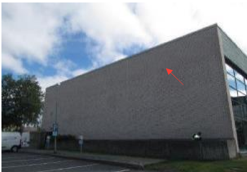
Kuva 19. US6. Ulkoseinän rakenneavaus altaiden puoleisessa päädyssä.
