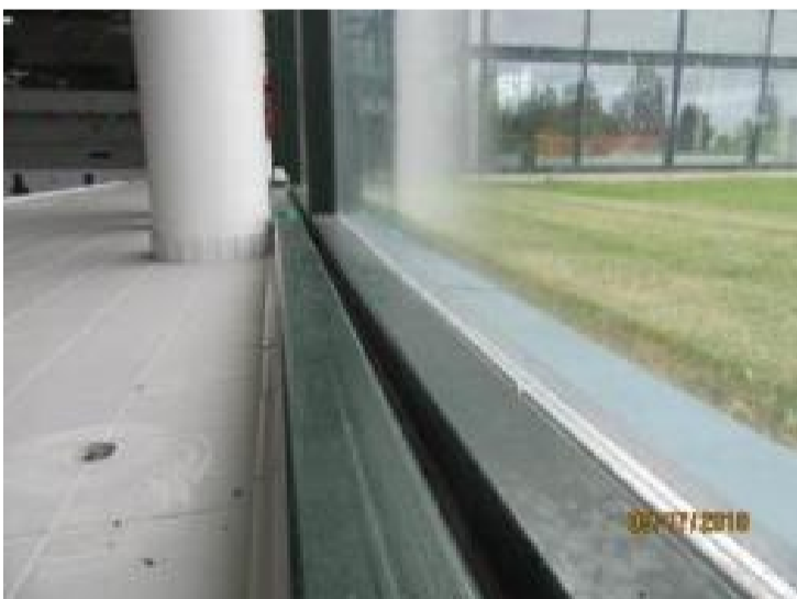
Kuva 235. Allastilan tuloilman rakoventtiili
