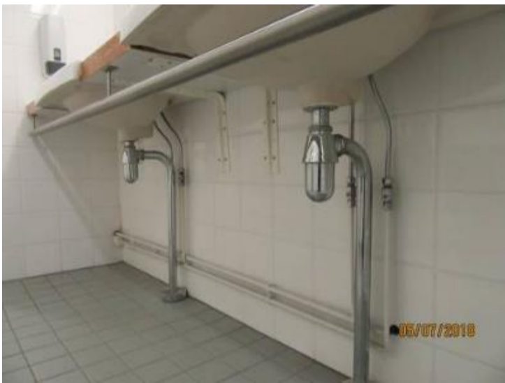
Kuva 195. Vesijohdot kupariputkia
