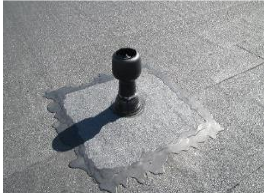
Kuva 70. Yläpohjatilan alipainetuulettimet.
