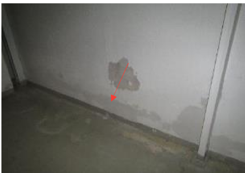
Kuva 37. US14. Rakenneavauskohta ulkoseinän alaosaan kellarissa.
