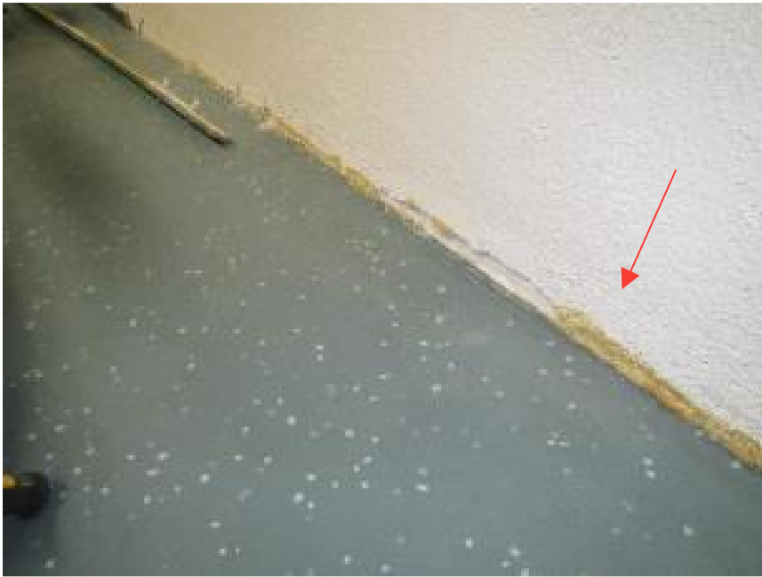
Kuva 39. US15. Rakenneavauskohta ulkoseinän alaosaan taukotilassa.
