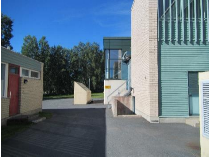
Kuva 5. Kuvaa pukuhuoneiden puoleisesta päädyestä. Asfaltin pinta on loivasti kaadolla rakennuksesta poispäin.
