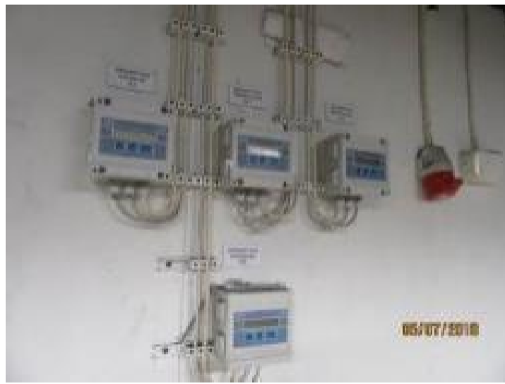
Kuva 259. Altaiden virtausmittaukset
