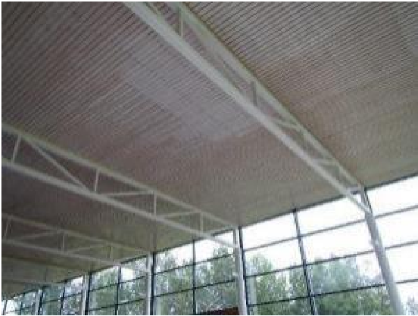
Kuva 83. Yleiskuvaa yläpohjan kantavista teräsrakenteista/yläpohjarakenteesta.
