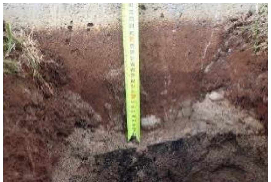
Kuva 26. Sokkelin vedeneristys bitumointi alkaa n. 20 cm maapinnan alapuolelta.
