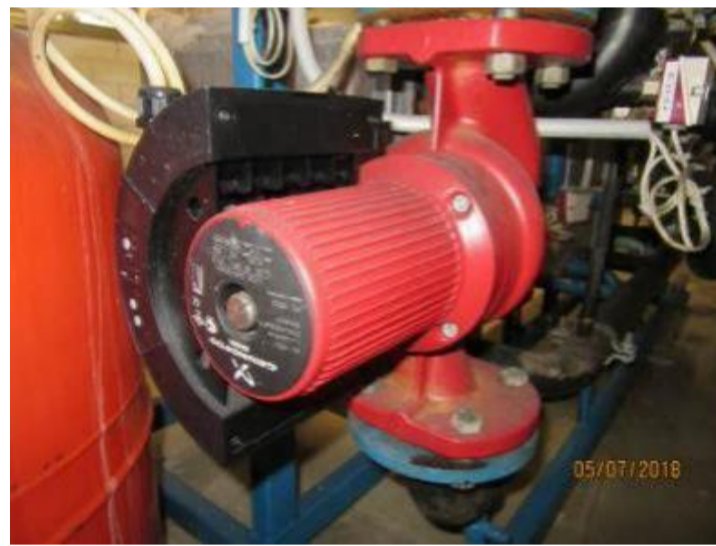
Kuva 180. Uusittu kiertovesipumppu
