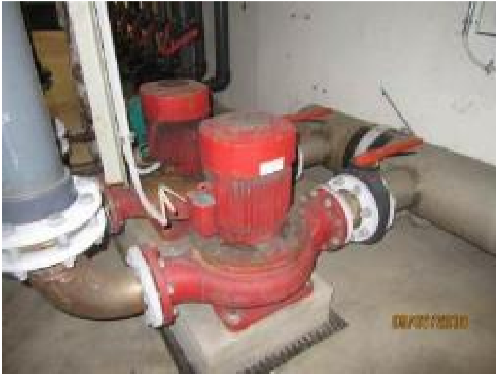
Kuva 254. Allasvesien kierrätyspumput
