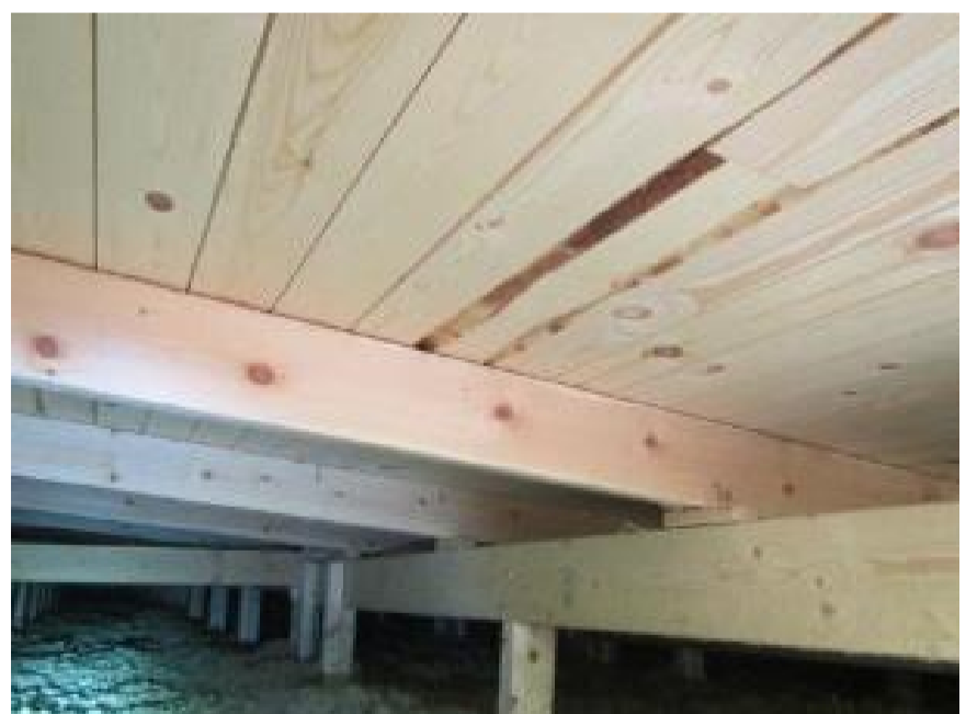
Kuva 82. Aluslaudoituksissa ei havaittu viitteitä puuttellisesta tuuleuksesta.
