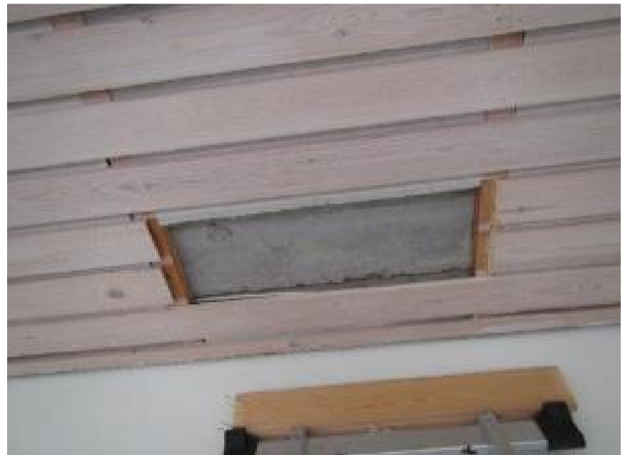
Kuva 86. Harvalaudoituksen rakenneavaus.
