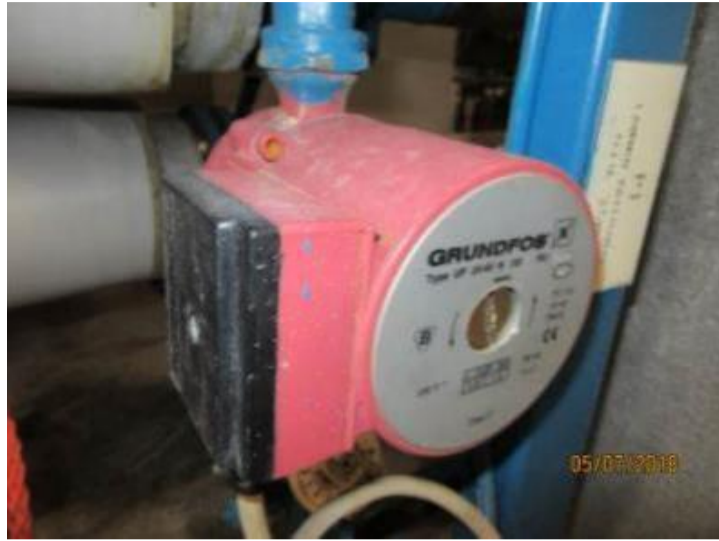
Kuva 182. Lämpimän käyttöveden kiertopumppu
