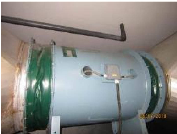
Kuva 219. Ilmanvaihtokoneen 3TK/PK2 uusittu poistoilmahuuhallin
