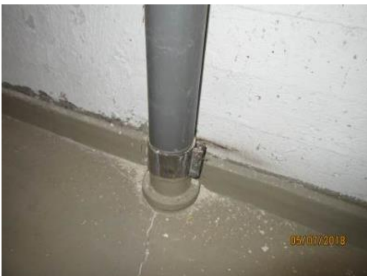
Kuva 205. Muoviviemäri liitetty alkuperäiseen valurautaviemäriin
