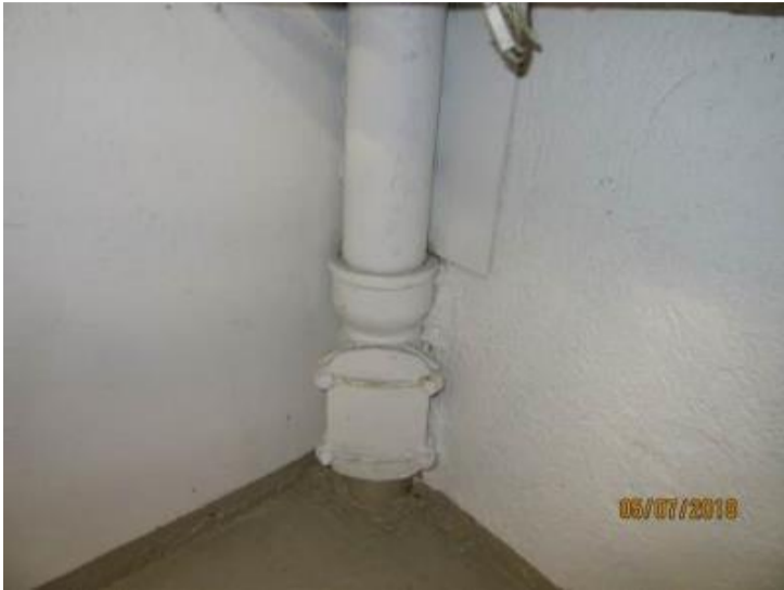
Kuva 201. Alkuperäinen valurautaviemäri
