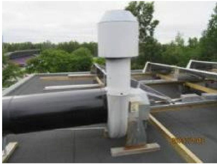
Kuva 224. Kemikaalitilojen poistoilmakone
