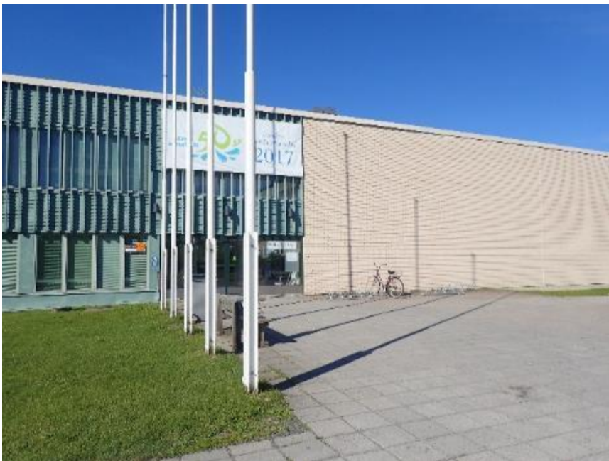
Kuva 7. Etusivulla pääsisäänkäynnin vierässä sokkelipintaa on näkyvillä n. 5 cm, ikkunoiden alla 0 -5 cm
