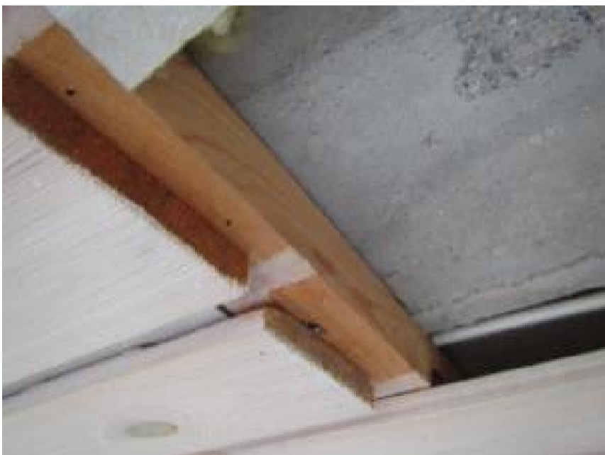
Kuva 87. Alapintaan asennettu koolaus kiinnitetty ontelolaattaan keltapassivoiduilla 8 mm holkkinauloilla.
