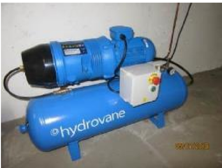
Kuva 243. Paineilmakompressori
