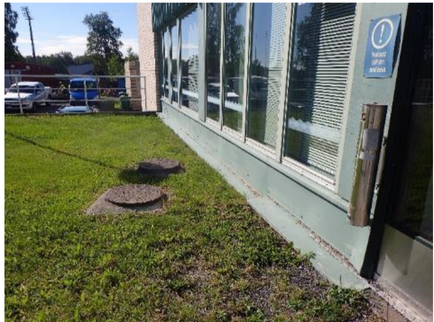
Kuva 8. Kuva pääsisäänkäynnin vierestä. Sokkelipintaa ei juuri ole.
