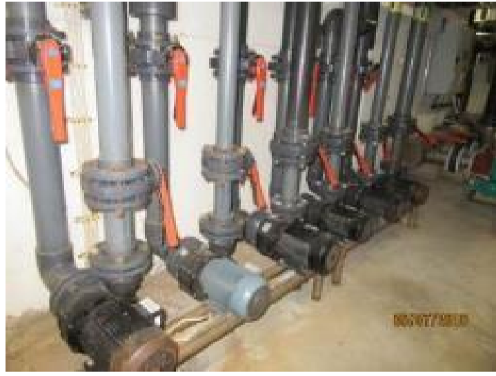
Kuva 253. Virkistyslaitteiden pumppuja
