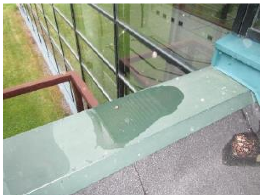
Kuva 76. Reunapelti tasalla, vesi voi valua ruuvin kohdalta tai peltien liitoksesta pellin alle.
