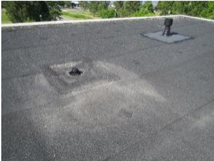
Kuva 71. Vettä lammikoituu muutamien katto-kaivojen viereen. Lammikot lisäävät vuotoriskiä ja lyhentävät katteen käyttöikä.
