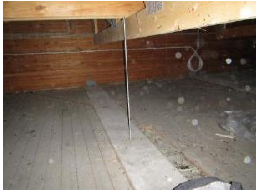
Kuva 68. Yläpohjarakenteen lisäkannatus myöhemmin asennuilla ristikoilla ja kierretangoilla.
