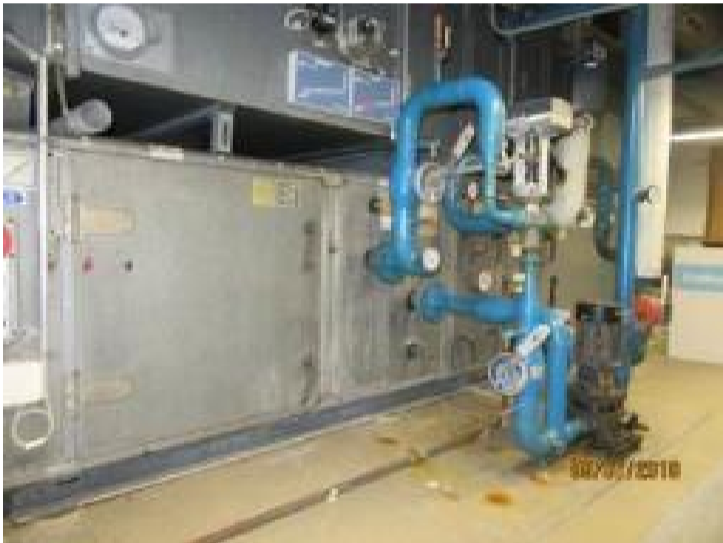
Kuva 217. Ilmanvaihtokone 3TK/PK4
