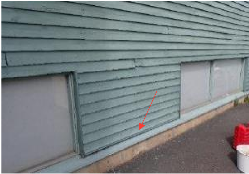
Kuva 33. US12. Rakenneavauskohta pukuhuoneen puoleiseen pätyyn.
