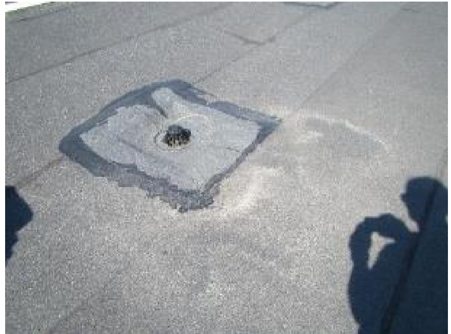
Kuva 72. Joitakin kattokaivoja on uusittu/uudelleen asennettu.
