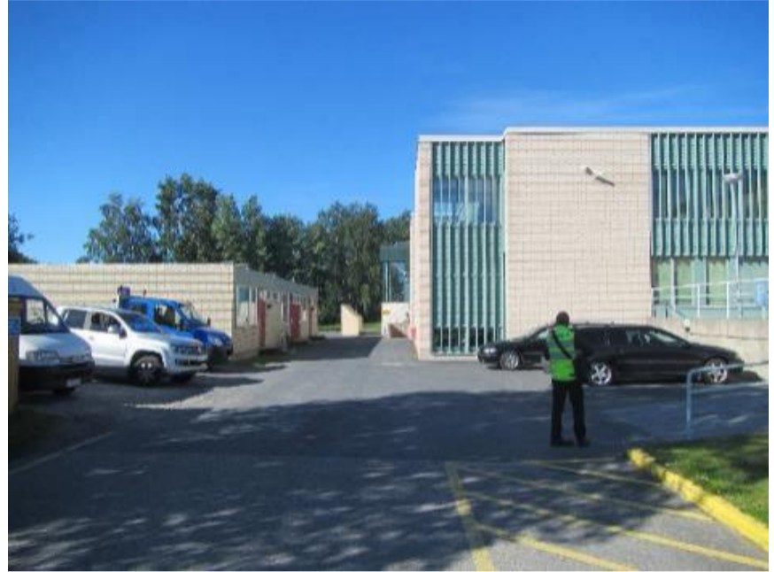
Kuva 6. Kuva etukulmalta. Asfaltti pinta viettää loivasti rakennuksesta poispäin.
