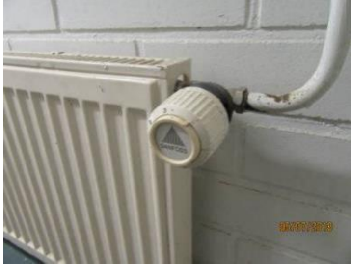
Kuva 186. Patteriventtiili
