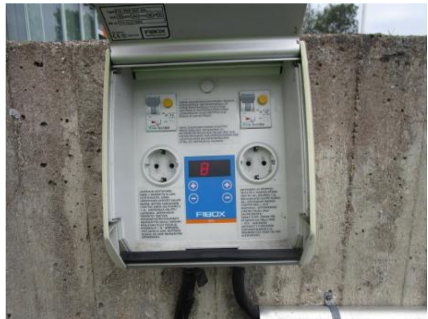
Kuva 147. Uusittuja autolämmityskoteloita
