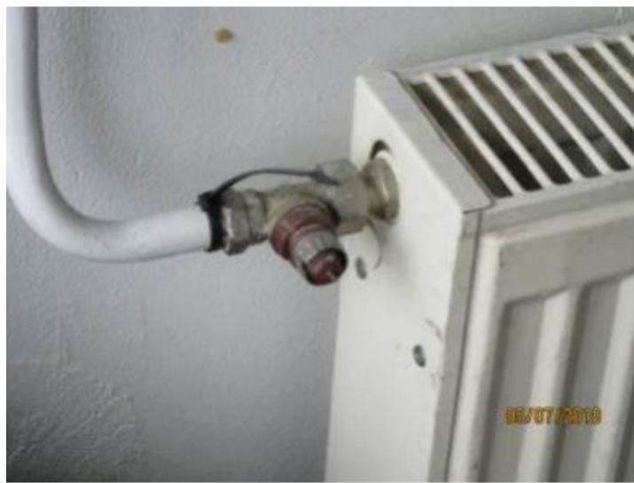
Kuva 188. Patteriventtiili
