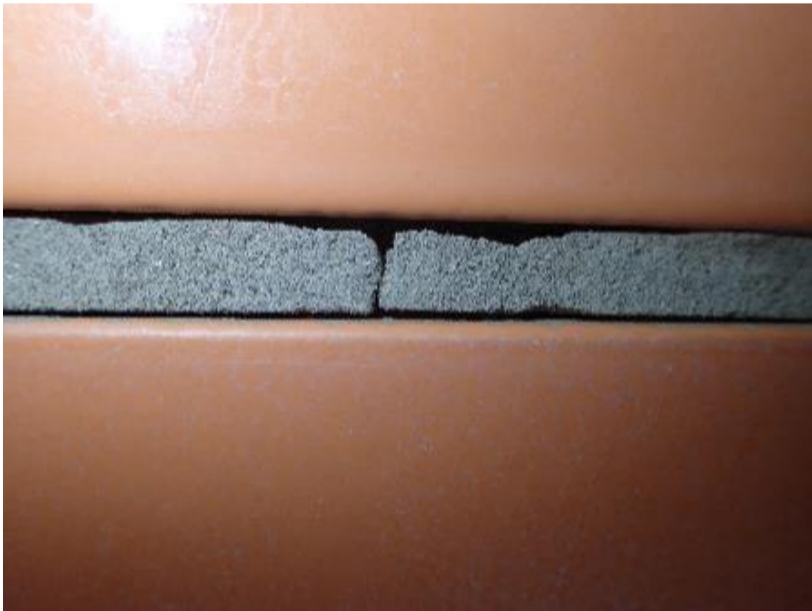
Kuva 128. Laastisaumoissa paikallista kulumista ja halkeilua
