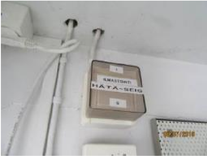
Kuva 213. Ilmanvaihtojärjestelmän hätätyskytkin.
