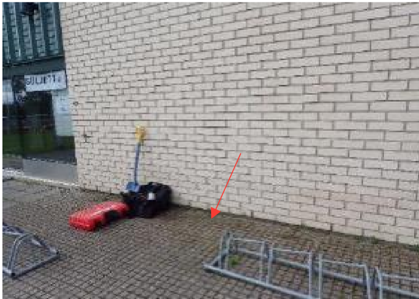
Kuva 23. US8 Rakenneavaus kohdalle, jossa sokkelipintaa n. 5 cm.
