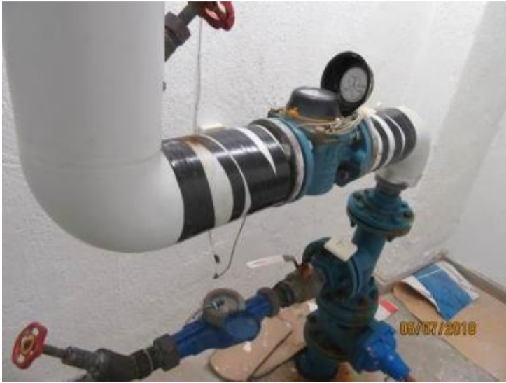
Kuva 193. Vesimittarit
