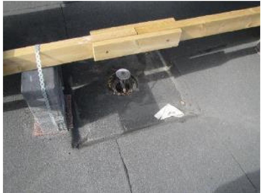
Kuva 78. Kattokaivoilla asianmukaiset roskasiivilät. Aurinkopaneelitelien ja vesikatteen välissä on asianmukaiset suojamatot.
