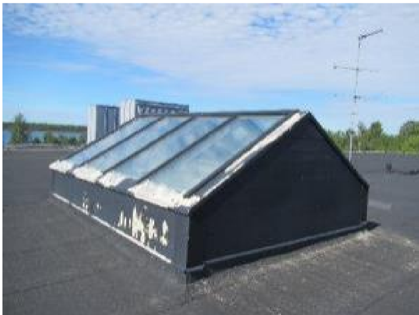
Kuva 73. Kattoikkunaryhmän pellityksissä ei havaittu merkittäviä puutteita. Maali on hilseillyt auringon vastaisella sivulla.
