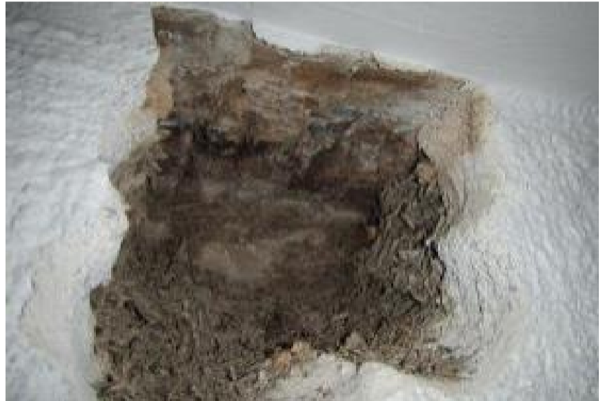
Kuva 42. US16. Kohdalla ei viitteitä vaurioista. Välipohjan betoni jatkuu yhtenäisenä sokkeliin, liitos on ilmatiivis.
