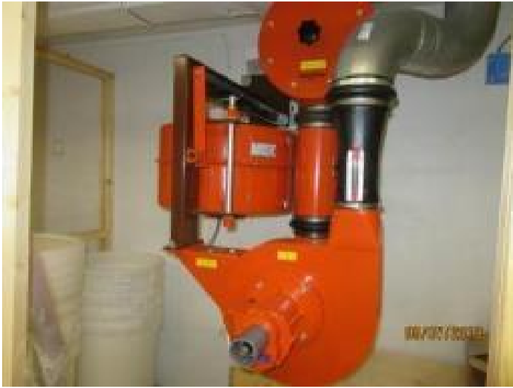
Kuva 237. Suojapuhallin
