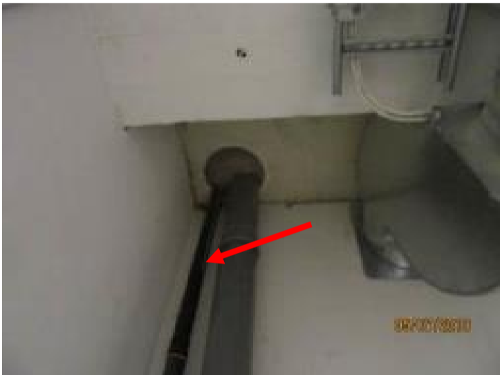
Kuva 246. Pölynpoistoputki
