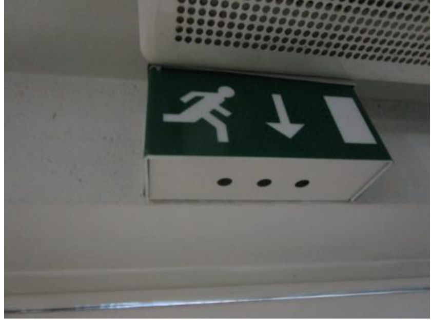
Kuva 165. Poistumistievalaisimia, pimeänä.
