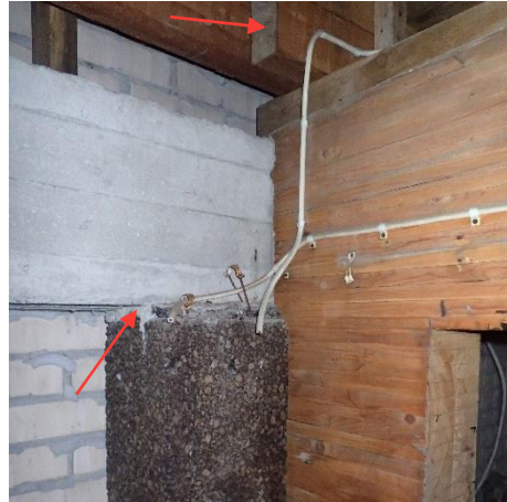
Kuva 2. Pilarit on tuettu useasta kerrostasosta betonipalkeilla. Liimapuu nurjahdustukena toimii sekundäripalkit ja yläpohjarakenne.
