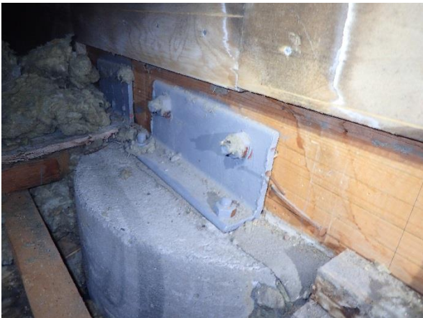
Kuva 3. Primäärikannattajan on tuettu nivelellisesti mastopilarin päistä.
