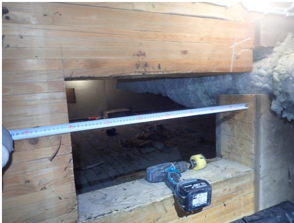
Kuva 9. Palkkien ulokeosaan on tehty erikokoisia reikiä IV-läpiviennille sekä yläpohjan huoltoaukoiksi.
