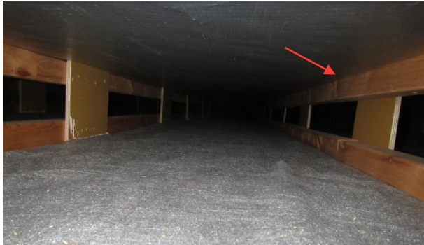
Kuva 7. 2006 tehty uusi höyrinsulkurakenne on kiinnitetty vanhaan alakattoon. Rakenne toimii lisäkuormana.
