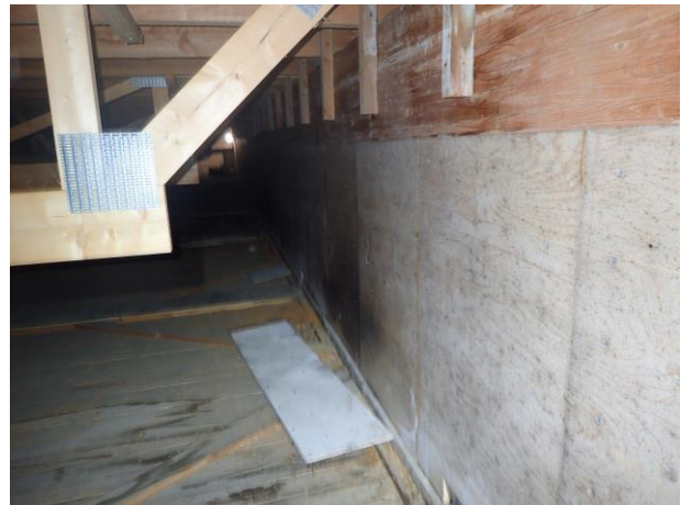
Kuva 10. Palkki 3 on vahvistettu naulaamalla ja liimaamalla 30mm levyt palkin kylkiin n.110cm korkeudelle alareunasta.
