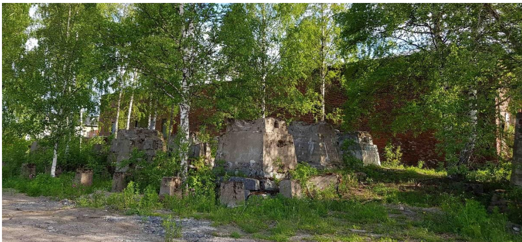
Raamisahojen betoniperustuksia voimalaitoksen eteläpuolella.
