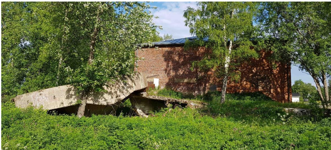
Voimalaitoksen piipun perustukset ja sahan rakenteita voimalaitosrakennuksen etelän puoleisessa päädysssä.
