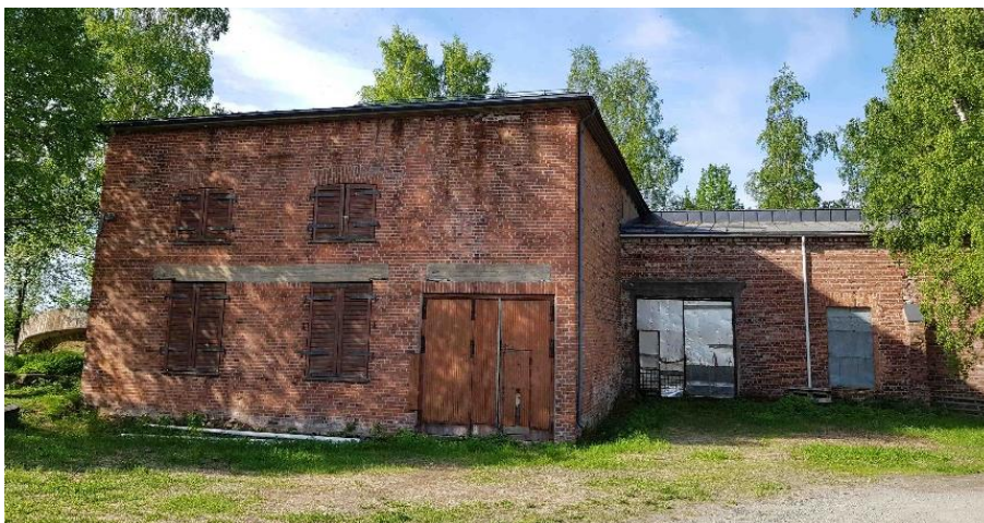
Ikkuna-aukkojen päällä on muuraamalla tehtyjä holvirakenteita.
