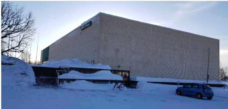
Luoteeseen Meripuistokadulle suuntautuva julkisivu on ilmeeltään umpinainen. Se muodostaa voimakkaan kontrastin meren puolelle avautuvalle lasijulkisivulle.
