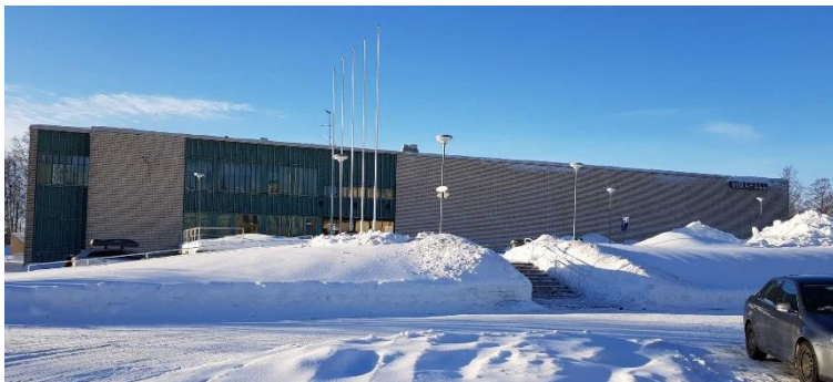
Uimahallin sisäänkäyntijulkisivu suuntautuu koilliseen. Sisäänkäyntiä korostavat eteistilan lasiovet ja suuret ikkunat, joiden kautta avautuu jo näkyviä aulatilaa ja allassaliin. Julkisivussa allassalin puoli on ilmeeltään suljettu, umpinainen tiilijulkisivu.
