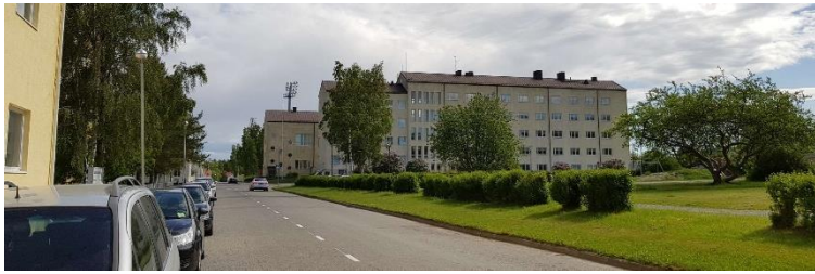
Korkea luokkahuonesiipi rajaa Meripuiston puolelta avautuvaa näkymää.
