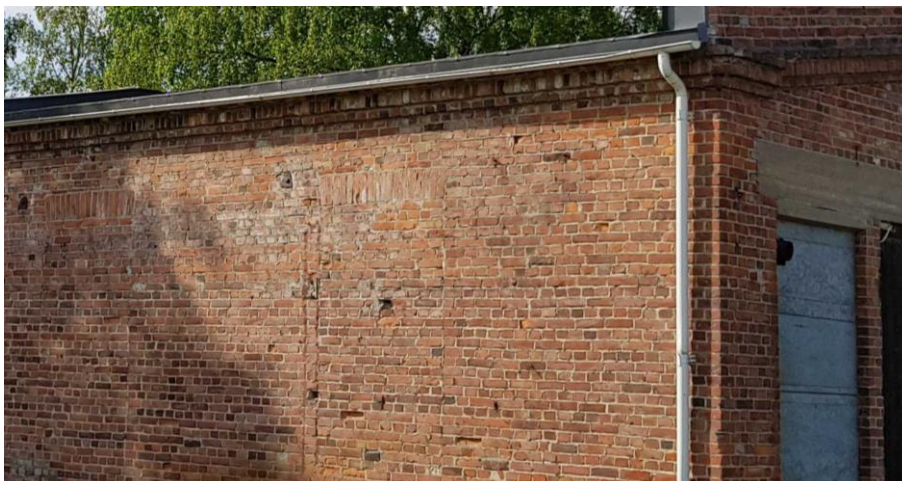
Eläväpintaista muurattua punatiiliseinä. Räystään alla näkyvät muuraamalla tehdyt ulkonevat koristelilat.
