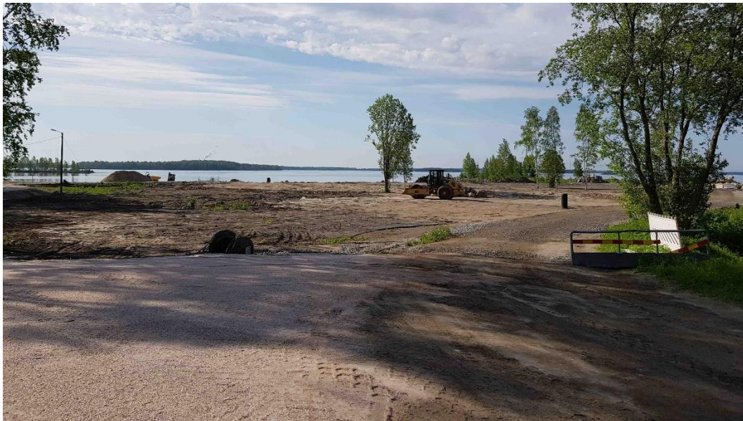
Mansikkanokan ranta-alueella on meneillään alueen kunnostustyö. Rannan tuntumassa on tehty maansiirtotöitä.
