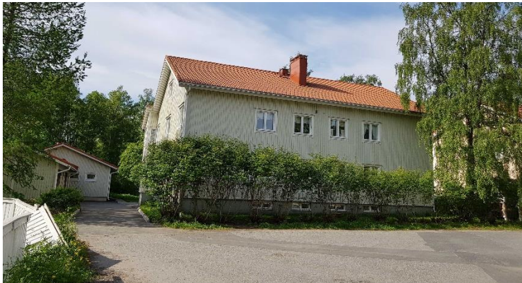
Urheilukatu 15. Pihaa rajaa asuinrakennuksen ohella matalampi talousrakennus.
