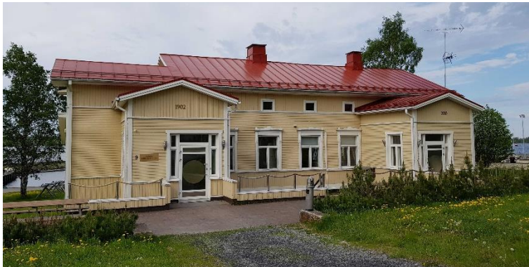
Rantabulevardin puolella rakennuksen ulkoasua on muutettu. Nykyiset kaksi kuistia ovat todennäköisesti peräisin peruskorjauksen ajalta.
