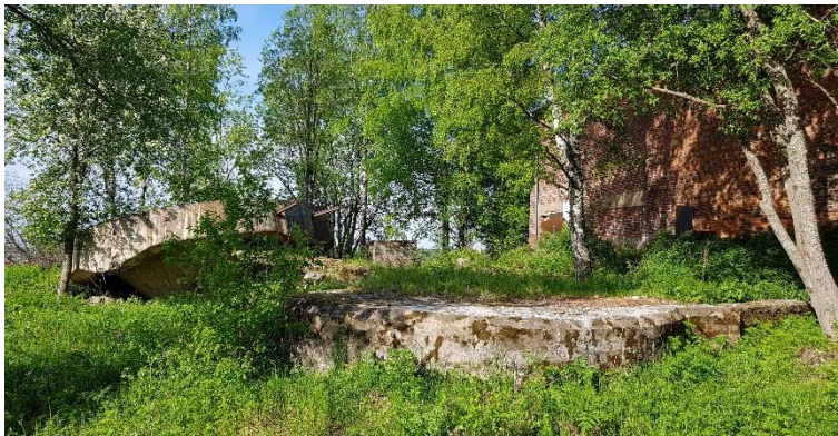
Sahan rakenteita ja piipun perustukset.
