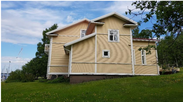
Etelän puoleiseen päätyyn on rakennettu laajennusosa. Betoniperustasta ja laajennuksen ulkoasusta päätellen se on myöhempi lisäys.
