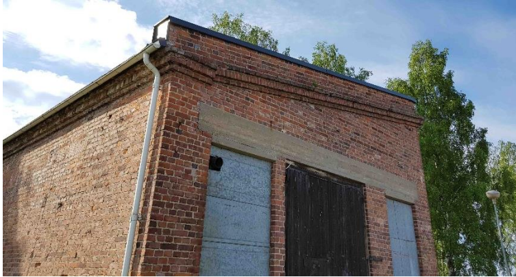
Pohjoisen puoleisessa päädyssä räystäällä on tiilistä muuratut ulkonevat koristelistat. Oviaukkojen yläpuolella muuraukseen upotettu betonipalkki erottuu julkisivussa vanhalle teollisuusrakennukselle luonteenomaisena yksityiskohtana.
