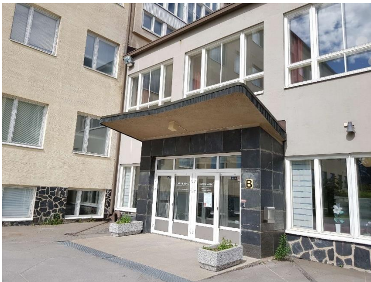
Pääsisäänkäyntiä korostaa linjakas katos. Rakennuksen julkisivuissa on säilynyt paljon alkuperäisiä, jälleenrakennuskauden arkkitehtuurille tyypillisiä hienopiirteisiä yksityiskohtia, kuten pääsisäänkäynnin siro, keskeltä taitteinen katos ja sokkeleiden lohkokiviverhoukset.
