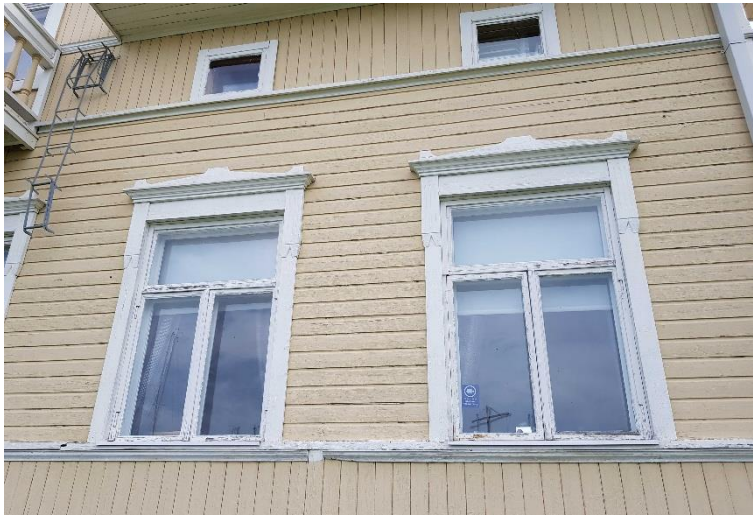
Rakennuksessa on T-karmi-ikkunat, joita kehystävät pelkistetyn koristeelliset vuorilaudat.
