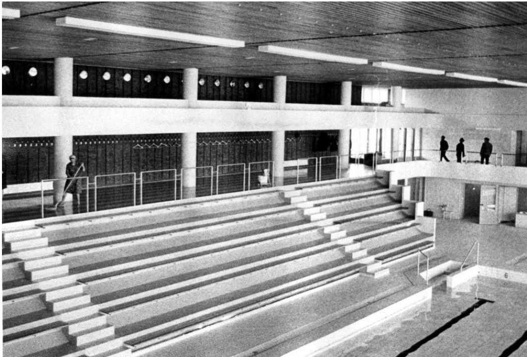
Allassalin koillislaidalla sijaitsevaan katsomoon on kulku sisäänkäynnin tasalta aulasta. Porrastettu katsomo laskeutuu ison altaan tasalle. Katsomon takana aulan jatkeena on rakennuksen koillisestalle sijoittuva naulakotila. Naulakotilaa rajaa pyöreiden betonipilareiden rivistö. Allassalin katopintaa rytmittävät poikittaisten liimapuupalkkien alareunat. (Kuva Kemijoen uimahallin arkisto)
