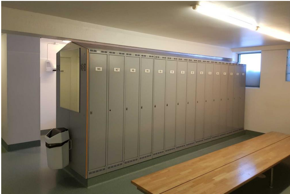
Pukutiloissa kalusteet ja pinnat on uusittu peruskorjauksen yhteydessä.
