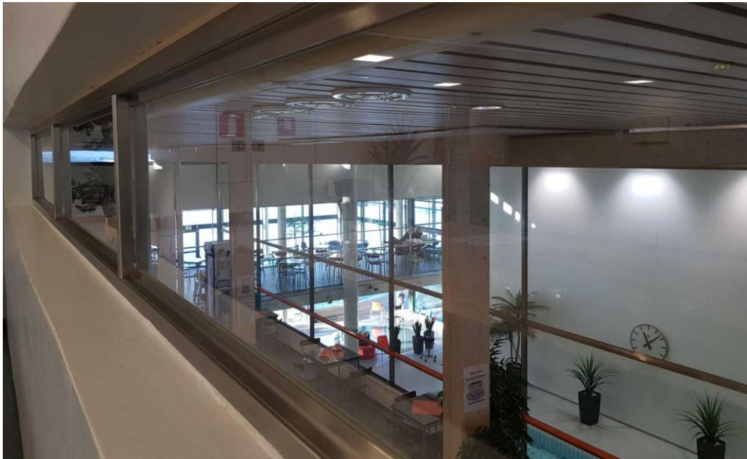
Yläaulasta on ilmeisesti peruskorjauksen yhteydessä avattu ikkunat allassaliin. Uimahallirakennusta alkuperäisessä asussaan kuvaavissa valokuvissa ikkuna-aukkoja ei ole.
