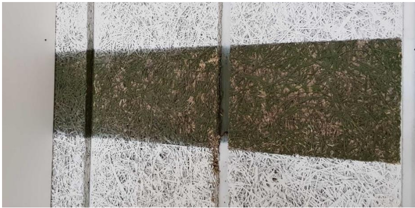
Allassalin seinillä ovat säilyneet alkuperäiset akustoivat verhouslevyt. Ne on peruskorjauksen yhteydessä maalattu valkoisiksi. Alkuperäinen tummanvihreä väri näkyy paikassa mistä seinänaulakot on myöhemmin poistettu.
