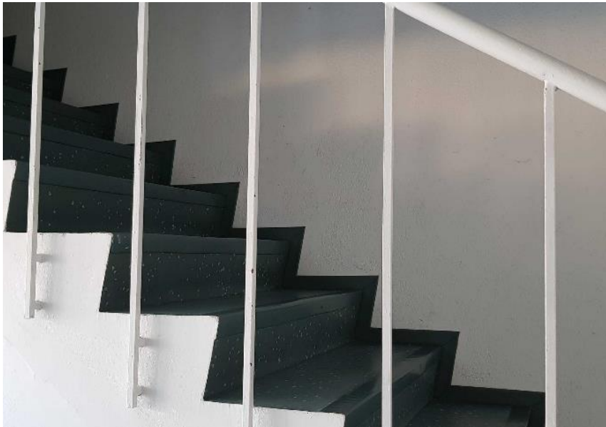
Uimahallirakennuksen luoteiskulmalla sijaitseva ensimmäisestä kerroksesta toiseen kerrokseen johtava porttas on lähes alkuperäisessä asussaan, askelmien pintarakenteet on uusittu ja kaiteet maalattu.
