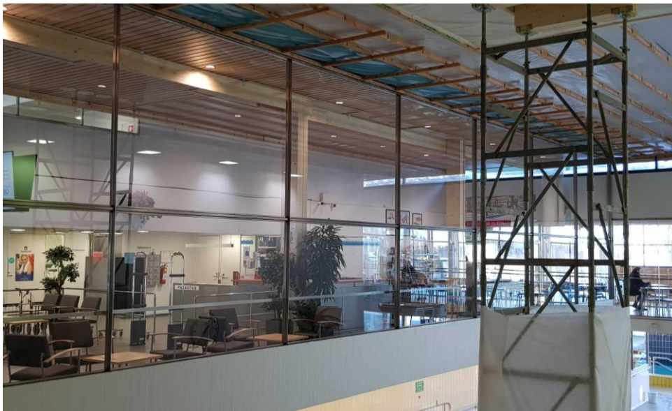
Lasiseinä allassalin puolelta nähtynä. Seinä tukeutuu alkuperäiseen betonikaiteeseen.
