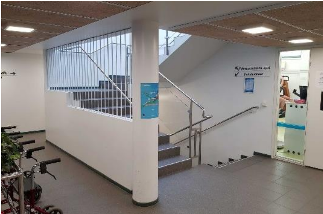
Aulan yhteyteen rakennuksen keskelle on peruskorjauksen yhteydessä rakennettu uusi pääporras, joka johtaa toisen kerroksen tasalla sijaitsevasta aulasta ensimmäisessä kerroksessa sijaitseviin puku-, pesu- ja saunatiloihin ja kolmannessa kerroksessa sijaitseviin kokous-, toimisto- ja pukutiloihin.
