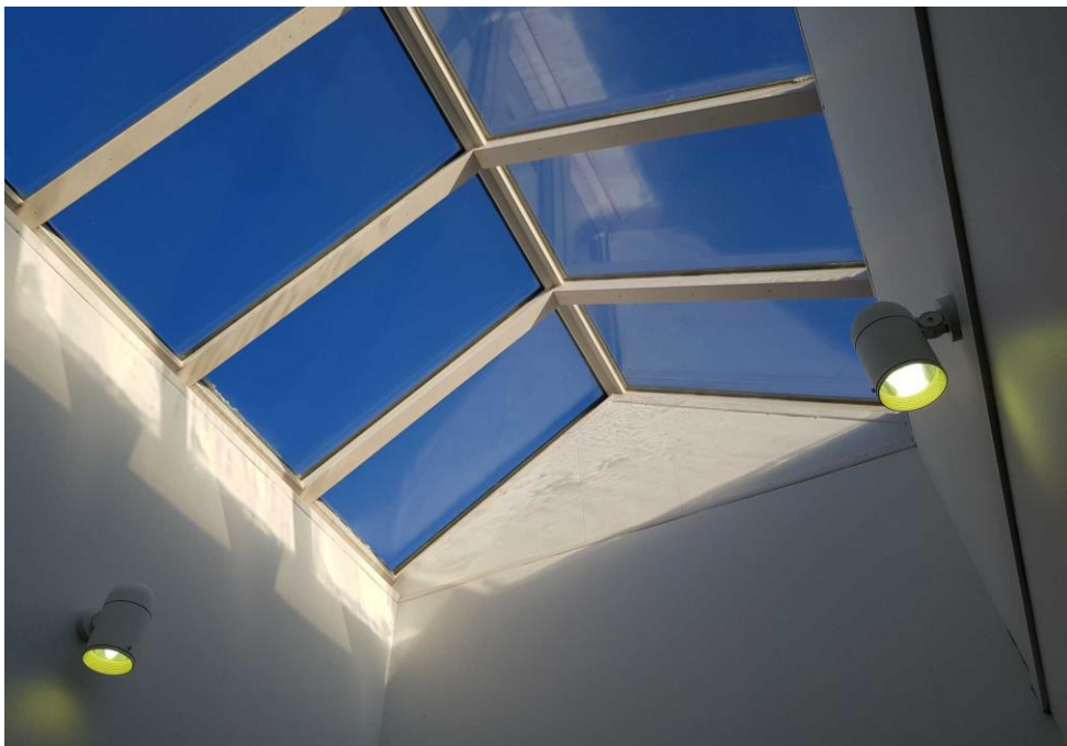
Pääportaan yläpuolella sijaitseva kattoikkuna on rakennettu peruskorjauksen yhteydessä. Ikkuna tuo valoa portaikkoon ja aulatiloihin.
