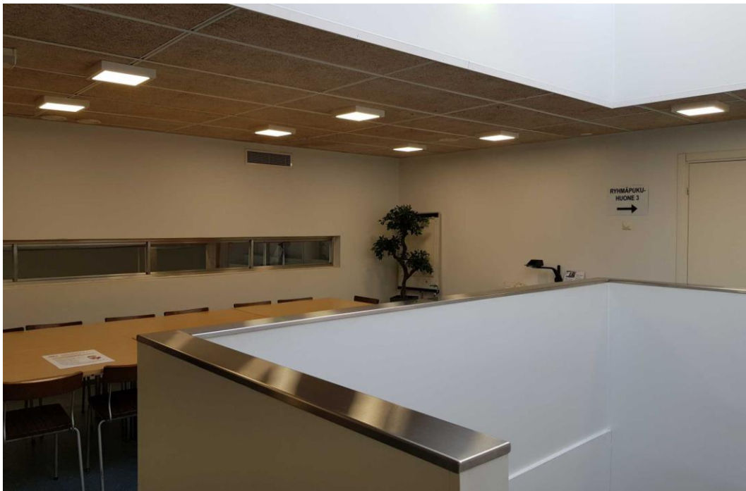
Kolmannessa kerroksessa sijaitsevat tilat on uudistettu peruskorjauksen yhteydessä. Varastotilojen ja teknisten tilojen paikalle on sijoitettu mm. kokoustilana toimiva yläaula sekä pukuhuonetiloja.
