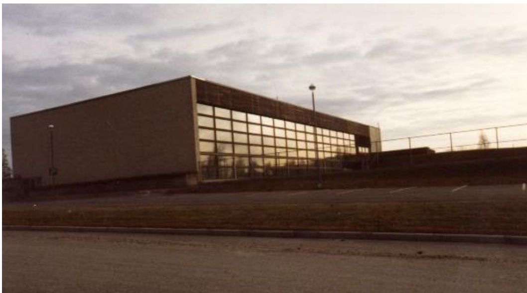
Kemin uimahalli 1970-luvun tienoilla. Kuvissa näkyy julkisivujen alkuperäinen väriyty: julkisivut ovat pääosin vaaleaa poltettua tiiltä, osittain ruskeaksi maalattua puuta. (Kuvat Kemin uimahallin arkisto)
