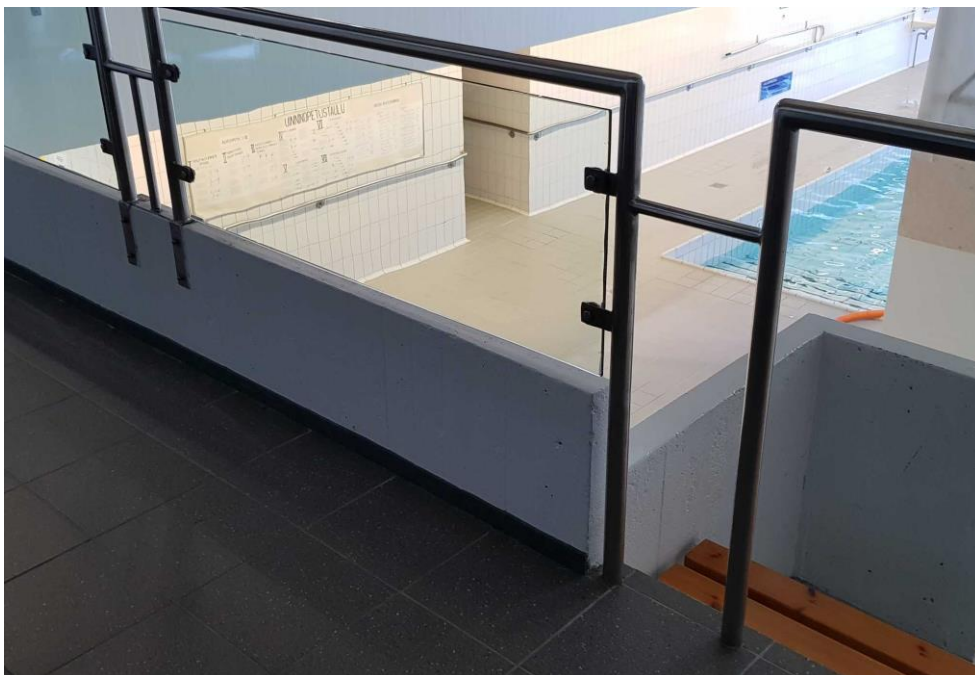
Allassalissa ovat säilyneet alkuperäiset kaiteet. Kaiteiden alaosat ovat lautamuottiin valettua ja maalattua betonia, yläosat teräs-lasirakenteiset.
