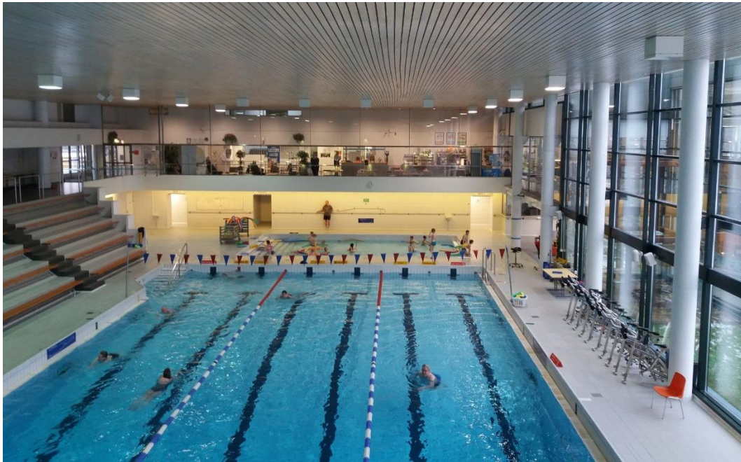
Allassalin alakattorakenteet on peruskorjauksen yhteydessä uusittu. Nykyinen alakatto on ripustettu vanhan alapuolelle. Uusi alakatto on ulkoasultaan alkuperäisestä poikkeava, alun perin kattopintaa rytmittivät poikittaisten liimapuupalkkien alareunat. (Kuva Kemin uimahallin arkisto)
