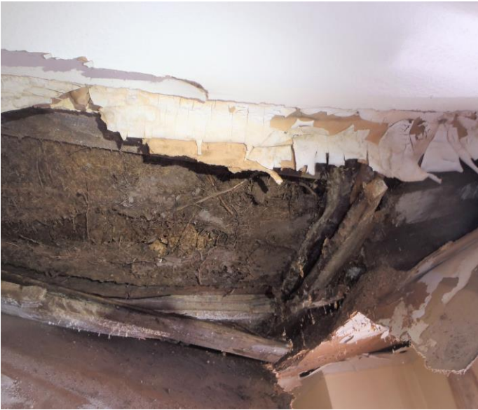
47-48. Keittiössä ja mh:ssa katto/yläpohja lahonut putki(kts em yläpohja/vesikatto)
