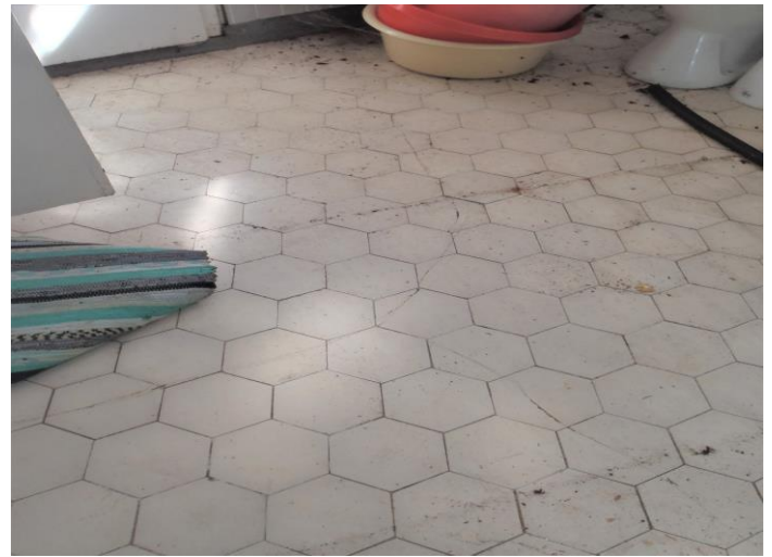
7-8. Lämmönjakohuoneen lattia kostea/kosteusjälkiä. Peh-wc:n lattian betonilaatassa hiushalkeamia
