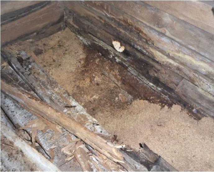
11-12. Ulkoseinäyläosissa/yläpohjassa takasivulla (k/mh-kulmalla ja k:ssä piipun alla ympärillä) merkkejä kosteusvaurioita
