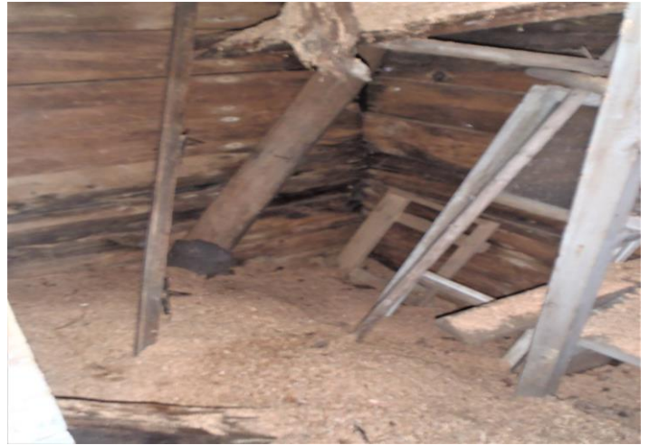
41-42. Talousrakennuksen lisävarastoissa katto vuotaa/vuotanut, välivaraston muhaeristeinen yläpohja romahtanut
