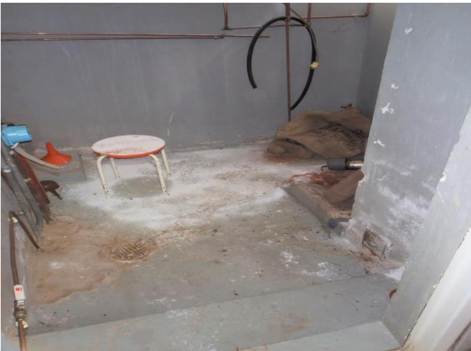
7-8. Lämmönjakohuoneen lattia kostea/kosteusjälkiä. Peh-wc:n lattian betonilaatassa hiushalkeamia
