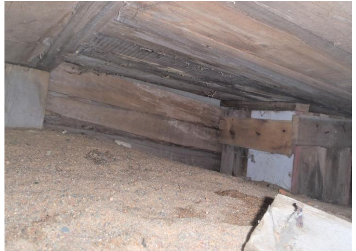
5-6. Pihasisivulla keittiöseinällä alapohja pieneltä osin pudonnut, perustuskivi painunut. Piipujuuressa alapohjassa kost.jälkiä/-vikaa
