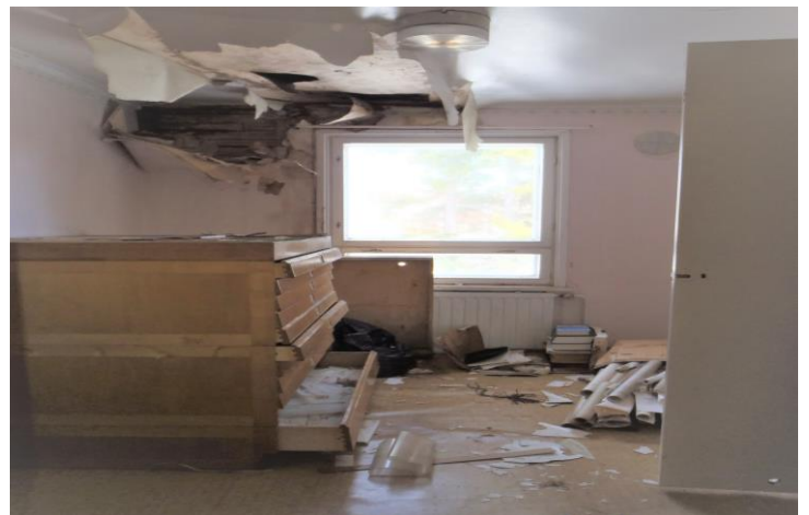
49-50. Päärakennuksen huoneseinien ja -kattojen pintamateriaalien alla paikoin vanhoja vuotojälkiä ja -vikoja.
