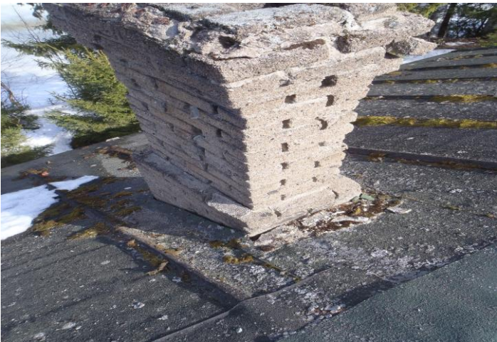
27-28.Katolla piippujuuret vuotaa ja piipuissa kunnostamista,sääsuojia(hattua) ei ole
