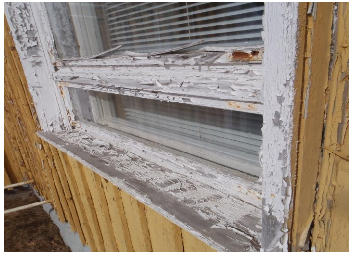
13-14. Julkisivun alapäässä paikoin lahovikaa, maalipinnassa kunnostamista. Ikkunoissa kunnostamista
