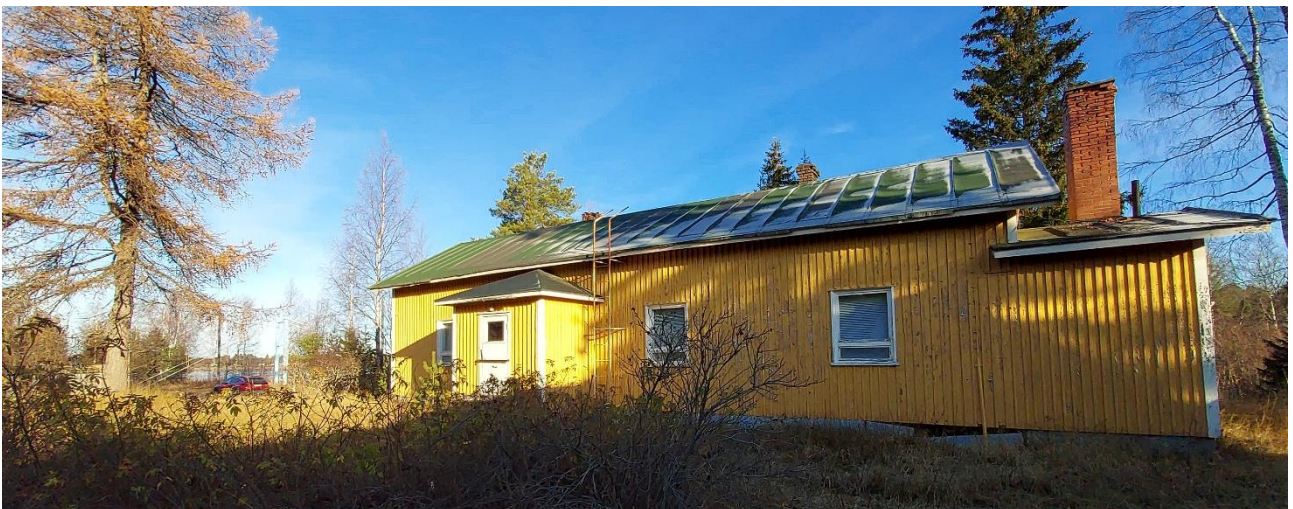
Kuva 18. Alueella sijaitseva vanha asuinrakennus.
