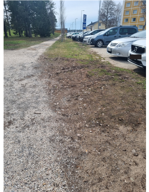
Yllä: Pysäköintialue Meripuiston laidalla Kauppakadun päässä on jäänyt keskeneräiseksi ja pysäköinti on jäsentymätöntä.
