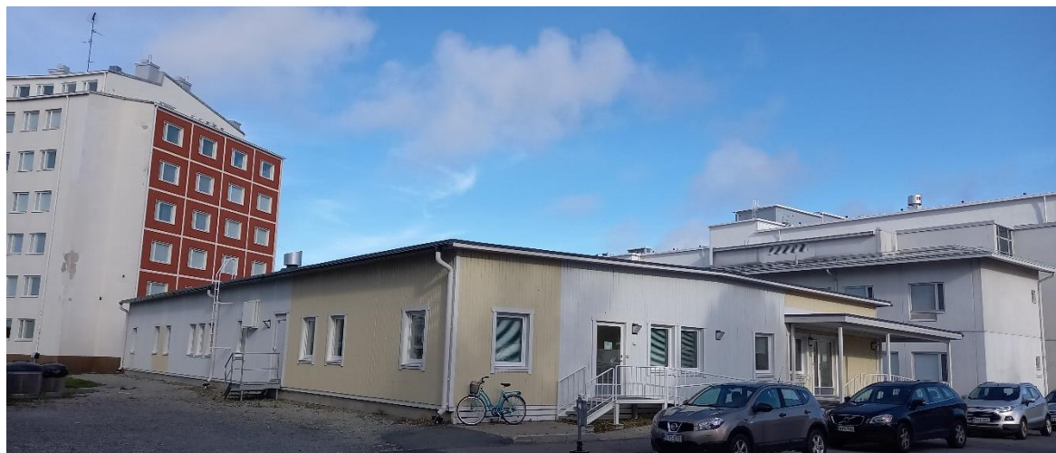
Kuva 5. Yksikerroksinen psykiatrian väistötilarakennus Kauppakadun varressa on rakennettu tilapäisellä rakennusluvalla v.2018 (J.Lokio 2022).
