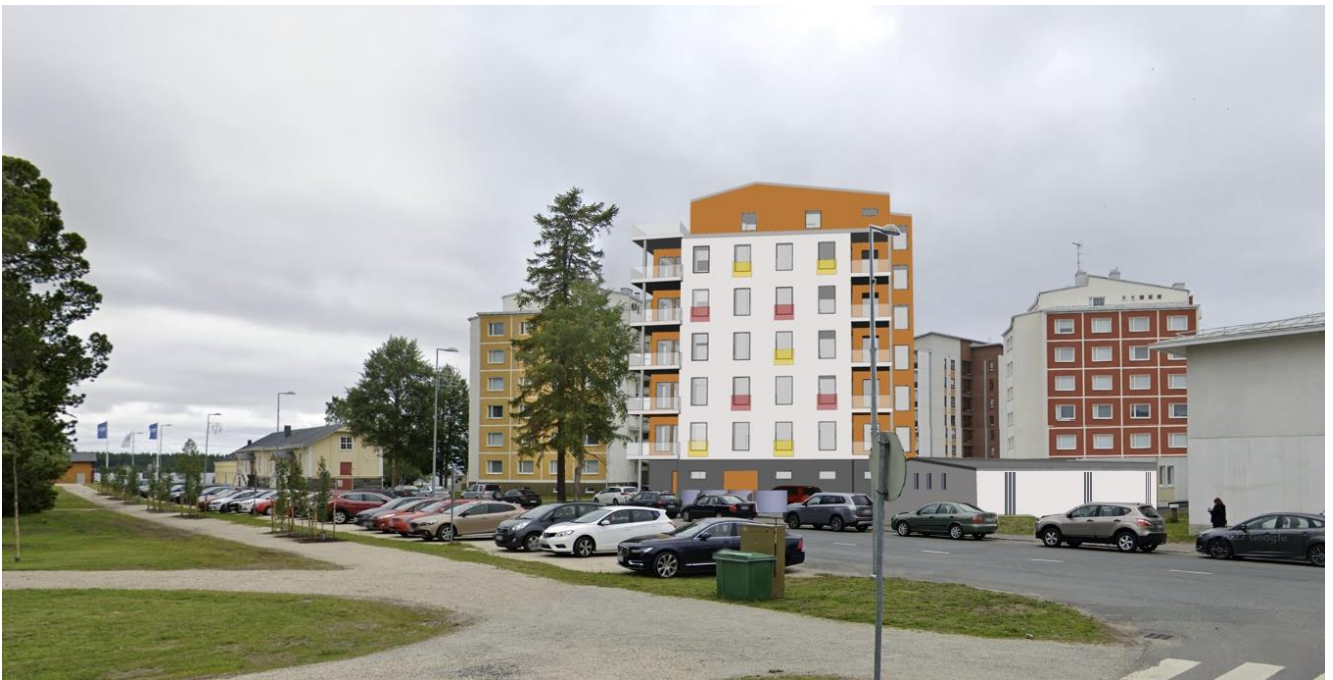
Kuva 30. Havainnekuva kaavan sallimasta uudisrakentamisesta ja sen soveltumisesta olevaan ympäristöön. Massoittelu, kerrosluku, aukotus ja rakennuksen yleisväritys täydentävät suojeltuja pistetaloja. © Arkkitehti-toimisto Jarmo Lokio Oy 2023.
