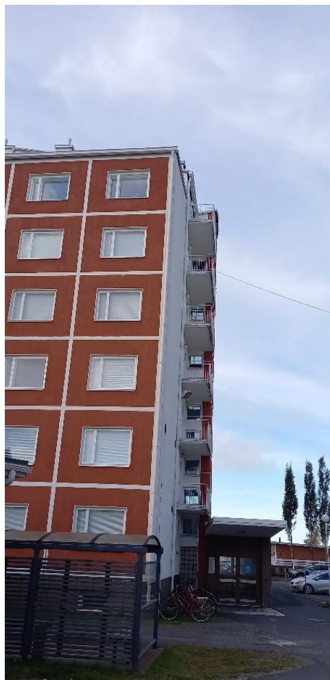
Kuva 2. Meripuistokatu 3 sisäänkäynti- ja parvekeseinä pihan puolelta (J.Lokio 2022).
