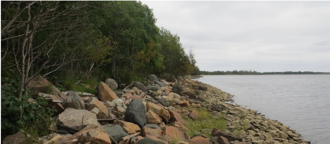
Kuva 4. Jätevedenpuhdistamon rakennettua rantaa.
