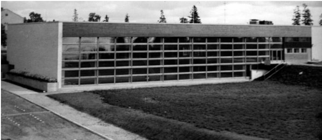
kuva 6. Uimahallin vanha osa ennen myöhempää, vuoden 1997 laajennusosaa. Ote Kemin uimahallin rakennushistoriaselvityksestä /Sweco Ympäristö Oy 3.5.2019 / Kemin uimahallin arkisto.
