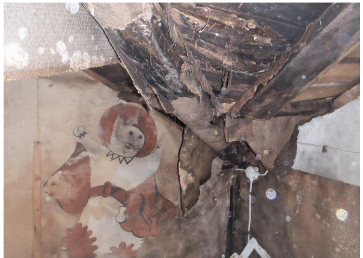
37-38. Vesikatto vuotaa/vuotanut (valo paistaa) pihapään huonetilan parviosalla, puuoissa lahovikoja, jiiri romahtamassa
