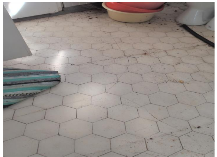
7-8. Lämmönjakohuoneen lattia kostea/kosteusjälkiä. Peh-wc:n lattian betonilaatassa hiushalkeamia
