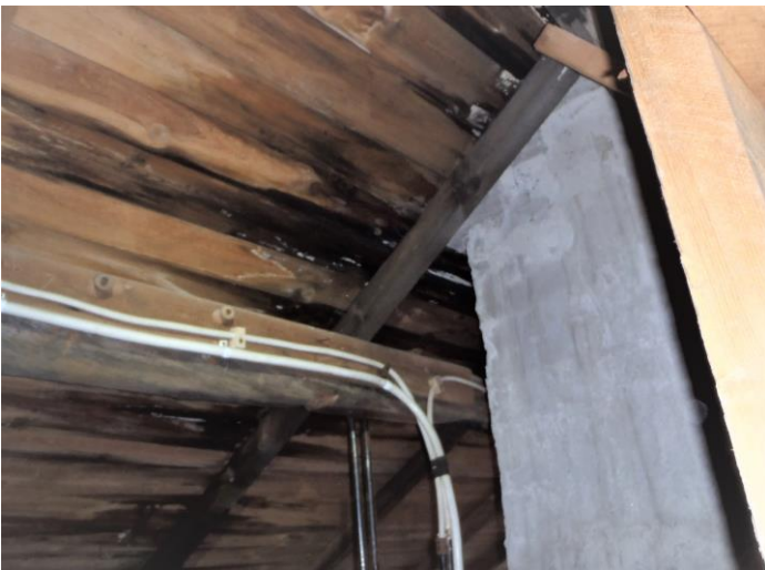
19-20. Keittiön piipun ympärillä/alalappeella katto vuoti, ko kohdilla yläpohjan/ulkoseinän puu- ja eristeosissa laho-/mikrobivaurioita
