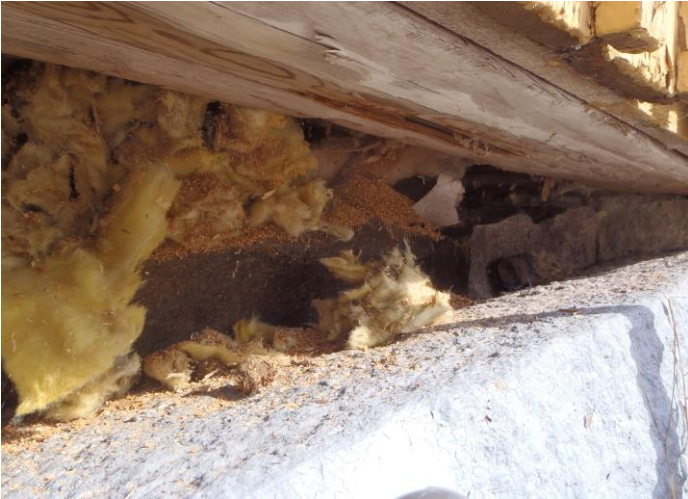
5-6. Pihasisivulla keittiöseinällä alapohja pieneltä osin pudonnut, perustuskivi painunut. Piipujuuressa alapohjassa kost.jälkiä/-vikaa
