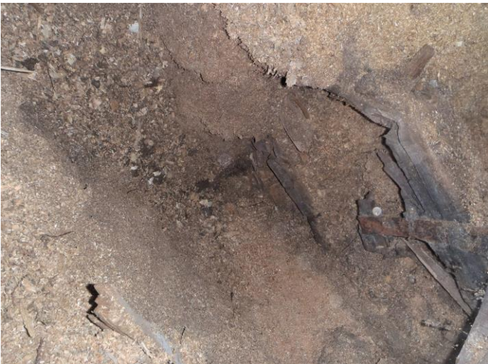
9-10. Ulkoseinäyläosissa/yläpohjassa pihasisivulla (ent k/oh-et:n vuotkohdat) vanhoja kosteusvaurioita (kattohuopa uusittu)
