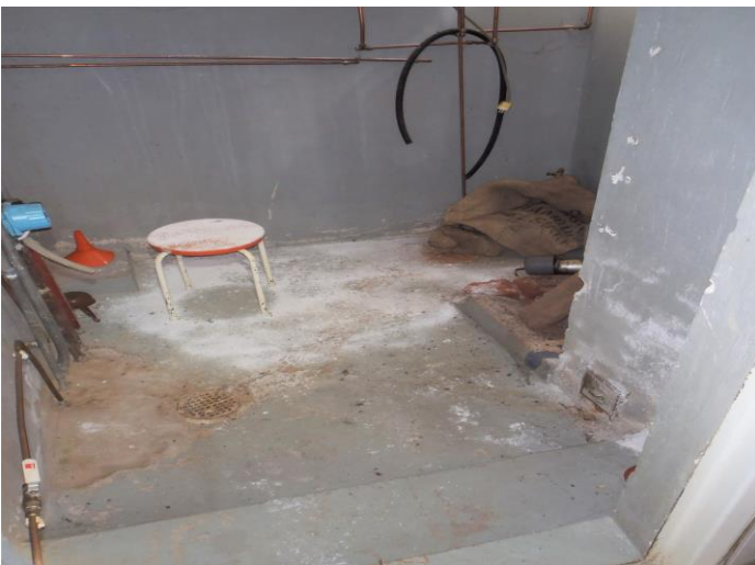
7-8. Lämmönjakohuoneen lattia kostea/kosteusjälkiä. Peh-wc:n lattian betonilaatassa hiushalkeamia
