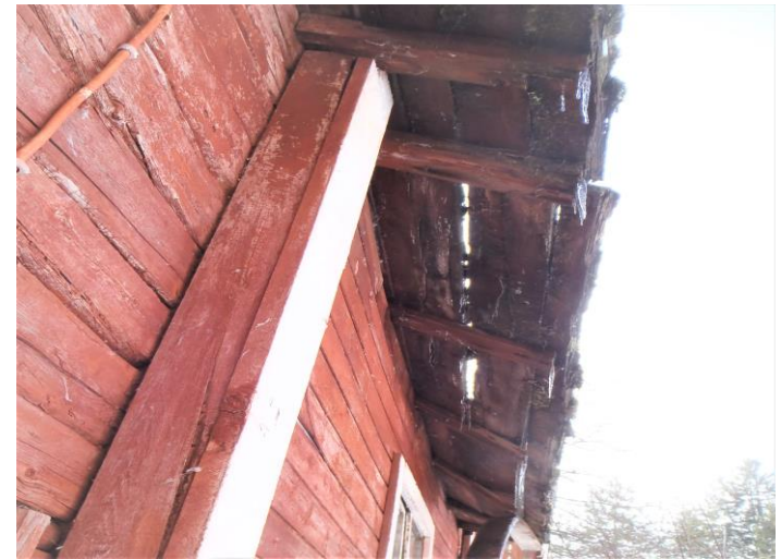
43-44. Talousrakennuksen vesikaton huopakate osin puuttuu, laudoituksessa/räystäässä lahoavikoja. Sadevesipoistoja ei ole ollut
