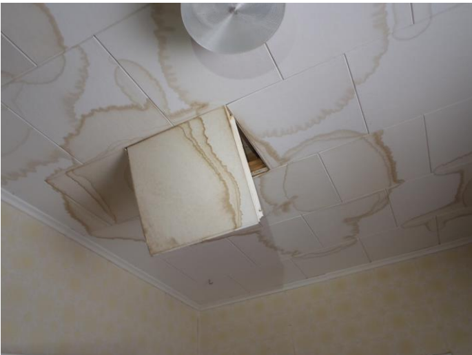
45-46. Päärakennuksen huonetilojen katto ja seinäpinnoissa vanhoja vuoto/valumajälkiä (kts em vesikatto/yläpohja)
