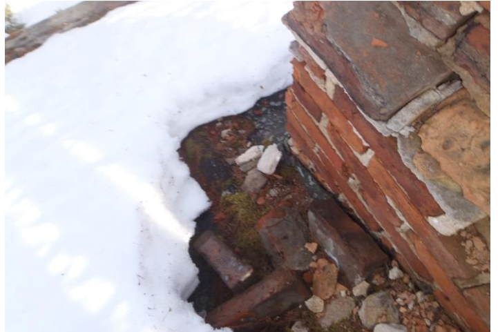
25-26.Vesikaton kattuhuopa heikkokuntoinen takalappeella(pihalappeella korjattu).Yksi piipuista romahtanut
