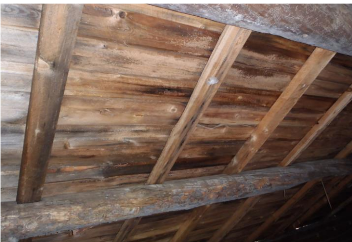
21-22. Vesikattolaudoituksessa ja huonetilojen sisäkatoissa useissa kohdissa vanhoja kosteusjälkiä (kts em yläpohja)
