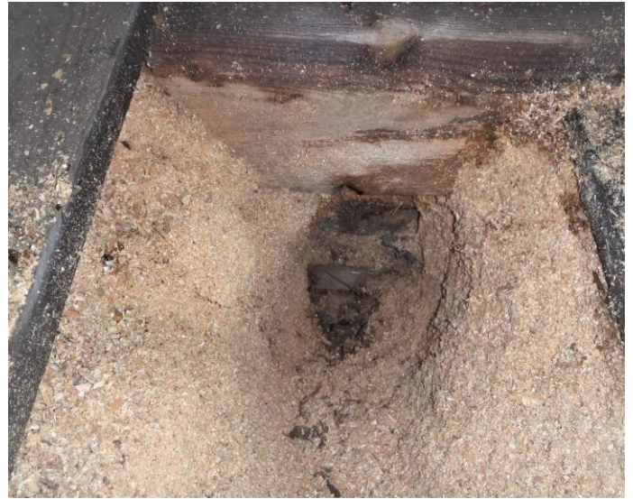
11-12. Ulkoseinäyläosissa/yläpohjassa takasivulla (k/mh-kulmalla ja k:ssä piipun alla ympärillä) merkkejä kosteusvaurioita
