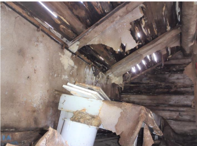
37-38. Vesikatto vuotaa/vuotanut (valo paistaa) pihapään huonetilan parviosalla, puuoissa lahovikoja, jiiri romahtamassa
