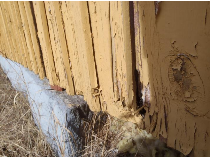
13-14. Julkisivun alapäässä paikoin lahovikaa, maalipinnassa kunnostamista. Ikkunoissa kunnostamista
