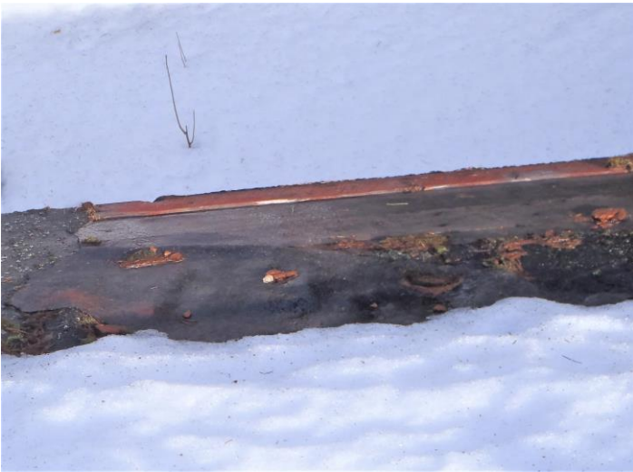
25-26.Vesikaton kattuhuopa heikkokuntoinen takalappeella(pihalappeella korjattu).Yksi piipuista romahtanut
