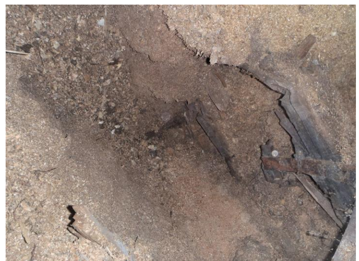
9-10. Ulkoseinäyläosissa/yläpohjassa pihasisivulla (ent k/oh-et:n vuotkohdat) vanhoja kosteusvaurioita (kattohuopa uusittu)
