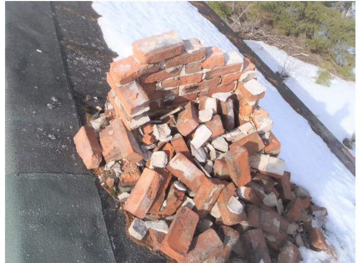
25-26.Vesikaton kattuhuopa heikkokuntoinen takalappeella(pihalappeella korjattu).Yksi piipuista romahtanut
