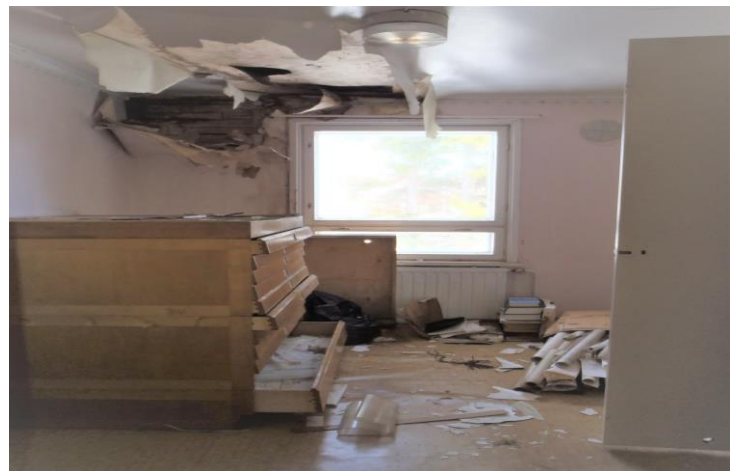
49-50. Päärakennuksen huoneeseinien ja -kattojen pintamateriaalien alla paikoin vanhoja vuotojälkiä ja -vikoja.
