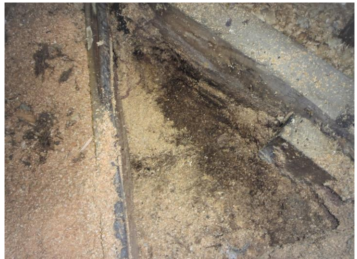
19-20. Keittiön piipun ympärillä/alalappeella katto vuoti, ko kohdilla yläpohjan/ulkoseinän puu- ja eristeosissa laho-/mikrobivaurioita
