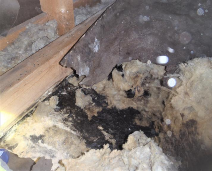
23-24.Laajennusosan(peh-wc ja ljh) yläpohjassa/katoissa märkiä villoja(kattoluukku/katto vuotanut)
