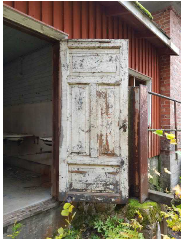
Rakennuksen kaakkoiskulmassa on pesuhuone, jonne on kulku suoraan ulkoa. Pesuhuoneen paneeliövi on selvästi kiertetty jostain vanhemmasta rakennuksesta.
