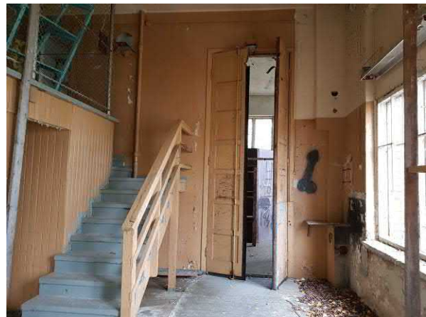
Korkeat pariovet ovat peräisin 1920-luvulta. Parvikerrokseen johtaa puurakenteinen porras.
