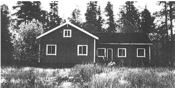
Veitsiluoto Oy:n asuinrakennus. (Kuva Eloranta 1999).
