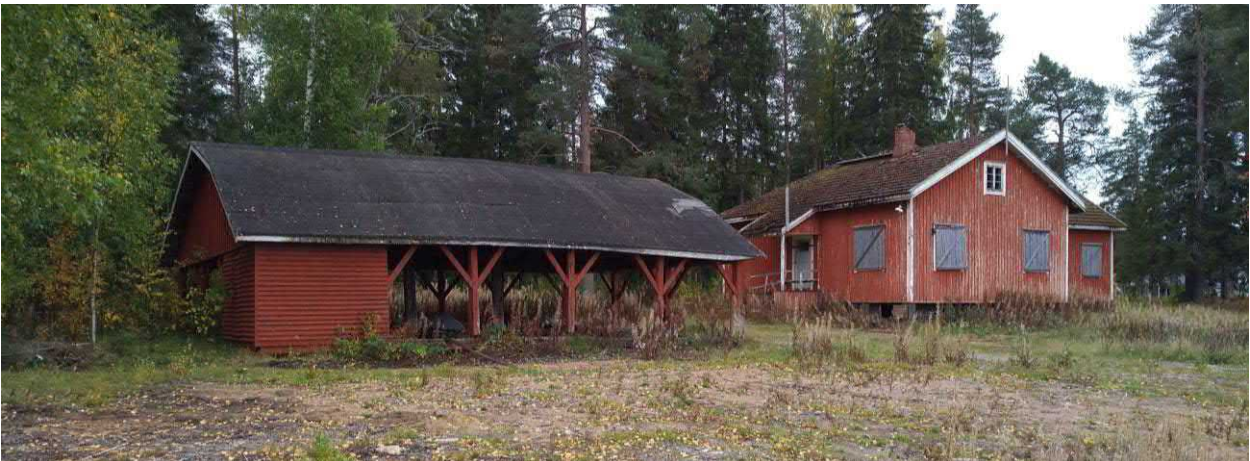
Vuonna 1925 rakennettu venekatos ja vuonna 1938 rakennettu asuinrakennus sijaitsevat jokivarressa Leukalan puolella, nykyään hieman erillään uiton alueen muista rakennuksista.
