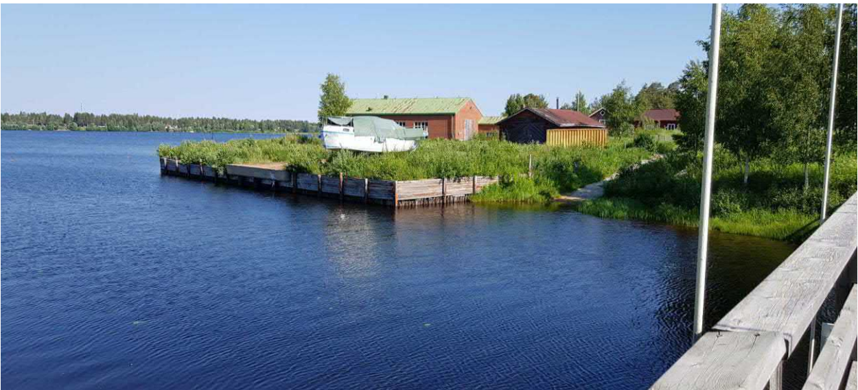
Näkymä työmaa-alueelle Majaputaan yli johtavalta riippusillalta. Etualalla näkyvät levyhalli ja hitsaussuuli.
