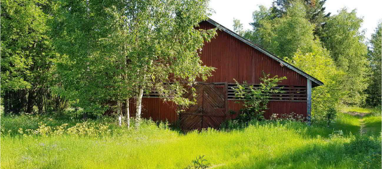
Vuonna 1952 rakennettu suuri venesuuli sijaitsee Leukalassa Majaputaan partaalla, pääty putaalle päin.
