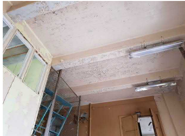
Kattoa kannattavat muodoltaan pelkistetyt betonipalkit.
