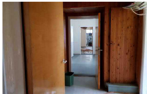
Eteisen seinissä on 1950-luvun lakatut sormipaneelit. Väliovet ovat 1950-luvun lakattuja vaneriovia.
