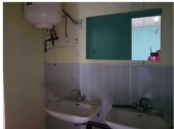
Pesuhuone on erotettu väliseinällä kuivaushuoneesta. Pesuhuone on rakennettu historiatietojen mukaan 1970-luvun alussa. Pesuhuoneessa on pesualtaat ja lämminvesiboileri.
