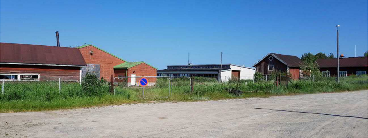
Työmaa-alue Majaputaan suunnasta nähtynä. Kuvassa näkyvät hitsaussuuli (rakennettu vuonna 1959), punatiilinen levyhalli (1962), konttori-moottorikorjaamorakennus (1968), varastorakennus (1928) ja paja ja verstasarakennus (1930). Aluetta rajaa teräsverkköaita.
