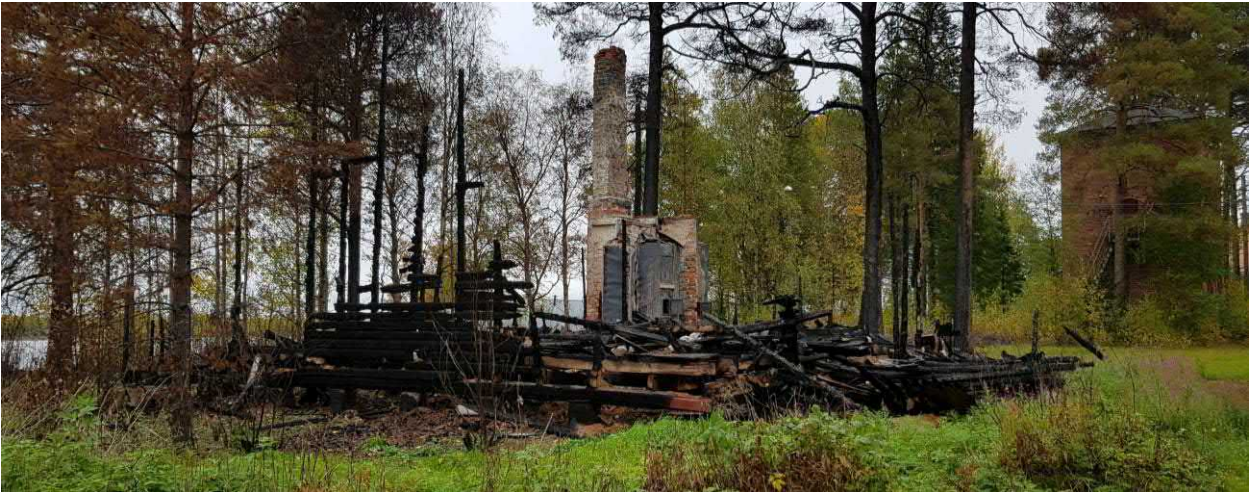
Ruokalan pohjoispuolella sijainnut Mäntykämpä on tuhoutunut tulipalossa kesällä 2022. Taustalla näkyy punatiilinen muuntaja.
