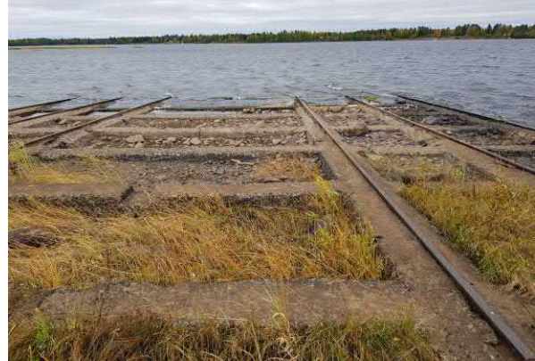
Päätelakan rautakisko- ja betonirakenteita.
