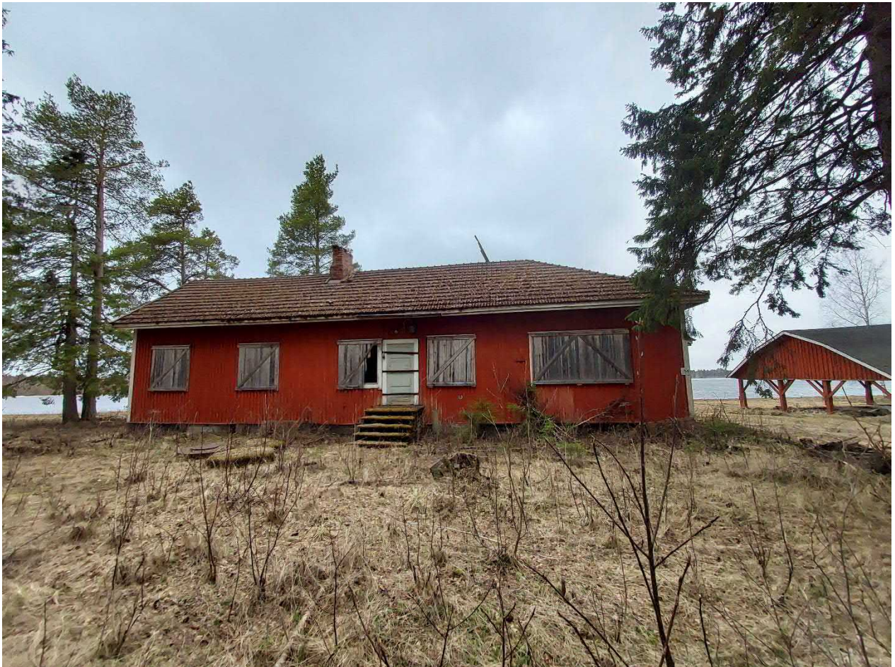
Kuva 17. Leukalantie 14. Majoitusrakennus ja venekatos. Kuva: Miisa Saukkonen
