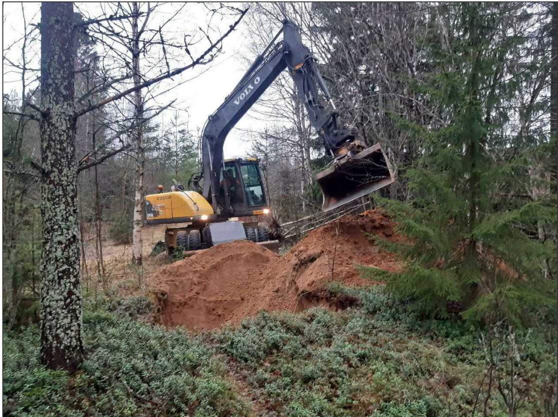
Kuva 1. Koekuopan KK8 kaivua (2.11.2021).
