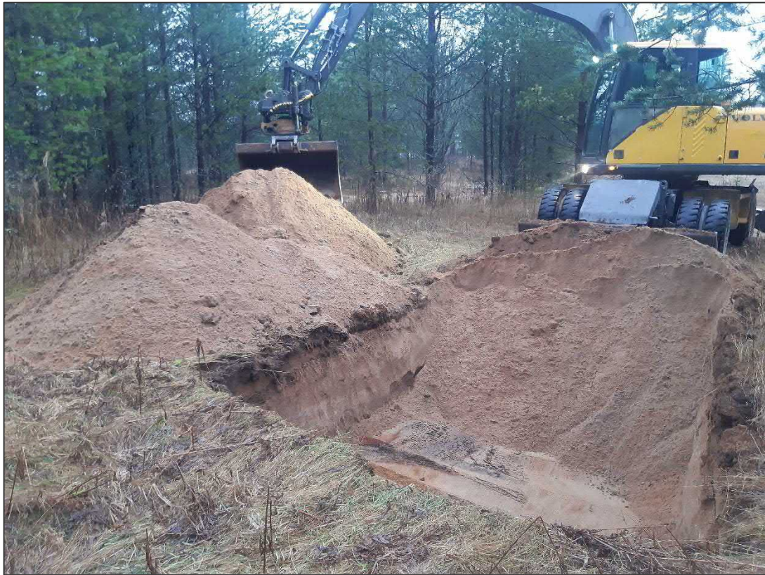
Kuva 3. Koekupan KK2 kaivua (1.11.2021).
