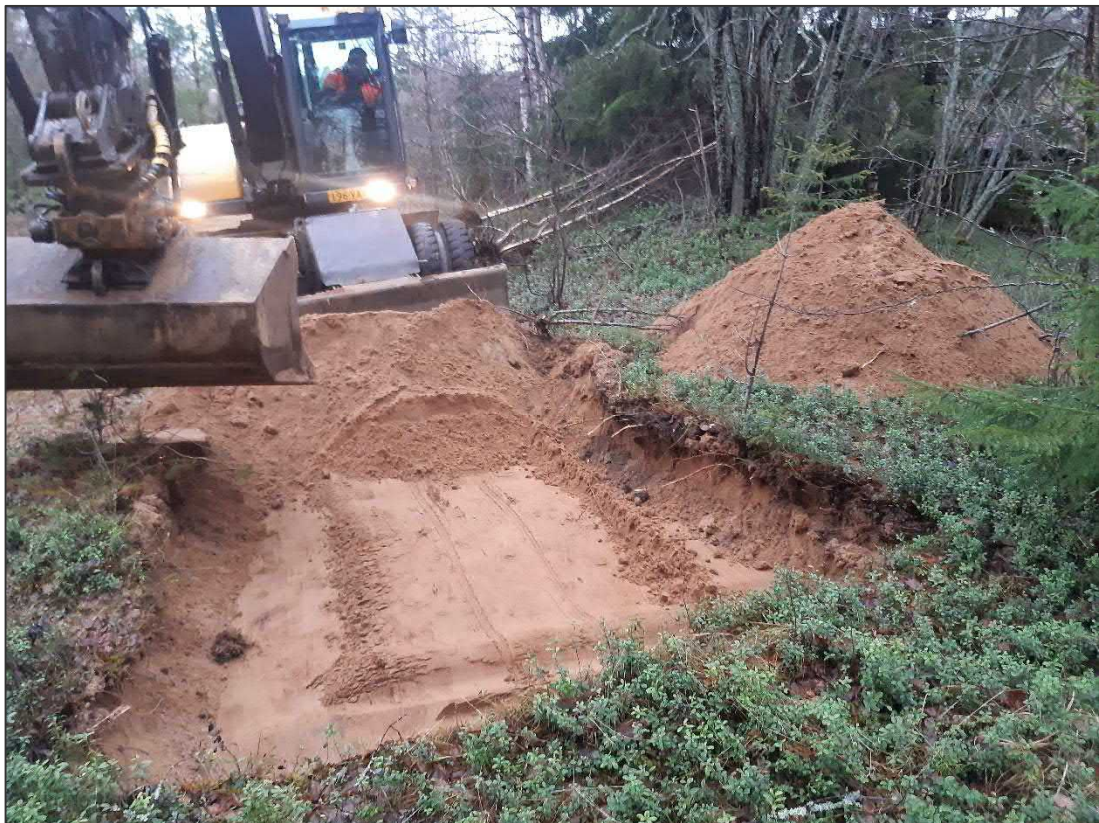
Kuva 4. Koekuopan KK8 kaivua (2.11.2021).
