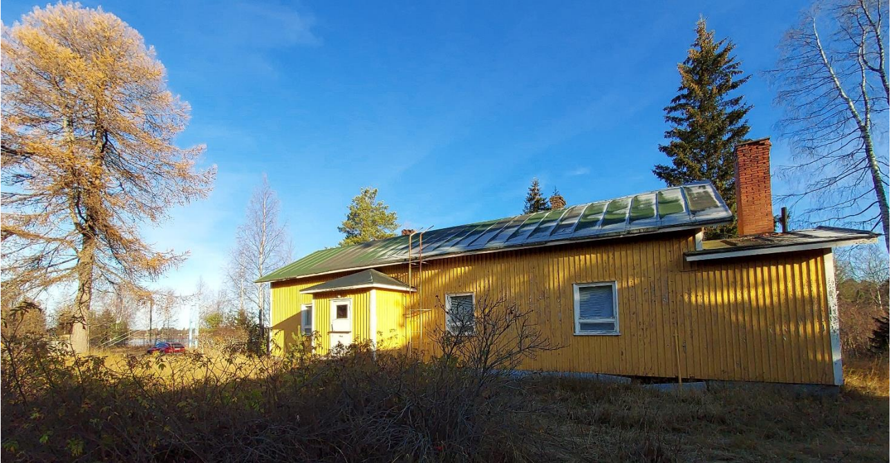
Kuva 18. Alueella sijaitseva vanha asuinrakennus.
