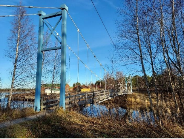
Kuva 8. Kaava-alueelta Sotisaareen johtava kevyenliikenteen silta.
