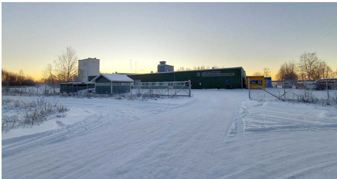
Kuva 3. Olemassa oleva jätevedenpuhdistamo tasoristeyksestä kuvattuna.
