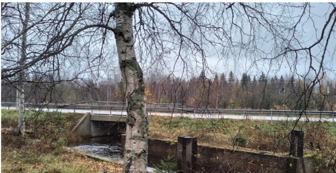
Vähä-Ruonaojan pato- ja kanavarakenteita.
