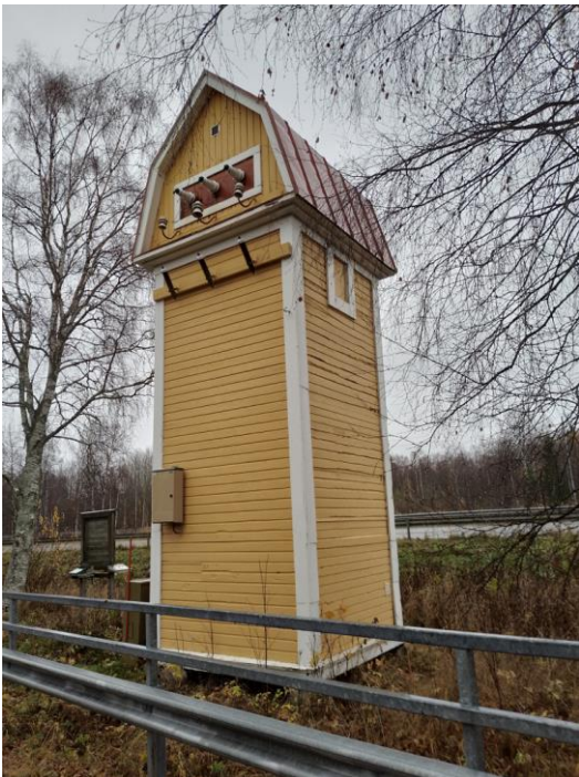
Mansardikattoinen puurakenteinen muuntamo Eteläntien varressa.
