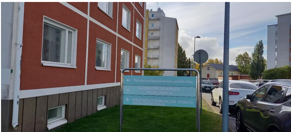
Kuva 7. Vanhemmassa, v.1956 valmistuneessa pistetalossa (Merikatu 3) on Länsi-Pohjan sairaanhoitopiirin hallinto- ja psykiatria vastaanottotiloja ja -osastoja (J.Lokio 2022).
