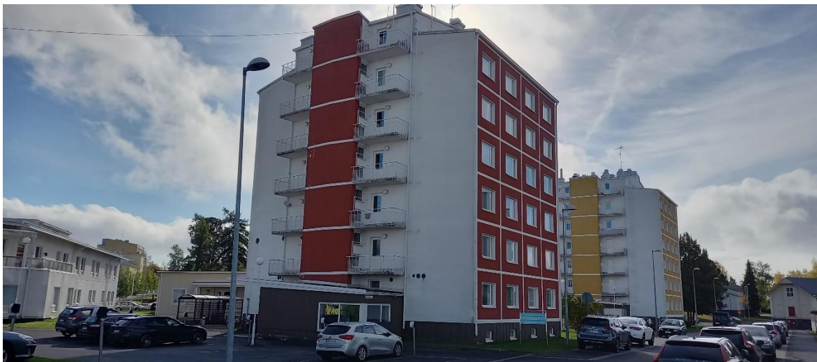
Kuva 3. Kaavamuutosalueella sijaitsee vv.1956 ja 1958 rakennetut kaksi 6 ja ½-kerroksista pistetaloa (J.Lokio 2022).
