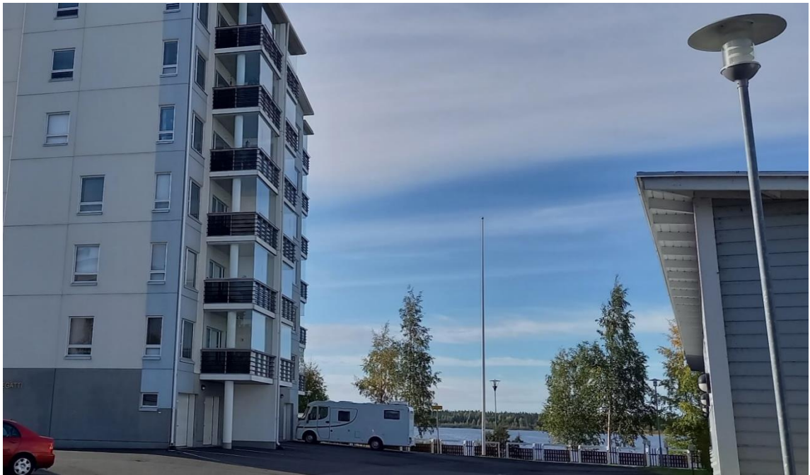
Kuva 28. Merikadun merenpuoleisten uudisrakennusten välistä pilkahtelee merimaisema katutasollakin kaavamuutosalueen kohdalla (Kuva J.Lokio 2022).
