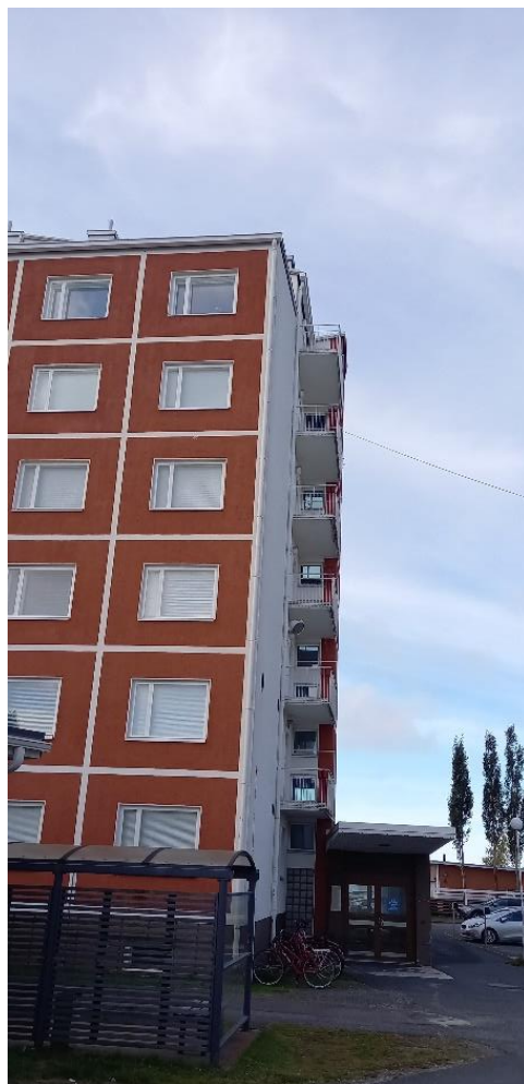
Kuva 2. Meripuistokatu 3 sisäänkäynti- ja parvekeseinä pihan puolelta (J.Lokio 2022).
