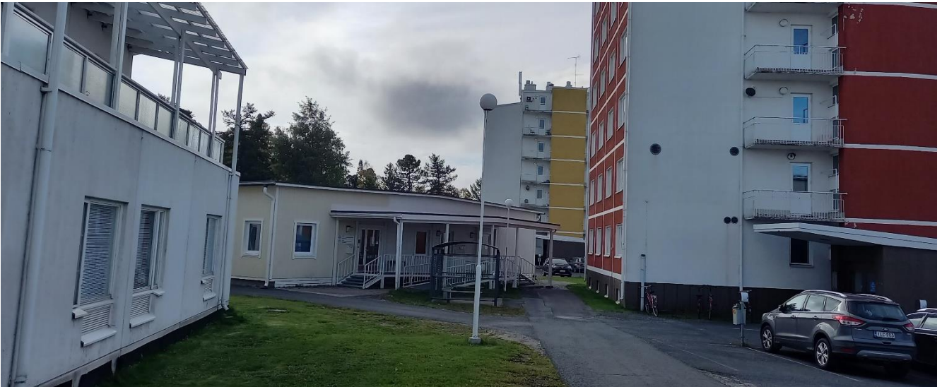
Kuva 23. Yksikerroksinen, v.2018 viiden vuoden väliaikaisella rakennusluvalla toteutettu psykiatrian väistötila sijaitsee ahtaasti muuhun olevaan rakennuskantaan nähden. Rakennus puretaan syksyllä 2023. Kuva J.Lokio 2022.
