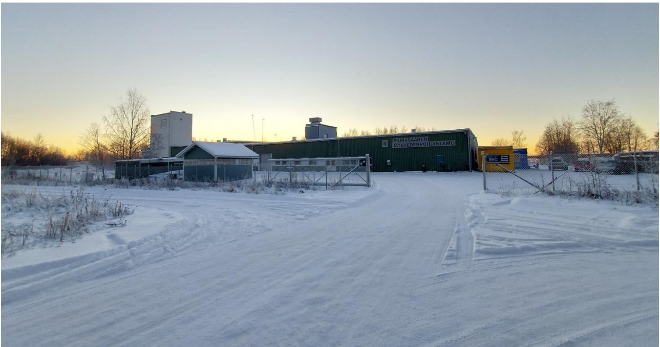
Kuva 3. Olemassa oleva jätevedenpuhdistamo tasoristeyksestä kuvattuna.
