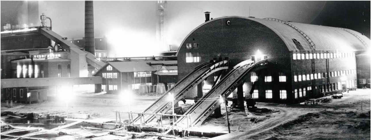
Kuva 126 Ote valokuvasta vuodelta 1951 koillisesta. Vasta valmistunut kaarikattoinen saha. Kuvan etualalla näkyy sahan tukkiallas, josta johtaa tukkien kuljettimet sahalle. Kuvan perusteella itäpäädyin ja pohjoisjulkisivun ikkunat ovat olleet ruutuikkunoita. Kuvälähde: Kemin historiallinen museo / 893 (4301) Veitsiluodon saha vuonna 1951. Kuvaaja Mannelin.
