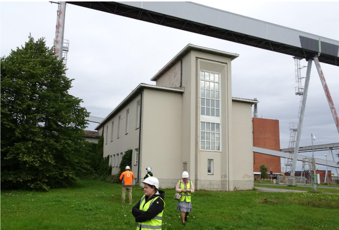
Kuva 218 Etelään. Rakennuksen yli on rakennettu kuljetin 1990-luvulla.
