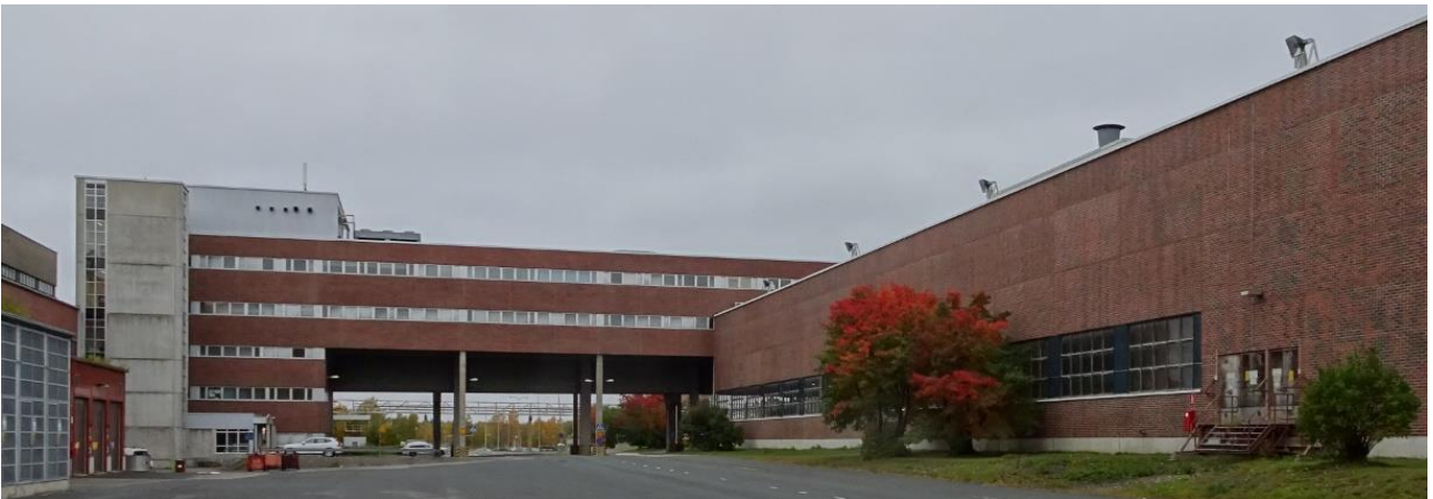
Kuva 296 Yhdysosa kaakosta. Arviolta 1990-luvun alkupuolella on rakennettu paperitehtaiden väliin ja Paperitien ylle toimisto- ja laboratoriotiloja sisältävä siipiosa. Sen paikalla on ollut jo PK5:n rakennuksen valmistumisesta alkaen paperitehtaat paperivarastoille yhdistävä kuljetin. PK5 näkyy kuvan oikeassa reunassa. Kuvälähde: FCG 2022
