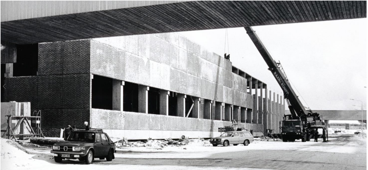
Kuva 289 Lännestä vuonna 1985. Koneistamo on rakenteilla PK5:n lounaisjulkisivun keskivaiheille. Kuvälähde: Kemin historiallinen museo / 1608 (5025) Uuden koneistamon uudisrakennus vuonna 1985. Uuden koneistamon rakennustilavuus oli runsaat 32 000 kuutiota ja rakennusala yli 12 000 neliötä. Kuvaaja Manne Stenroos.
