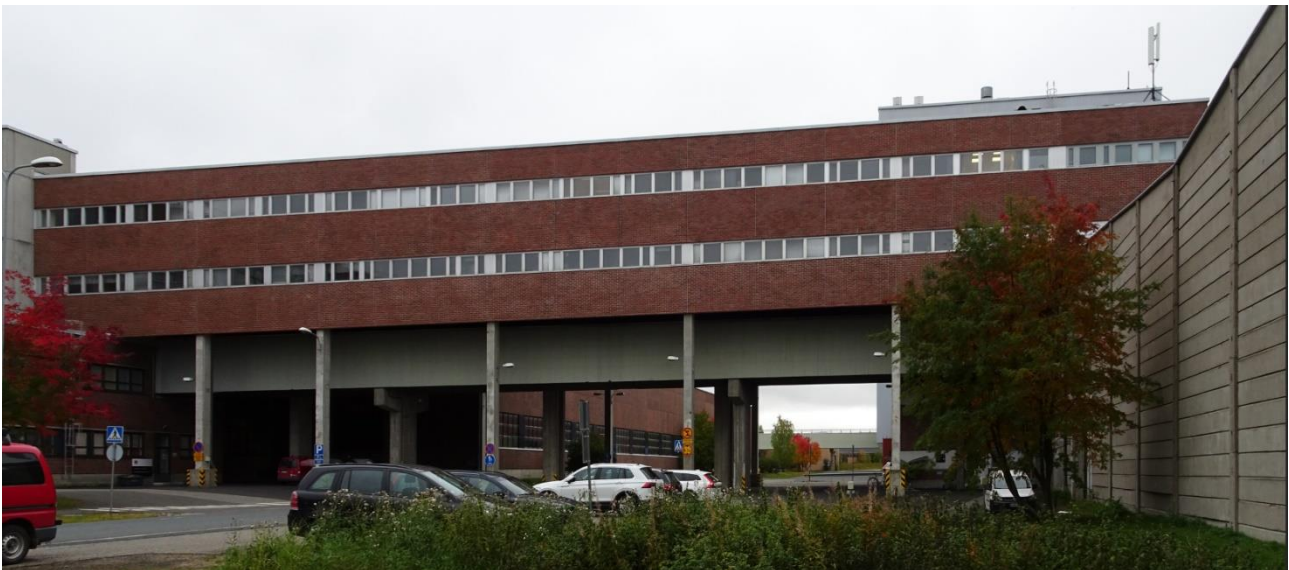
Kuva 209 Yhdysosa luoteesta. Arviolta 1990-luvun alussa rakennetun Paperitien ylittävän toimisto- ja laboratoriosiiven alla näkyy paperitehtaat paperivarastoille yhdistänyt kuljetin. Kuvan oikeassa reunassa näkyy paperivaraston betonielementtiseiniä. Kuvälähde: FCG 2022
