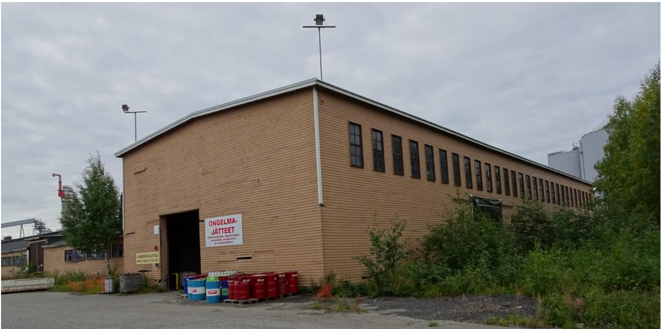
Kuva 177 Varasto pohjoisesta. Kuvälähde: FCG 2022
