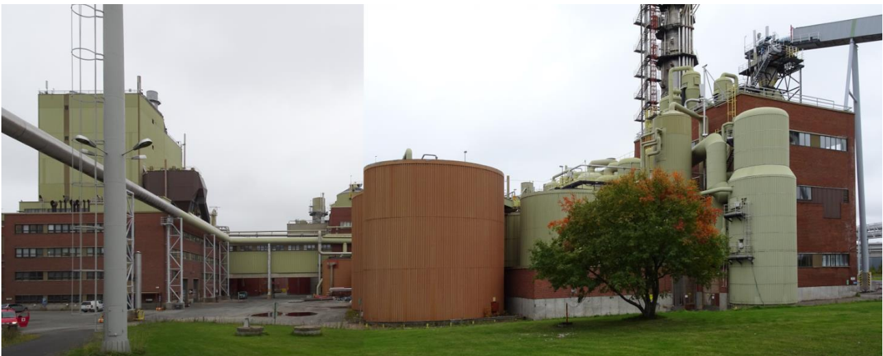
Kuva 324 Sulfaattiselluloosatehdas kaakosta. Oikealla on Kamyrr-keitin ja höyrykattilat. Punaiset säiliöt keskellä on rakennettu myöhemmin. Kuvälähde: FCG 2022
