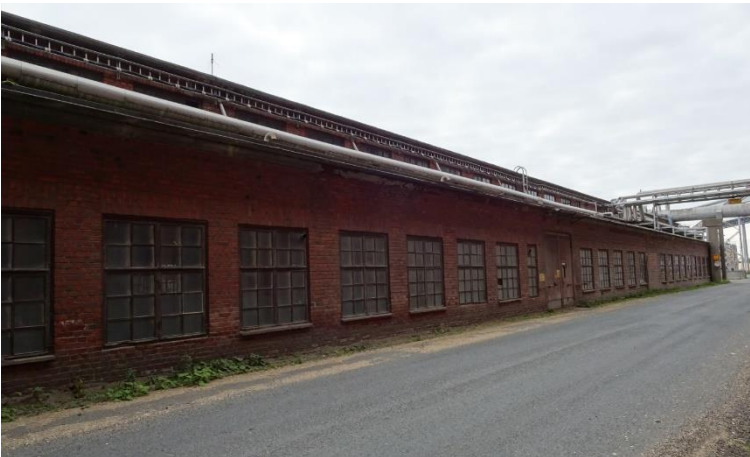
Kuva 111 Luoteesta. Konepajan aukkojen yläreunat on tehty tiiliholvimuurauksella ja ulkopuolen ikkunapenkit betonista. Kuvälähde: FCG 2022
