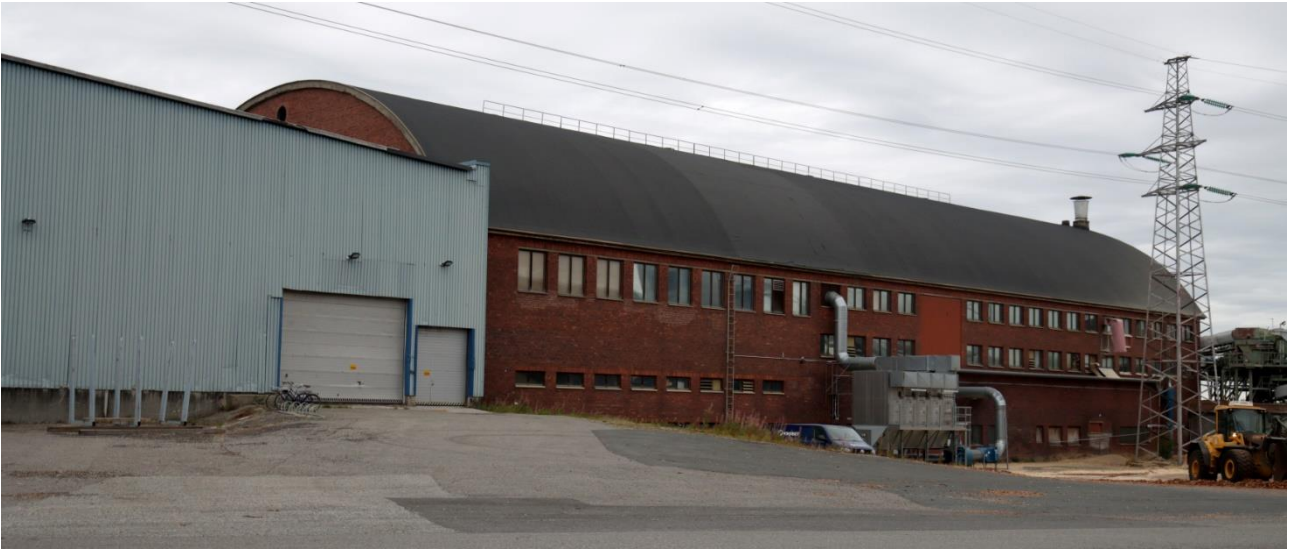
Kuva 135 Sahan eteläjulkisivu lounaasta. Jälkikäsittelyosaston laajennukset on rakennettu kiinni sahan länsipäähän. Kuvälähde: FCG 2022
