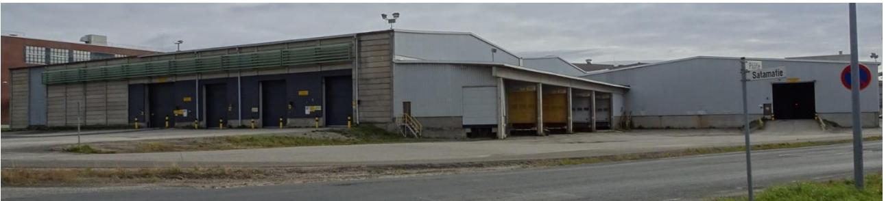
Kuva 211 Luoteispääty ja lounaisjulkisivua. Paperivaraston päädyn aukotusta on muutettu ja lounaissivulle lisätty lastauslaiturit. Kuvälähde: FCG 2022
