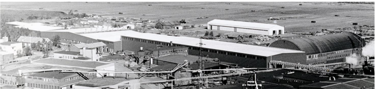
Kuva 134 Ote ilmakuvaista vuodelta 1975 lounaasta. Uusi kuivaamo jälkikäsitteilytiloineen on valmistunut sahan jatkeeksi. Kuivaamon ja jälkikäsitteilyn tilat muodostivat n. 400 m pitkän rakennusmassan. Kuvälähde: Kemin historiallinen museo / 128 (154) Mekaaninen jälkipää vuonna 1975. Kuvaaja: J. Sauvola.
