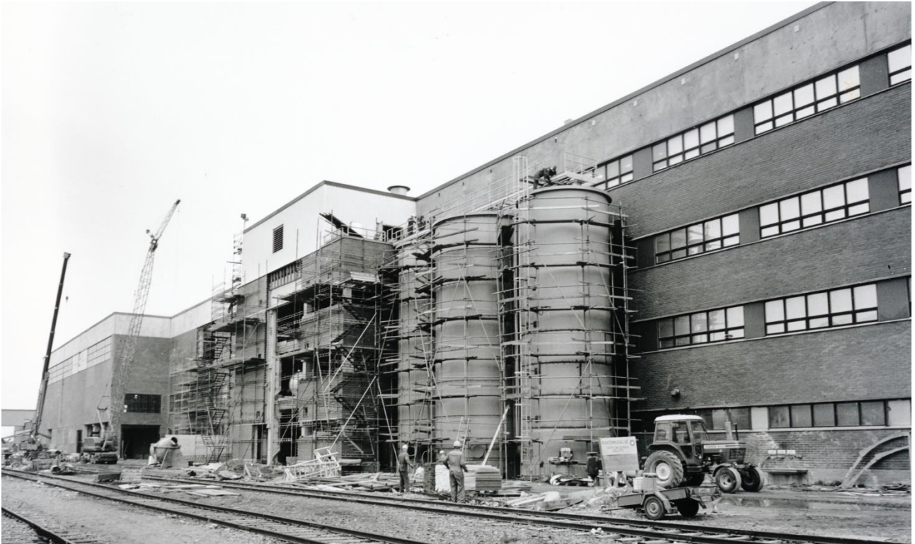
Kuva 194 Kaakkoisjulkisivulla PK1:n konesalin yhteyteen rakennettiin 1980-luvun lopulla laajennusosia. Ne näkyvät valmiina vuoden 1989 ilmakuvasa. Kuvassa vasemmalla näkyvä uusi ulkoneva rakennusosa peittää alkuperäisestä julkisivusta näkyneen jälkikäsitellyn osaston lounaisjulkisivun taakse. Myös kuvan keskivaiheilla näkyvä ulkoneva rakennusosa on uusi ja sen ympärillä on vielä rakennustelineet. Kuvan oikeassa laidassa näkyvän 1960-luvun lopulta olevan rakennusosan alkujaan pieniruutuiset ikkunat on uusittu. Kuvälähde: Kemin historiallinen museo / 883 (4282, 357/82) Paperikone yhden (PK1) rakennustyömaa 26.9.1982. Kuvaaja Mannelin, Helsinki.
