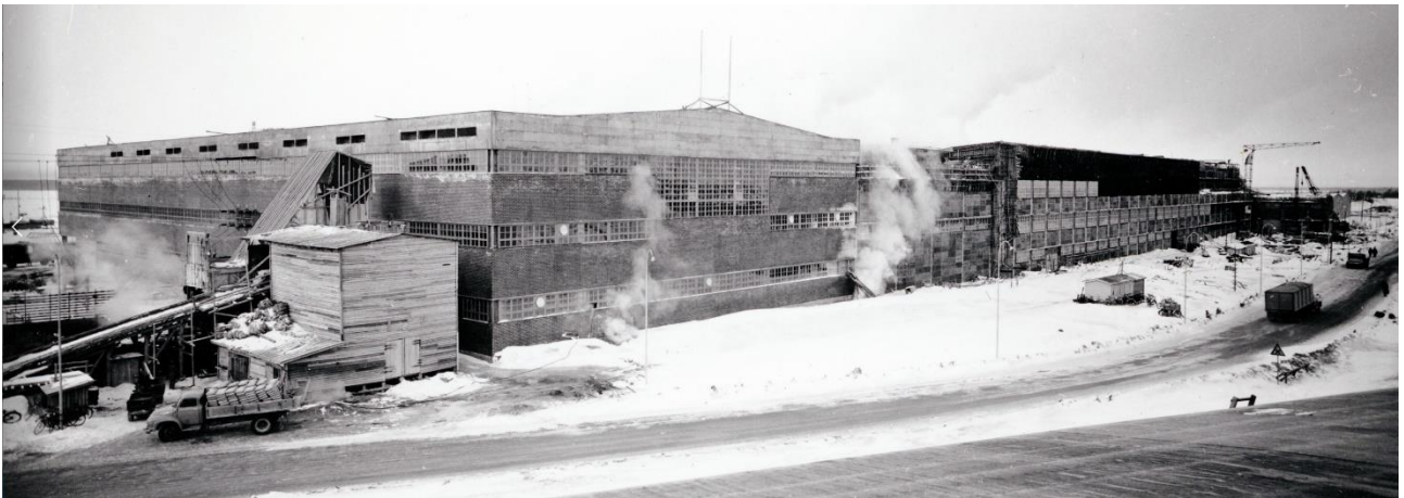
Kuva 188 Koillisesta. Puuhiomo kuvan vasemmassa reunassa on valmistumassa ja toinen konesali kuvan oikeassa reunassa on edelleen rakenteilla. Koillisjulkisivulla toinen konesali peittää taakseen paperitehtaan alkuperäiset julkisivut. Kuvälähde: Kemin historiallinen museo / 72 (1277, H5/61) Paperitehdas 28.3.1961. Kuvaaja Mannelin.
