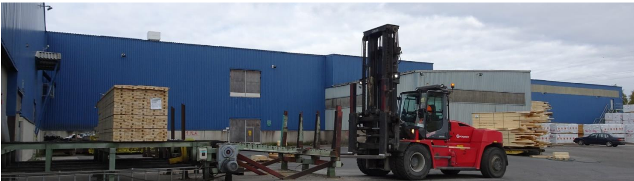
Kuva 146 Kuivaamon pohjoispuoleisia rakennusosia kuvattuna idästä. Keskellä näkyvä vaaleansininen siipi rakennettu 1970-luvun alkupuolella. Tummemman siniset osat on rakennettu 2000-luvun vaihteen tienoilla. Kuvälähde: FCG 2022
