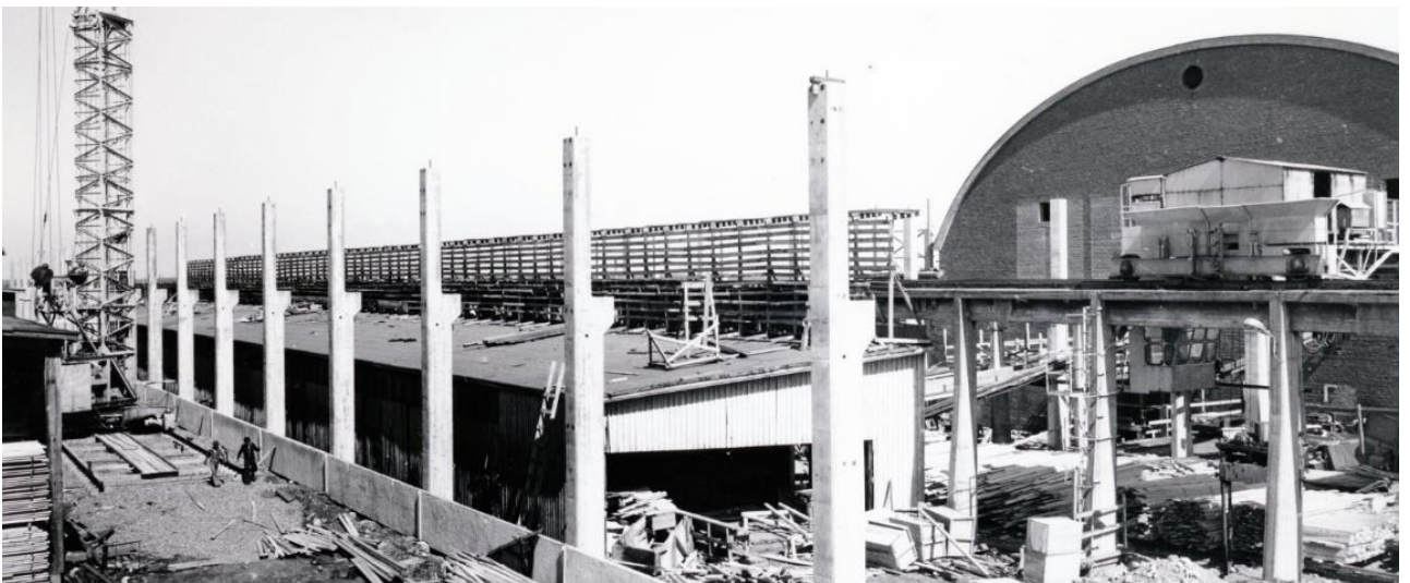
Kuva 131 Ote valokuvasta idästä. Sahan jälkikäsittelyosaston laajennusten rakentaminen on aloitettu. Kuvälähde: Kemin historiallinen museo / 233 (1151, 473/74) Sahan jälkikäsittely 9.6.1974. Kuvaaja Mannelin
