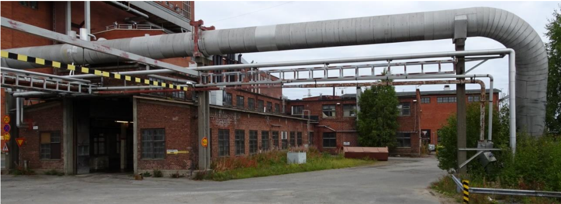
Kuva 104 Etelästä. Eteläpäädyn oviaukko on suurennettu. Pajasiiven alakerrassa on havaittavissa vieläkin alkuperäisen 1-kerroksisen siiven hahmo. Kuvälähde: FCG 2022
