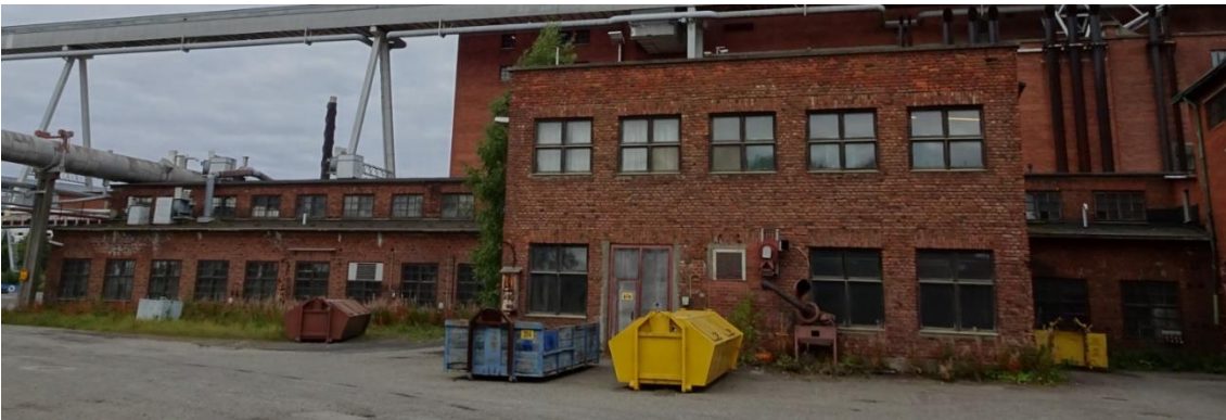
Kuva 105 Idästä. Pajasiiven ikkunat on uusittu ja niissä suuremmat ruudut kuin muualla rakennuksessa. Kuvälähde: FCG 2022
