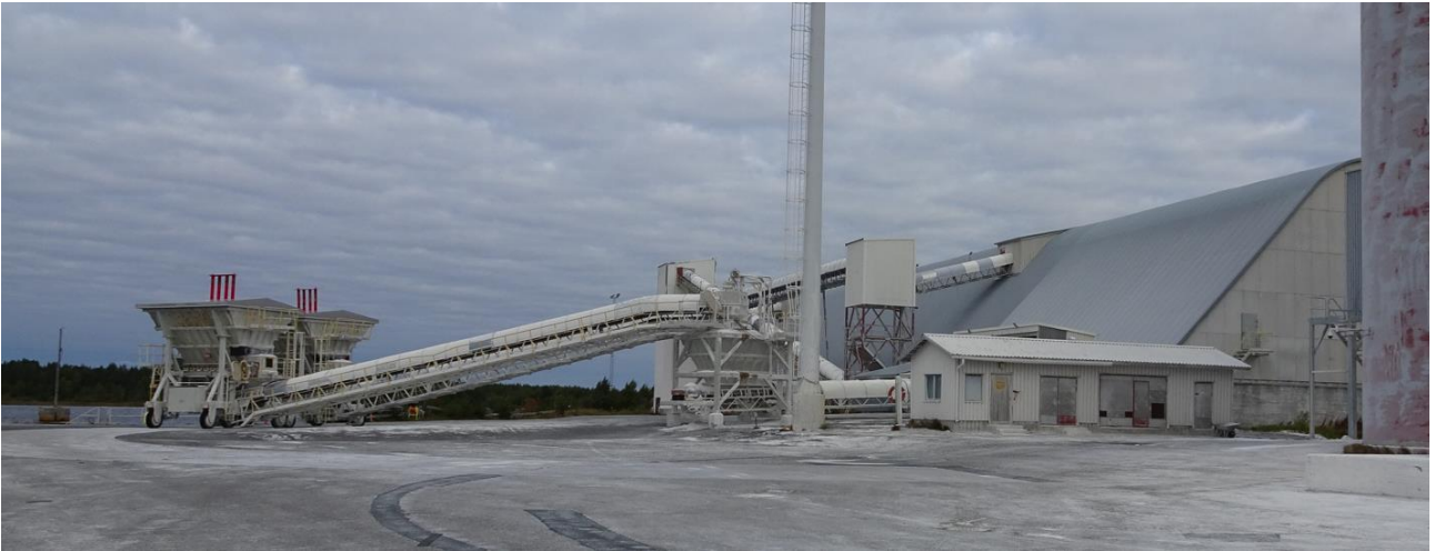
Kuva 262 Kaakosta. Pigmenttiaine on siirretty laivoista kuvassa näkyvillä kuljettimilla halliin varastoon. Kuvälähde: FCG 2022
