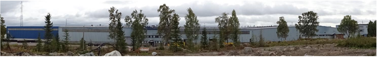
Kuva 148 Laajennuksen pohjoispään länsijulkisivu. Kuvan keskiosassa näkyy 2-kerroksinen toimisto-osa.
