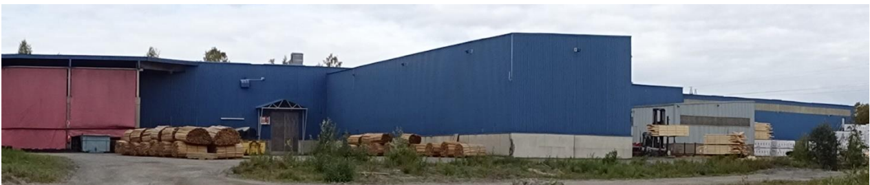
Kuva 145 Kuivaamon pohjoispuoleiset rakennusosat kuvattuna idästä. Kuvälähde: FCG 2022
