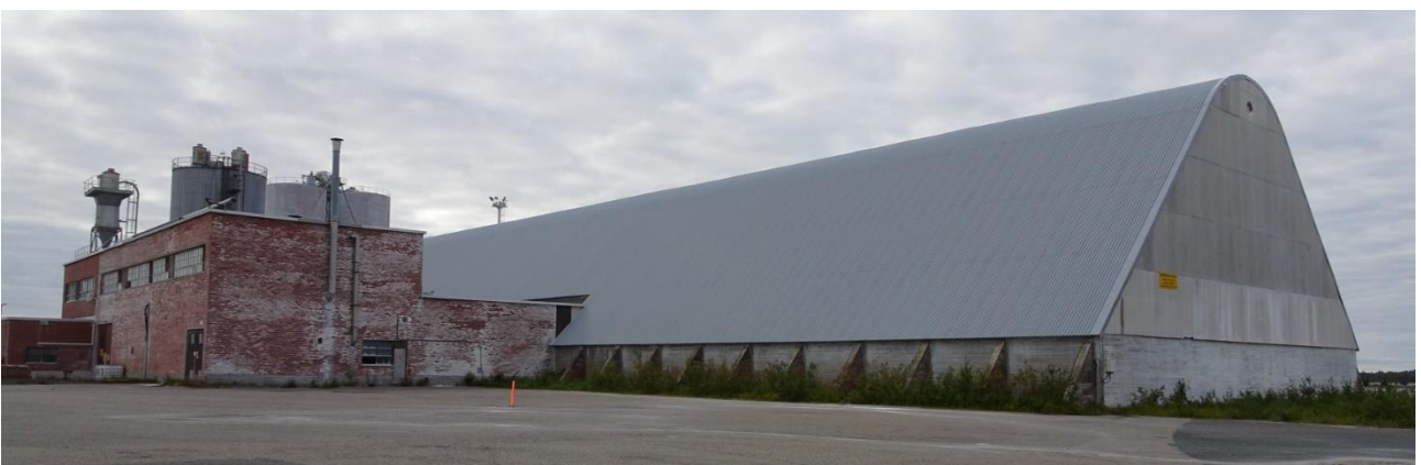
Kuva 261 Luoteesta. Betonisten tukikaarien alaosaat rytmittävät julkisivun alaosa.
