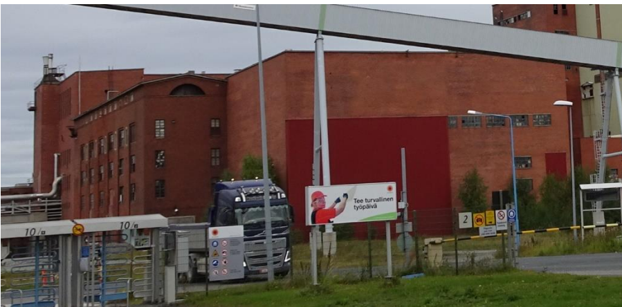
Kuva 43 Lounaasta. Keitto-osaston pääsyssä on kaareva ikkuna. Pesuosaston yhdyskohta 1980-luvulla purettuun spritehtaaseen on umpeutettu. Verhouksena on käytetty punaista profiilipeltiä. Kuvälähde: FCG 2022
