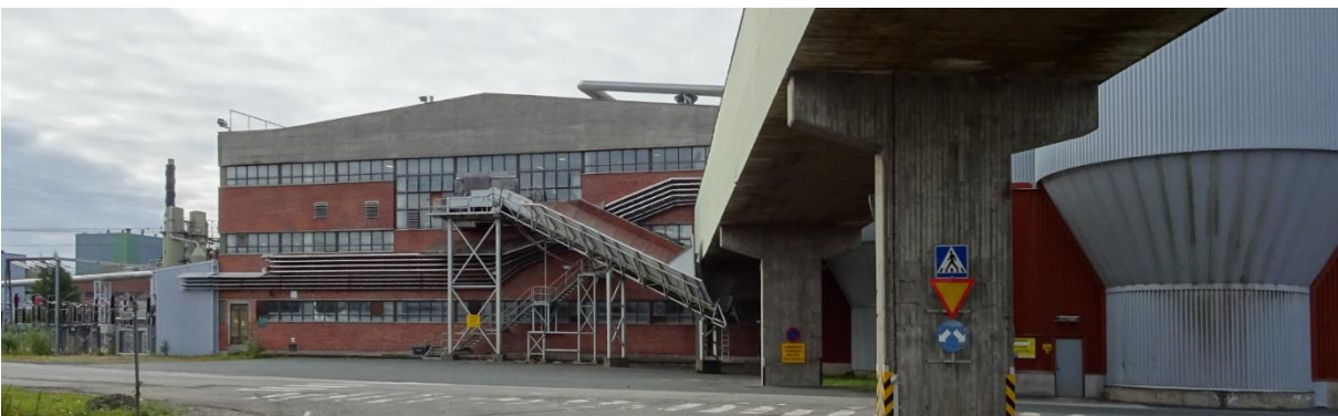
Kuva 204 Koillisjulkisivua. Vuonna 1961 valmistuneen puuhiomon pääty on koillisessa edelleen hyvin näkyvissä, vaikka julkisivun edessä on nykyisin erilaisia kuljettimia ja putkia. Kuvassa näkyy myös PK5:n rakennukselle johtava kuljetin ja sen betoniset kannatinpilareit. Kuvälähde: FCG 2022
