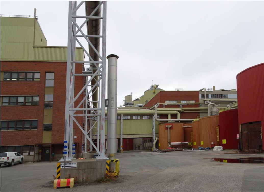
Kuva 325 Sulfaattiselluloosatehtaan rakennusten välinen kuja kaakosta. Rakennusten välillä on yhdyskäytävä. Kuvalähde: FCG 2022
