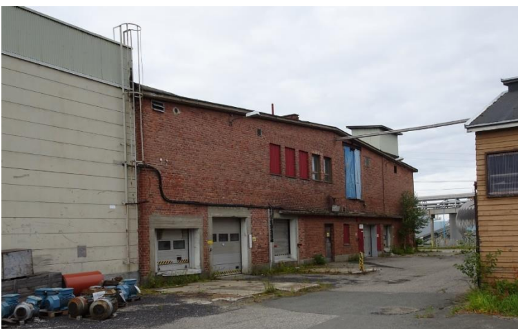
Kuva 165 Luoteesta. Alkuperäisen rakennusosan aukotuksia ja ovia on muutettu. Kuvälähde: FCG 2022
