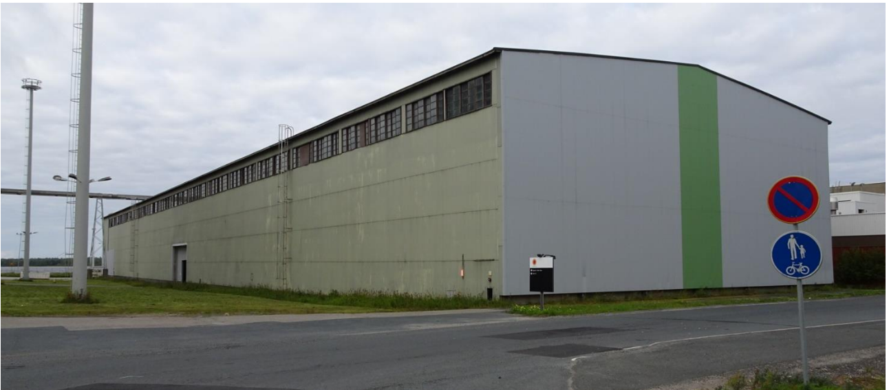
Kuva 255 Hallin koillispäätä on lyhennetty tielinjauksen muututtua. Pääty on verhoiltu vaaleanharmaalla pellillä, keskellä vihreä pystyraita. Kuvälähde: FCG 2022
