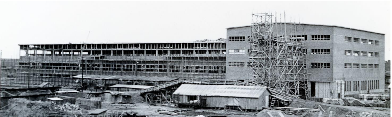
Kuva 180 a Etelästä vuonna 1953. Paperitehdasta rakennetaan. Kuvan oikeassa laidassa jauhatusosasto ja vasemmassa paperikonesali. Kuvälähde: Kemin historiallinen museo / 68 (2718) Paperitehdas 10.11.1953. Kuvaaja Mannelin.
