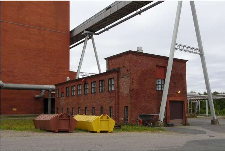
Kuva 120 Lounaasta. Alkujaan kuorimon eteläjulkisivun keskellä on ollut iso ikkuna ja ovi pienessä syvennyksessä. Ikkunaa on myöhemmin pienennetty ja oven viereen on tehty isompi oviaukko. Kuvälähde: FCG 2022
