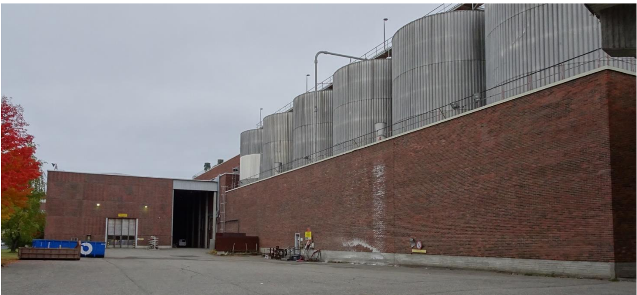
Kuva 298 Koneistamon kaakkoispäätty ja paperitehdas PK5:n säiliöitä lounaisjulkisivun itäpäässä. Kuvälähde: FCG 2022
