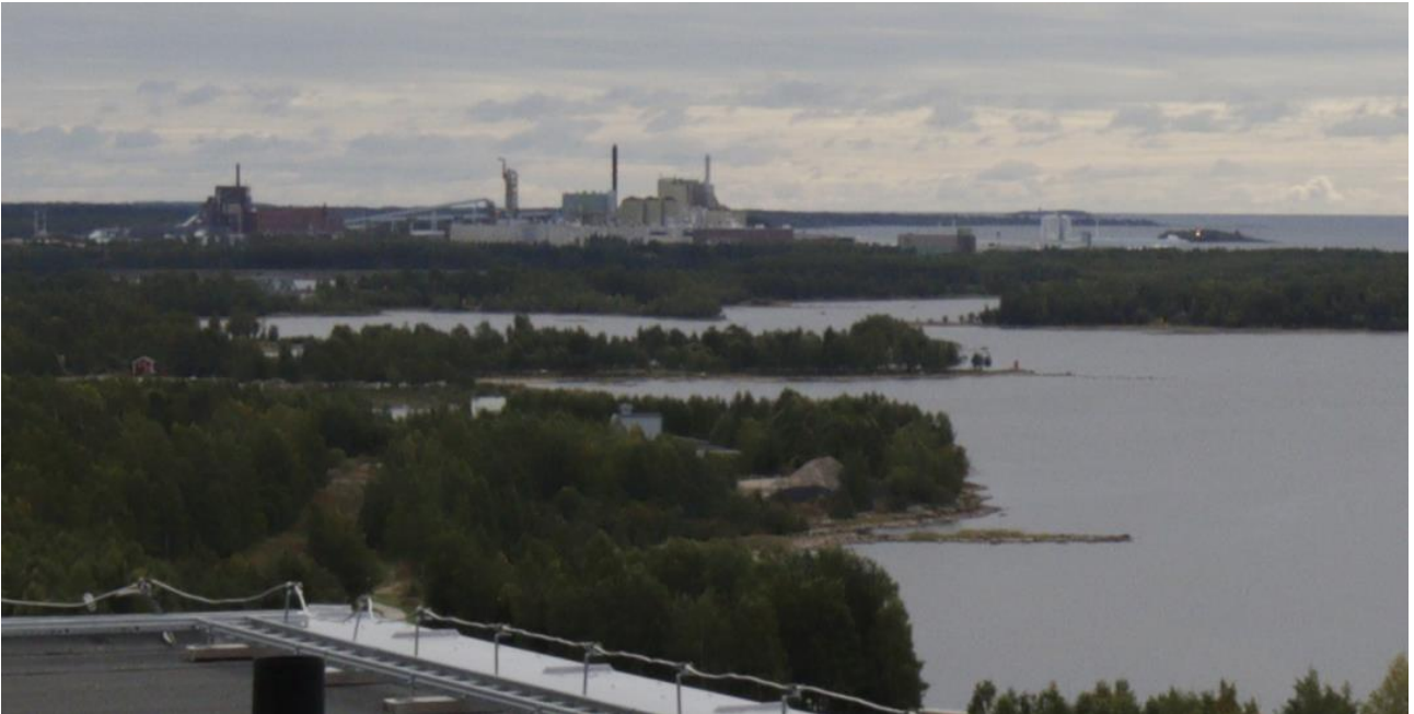
Kuva 18. Näkymä Veitsiluotoon Kemin keskustasta kaupungintalon katolta. Veitsiluodon rakennuksista kuvassa vasemmalla näkyy voima-asema ja sulfiittisellutehdas. Niiden oikealla puolella näkyy sulfaattisellutehtaan Kamyri-keittimen torni. Korkein torni ja sen edessä näkyvä rakennus kuuluvat uuteen voimalaitokseen. Oikeanpuolimmaisat korkeat rakennukset ja säiliöt kuuluvat sulfaattiselluloosatehtaaseen.
