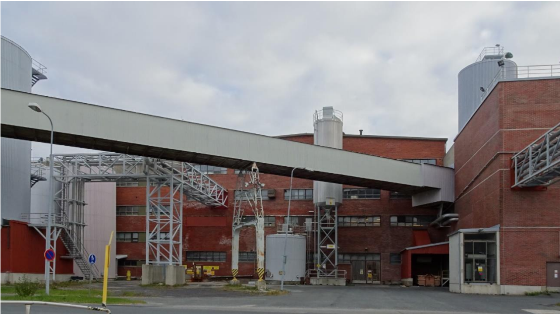
Kuva 200 Lounaisjulkisivua luoteesta. Keskellä kuvaa oleva harjakattoinen osa on alkuperäisen paperitehtaan jauhatusosaston pääty. Se on ainoa alkuperäisestä paperitehtaasta yhä näkyvillä oleva julkisivu. Kuvan oikeassa reunassa näkyy 2000-luvun taitteessa tehty laajennusosa.
