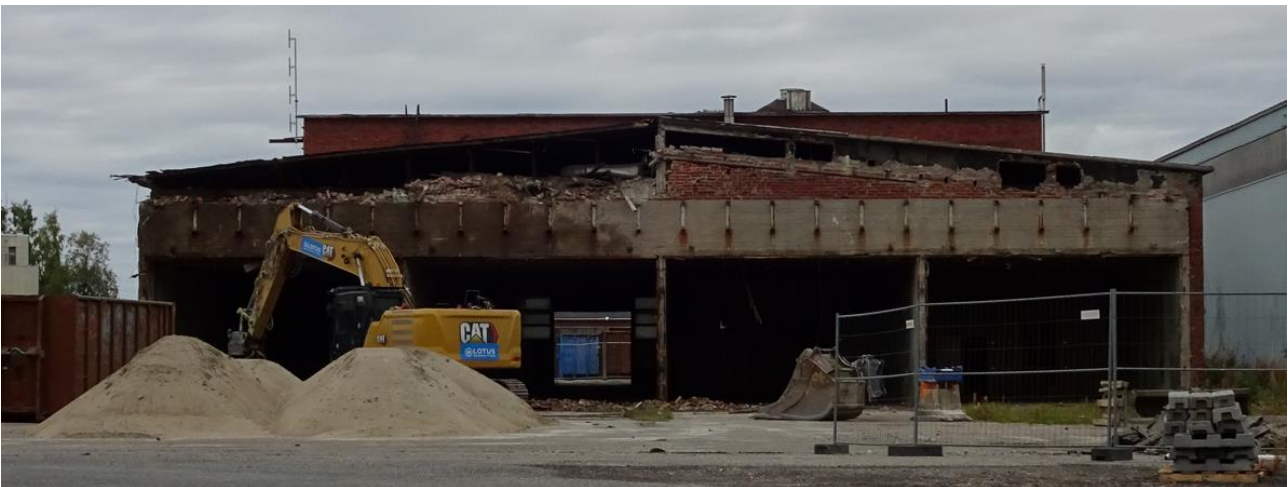
Kuva 159 Purkamisen on aloitettu rakennuksen eteläpäästä. Kuvälähde: FCG 2022
