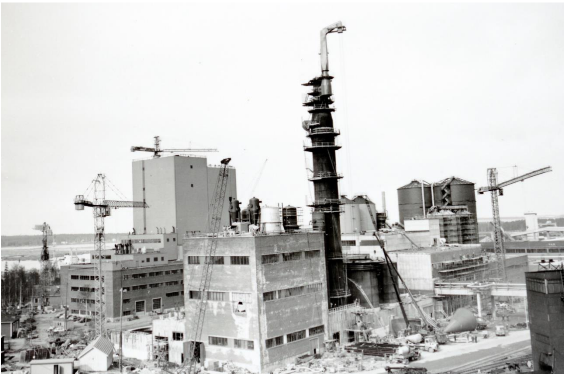
Kuva 306 Sulfaattiselluloosatehtaan rakennustyömaa koillisesta 1977. Etualalla näkyy kuitulinjan rakennus ja Kamyrr-keitin sekä takana lipeälinjan rakennus. Kuvälähde: Kemin historiallinen museo / 2712 (1285) SA-tehtaan rakennustyömaa 20.5.1977.
