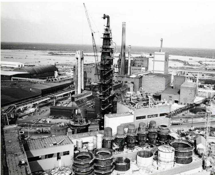
Kuva 308 Sulfaattiselluloosatehtaan rakennustyömaa lännestä 1977. Kamyri-keitin ja höyrykattilat ovat rakenteilla. Taustalla näkyy sulfiittisellutehdas, voima-asema ja sahan kaarikattoinen rakennus. Kuvälähde: Kemin historiallinen museo / 682 (2939) Veitsiluodon tehdas 5.7.1977. Kuva Mannelin, Helsinki
