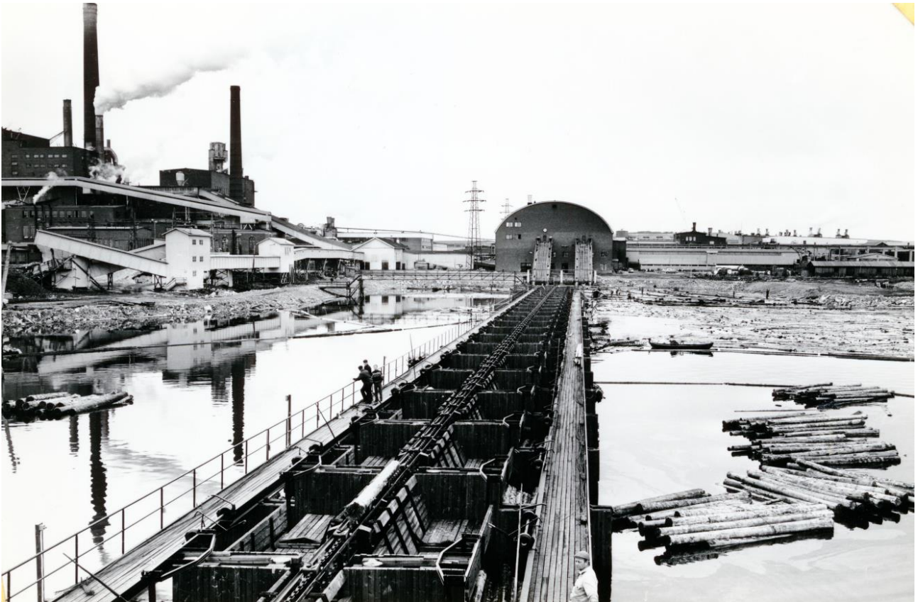
Kuva 132 Ote valokuvasta arviolta 1970-luvun alkupuolelta. Sahan oikealla puolella kuvassa näkyy jälkikäsitteilyosaston ensimmäisen rakennusvaiheen rakennuksia. Tukkeja kuljetettiin edelleen sahalle uittamalla. Kuvan vasemmassa reunassa näkyy voima-aseman ja sulfiittisellutehtaan rakennuksia sekä tehdaskompleksin eri osia yhdistäviä kuljettimia. Kuvälähde: Kemin historiallinen museo /358 (2389, TM 27/69) Veitsiluodon saha vuonna 1969(?). Kuvaaja Mannelin.
