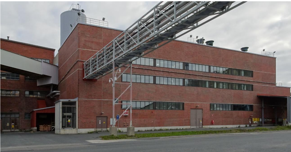
Kuva 201 Lounaisjulkisivun itäpää etelästä. 2000-luvun alussa rakennettiin tiilipintaisilla elementeillä verhoiltu laajennus puuhiomon lounaispäättyyn.
