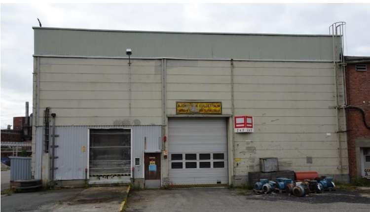
Kuva 167 Laajennusosan luoteispää. Kuvälähde: FCG 2022
