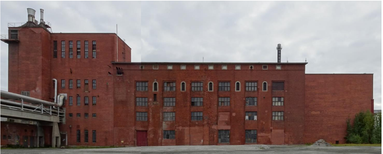
Kuva 42 Keskellä sulfittisellutehtaan alkuperäinen keitto-osasto lännestä kuvattuna. Kuvan vasemmassa reunassa vuonna 1959 valmistunut keitto-osaston laajennus valkaisuosaston yhteydessä. Kuvan oikeassa reunassa näkyy pesuosasto vuodelta 1962. Kuvälähde: FCG 2022
