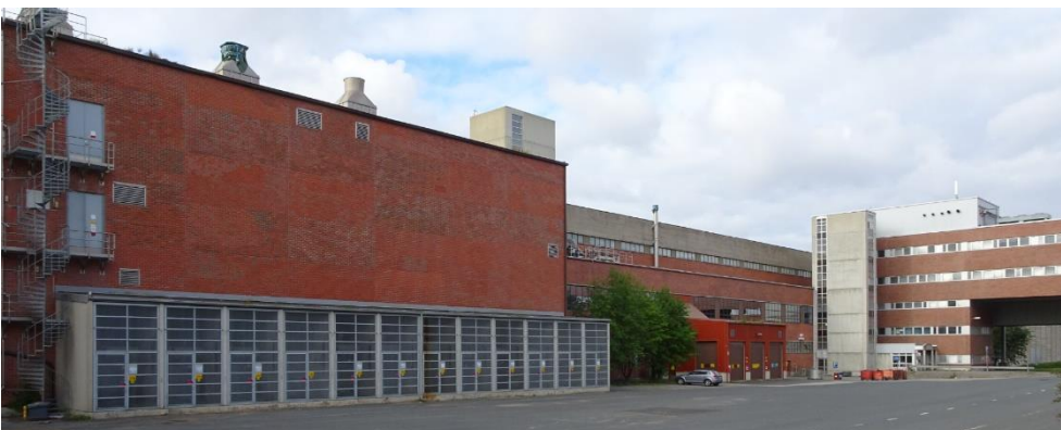
Kuva 207 Koillisjulkisivua. PK2:n ja PK3:n paperikonesalin koillisjulkisivun keskelle on tehty pieni laajennus myös 2000-luvun alussa. Se on verhoiltu tiilipintaisilla betonielementeillä. Kuvälähde: FCG 2022
