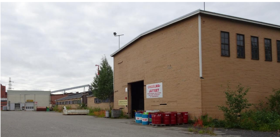
Kuva 176 Pohjoisesta. Varasto etualalla. Kuvälähde: FCG 2022
