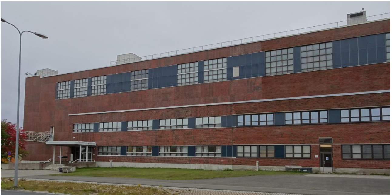
Kuva 294 Lounaisjulkisivun länsipääty. Ikkunoiden välit on verhoiltu sinisellä rakennuslevyllä. Kuvan oikeassa reunassa näkyy PK5:n alkuperäistä rakennusosaa, jonka julkisivu on verhoiltu puhtaaksi muuratulla tiilellä. Kuvan vasemmassa laidassa näkyvä laajennus erottuu alkuperäisestä rakennusosasta lähinnä verhoilunsa puolesta. Se on verhoiltu tiilipintaisilla betonielementeillä. Ikkunat jatkavat alkuperäisen rakennusosan ratkaisua. Kuvälähde: FCG 2022
