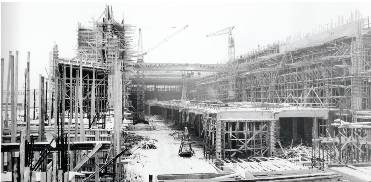
Kuva 186 Toista konesalia paperikoneille 2 ja 3 (PK2, PK3) rakennetaan vuonna 1960. Kuvälähde: Kemin historiallinen museo / 446 (3710, B4) Paperitehdas 25.11.1960. Kuvaaja Teollisuuskuvaamo Mannelin, Helsinki.
