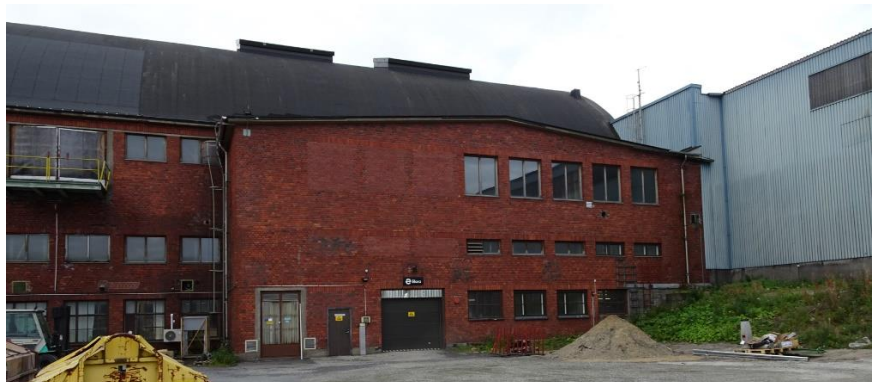
Pyöreä ikkuna pohjoisjulkisivun 1-kerroksessa. Kuvälähde: FCG 2022
