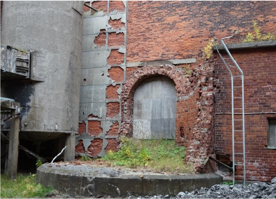
Kuva 90 Sulfiittiselluloosatehtaan voima-aseman piipun perustus on edelleen nähtävissä 1950-luvulla rakennetun laajennuksen länsipuolella. Kuvälähde: FCG 2022
