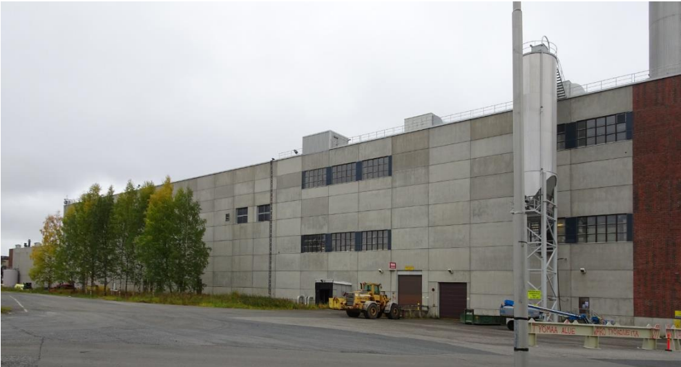
Kuva 301 Koillisjulkisivun länsipää on verhoiltu betonielementeillä. Julkisivu on osa päällystyskonetta ja jälkikäsitteilytiloja varten tehtyä laajennusta. Kuvälähde: FCG 2022
