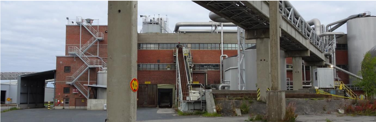
Kuva 202 Kaakkoispääty. Vasemmalla 2000-luvun taitteessa rakennettu laajennus, kuvan keskellä näkyy vuonna 1961 valmistunutta puuhiomoa nauhaikkunoineen. Kuvälähde: FCG 2022
