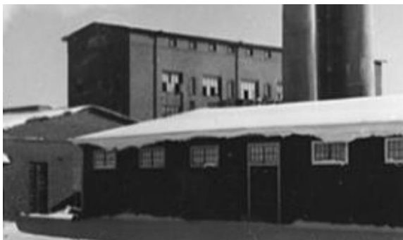
Kuva 59 Ote valokuvasta 1930-luvulta. Nykyisen betonielementtisen selluvaraston paikalla on aikaisemmin ollut puurakentein pienempi varasto. Kuvälähde: Lusto–Suomen metsämuseo, Suomen Metsäyhdistyksen kokoelma/ Metsätaloudellinen Valistustoimisto V91002:6499 / Veitsiluoto Oy:n sellutehdas, 1930-luku, valokuvaaja Mauno Mannelin
