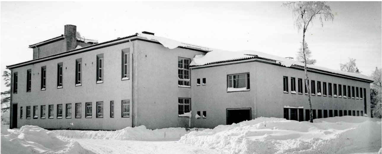
Kuva 215 Laajennuksen ikkunoiden smyygit ovat olleet myös tummat. Itäsvun keskivaiheilla alun perin ollut ulko-ovea ei enää ole. Kuvälähde: Kemin historiallinen museo / 652 (455, 30/52) Pääkonttori vuonna 1952. Kuvaaja Teollisuuskuvaus Mannelin, Helsinki.//
