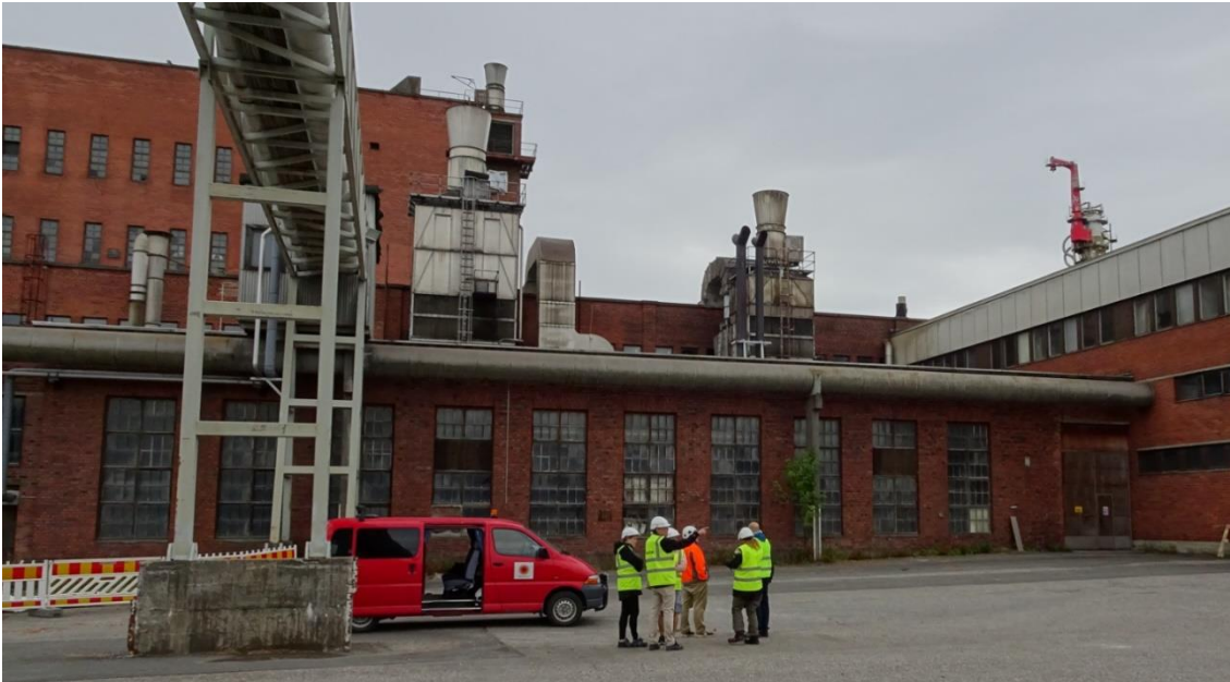
Kuva 55 Julkisivu pohjoiseen. Vuonna 1930 valmistuneen osan ikkunoissa on pienet ruudut. Kuvälähde: FCG 2022
