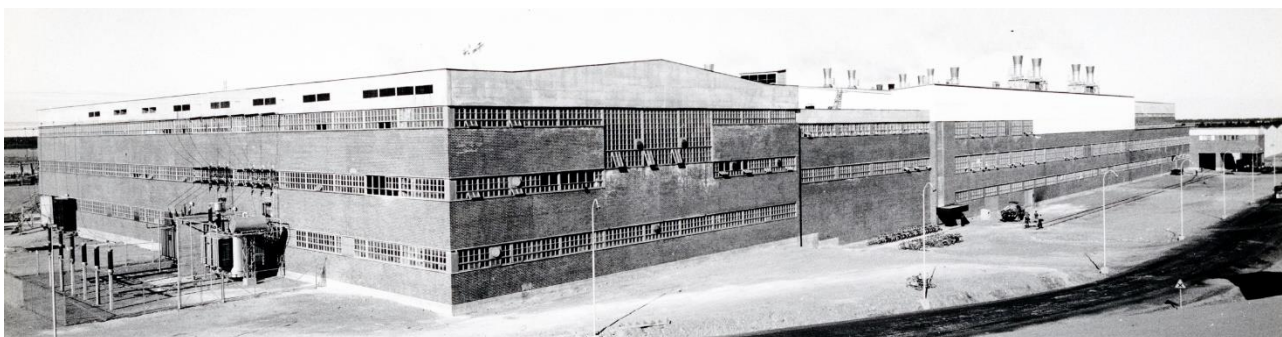
Kuva 190 Idästä vuonna 1963. Vasta valmistuneet puuhiomo ja paperikoneiden PK2 ja PK3 konesali. Konesali on rakennettu alkuperäisen paperitehtaan kylkeen sen koillisjulkisivulle. Se peittää taakseen paperitehtaan alkuperäisen koillisjulkisivun. Kuvälähde: Kemin historiallinen museo / 2320 (2686, TA 6/63) Veitsiluodon paperikone 3:n (PK 3) rakennus 5.7.1963. Kuvaaja Teollisuuskuvauus Mannelin, Malmi
