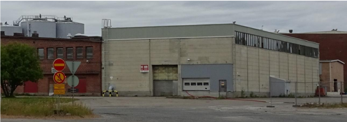
Kuva 166 Alkuperäisen höyläämön koillispuolelle on rakennettu betonielementtirakenteinen koko alkuperäisen rakennuksen mittainen laajennus. Kuvälähde: FCG 2022
