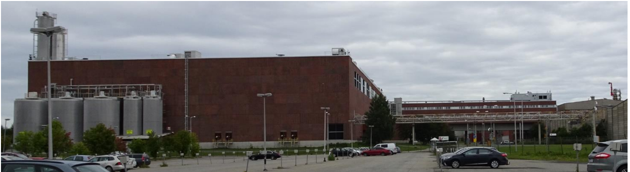
Kuva 293 Luoteispääty. Kuvan oikeassa reunassa näkyy Paperitien ylle 1990-luvun alussa tehty toimisto- ja laboratorio-osa, joka yhdistää paperitehtaan kaksi rakennusta. Kuvälähde: FCG 2022
