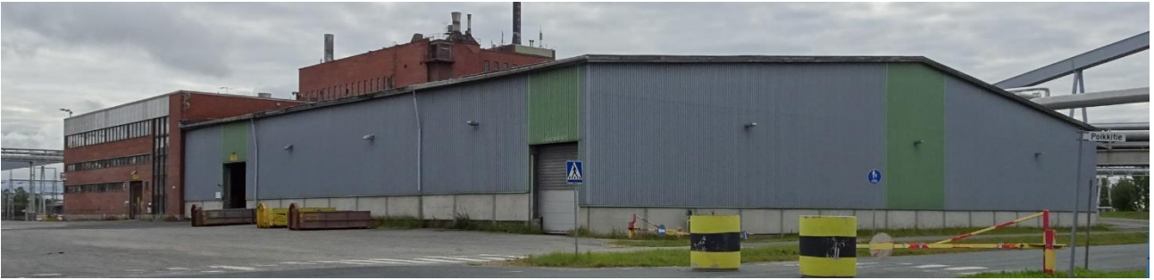
Kuva 64 Luoteesta. Selluloosavaraston ulkoverhous on uusittu 1970-luvun jälkeen. Nykyinen profiilipeltiverhous vaikuttaa olevan 2000-luvun taitteesta. Nauhaikkunat on peitetty. Kuvälähde: FCG 2022
