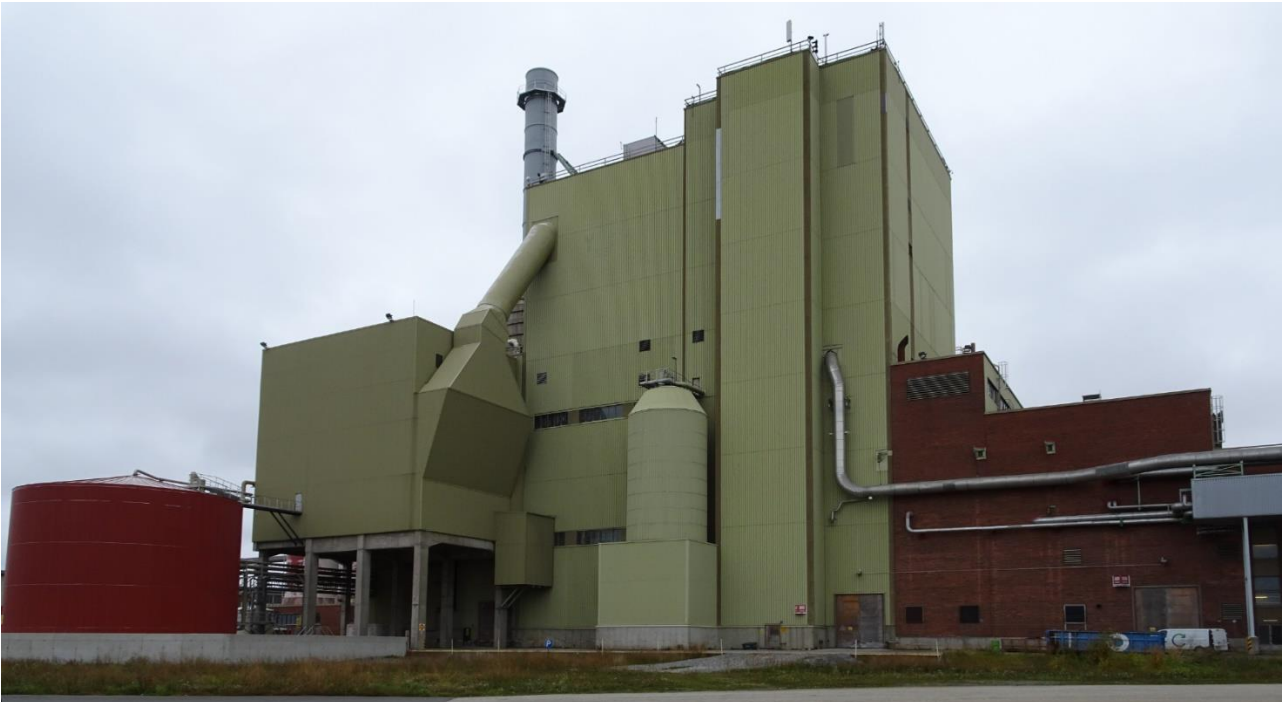
Kuva 321 Soodakattilarakennuksen luoteissivu etelästä. Kuvälähde: FCG 2022
