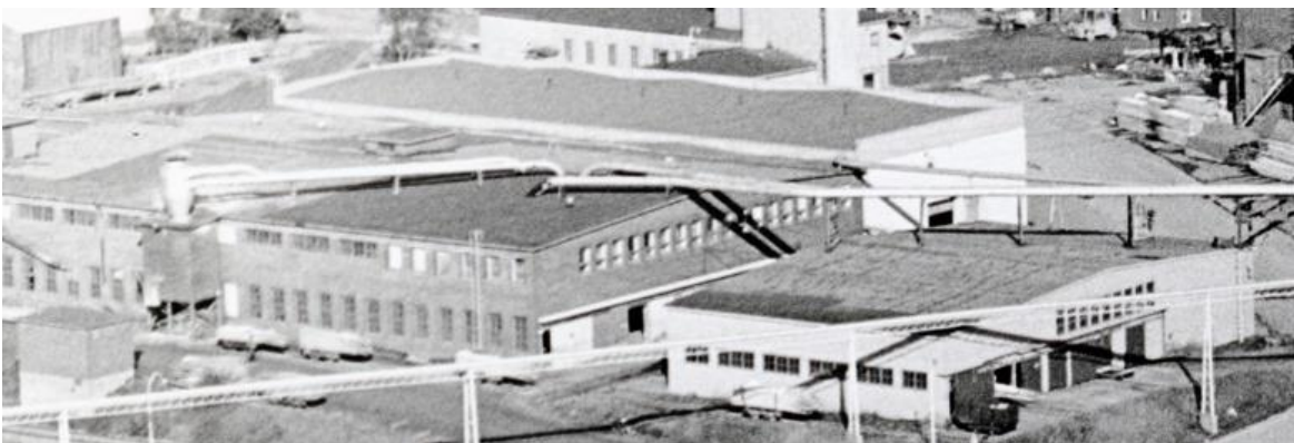
Kuva 162 Ote valokuvasta vuodelta 1975 etelästä. Alkuperäisen höyläämön koillispuolelle on rakennettu betonielementeistä laajennus. Osa lounaisjulkisivun yläikkunoista on muutettu korkeammiksi. Kuvälähde: Kemin historiallinen museo / 128 (154) Mekaaninen jälkipää vuonna 1975. Kuvaaja: J. Sauvola.
