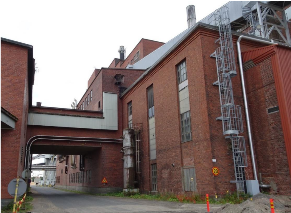
Kuva 86 Voima-aseman ja korjauspajan välinen yhdyskäytävä. Yhdyskäytävän oikealla puolella näkyvän 1920-luvun lopun laajennuksessa ikkunat ovat sijainneet symmetrisesti hieman sisäänvedettyinä muusta julkisivusta. Räystään alla on tiilistä muurattu porrastus. Kuvälähde: FCG 2022
