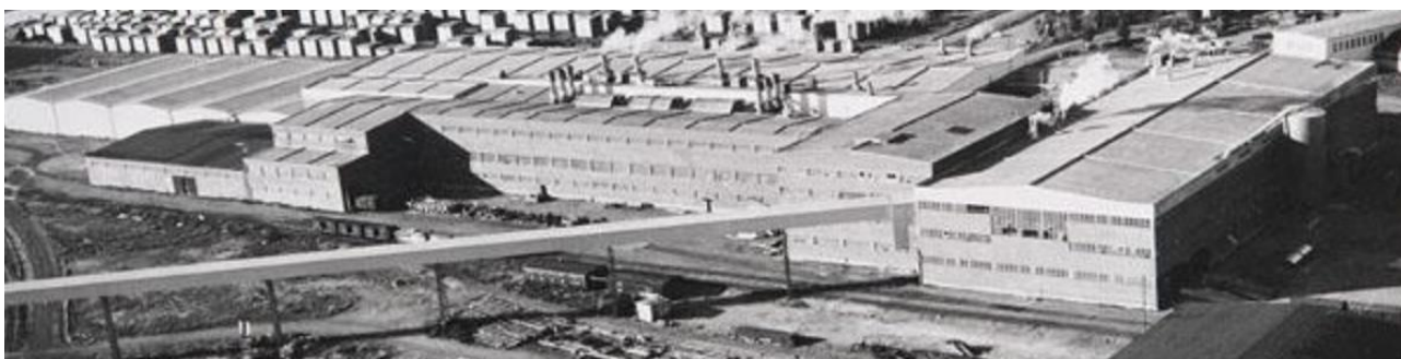
Kuva 191 Ote ilmakuvasta etelästä 1966. Lounaispuolen julkisivun keskiosassa on vielä näkyvässä alkuperäisen paperitehtaan julkisivu. Kuvan oikeassa laidassa puuhiomo, sen vasemmalla puolella jauhatusosasto, sen vasemmalla puolella alkuperäinen konesali (PK1) ja sen vasemmalla puolella muusta rakennusmassasta ulkoneva jälkikäsitteilyosasto. PK1:n takana näkyy PK2:n ja PK3:n konesali sekä sen vasemmalla puolella paperivarasto. Kuvälähde: Lusto – Suomen metsämuseo, Metsäteollisuus ry:n kokoelma V96022:3920 / Veitsiluoto Oy:n paperitehdas Kemin Veitsiluodossa ilmasta kuvattuna, valokuvaaja teollisuuskuvaamo Mannelin, 1966.
