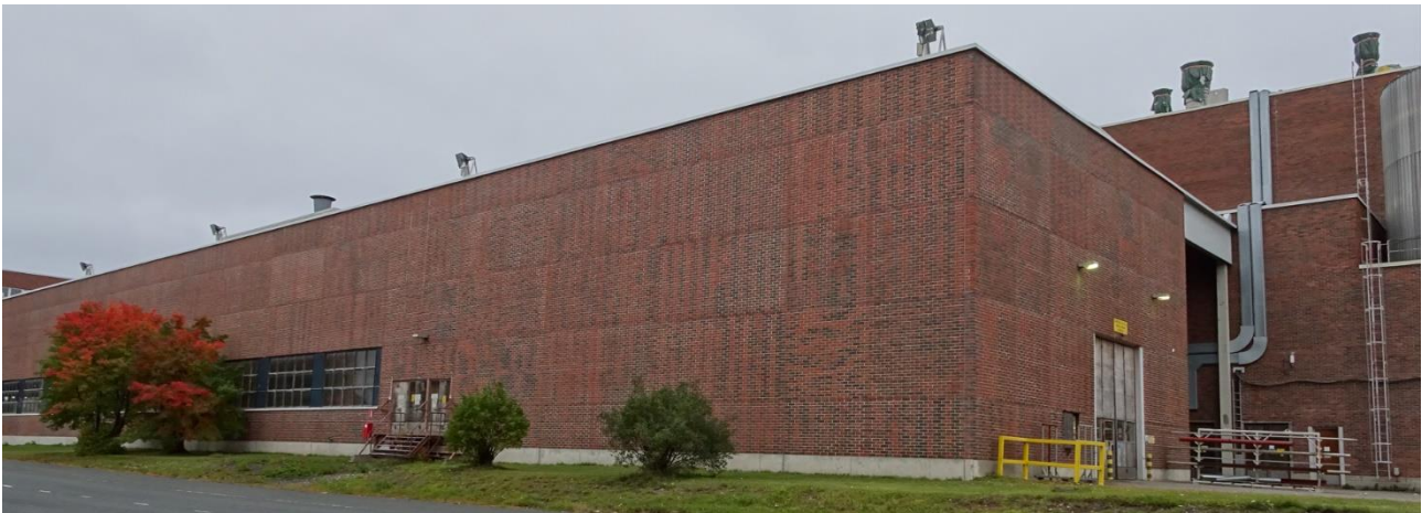
Kuva 297 Lounaisjulkisivun keskiosaa koneistamon kohdalla. Kuvälähde: FCG 2022
