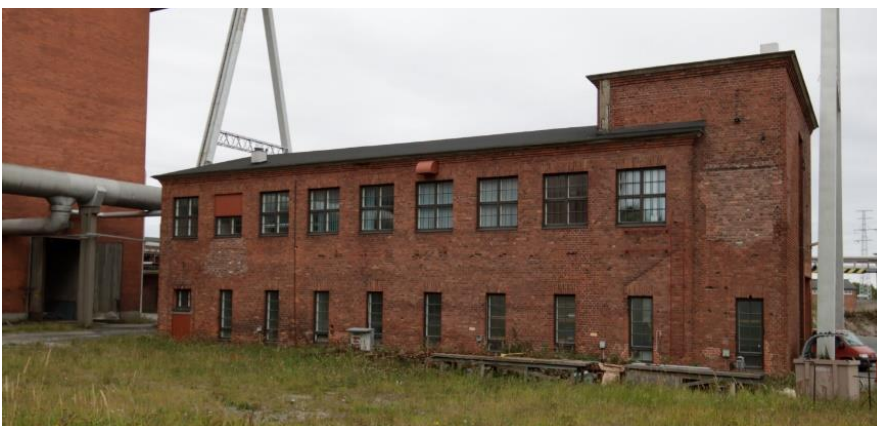
Kuva 119 Länneestä. Kuvassa oikeassa reunassa näkyy umpeutettu kuljettimen aukko. Kuvälähde: FCG 2022
