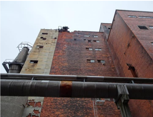
Kuva 91 (Vasemmalla) 1950-luvulla rakennetun laajennuksen länsijulkisivu. Luoteisnurkka on päällystetty vaalealla rakennuslevyllä. Kuvälähde: FCG 2022
