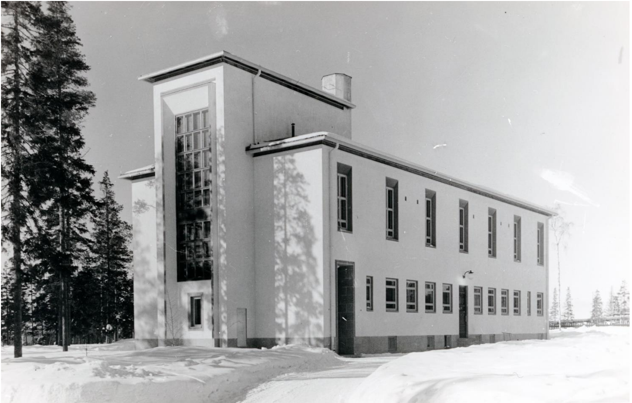
Kuva 213 Vaaleiden ikkunoiden smyygejä on korostettu julkisivua reilusti tummemmalla sävyllä. Päädyn tumman ikkunan smyygit ovat vaaleat, mutta smyygikehyksen etu- ja ulkoreunat ovat tummat. Myös räystäään alapinnat ovat tummat. Sisennetty kapea ja korkea pääsisäänkäynti on verhoiltu kivilaatoilla. Kuvälähde: Kemijoki historiallinen museo / 661 (3305) Pääkonttori vuonna 1936. Kuvaaja M. Mannelin, Helsinki.
