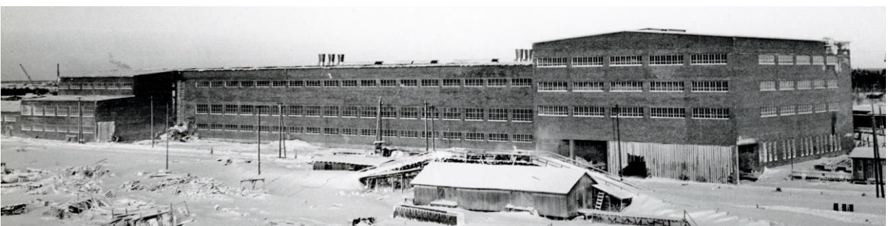
Kuva 182 Paperitehtaan lounaisjulkisivu arviolta 1950-luvun puolella välissä. Ikkunat ovat nauhamaisia, pienistä ruuduista koostuvia vaakaikkunoita. Kuvälähde: Kemin historiallinen museo / 501 (2724) Paperitehdas. Kuvaaja Kemin Kuvaamo.
