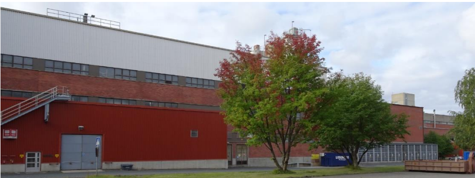
Kuva 206 Koillisjulkisivua. Kuvassa vasemmalla näkyy 1980-luvulla tehty laajennus. Sen edessä on 2000-luvun alussa rakennettu matala laajennus, joka on verhoiltu punaisella profiilipellillä. Kuvälähde: FCG 2022
