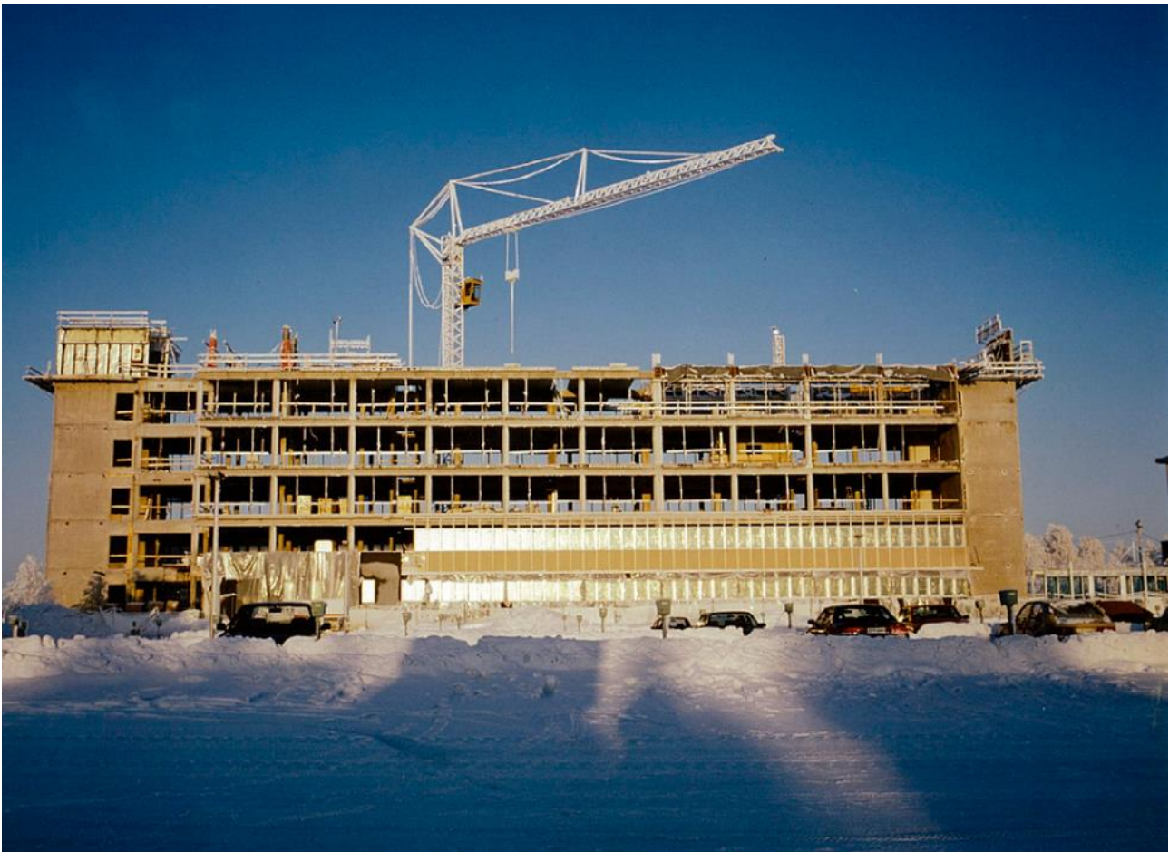
Kuva 264 Keskuskonttoria rakennetaan talvella 1994. Kuvälähde: Rakennusliike M. Kurtti Oy, https://www.lapinkansa.fi/lapin-perinteikkain-rakennusliike-on-kokenut-monta/2638228
