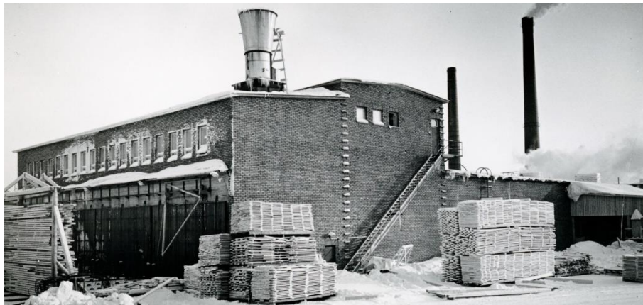
Kuva 152 Länsijulkisivua jäsentää korkeimman osan nurkkia korostavat ulkonevat tiilimuuraukset. Kuvälähde: Kemin historiallinen museo /1501 (440,58/53) Entinen Veitsiluodon piirustuskontori vuonna 1953. Kuvaaja Teollisuuskuvaus M. Mannelin, Malmi.
