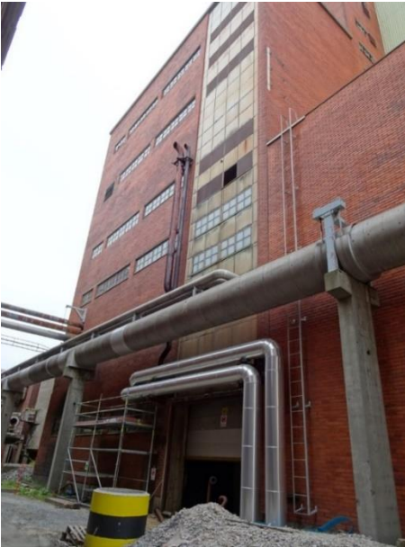
Kuva 93 Vuonna 1961 valmistuneen laajennuksen länsijulkisivussa on nauhamaisia ikkuna-aukkoja sekä lounaiskulmassa vaalealla levyllä päällystetty pystyosuus. Kuvälähde: FCG 2022
