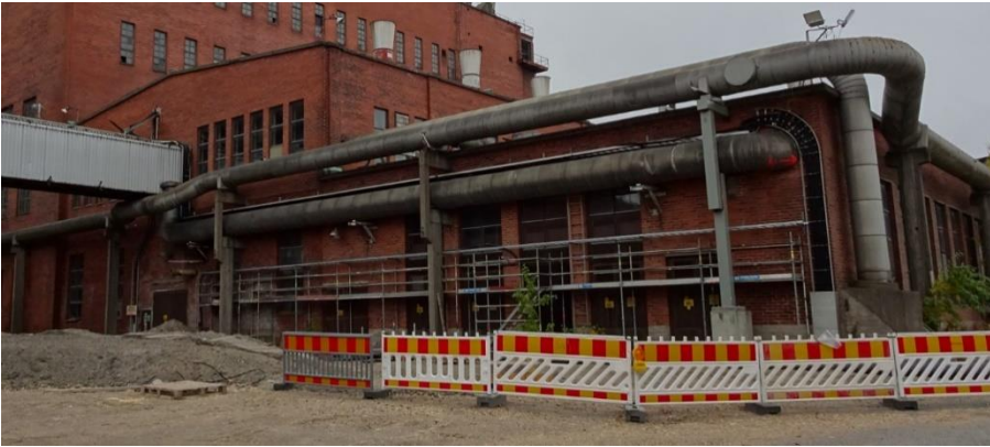
Kuva 53 Kuivauskonesalin pääty itään. Kuivaussalin harjakattoinen osa korotettiin vuonna 1959 2-kerroksiseksi. Sen pohjoispuolista matalaa tasakattoista siipiosaa jatkettiin 1950-luvulla koilliseen. Päädyn ikkunat peittyvät putkilinjastojen taakse. Kuvälähde: FCG 2022
