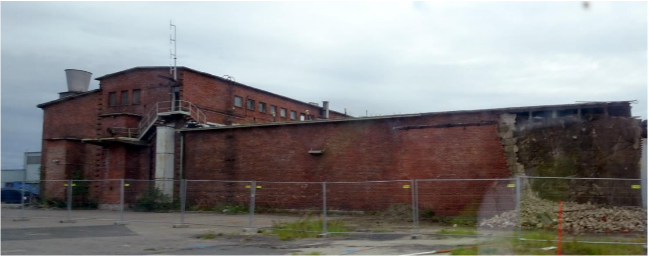
Kuva 156 Julkisivu länteen. Tiilimuurauksessa näkyy vielä, missä katos on sijainnut. Kuvälähde: FCG 2022
