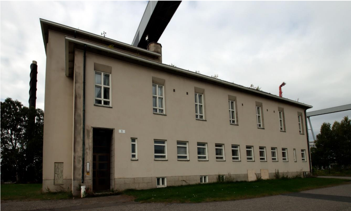
Kuva 219 Itään. Pääovi sijaitsee kapeassa ja korkeassa syvennyksessä, joka on verhoiltu vastaavilla kivilaatoilla kuin rakennuksen kivijalka. Kuvälähde: FCG 2022
