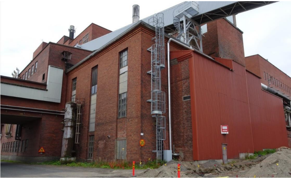
Kuva 87 Alkuperäinen sahan voima-asema vuodelta 1922 on purettu ilmakuviin perusteella 1990-luvun puolivälissä lähes kokonaan. Siitä on jätetty vain kapea siivu jäljelle. Siivun pääty on verhoiltu profiilipellillä. Koristeellinen räystäään alunen on ilmeisesti ollut betonista valettu ja sen profiili on edelleen nähtävissä. Kuvälähde: FCG 2022
