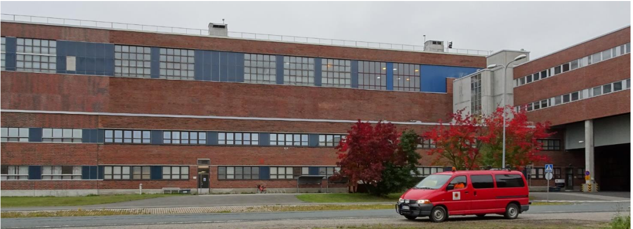
Kuva 295 Lounaissivun keskiosa toimisto- ja laboratoriosivun länsipuolella. Kuvälähde: FCG 2022
