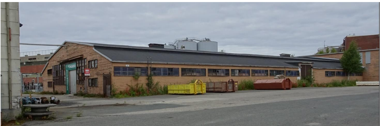
Kuva 175 Kokoonpanohalli kaakosta. Koillissivulle on lisätty sivuseinää korkeampi ovi. Kaakkoispäädyn ovi on uusittu. Kuvälähde: FCG 2022
