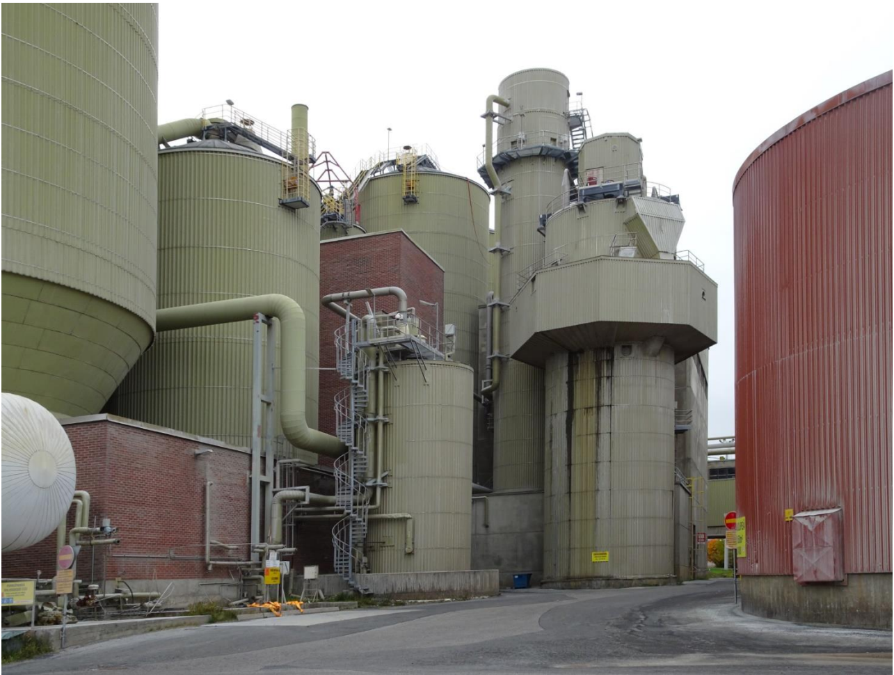
Kuva 318 Idästä. Sulfaattisulutehtaan rakennusten välissä olevalle kujalle on lisätty säiliöitä arviolta 1990-luvulla (kuvassa oikean puolimmaisiet vihreät säiliöt). Kuvälähde: FCG 2022
