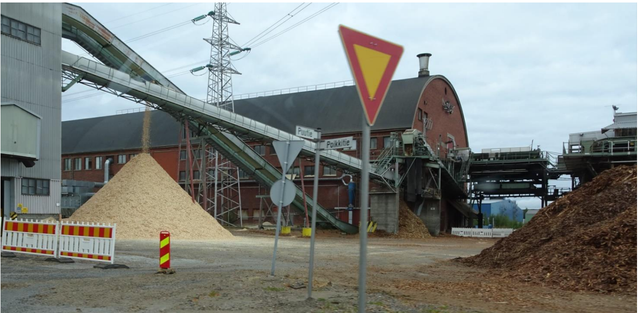
Kuva 136 Kaakosta sahan eteläjulkisivua ja itäpäätä. Kuvälähde: FCG 2022
