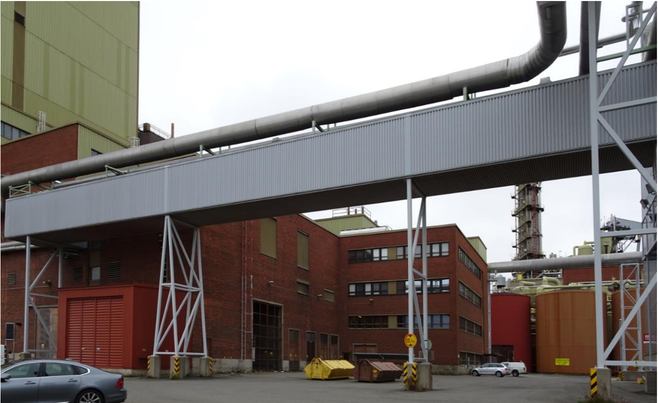
Kuva 323 Soodakattilarakennuksen kaakkoispää etelästä. Kuvälähde: FCG 2022
