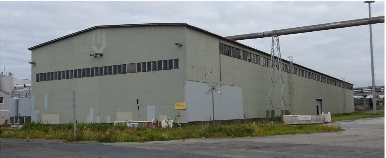
Kuva 254 Hallin lounaispäädyssä vielä näkyvissä Veitsiluoto Oy:n logon tausta. Vanhoja kulkuaukkoja on umpeutettu vaaleanharmaalla pellillä. Kuvälähde: FCG 2022
