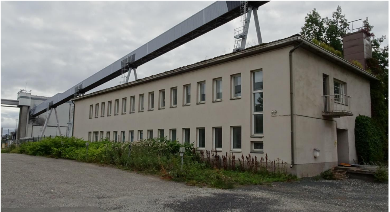
Kuva 221 Pohjoiseen. Laajennuksen ikkunat ovat pääosin kapeahkoja yksiruutuisia. Portaikossa on kolmeruutuinen korkea ikkuna. Kuvälähde: FCG 2022
