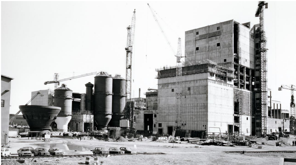
Kuva 303 Sulfaattiselluloosatehtaan rakennustyömaa lännestä vuonna 1976. Kuvan oikeassa reunassa sellutehtaan lipeälinjan rakennus. Kuvälähde: Kemin historiallinen museo / 681 (2938) Veitsiluodon tehdasta.
