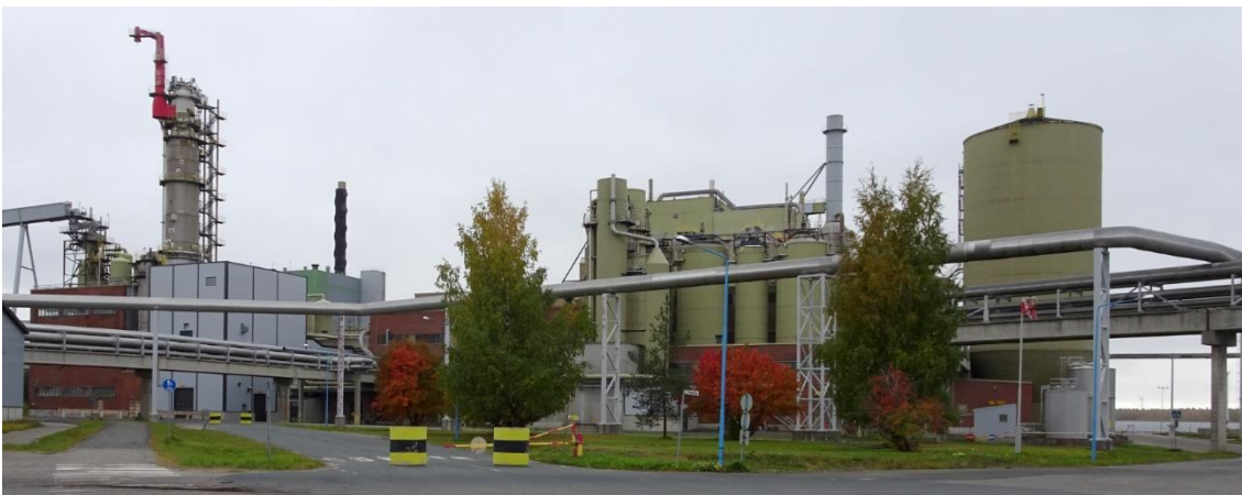
Kuva 315 Pohjoisesta. Vasemmalla vaaleansininen peltivuorattu uusin laajennus on rakennettu 2018. Sen takana on korkea Kamyri-keitin. Kuvan oikeassa reunassa vihreät rakennukset ovat Kuvälähde: FCG 2022
