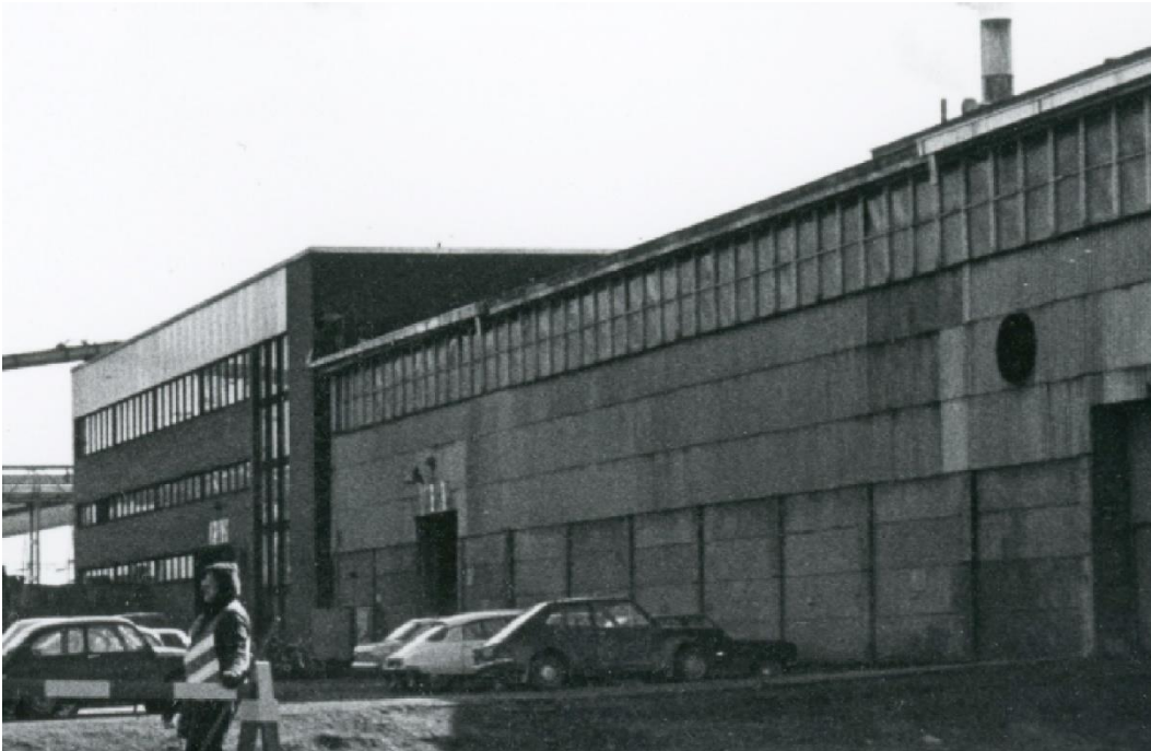
Kuva 62 Ote valokuvasta 1970-luvulta luoteesta. Betonielementtirakenteinen halli on osittain verhoiltu rakennuslevyillä. Seinän yläosan nauhaikkunan paikka hahmottuu hyvin, vaikka ikkunat ovatkin luultavasti jo peitetty. Kuvan vasemmassa reunassa on 1971 valmistunut 3-kerroksinen laajennus. Sen julkisivuja jäsentävät nauhaikkunat. Kuvälähde: Kemin historiallinen museo / khmva_0229_0013_00, 1970-luvun Veitsiluotoa, valokuvaaja Jorma Sauvola
