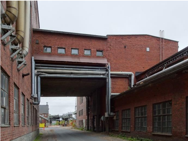
Kuva 110 Lounaasta. Yhdyskäytävä voima-aseman ja kunnossapito-osaston välillä. Putkilinjat ovat lisääntyneet vuosien kuluessa. Kuvälähde: FCG 2022
