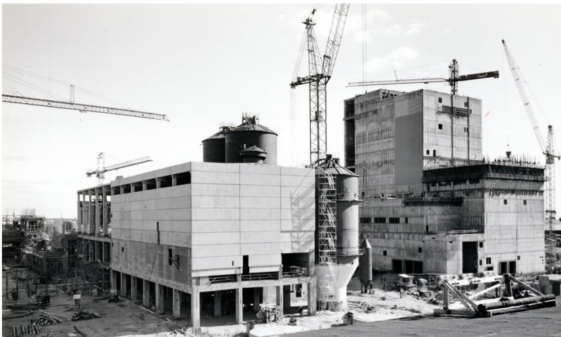
Kuva 304 Sulfaattiselluloosatehtaan rakennustyömaa pohjoisesta vuonna 1976. Kuvan vasemmassa reunassa sellutehtaan kuitulinjan rakennus ja oikeassa reunassa lipeälinjan rakennus. Kuvälähde: Kemin historiallinen museo /676
