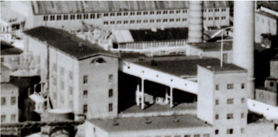
Kuva 28 Ote ilmavasta lounaasta. Sulfiittiselluloosatehdas vuonna 1953. Etualalla vuonna 1943 valmistunut spriitehdas ja taustalla vuonna 1951 valmistunut kaarikattoinen saha. Kuvälähde: Kemin historiallinen museo /407 (3683) Veitsiluodon tehtaat. Kuvaaja Veljekset Karhumäki, N:o 10 797.
