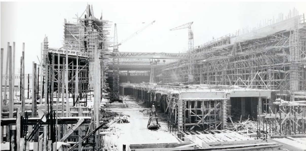
Kuva 186 Toista konesalia paperikoneille 2 ja 3 (PK2, PK3) rakennetaan vuonna 1960. Kuvälähde: Kemin historiallinen museo / 446 (3710, B4) Paperitehdas 25.11.1960. Kuvaaja Teollisuuskuvaamo Mannelin, Helsinki.
