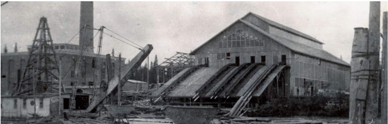
Kuva 123 Koillisesta. Veitsiluodon ensimmäinen saha ja voima-asema olivat rakenteilla 1920-luvun alussa. Kuvälähde: Kemin historiallinen museo / khmva_0211_0012, Veitsiluodon saha 1920-luvun alussa.
