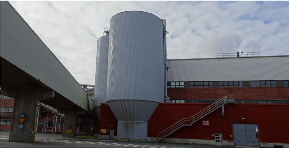
Kuva 205 Koillisjulkisivua. Kuvassa näkyy lähinnä 1980-luvulla tehty laajennus. Kuvassa näkyy myös PK5:n rakennukselle johtava kuljetin. Kuvälähde: FCG 2022
