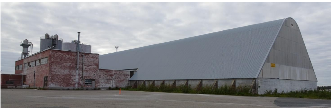
Kuva 261 Luoteesta. Betonisten tukikaarien alaosaat rytmittävät julkisivun alaosa.
