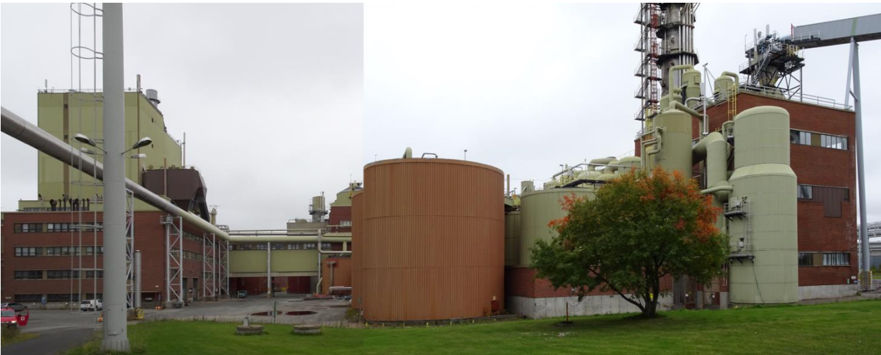
Kuva 324 Sulfaattiselluloosatehdas kaakosta. Oikealla on Kamyri-keitin ja höyrykattilat. Punaiset säiliöt keskellä on rakennettu myöhemmin. Kuvälähde: FCG 2022
