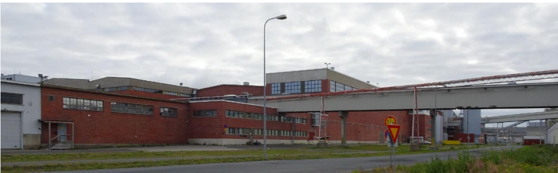
Kuva 198 Lounaisjulkisivua idästä. Alkuperäistä 1950-luvun alun julkisivua ei juurikaan ole näkyvissä. Kuljettimen yläpuolella näkyvä harjakattoinen punatiilinen pääty kuuluu alkuperäiseen paperitehtaaseen vuodelta 1955. Kuvälähde: FCG 2022
