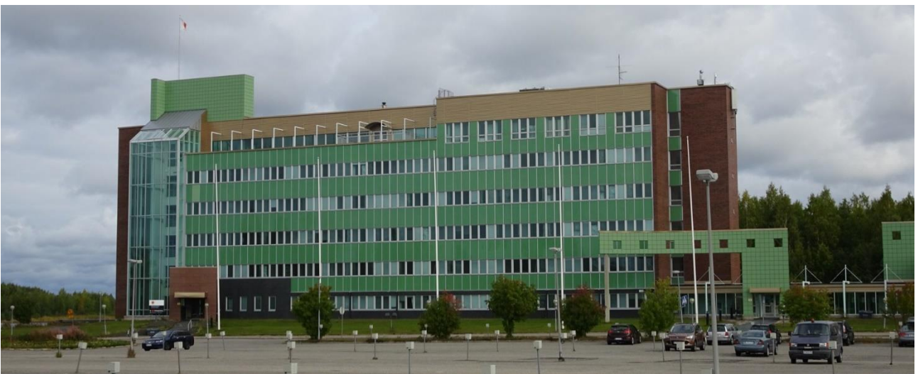
Kuva 266 6-kerroksinen toimisto-osa lounaasta. Kuvälähde: FCG 2022
