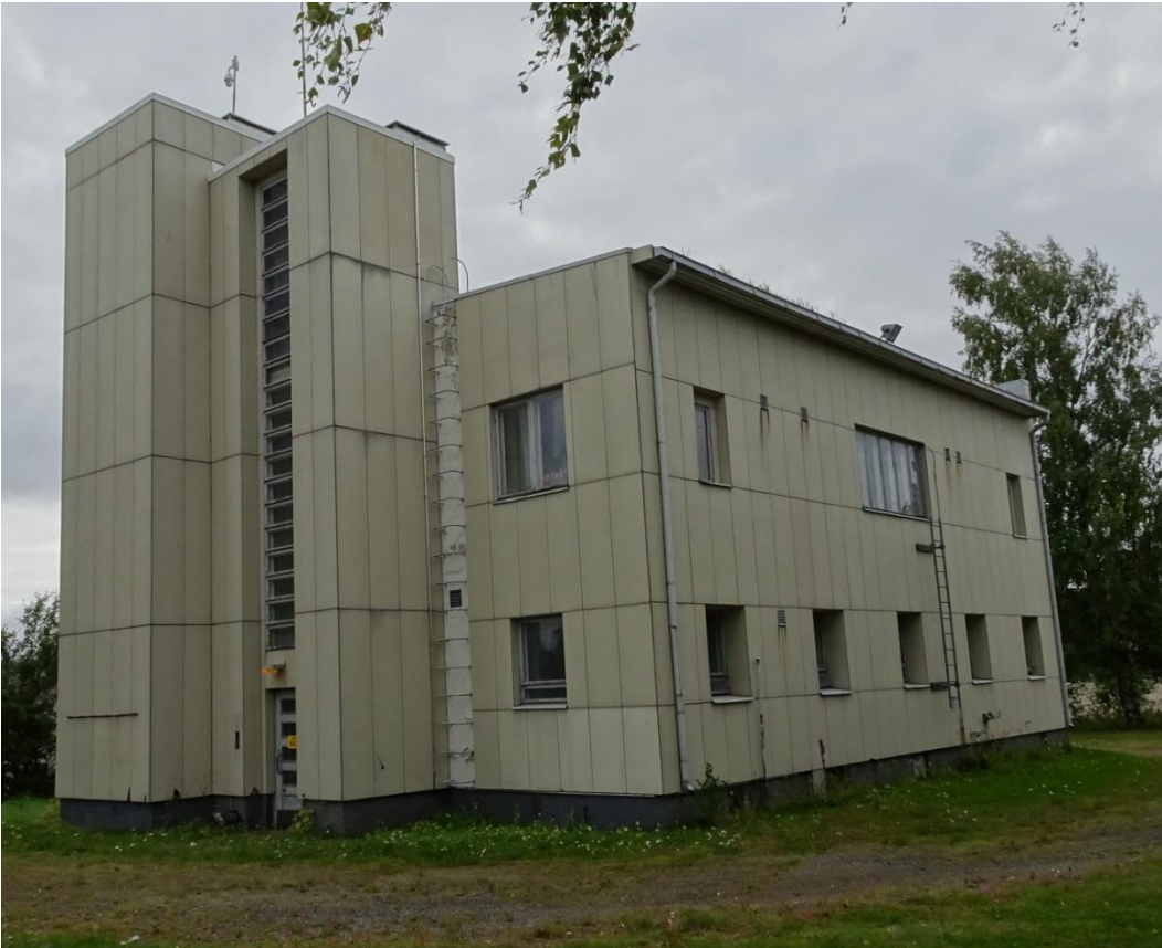
Kuva 245 Luoteesta. Portaikko ja letkutorni hallitsevat päätyjulkisivua. Kuvälähde: FCG 2022
