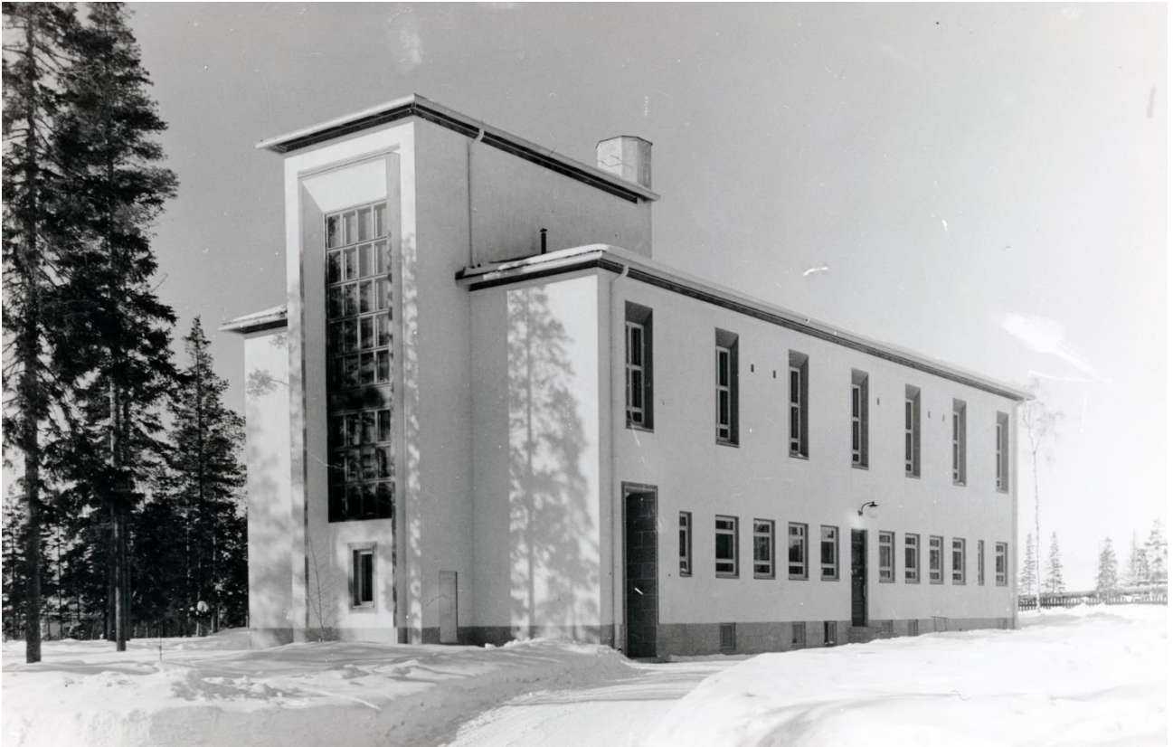
Kuva 213 Vaaleiden ikkunoiden smyygejä on korostettu julkisivua reilusti tummemmalla sävyllä. Pädyn tumman ikkunan smyygit ovat vaaleat, mutta smyygikehyksen etu- ja ulkoreunat ovat tummat. Myös räystäään alapinnat ovat tummat. Sisennetty kapea ja korkea pääsisäänkäynti on verhoiltu kivilaatoilla. Kuvälähde: Kemijoki historiallinen museo / 661 (3305) Pääkonttori vuonna 1936. Kuvaaja M. Mannelin, Helsinki.
