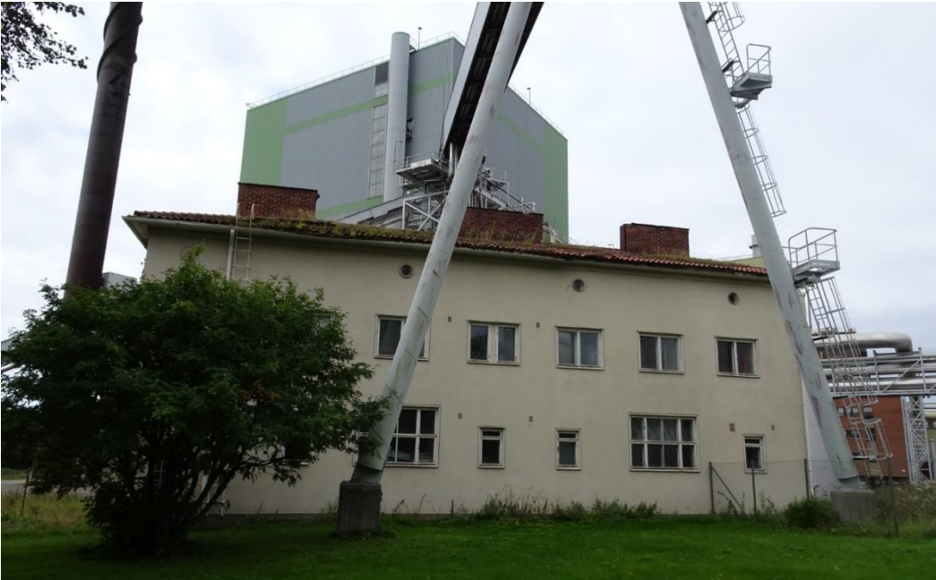
Kuva 236 Rakennuksen yli rakennettiin 1990-luvulla voimalaitoksen kuljetin. Kuvälähde: FCG 2022
