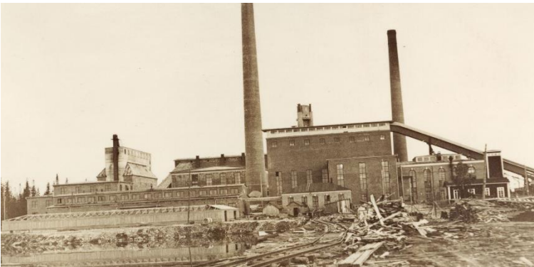
Kuva 96 Idän suunnalta arviolta 1930-luvun alusta. Korjauspajan ja meren väliin ollaan rakentamassa U:n mallista matalaa varastorakennusta. Konepajan takana näkyy vasemmalla myöhemmin purettu kuorimo, sen vieressä sulfiittitehdas ja piippujen välissä voima-aseman vuonna 1929 valmistunut laajennus. Vanha voima-asema näkyy kuvan oikeassa reunassa. Sen edessä on tehdasalueen vanhin paloasema. Kuvälähde: Kemin historiallinen museo / khmva_0001_5523.
