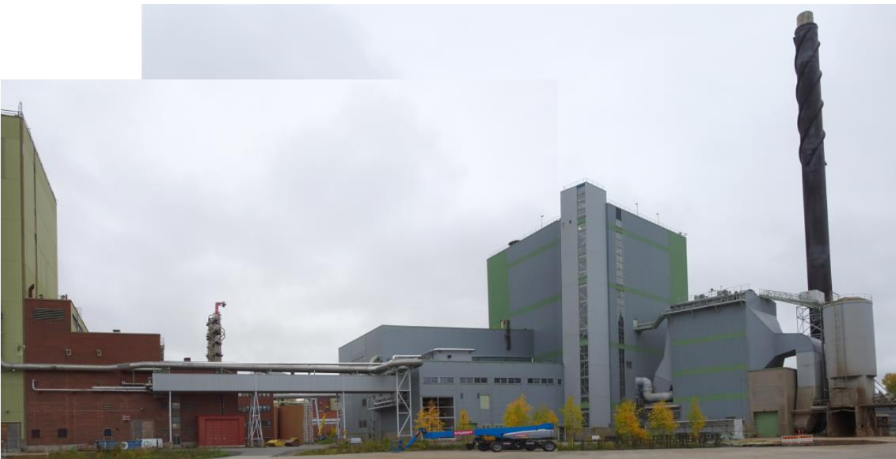
Kuva 322 Soodakattirakennuksen kaakkoispuolelle valmistui vuonna 1996 sinisellä ja vihreällä pellillä verhoiltu voimalaitos. Kuvälähde: FCG 2022
