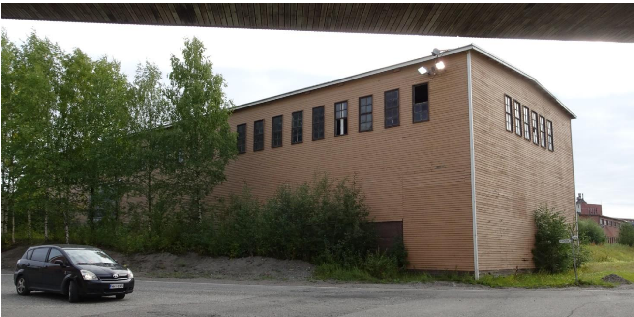
Kuva 178 Varasto idästä. Raiteiden poistuttua päädyn aukko on umpeutettu. Kuvälähde: FCG 2022
