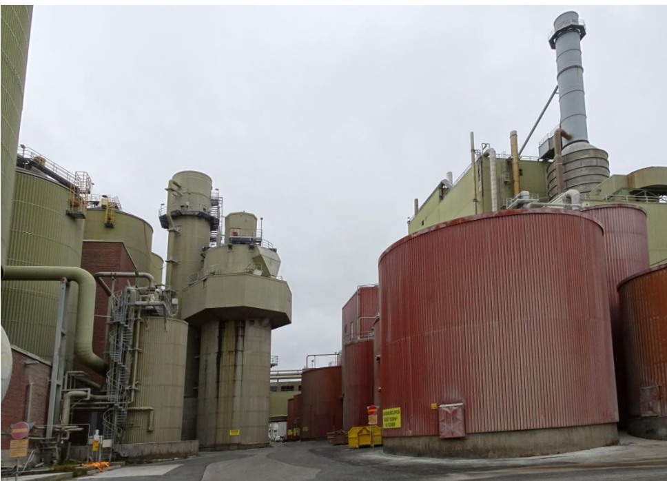
Kuva 326 Sulfaattiselluloosatehtaan rakennusten välinen kuja luoteesta. Kuvalähde: FCG 2022
