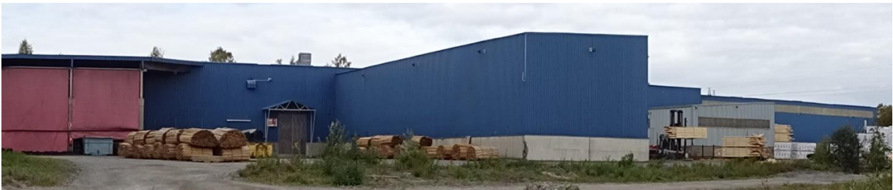
Kuva 145 Kuivaamon pohjoispuoleiset rakennusosat kuvattuna idästä. Kuvälähde: FCG 2022
