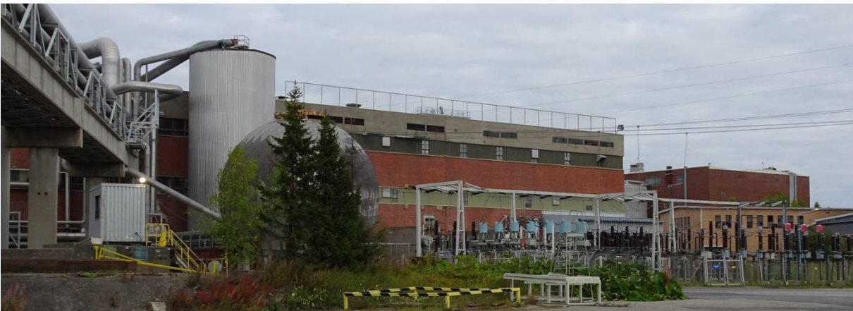
Kuva 203 Kaakkoispääty. Vuonna 1961 valmistuneen puuhiomon julkisivu on kaakossa edelleen hyvin näkyvissä. Kuvan oikeassa reunassa näkyy PK5:n rakennus ja sen edessä puutalotehtaan varasto. Kuvälähde: FCG 2022
