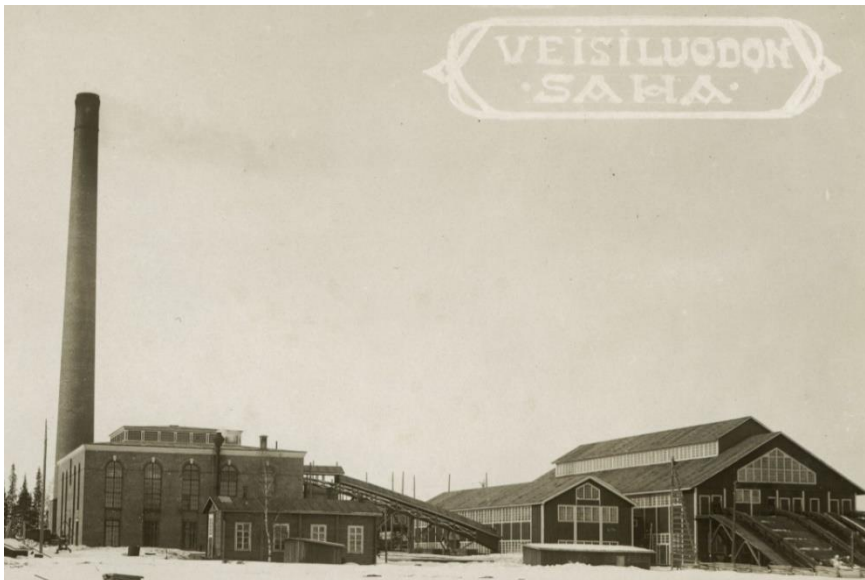
Kuva 66 Idästä arviolta 1920-luvun alkupuolelta. Vasta valmistuneet voima-asema ja saha. Voima-asemassa on symmetriset julkisivut ja korkeat yläosastaan kaarevat ikkunat. Ikkunoiden yläreunassa on vaalea koristeaihe. Muotoiltu räystäään alunen on myös vaalea. Nykytilanteen perusteella se vaikuttaa olevan betonista. Kuvälähde: Kemin historiallinen museo / khmva_0001_6186, Veitsiluodon saha.
