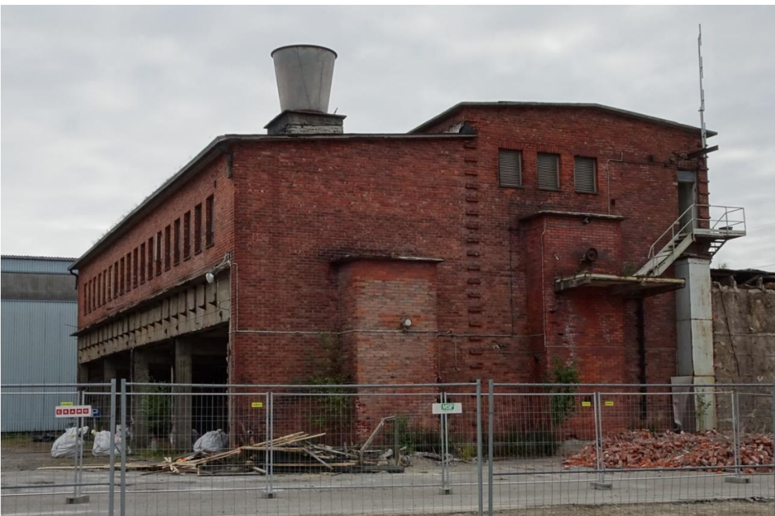
Kuva 157 Luoteesta. Julksivua jäsentää korkeimman osan nurkissa olevat ulkonevat tiilimuuraukset. Kuvälähde: FCG 2022
