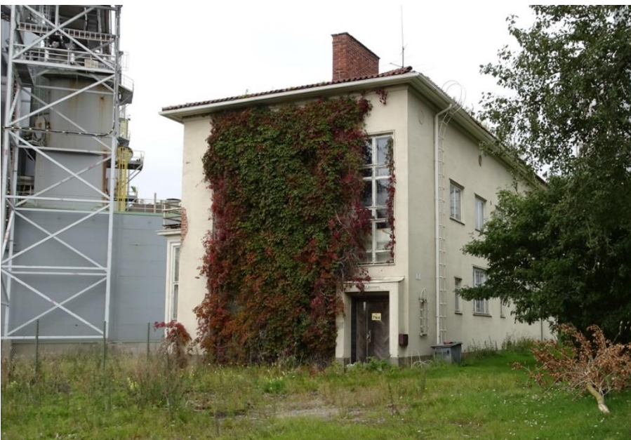
Kuva 235 Pääsisäänkäynnin yläpuolella korkea ruutuikkuna. Kuvälähde: FCG 2022
