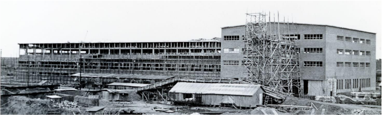
Kuva 180 a Etelästä vuonna 1953. Paperitehdasta rakennetaan. Kuvan oikeassa laidassa jauhatusosasto ja vasemmassa paperikonesali. Kuvälähde: Kemin historiallinen museo / 68 (2718) Paperitehdas 10.11.1953. Kuvaaja Mannelin.
