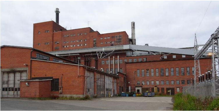
Kuva 107 Idästä. Vasemmalla ajoneuvokorjaamo- ja viilaamosiipi, jotka laajensivat 1940-luvulla rakennettua pienempää siipeä. Oikealla kunnossapito-osasto. Taustana voima-aseman rakennukset.
