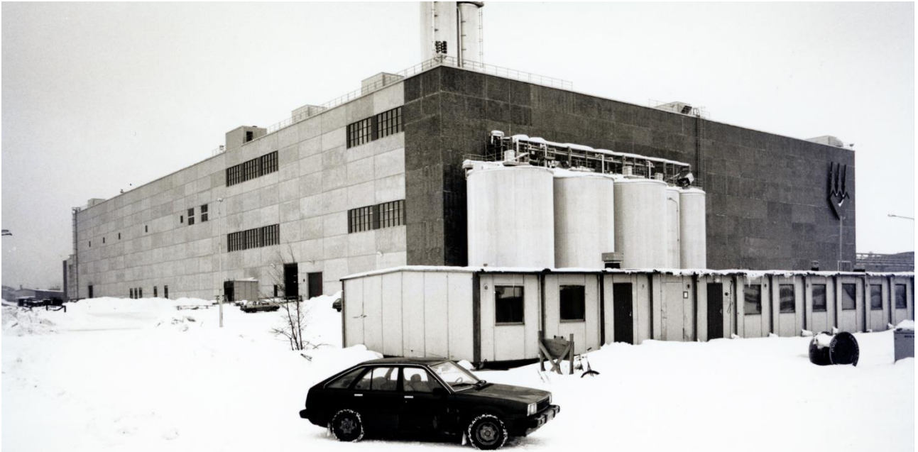
Kuva 291 Pohjoisesta vuonna 1986. Laajennuksen koillisjulkisivu verhoiltiin vain betonielementeillä, kun varauduttiin mahdolliseen laajennukseen. Kuvälähde: Kemin historiallinen museo / 2019 (4582, A1/86) Paperikone 5:den (PK 5) päällystyskone ja jälkikäsitteily kaupungista päin kuvattuna 15.3.1986. Kuvaaja Mannelin, Helsinki
