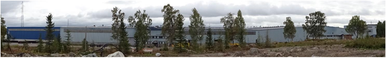
Kuva 148 Laajennuksen pohjoispään länsijulkisivu. Kuvan keskiosassa näkyy 2-kerroksinen toimistosa.
