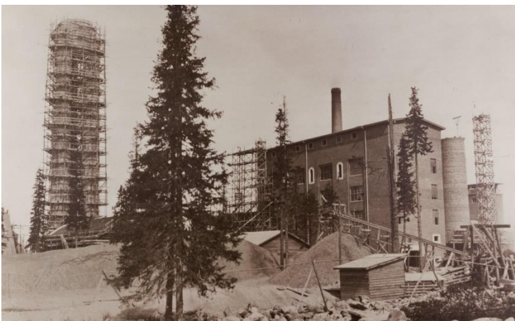
Kuva 20 Sulfiittiselluloosatehtaan keitto-osasto ja happotorni rakenteilla 1920-luvun lopulla. Vuonna 1929 valmistuneen voima-aseman laajennuksen piippu on myös rakenteilla kuvassa. Kuvälähde: Kemin historiallinen museo / khmva_0001_4677
