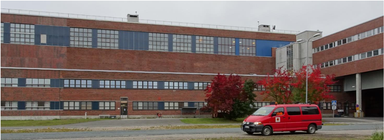
Kuva 295 Lounaissivun keskiosa toimisto- ja laboratoriosiiven länsipuolella. Kuvälähde: FCG 2022
