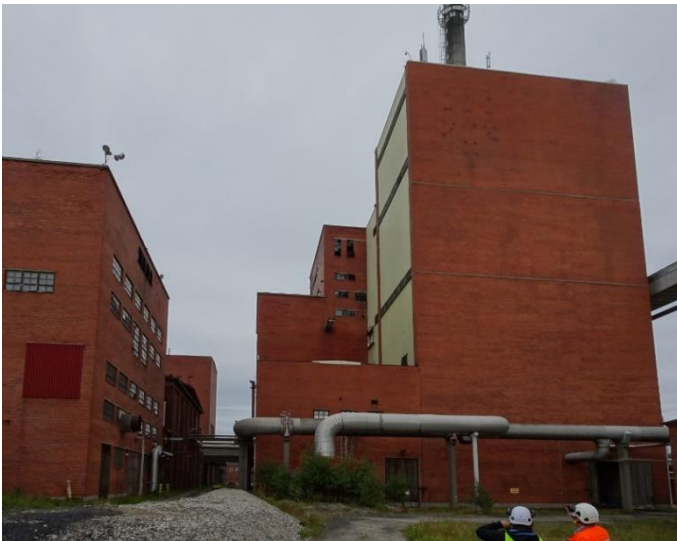
Kuva 94 Voima-aseman viimeinen laajennus on valmistunut vuonna 1971. Sen korkean osan länsijulkisivu on verhoiltu vaalealla profiilipellillä. Eteläisessä julkisivussa on vain 3 pientä ikkuna- ja 2 ovi-aukkoa, jotka jäävät rakennusta kiertävien putkien taakse piiloon. Korkeiden julkisivujen tiilimuraus on katkaistu kahdella betonisella vaakalistalla. Eteläjulkisivulla on vielä näkyvissä Veitsiluodon logon kiinnitysjäljet. Uusi voimalaitos on valmistunut vuonna 1996 sulfaattiselluloosatehtaan eteläpuolelle. Kuvälähde: FCG 2022
