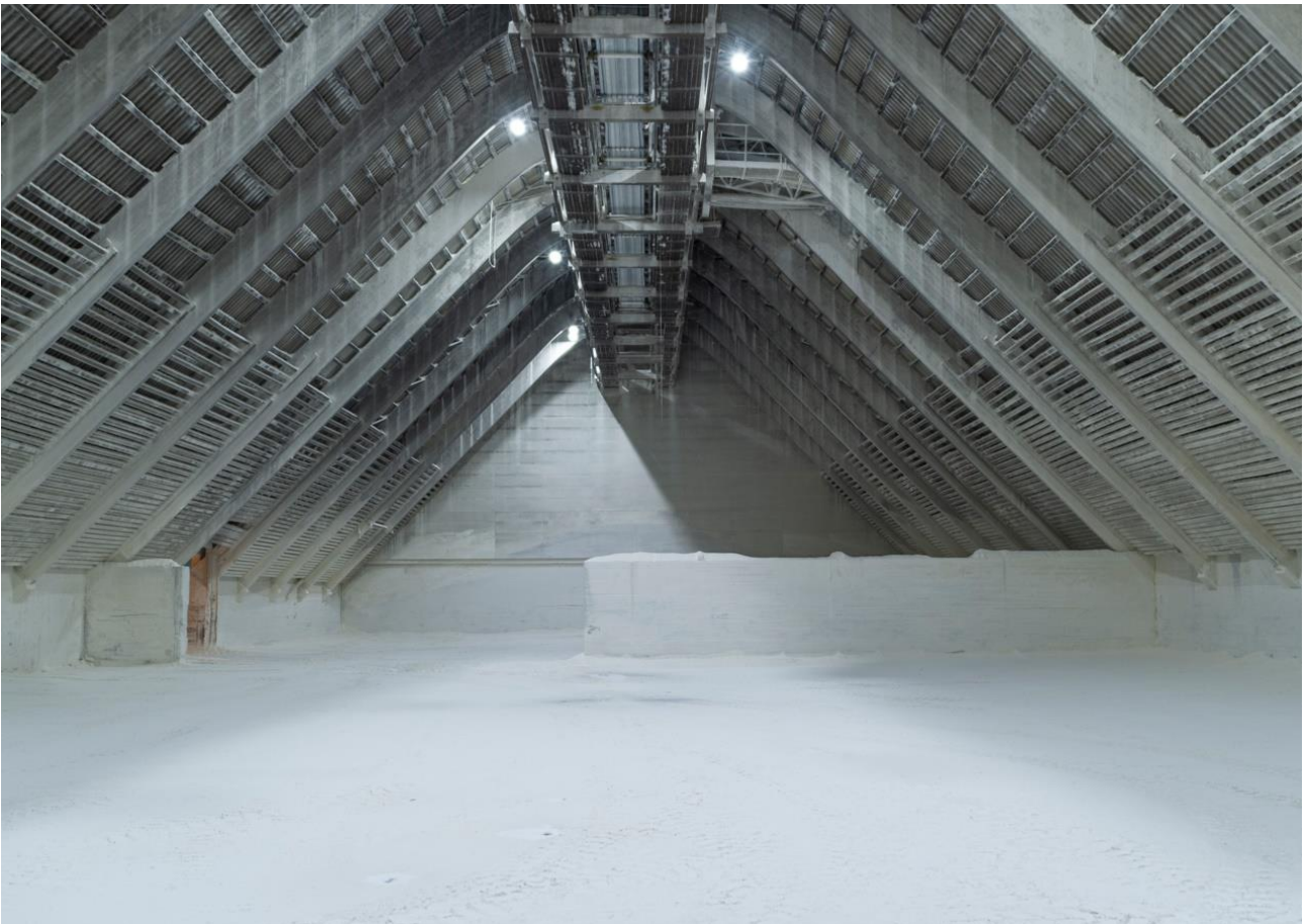
Kuva 263 Pigmenttivaraston sisällä kantavat teräsbetoniaaret näkyvät hyvin. Kuvälähde: Taisto Saari.
