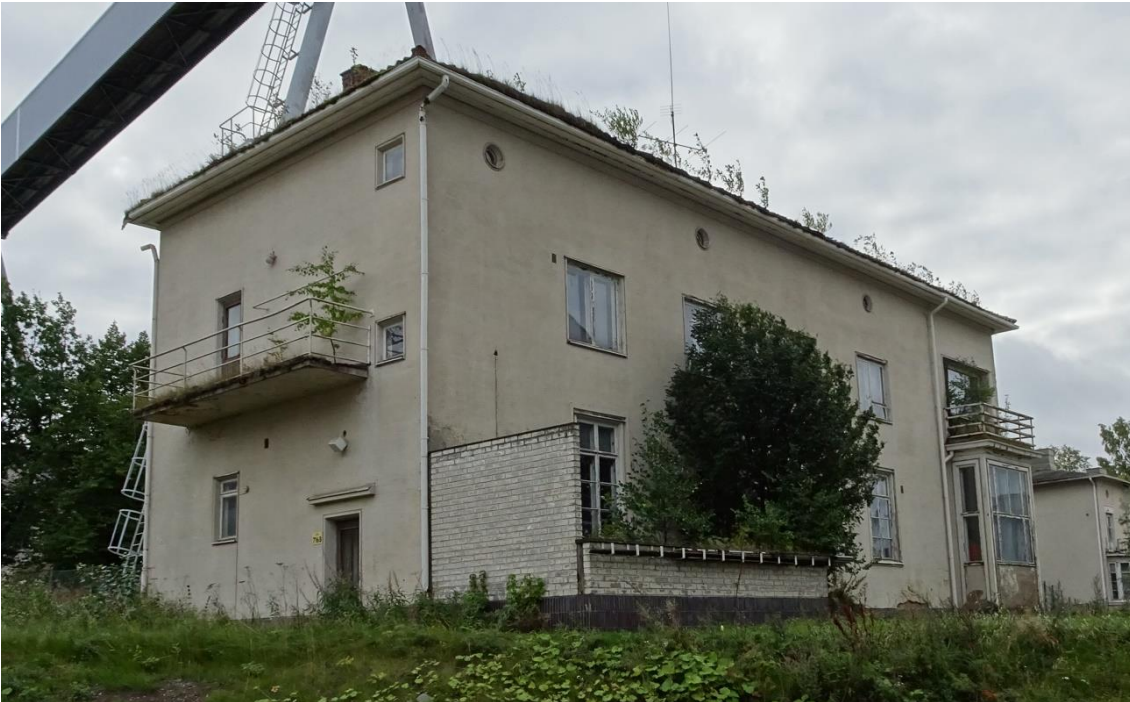
Kuva 238 Luoteesta. Pohjoispäädyssä on suurehko, mutta sirorakenteinen ulokeparveke. Kuvälähde: FCG 2022
