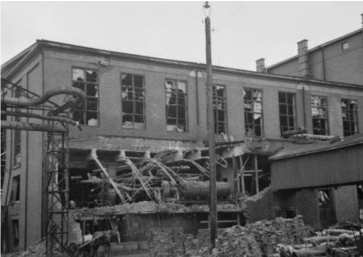
Kuva 25 Massalajitteluosaston pohjoispuoleinen matala siipi vaurioitui pahoin pommituksessa vuonna 1944. Kuvälähde: SA-kuva 167538 / Saksalaisten syöksypommittajien aiheuttamia vaurioita Veitsiluoto Oy:n tehtailla Veitsiluodossa, kuvaaja kapteeni Leo Vepsäläinen, 1944.11.04
