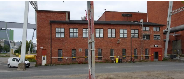
Kuva 121 Idästä. Alun perin yläkerran kaikki ikkunat ovat olleet samanlaisia neliön muotoisia ruutuikkunoita. Kuvälähde: FCG 2022
