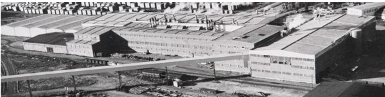
Kuva 191 Ote ilmakuvasta etelästä 1966. Lounaispuolen julkisivun keskiosassa on vielä näkyvissä alkuperäisen paperitehtaan julkisivu. Kuvan oikeassa laidassa puuhiomo, sen vasemmalla puolella jauhatusosasto, sen vasemmalla puolella alkuperäinen konesali (PK1) ja sen vasemmalla puolella muusta rakennusmassasta ulkoneva jälkikäsitelyosasto. PK1:n takana näkyy PK2:n ja PK3:n konesali sekä sen vasemmalla puolella paperivarasto. Kuvälähde: Lusto – Suomen metsämuseo, Metsäteollisuus ry:n kokoelma V96022:3920 / Veitsiluoto Oy:n paperitehdas Kemin Veitsiluodossa ilmasta kuvattuna, valokuvaaja teollisuuskuvaamo Mannelin, 1966.
