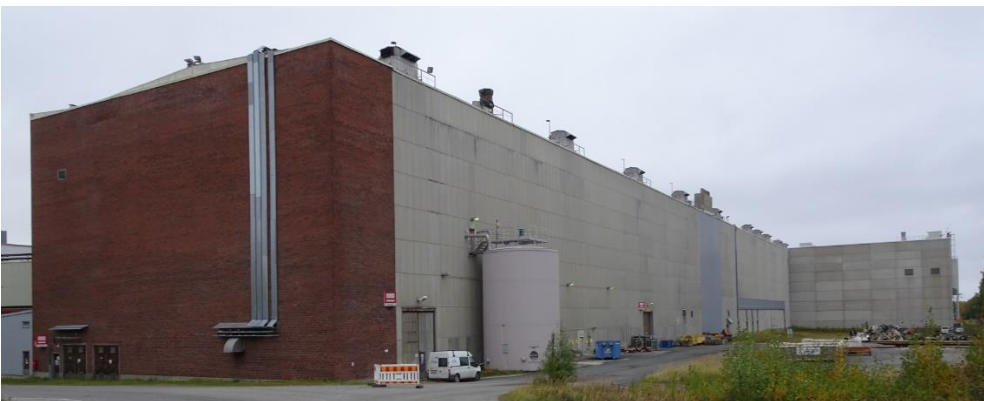
Kuva 300 Kaakkoispääty ja betonielementein verhoiltu koillisjulkisivun itäpää. Julkisivuverhoilu on jätetty betonipintaiseksi, koska on varauduttu paperitehtaan laajentamiseen. Kuvälähde: FCG 2022
