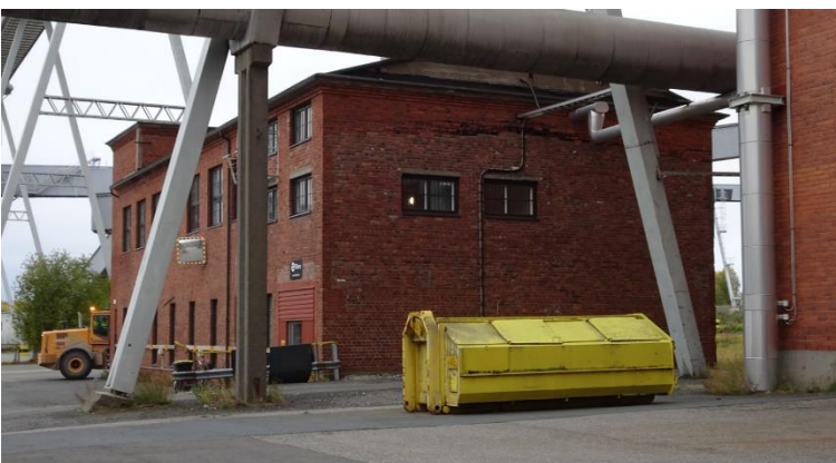
Kuva 122 Koillisesta. Pohjoisjulkisivulla on ollut toisessa kerroksessa lähes koko rakennuksen levyinen yhdyskäytävä, josta on päässyt kuorimon vanhempaan osaan. Kuvälähde: FCG 2022
