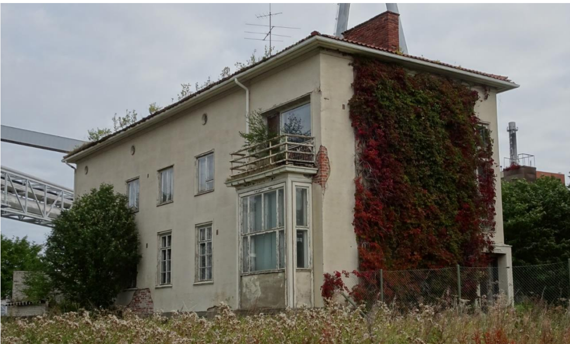
Kuva 239 Lounaasta. Erkkeri parvekkeineen korostaa rakennuksen lounaisnurkkaa. Kuvälähde: FCG 2022
