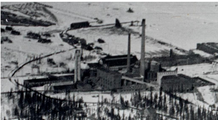
Kuva 23 Ote ilmakuvasta vuodelta 1933 lounaasta. Sulfiittiselluloosatehdas oheisrakennuksineen on valmistunut sahan ja voima-aseman yhteyteen. Kuvälähde: Kemin historiallinen museo / khmva_0210_0072, Talvinen ilokuva Veitsiluodosta 3.4.1933, valokuvaaja Sovio
