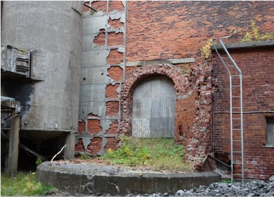
Kuva 90 Sulfiittiselluloosatehtaan voima-aseman piipun perustus on edelleen nähtävissä 1950-luvulla rakennetun laajennuksen länsipuolella. Kuvälähde: FCG 2022
