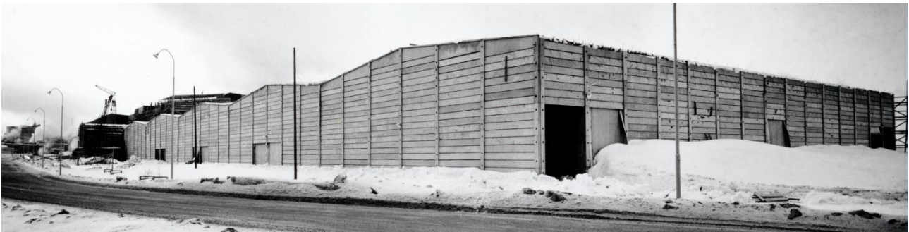
Kuva 189 Pohjoisesta. Betonielementtinen paperivarasto on valmistunut vuonna 1961 paperitehtaan luoteispuolelle. Kuvälähde: Kemin historiallinen museo / 2710 (1278, H 7/61) Veitsiluodon paperitehtaan varasto 28.3.1961. Kuvaaja Valok. M. Mannelin, Malmi.
