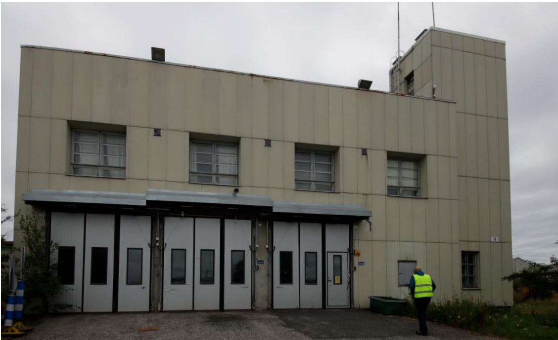
Kuva 242 Koilliseen. Rakennus on verhoiltu kapeilla pystysuuntaisilla levyillä. Kuvälähde: FCG 2022
