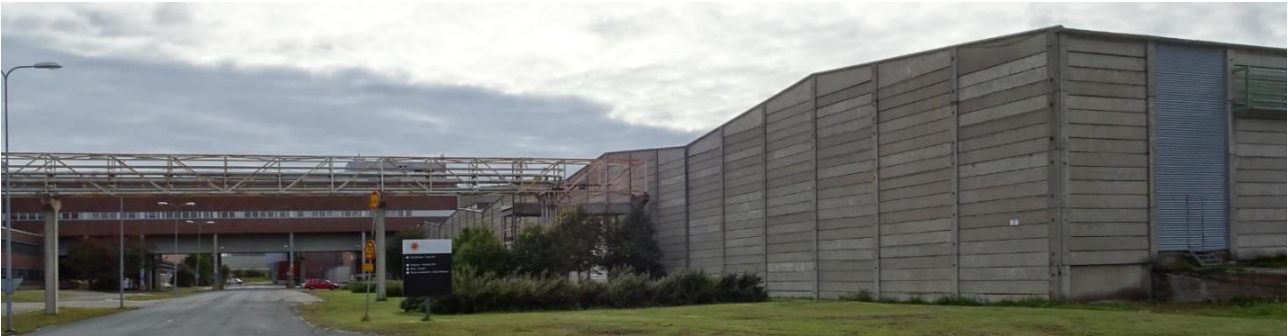
Kuva 210 Koillisjulkisivu pohjoisesta. Paperivarasto on rakennettu kapeista betonivaakaelementeistä. Se on valmistunut 1961. Vasemmalla osittain putkilinjaston takan paperitehtaiden välinen yhdysosa. Kuvälähde: FCG 2022
