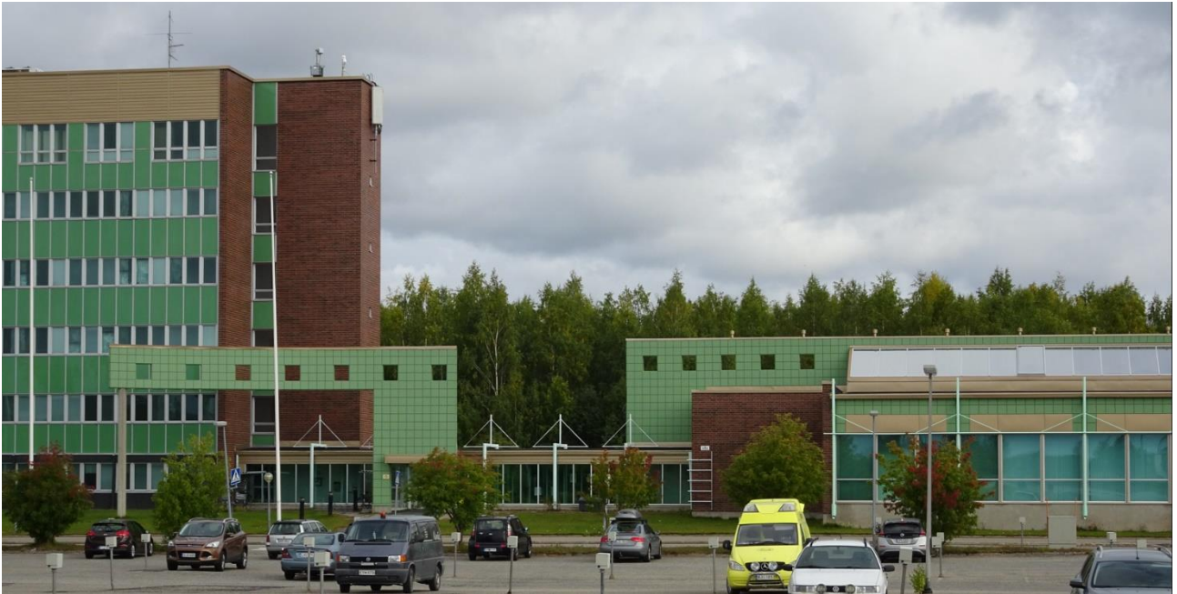
Kuva 268 Toimiston ja ruokalan yhdistävä lasikäytävä. Ruokalan sisäänkäyntiä rakennusten välissä korostaa kaarihaihe, joka jatkuu seinämänä ruokalaosan keskellä. Kuvälähde: FCG 2022
