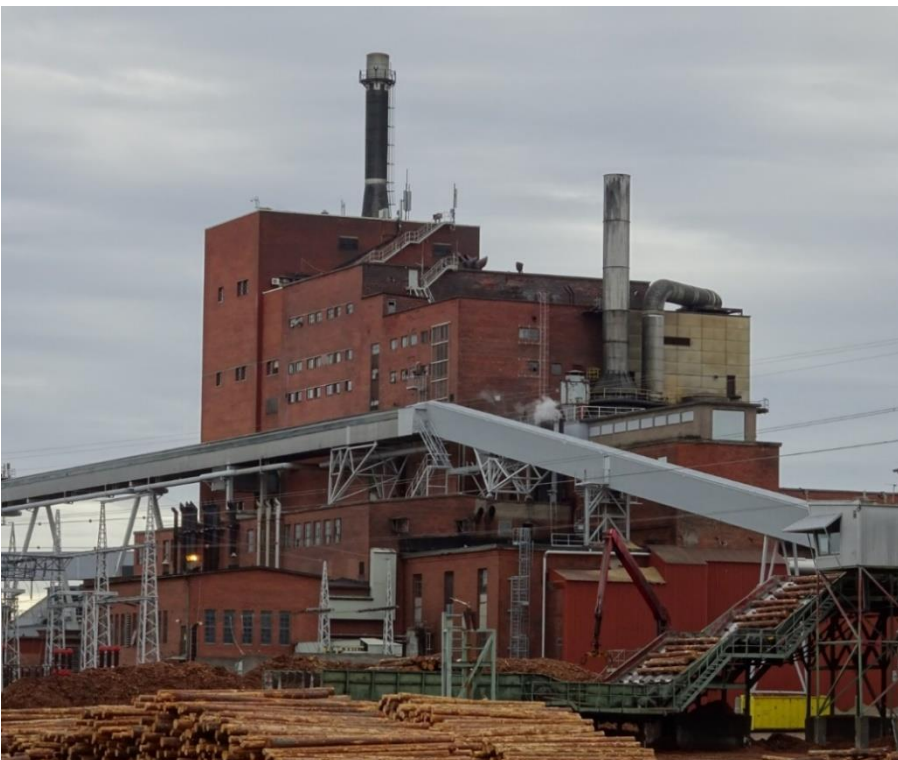
Kuva 84 Koillisesta. Voima-aseman kaikki 5 vaihetta erottuvat selkeästi. Sahan vuoden 1922 voima- asemasta tosin on jäljellä vain lyhyt siivu, jonka pääty on verhoiltu punaisella profiilipellillä. Kuvälähde: FCG 2022
