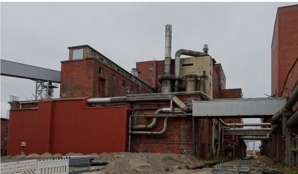
Kuva 88 Alkuperäisen sahan voima-aseman jäljelle jäänyt pohjoispääty on umpeutettu ja verhoiltu punaisella profiilipellillä. Oikealla voima-aseman ja sulfiittiselutehtaan väliin jäävä kuja. Kuvälähde: FCG 2022
