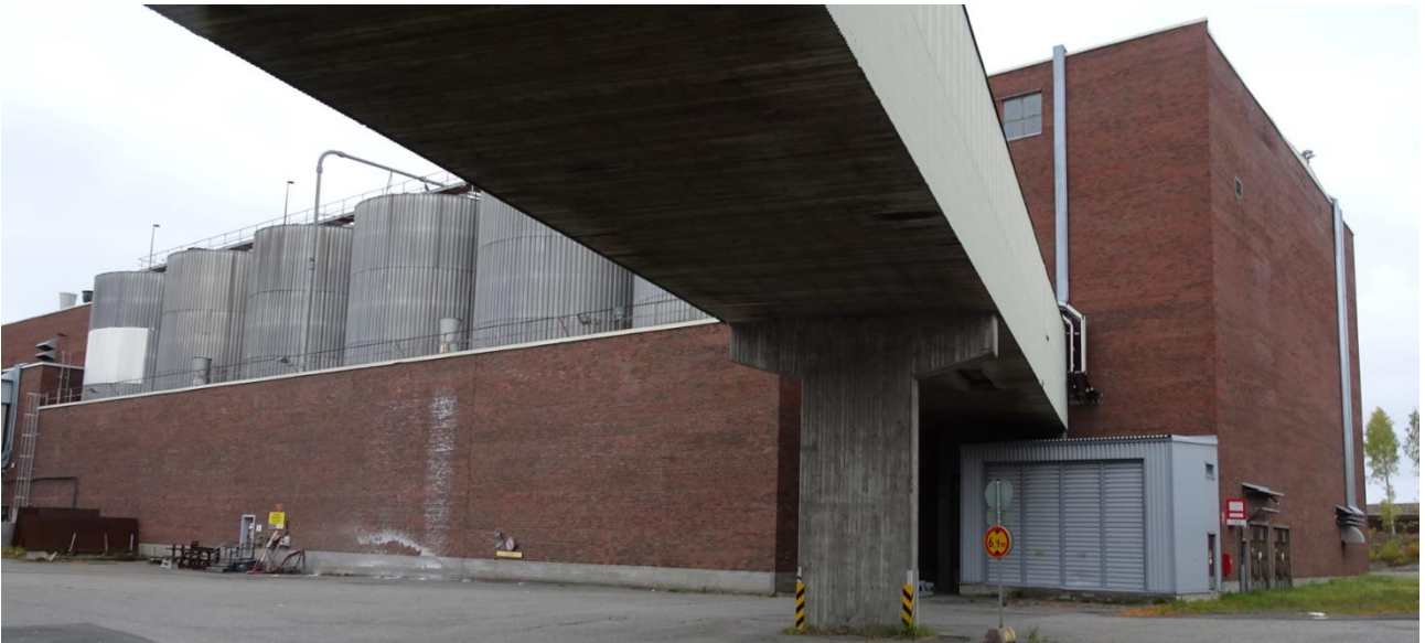
Kuva 299 Lounaisjulkisivun itäpäässä on kuljetin puuhiomolta PK5:lle. Kuvälähde: FCG 2022
