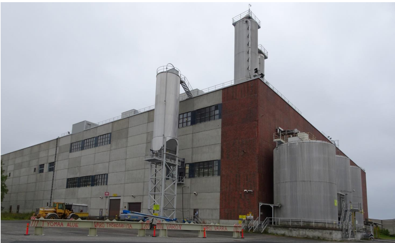
Kuva 302 Koillisjulkisivun länsipää ja kaakkoispäätä säiliöineen. Kuvälähde: FCG 2022
