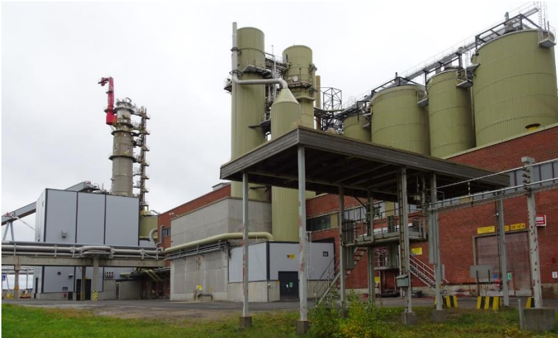
Kuva 316 Lounaasta. Betonielementtiverhoiltu laajennus on rakennettu arviolta vuosituhatosen vaihteen tienoilla. Vaaleansiniset peltiverhoillut laajennukset ovat vuodelta 2018. Kuvälähde: FCG 2022
