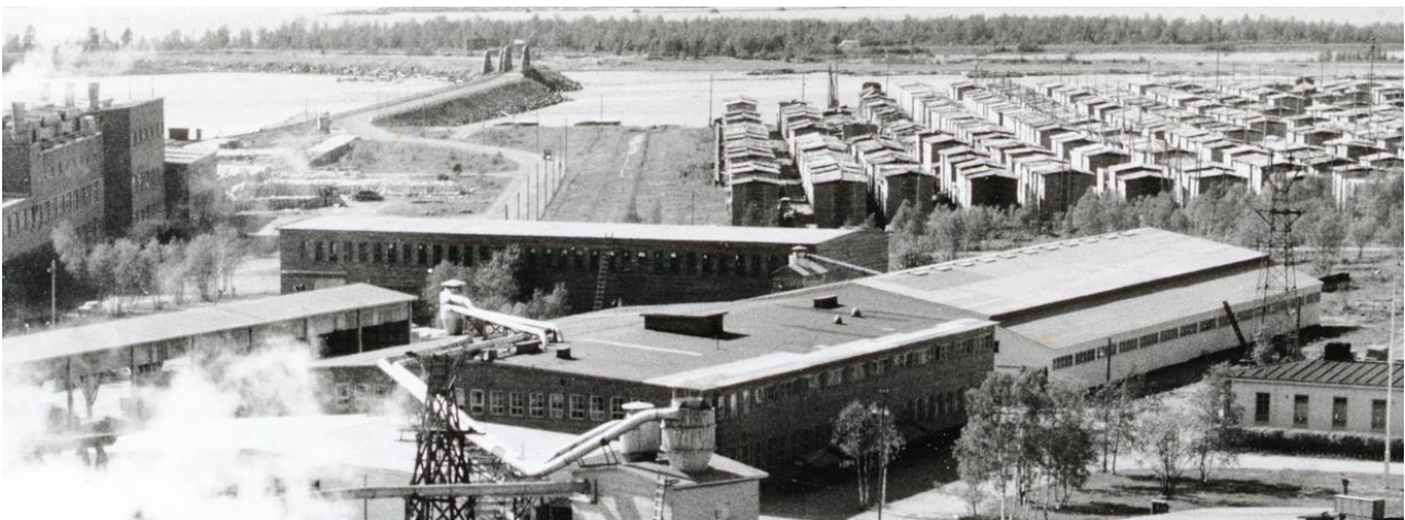
Kuva 172 Ote valokuvasta arviolta 1950-luvun lopulta. Silta Ajokselle valmistui vuonna 1953. Varastoa ei ole vielä siirretty. Kokoonpanohallin katto on muutettu mansardikatoksi. Kuvälähde: Kemin historiallinen museo / 124 (147) Veitsiluodon tehdasta.
