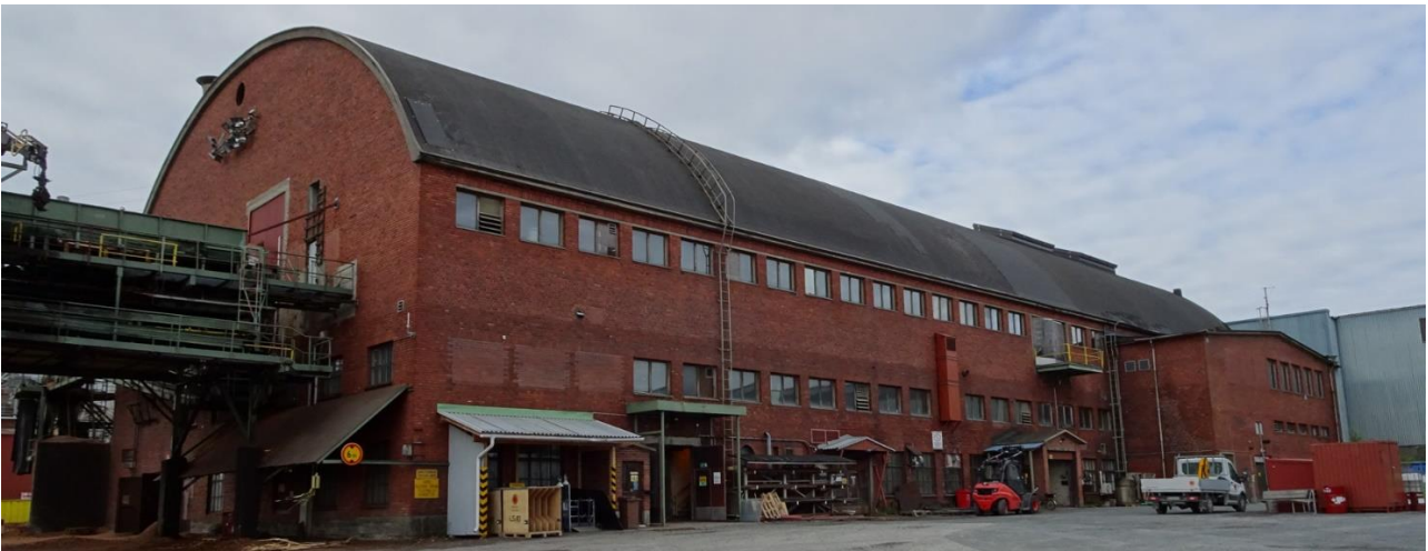
Kuva 138 Koillisesta sahan itäpäätä ja pohjisjulkisivu. Ikkunat ovat alun perin olleet ruutuikkunoita. Alkuperäisiä ikkunoita on vielä alimmassa kerroksessa. Ikkuna-aukkoja on jonkin verran umpeutettu. Kuvälähde: FCG 2022
