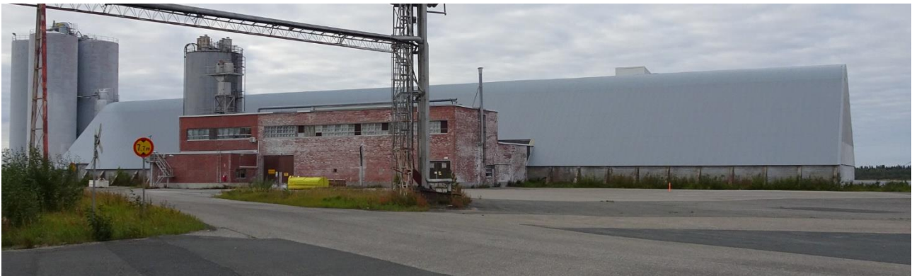
Kuva 260 Pohjoisesta. Kaarevaa osaa on laajennettu kummastakin päästä ja tiiliosaa kaakkoon päin.
