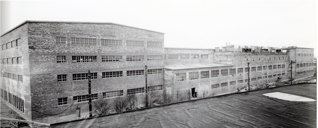
Kuva 183 Paperitehtaan koillisjulkisivu. Kuvassa vasemmalla jauhatusosasto ja sen oikealla puolella paperikonesali ja jälkikäsittelyosasto. Ikkunat ovat nauhamaisia, pienistä ruuduista koostuvia vaakaikkunoita. Kaakkoisjulkisivun alimmassa kerroksessa on myös pystyikkunoita. Kuva on otettu puutalotehtaan varaston katolta, joka näkyy kuvan etualalla. Kuvälähde: Kemin historiallinen museo /500 (2714) Paperitehdas 4.5.1954. Kuvaaja Teollisuuskuvaus M. Mannelin, Malmi
