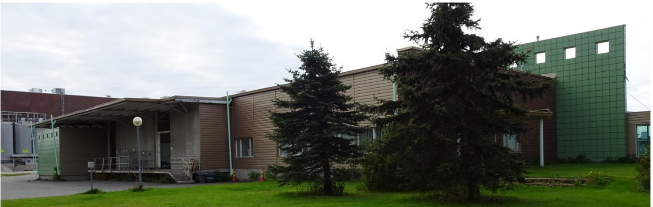
Kuva 272 Ruokalan keittiön lastauslaituri pohjoisesta. Kuvälähde: FCG 2022
