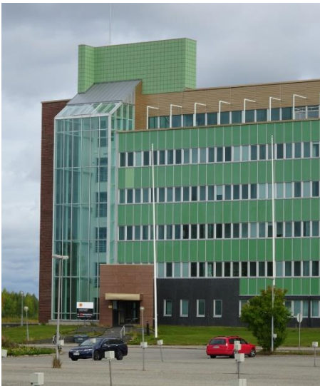
Kuva 269 (Vasemmalla) Pääsisäänkäyntiä korostaa mustaksi värjätystä pesubetonista tehty seinäke. Kuvälähde: FCG 2022
