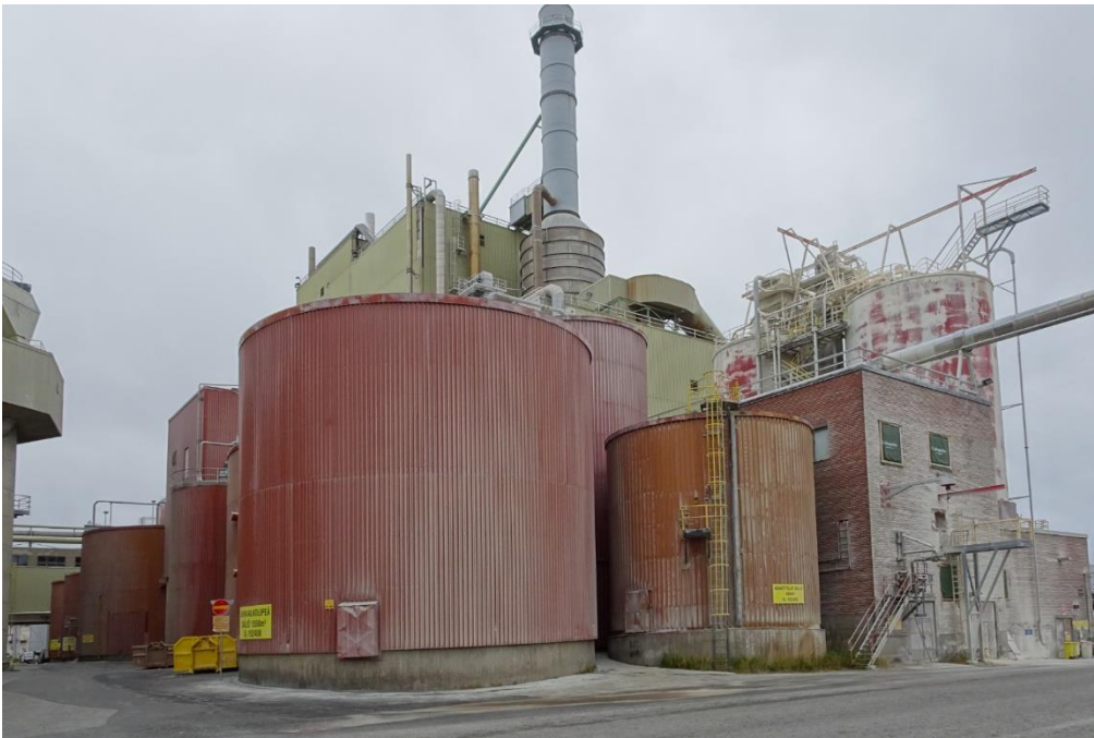
Kuva 319 Soodakattilarakennuksen lounaispääty pohjoisesta. Kuvälähde: FCG 2022
