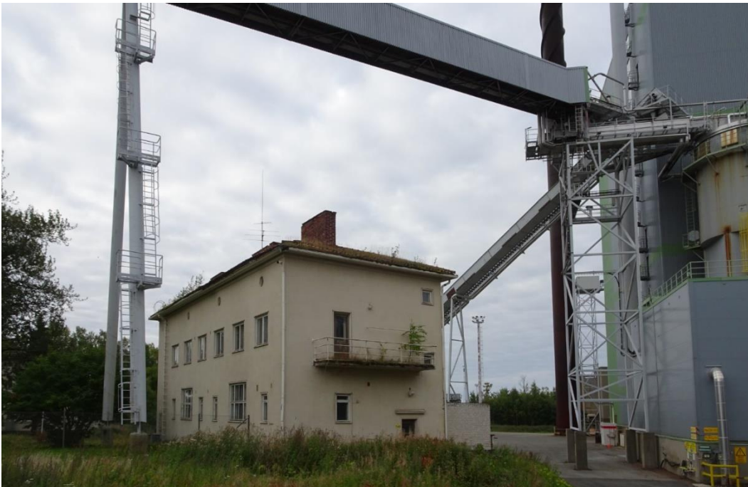
Kuva 237 Länsipuolelle rakennettiin voimalaitos 1990-luvulla. Kuljettimen tukirakenne sijaitsee aivan rakennuksen vieressä itäpuolella. Kuvälähde: FCG 2022
