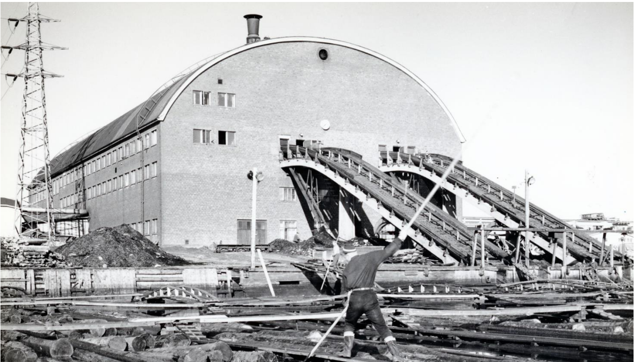
Kuva 129 Kaakosta vuonna 1962. Tukkien kuljettimet hallitsivat sahan itäpäättä. Pään yläosassa ei ole yhtä järjestelmällistä kuin muualla rakennuksessa, vaan siihen on vaikuttanut sahan toiminnot. Kuvälähde: Kemin historiallinen museo / 2336 (3087, A 20/62) Veitsiluodon saha 28.4.1962. Teollisuuskuvaus M. Manneli, Malmi.
