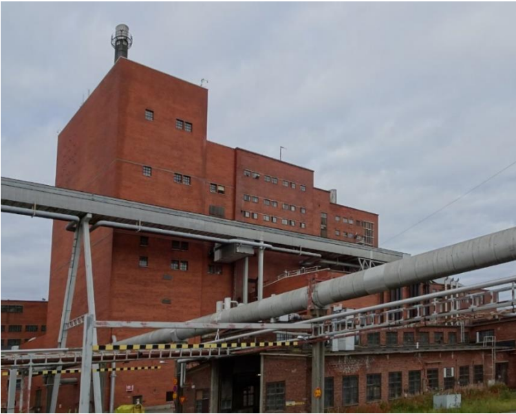
Kuva 83 Kaakosta. Vasemmallla voima-aseman uusin ja korkein 1970-luvun alun laajennus. Etualalla korjauspaja. Kuvälähde: FCG 2022
