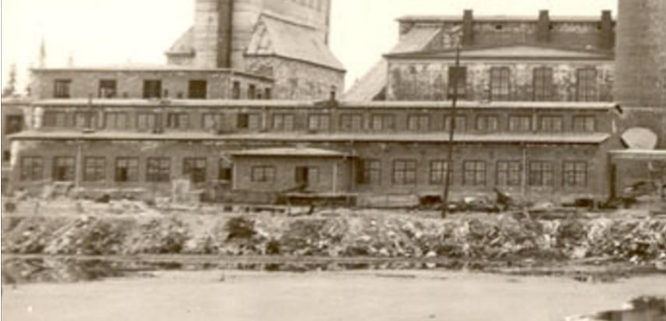
Kuva 95 Ote valokuvasta idän suunnalta arviolta 1930-luvun alusta. Vastavalmistunut konepaja merenpuolelta. Konepajan keskiosassa on alkuperäinen 1-kerroksinen pajasiiپی. Kuvälähde: Kemin historiallinen museo / khmva_0001_0324
