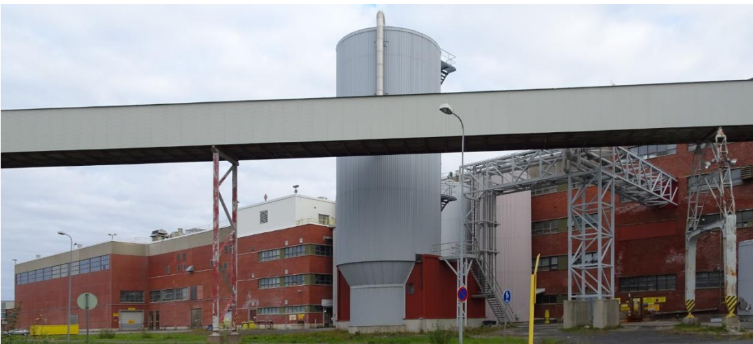
Kuva 199 Lounaisjulkisivua kaakosta. Vasemmalla näkyvän 1980-luvun laajennuksen julkisivut on tehty tiilivuoratuista betonielementeistä. Kuvan oikeassa reunassa näkyvät vanhemmat rakennusosat jäävät erilaisten säiliöiden, kuljettimien ja putkien taakse. Kuvälähde: FCG 2022
