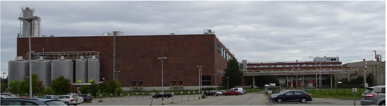
Kuva 293 Luoteispääty. Kuvan oikeassa reunassa näkyy Paperitien ylle 1990-luvun alussa tehty toimisto- ja laboratorio-osa, joka yhdistää paperitehtaan kaksi rakennusta. Kuvälähde: FCG 2022
