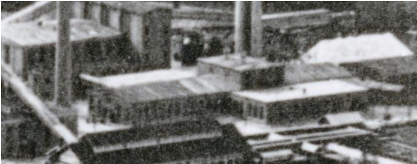
Kuva 47 Ote ilmakuvaista arviolta 1930-luvulta koillisesta. Kuivauskonesalin keskellä on ollut pieni 2-kerroksinen rakennusosa ja sen pohjoispuolella matala tasakattoinen siipiosa. Kuvälähde: Kemin historiallinen museo /121 (137) Ilmakuva Veitsiluodosta.
