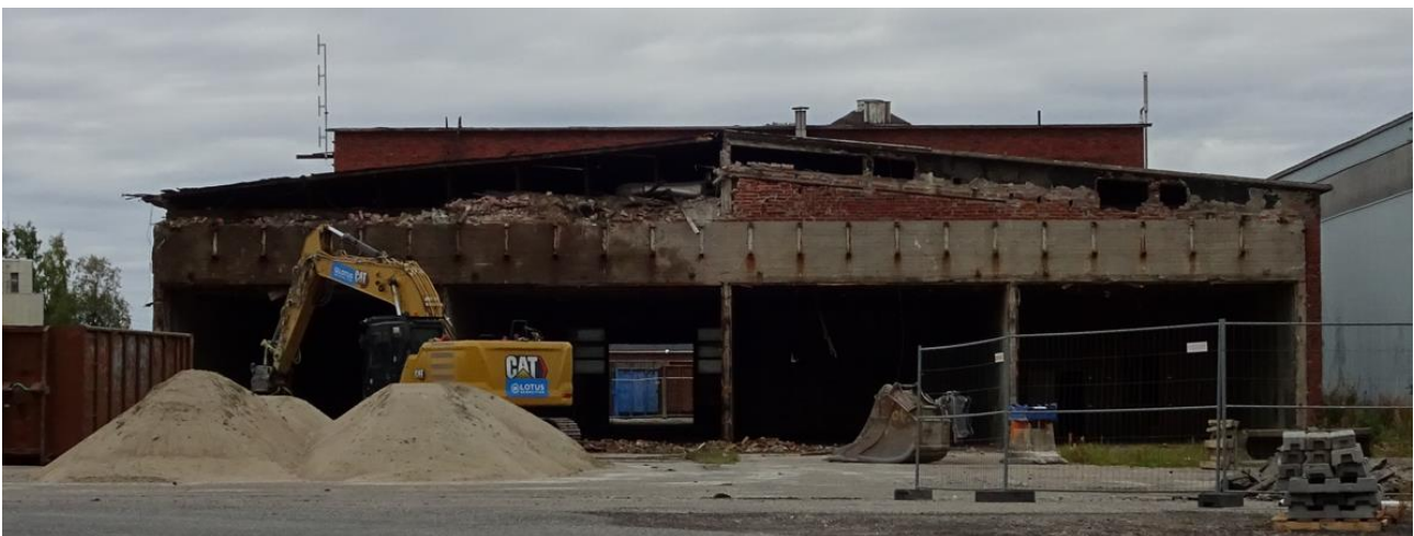
Kuva 159 Purkamisen on aloitettu rakennuksen eteläpäästä. Kuvälähde: FCG 2022
