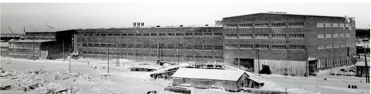
Kuva 182 Paperitehtaan lounaisjulkisivu arviolta 1950-luvun puolella välissä. Ikkunat ovat nauhamaisia, pienistä ruuduista koostuvia vaakaikkunoita. Kuvälähde: Kemin historiallinen museo / 501 (2724) Paperitehdas. Kuvaaja Kemin Kuvaamo.
