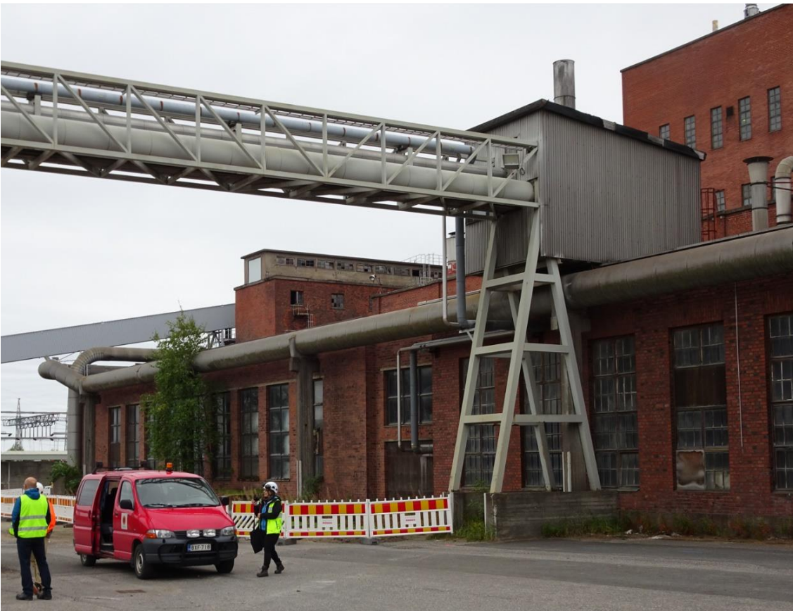
Kuva 54 Julkisivu pohjoiseen. Kuvan vasemmassa reunassa näkyvä koillisnurkan 1-kerroksinen laajennus on tehty luultavasti 1950-luvulla. Räystään korkeudella kulkee putkilinja, joka on tuettu siroilla betonipilareilla. Lisäksi rakennuksen yli johtaa putkilinja sahalle. Kuvälähde: FCG 2022
