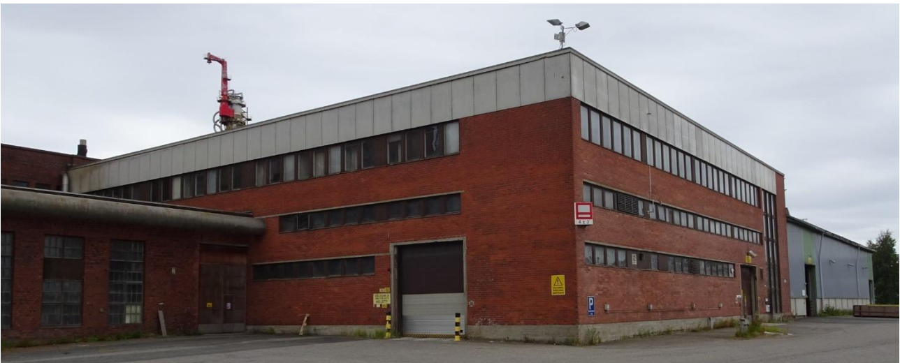
Kuva 65 Koillisesta. 3-kerroksinen tutkimus- ja laboratorio-osasto sekä selluloosatehtaan jälkikäsittelyosasto on rakennettu selluloosavaraston ja kuivauskonesalin väliin. Sen julkisivuja jäsentää nauhaikkunat. Tasakaton räystäätön otsa on verhoilut vaaleilla rakennuslevyillä. Kuvälähde: FCG 2022
