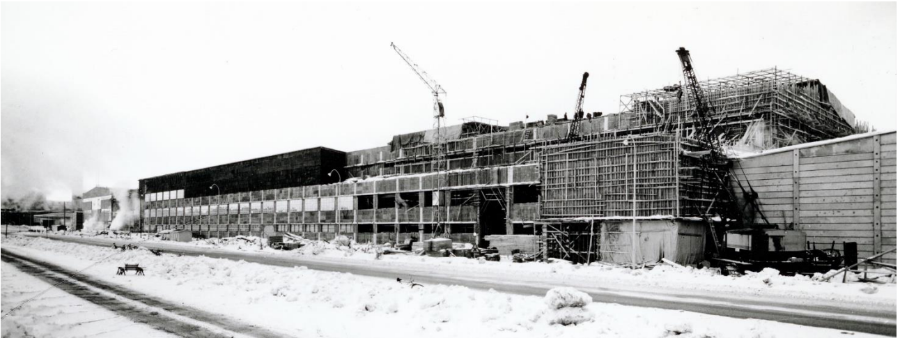
Kuva 187 Pohjoisesta. Toinen konesali on rakenteilla. Koillisjulkisivulla se peittää taakseen paperitehtaan alkuperäiset julkisivut. Kuvan oikeassa reunassa näkyvä paperivarasto vaikuttaa jo valmiilta. Kuvälähde: Kemin historiallinen museo / 71 (1276, H6/61) Paperitehdas 28.3.1961. Kuvaaja Mannelin.
