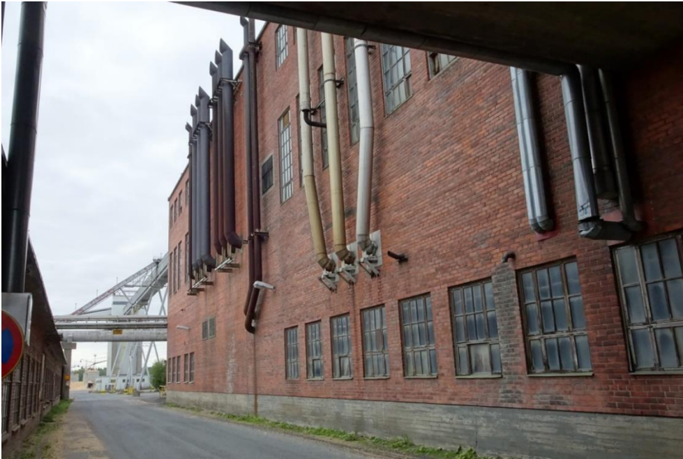
Kuva 85 Itäjulkisivun matalassa osassa on runsaasti erilaisia pystyputkia. Kuvälähde: FCG 2022
