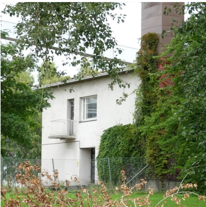
Kuva 222 Laajennuksen länsipäädystä on pieni pystypinnakaiteellinen ulokeparveke. Päädyn ulko-ovi sijaitsee syvennyksessä. Punatiilisen piipun yläosa on verhoiltu pellillä. Kuvälähde: FCG 2022
