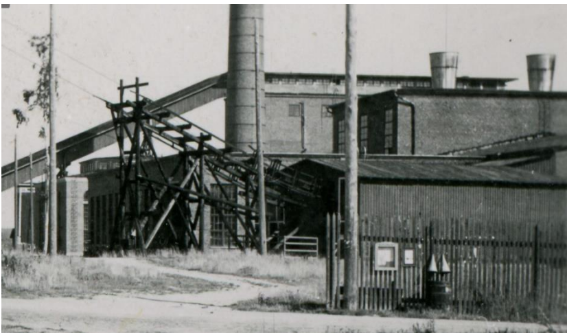
Kuva 48 Ote valokuvasta 1930-luvulta luoteesta. Matalan tasakattoisen rakennusosan länsisivulla on myös ollut korkeat ruutuikkunat. Taustalla näkyy Voima-aseman piippu ja rakennuksia, etualalla on puinen varastorakennus. Kuvälähde: Kemin historiallinen museo / khmva_0210_0072, 1930-luku
