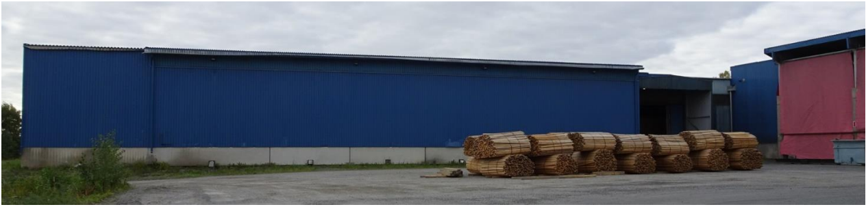
Kuva 144 Kuivaamon pohjoisjulkisivu. Kuvälähde: FCG 2022
