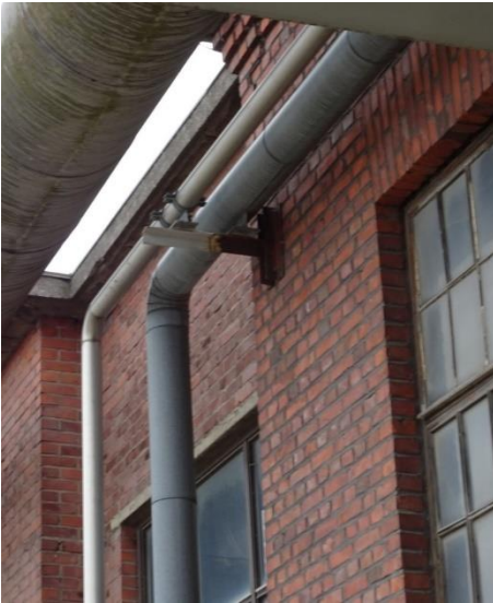
Kuva 57 Yksityiskohta pohjoisjulkisivulta. 1950-luvulla rakennetun laajennuksen ja alkuperäisen rakennusosan liitoskohdassa on pieni syvennys. Alkuperäisessä osassa räystäs muodostuu porrastetusta tiiliverhouksesta ja 1950-luvulla rakennetuissa laajennuksissa on betoniräystäs. Alkuperäisessä osassa aukkojen yläreunat on tehty tiiliholvimuurauksella, kun taas 1950-luvulla rakennetussa osassa on betonipalkit ikkunoiden yläreunassa. Kuvälähde: FCG 2022
