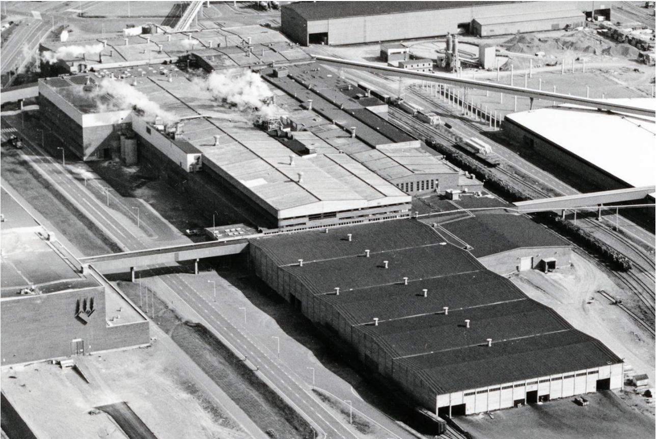
Kuva 195 Ote ilmakuvasa luoteesta arviolta 1980-luvun lopulta. Vuoden 1989 ilmakuvasa kuvan oikeassa reunassa keskeneräisenä näkyvä tuotevaraston laajennus näkyy valmiina. Kuvan vasemmassa yläreunassa näkyvä PK3:een liittyvä laajennus on valmistunut, mutta lounaisjulkisivun laajennuksia ei ole vielä tehty. Kuvälähde: Kemin historiallinen museo / 881 (4279) Ilmakuva Veitsiluodon tehdasalueesta. Kuvaja Kari Paajanen, Helsinki. Osasto 61/4279.
