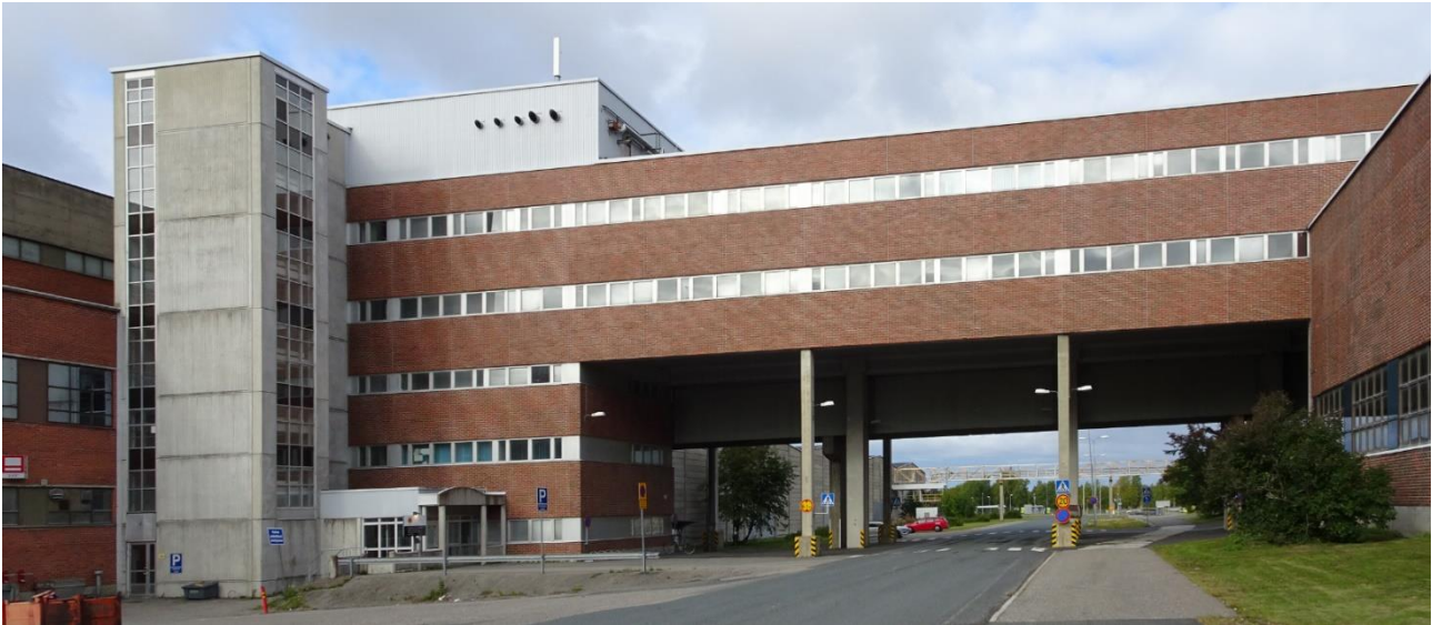
Kuva 208 Yhdysosa kaakosta. Arviolta 1990-luvun alkupuolella on rakennettu paperitehtaiden väliin ja Paperitien ylle toimisto- ja laboratoriotiloja sisältävä siipiosa. Sen paikalla on ollut jo PK5:n rakennuksen valmistumisesta alkaen paperitehtaat paperivarastoille yhdistävä kuljetin. Kuvassa vasemmalla näkyy PK2:n ja PK3:n paperikonesali, oikealla PK5:n rakennusta. Kuvälähde: FCG 2022
