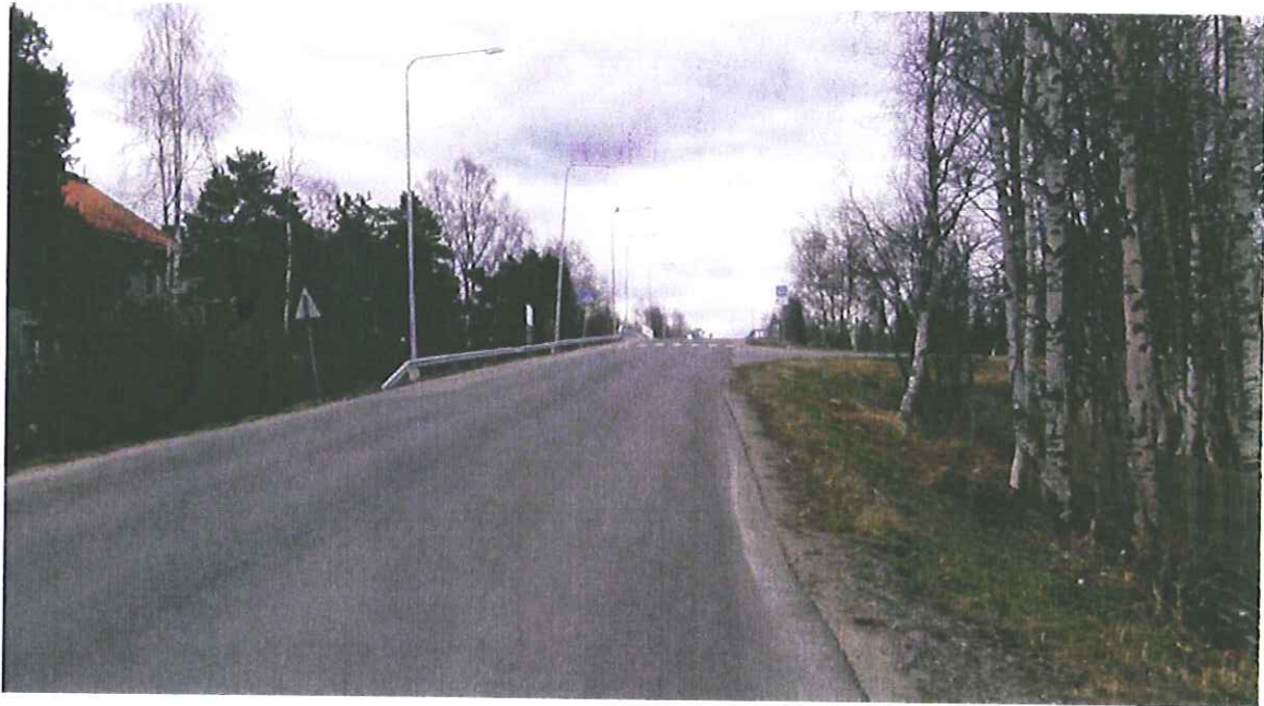
KUVA 8 MÄNTYLÄNKATU LAPINTIEN YLITTÄVÄN SILLAN LÄNSIPUOLELTA
